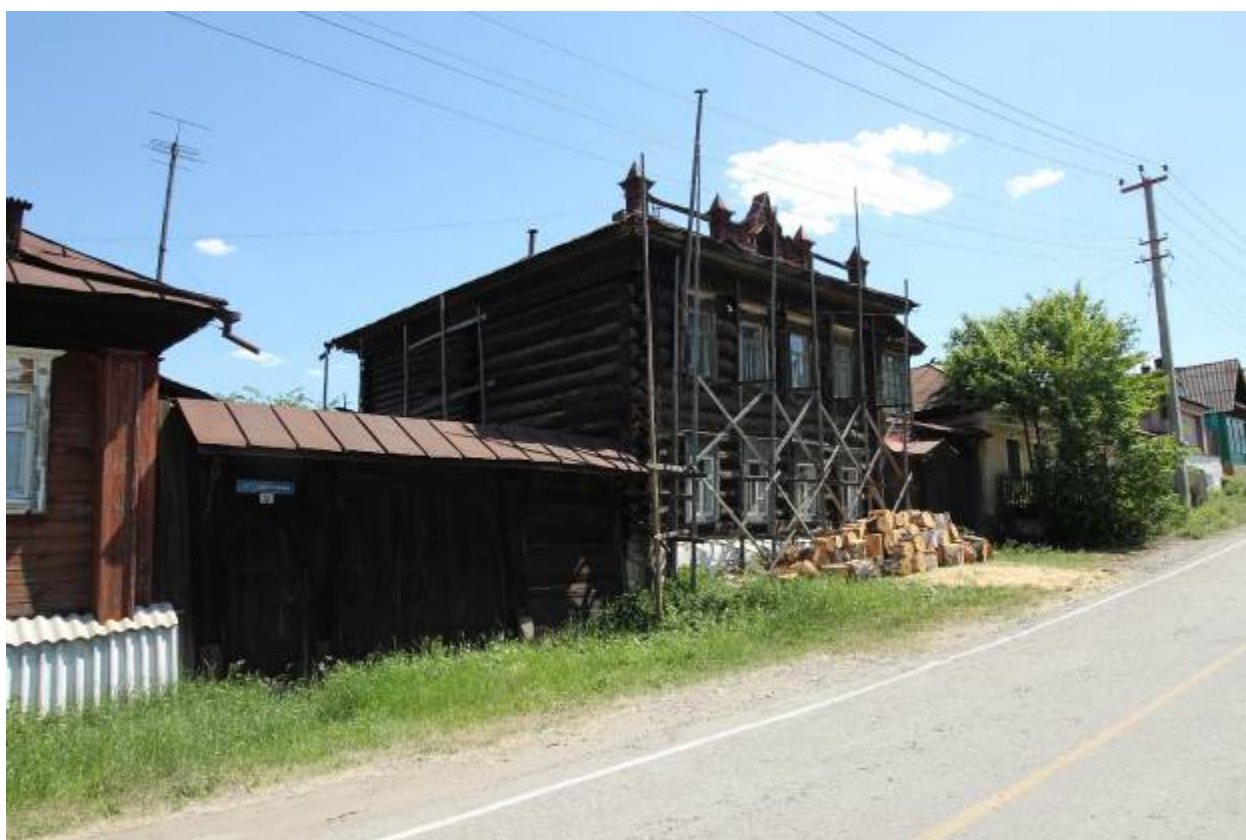
Рис. 2. Вид на здание с северо-запада при движении по ул. Советская
