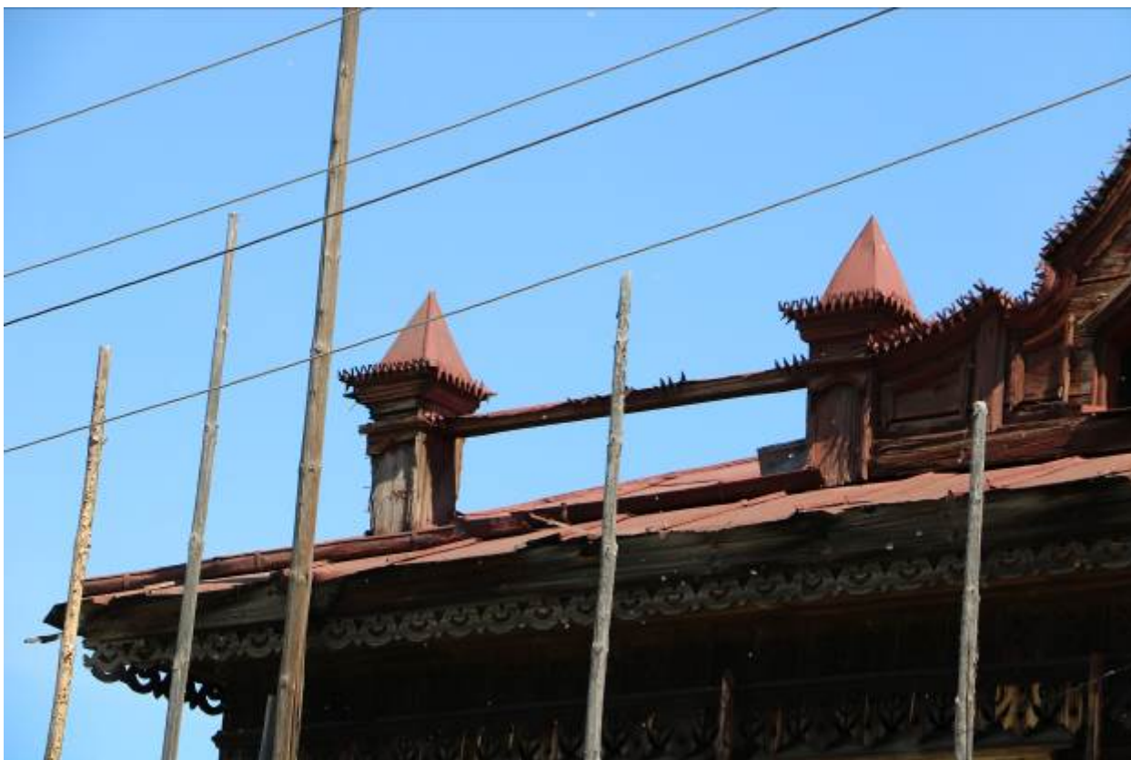
Декоративные элементы крыши. Вид с 3.
