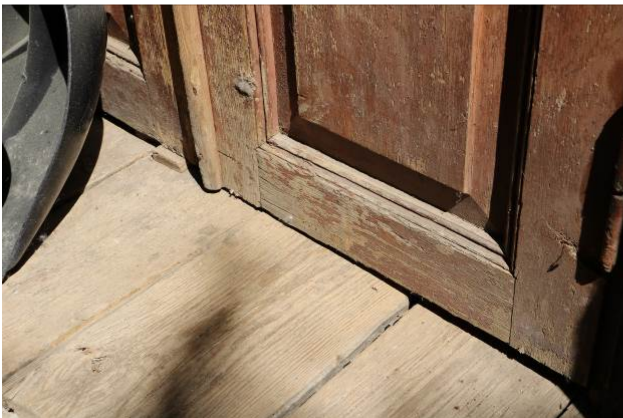
Покрытие крыльца, на котором расположена входная дверь Объекта.
