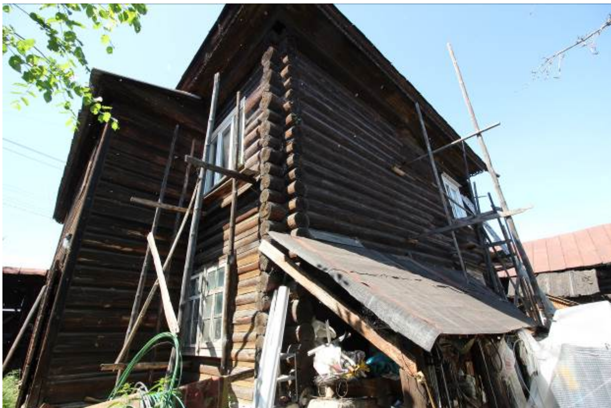
Южный фасад Объекта. Вид с Ю.
