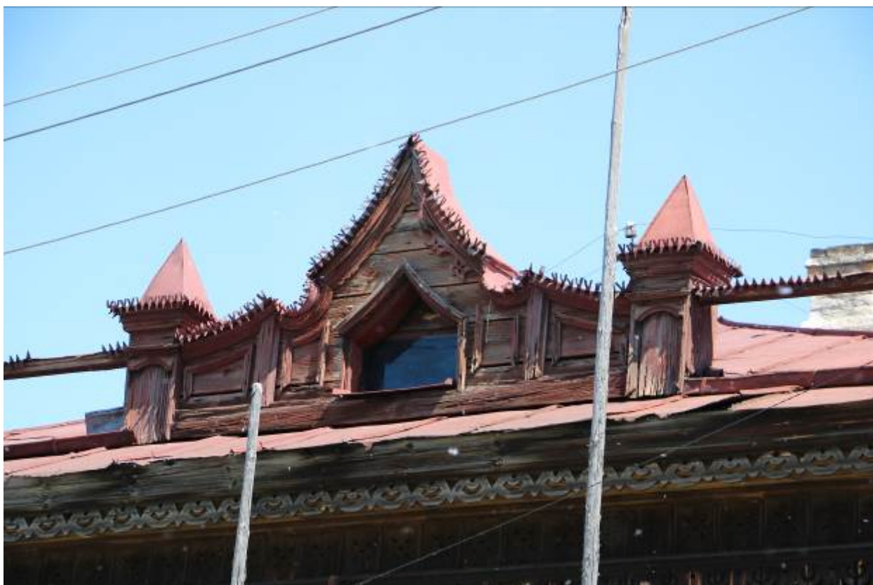
Декоративные элементы крыши. Вид с 3.
