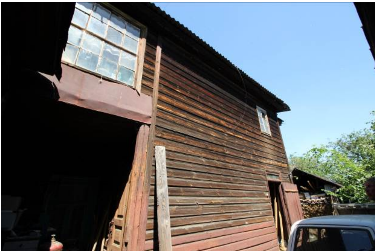
Южный фасад Объекта. Вид с Ю.
