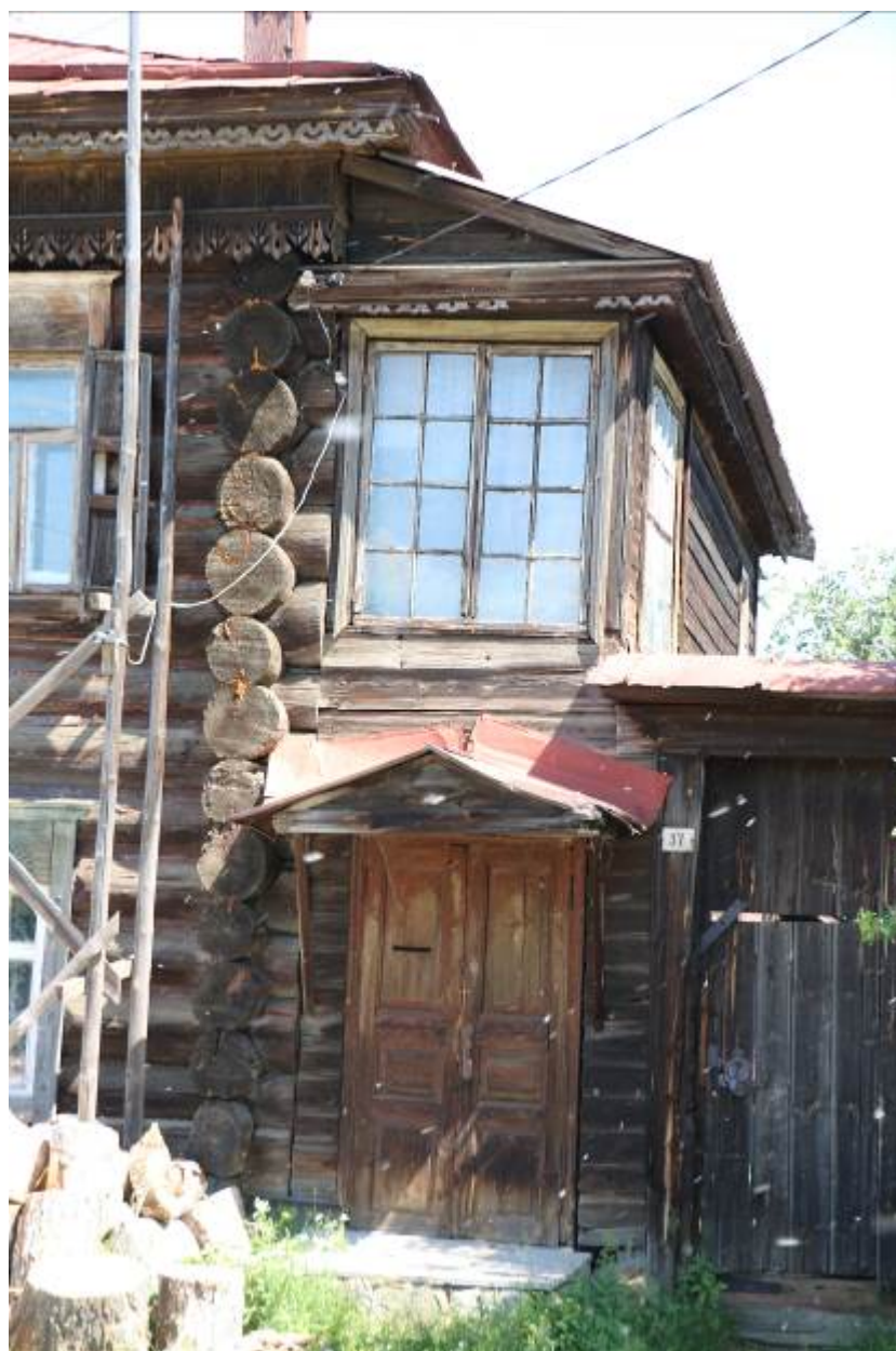
Входная дверь и часть главного фасада Объекта. Вид с 3.
