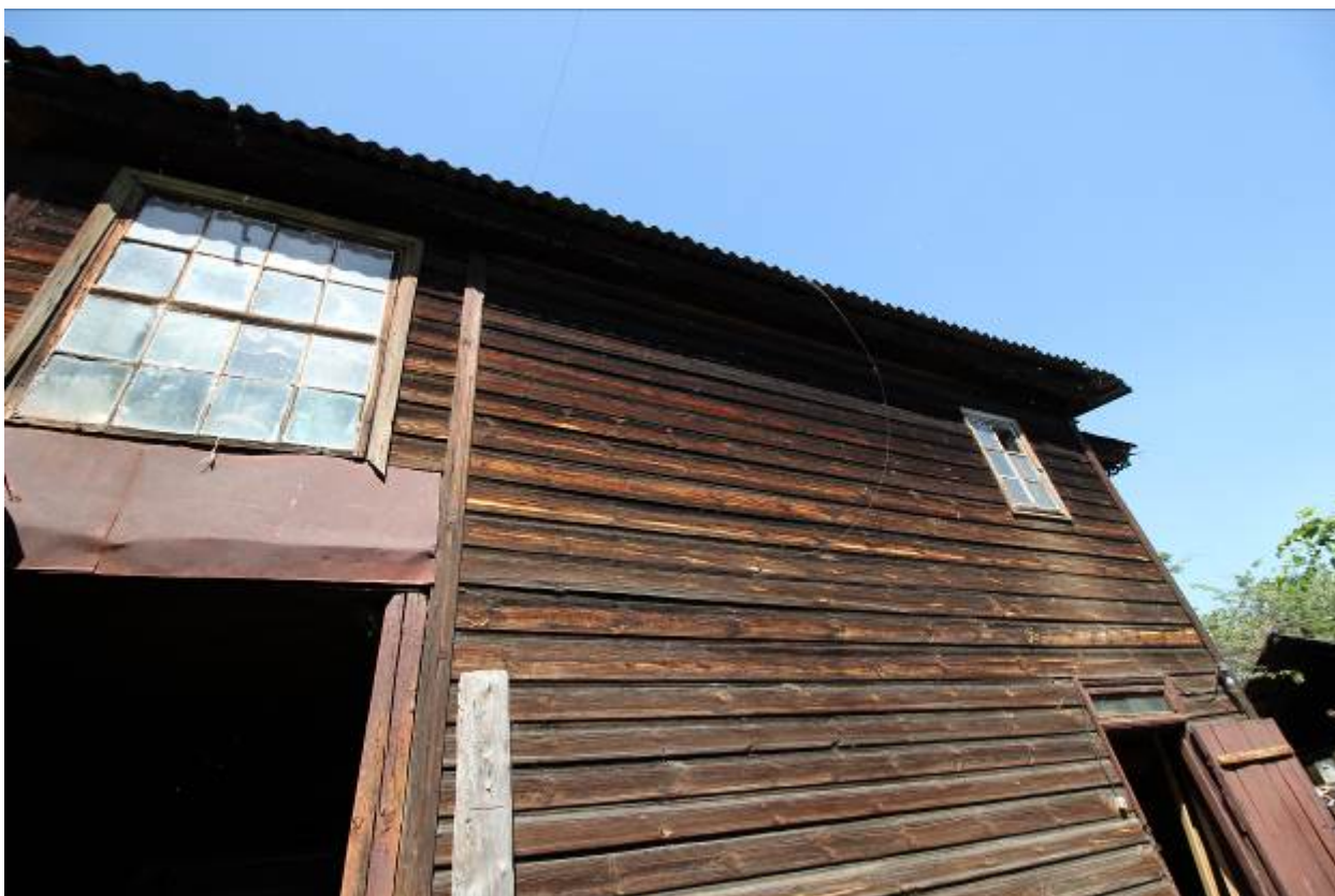
Южный фасад Объекта. Вид с Ю.
