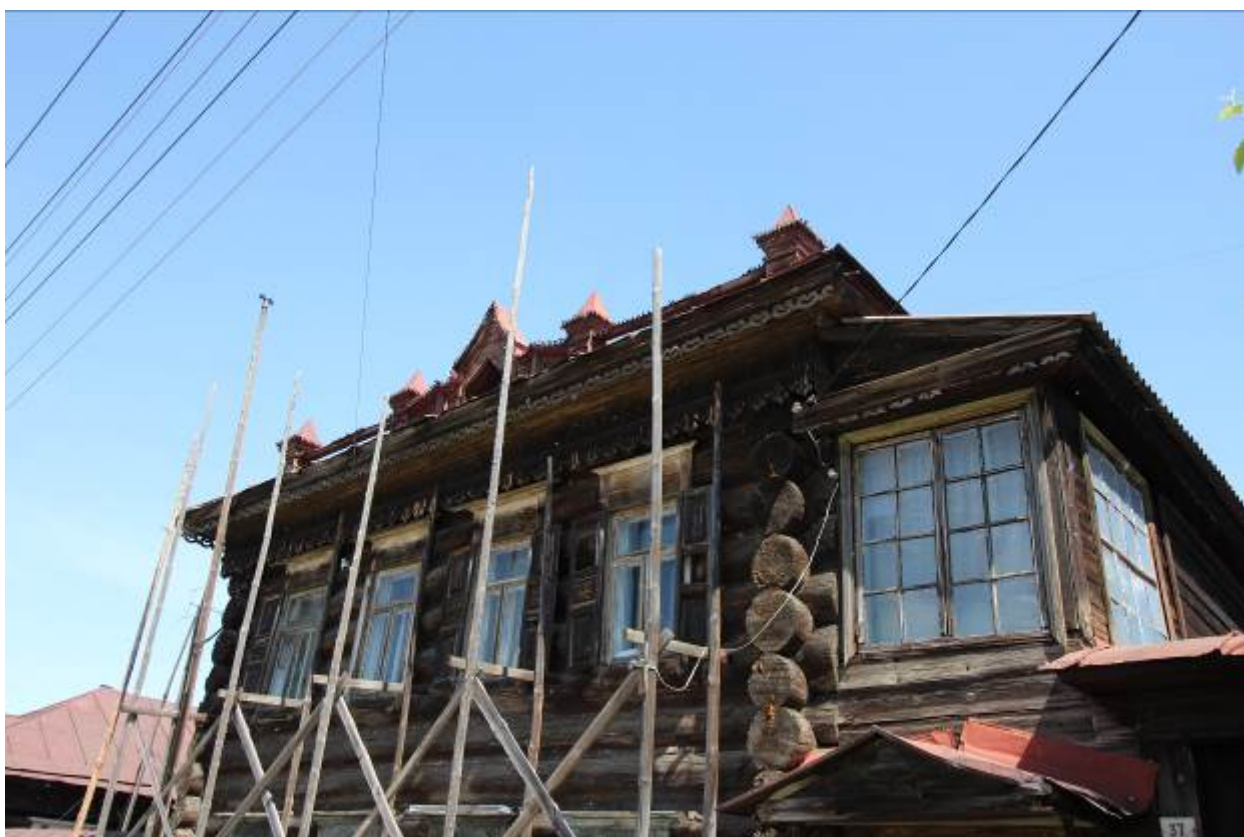
Вид на второй этаж Объекта с ЮЗ.
