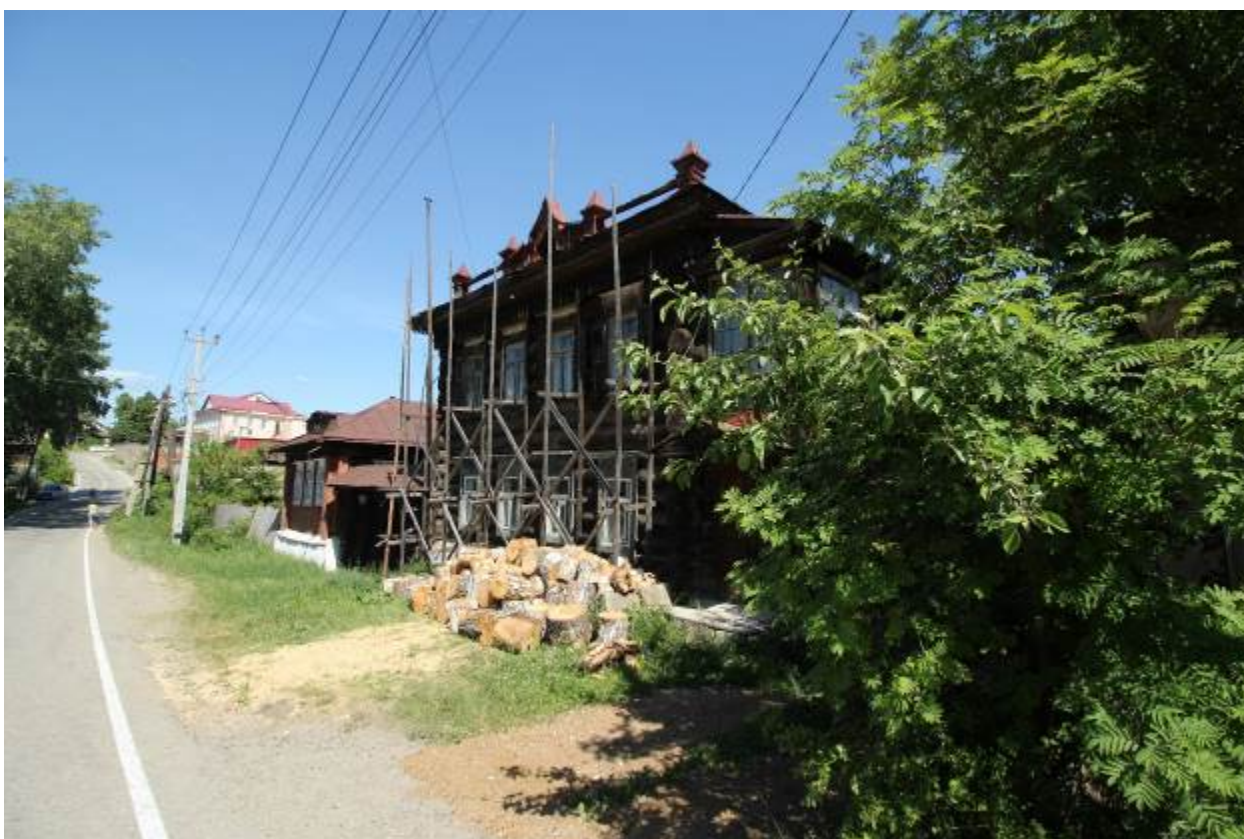
Рис. 4. Вид на здание с юго-запада при движении по ул. Советская
