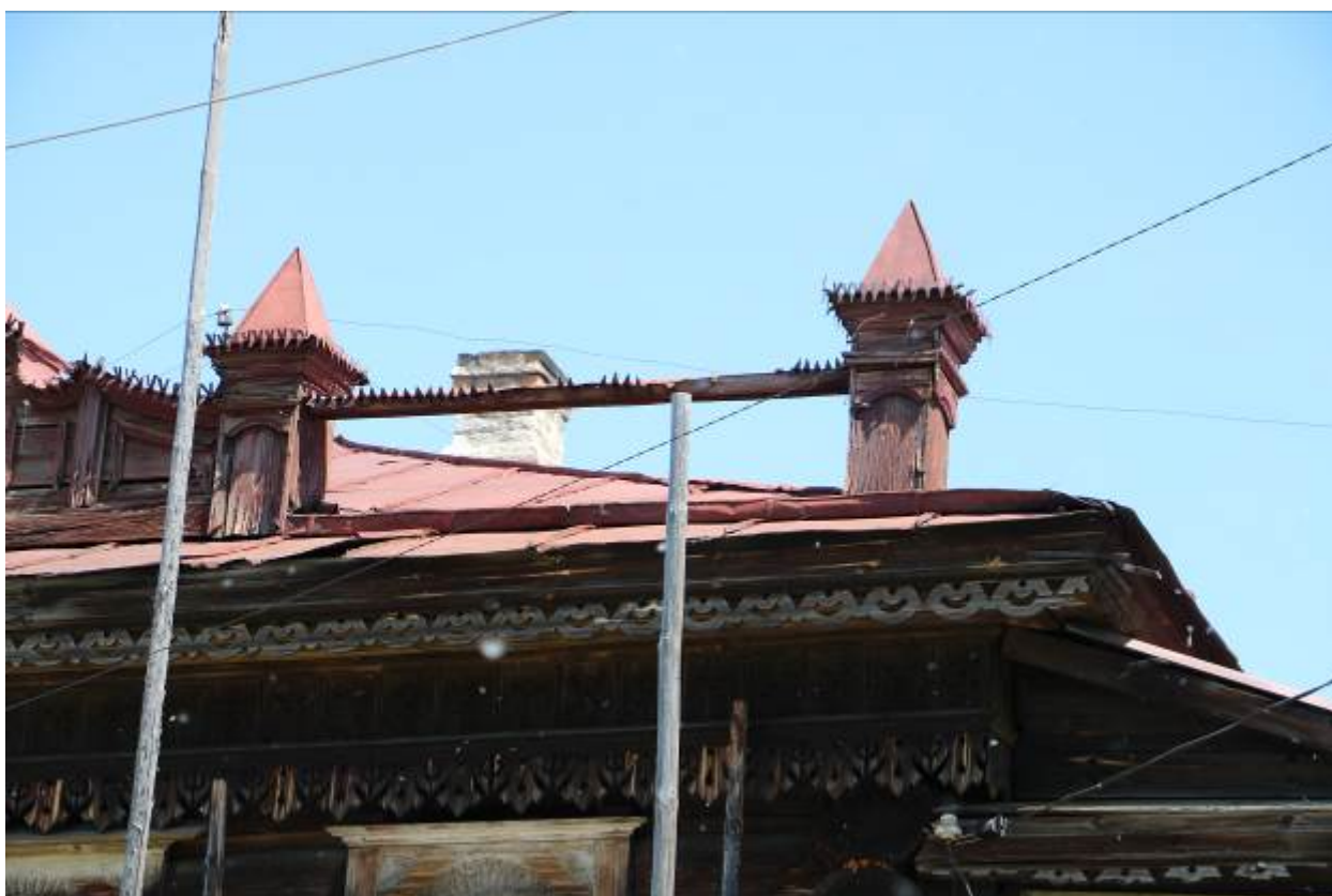
Декоративные элементы крыши. Вид с 3.
