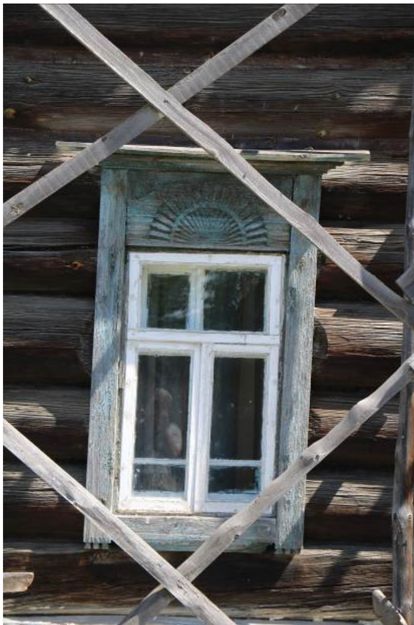
Окно первого этажа Объекта. Вид с 3.
