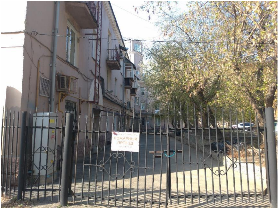
Фото 3. Объект культурного наследия - Дом жилой. г. Челябинск, Цвиллинга ул., 39/Тимирязева ул., 31. Вид с юга.
