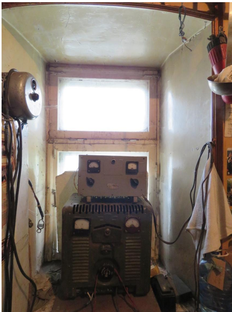
Рис. 16. Фрагмент интерьера. Оконный проем
