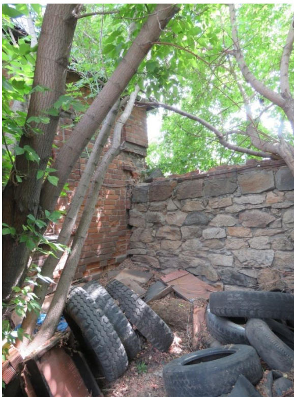
Рис. 13. . Фрагмент западного фасада. Южный угол и фрагмент примыкающей брандмауэрной стены.
