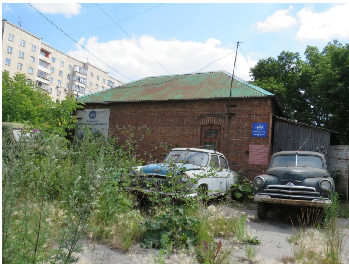
Рис. 6. Боковой, северный фасад
