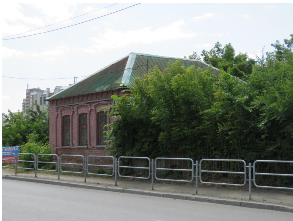
Рис. 2. Вид на здание со стороны ул. Российской. Лицевой, восточный, фасад
