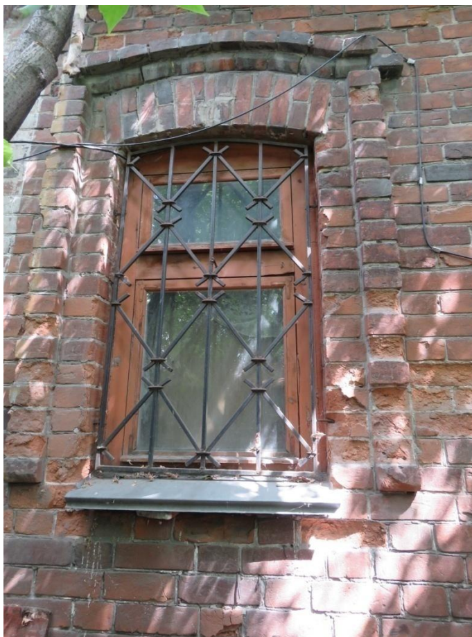
Рис. 12. Фрагмент западного фасада. Оформление оконного проема
