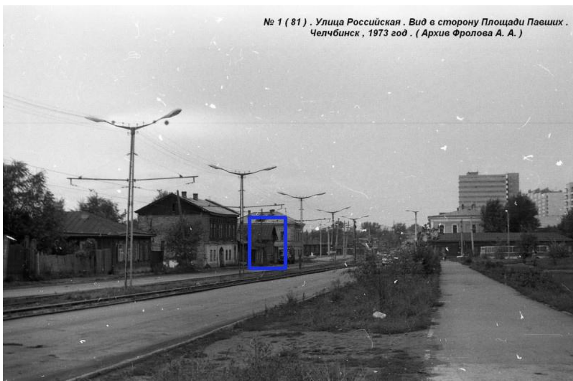
Рис. 14. Вид на ул. Российскую с фрагментом застройки, в ряду которой расположены дом Г.Я. Пчелина (угловое двухэтажное здание) и флигель (синий контур). Фото 1973 г. Коллекция Государственного исторического музея Южного Урала
