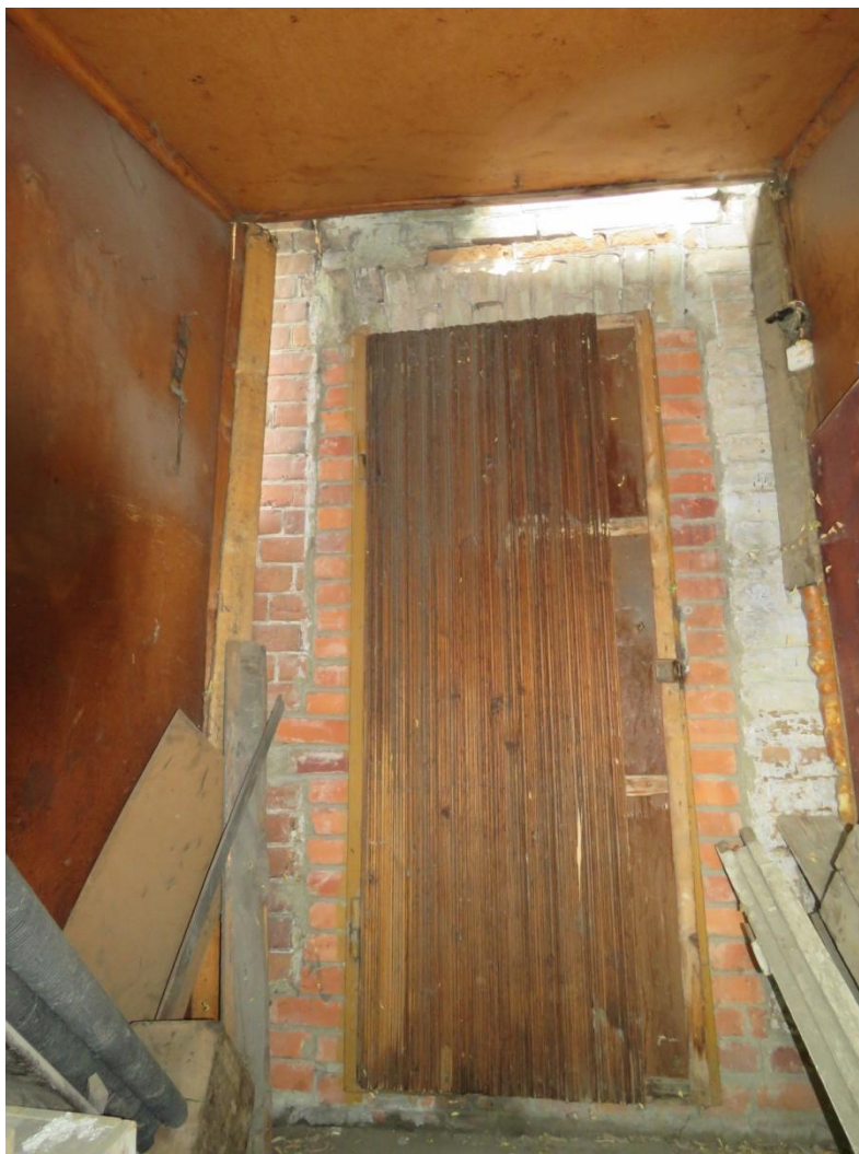
Рис. 14. Входной проем на южном фасада
