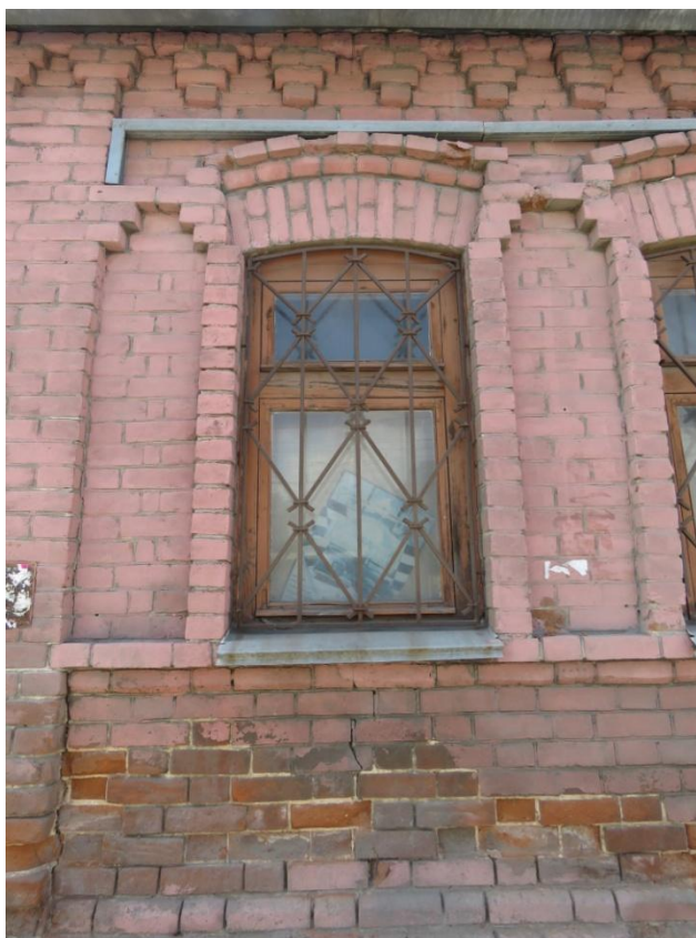
Рис. 8. Фрагмент лицевого, восточного фасада. Оконный проем и декор фасада
