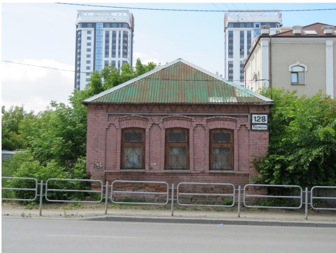
Рис. 3. Вид на здание со стороны ул. Российской. Лицевой, восточный, фасад
