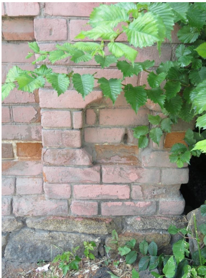
Рис. 7. Бутовый цоколь и кирпичная стена
