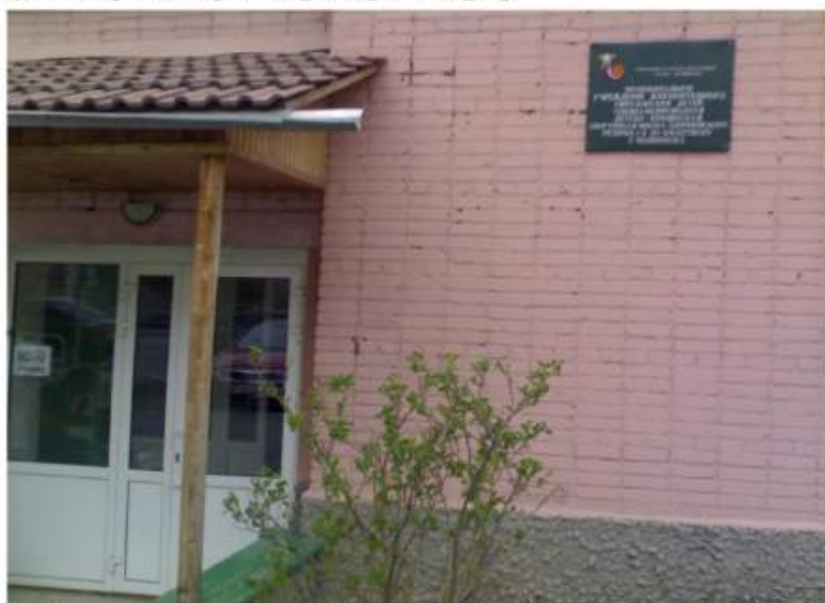
Рис. 39 Входная группа пристроенной части к зданию бывшего «3-го низшего начального (приходского) женского училища» (Муниципальное учреждение дополнительного образования СДЮСШОР № 8 по баскетболу) по ул. Володарского, 14а (Фото – 2014 г.). Ссылка: https://img-fotki.yandex.ru/get/5003/ssgen.1ea/0_63608_f255dd39_orig .
