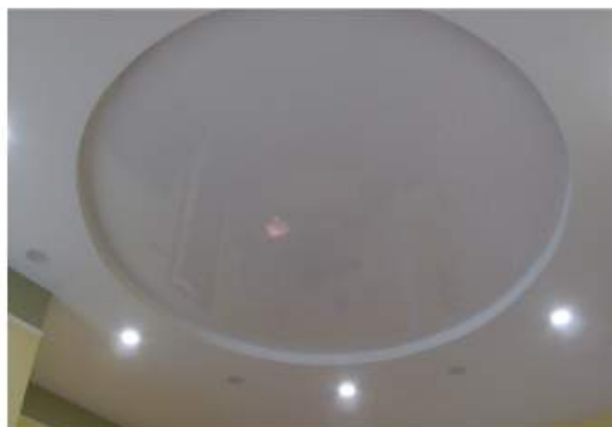
Рис. 34 Вид на потолок вестибюля
