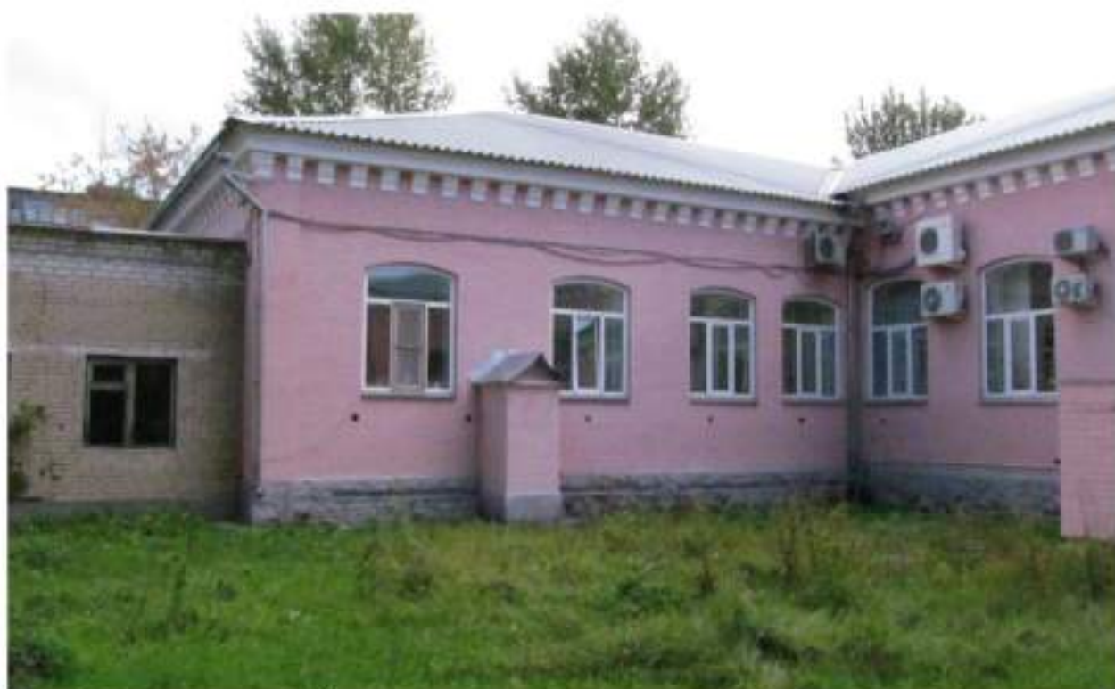
Рис. 13 Вид на западный фасад здания-памятника со стороны дворовой территории
