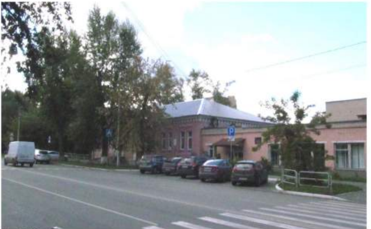
Рис. 2 Общий вид на здание-памятник с северо-востока со стороны ул. Володарского
