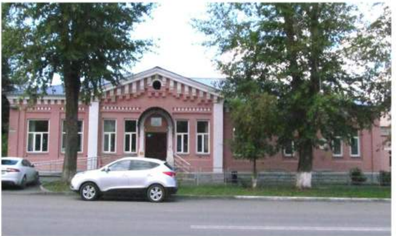
Рис. 7 Вид на главный восточный фасад здания-памятника со стороны ул. Володарского
