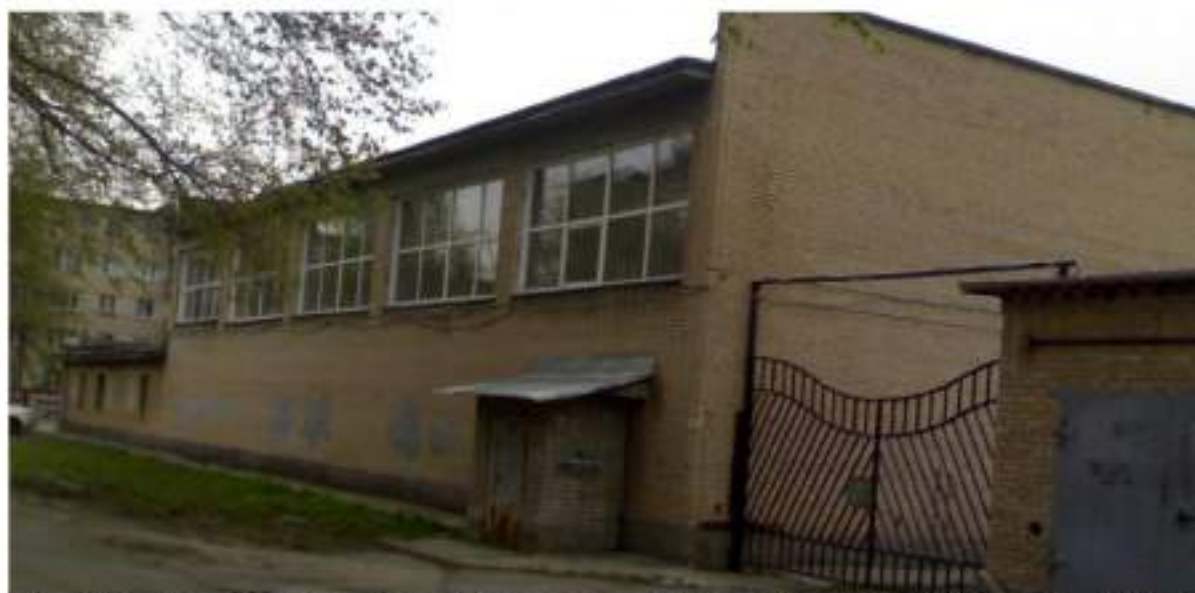
Рис. 29 Пристроенная часть (южный и северный фасады) к зданию бывшего «Третьего низшего начального (приходского) женского училища» (Муниципальное учреждение дополнительного образования СДЮСШОР № 8 по баскетболу) по ул. Володарского, 14а (Фото 2010-х гг.). Ссылка: http://kartagrada.ru/panorama/chelyabinsk/200 .
