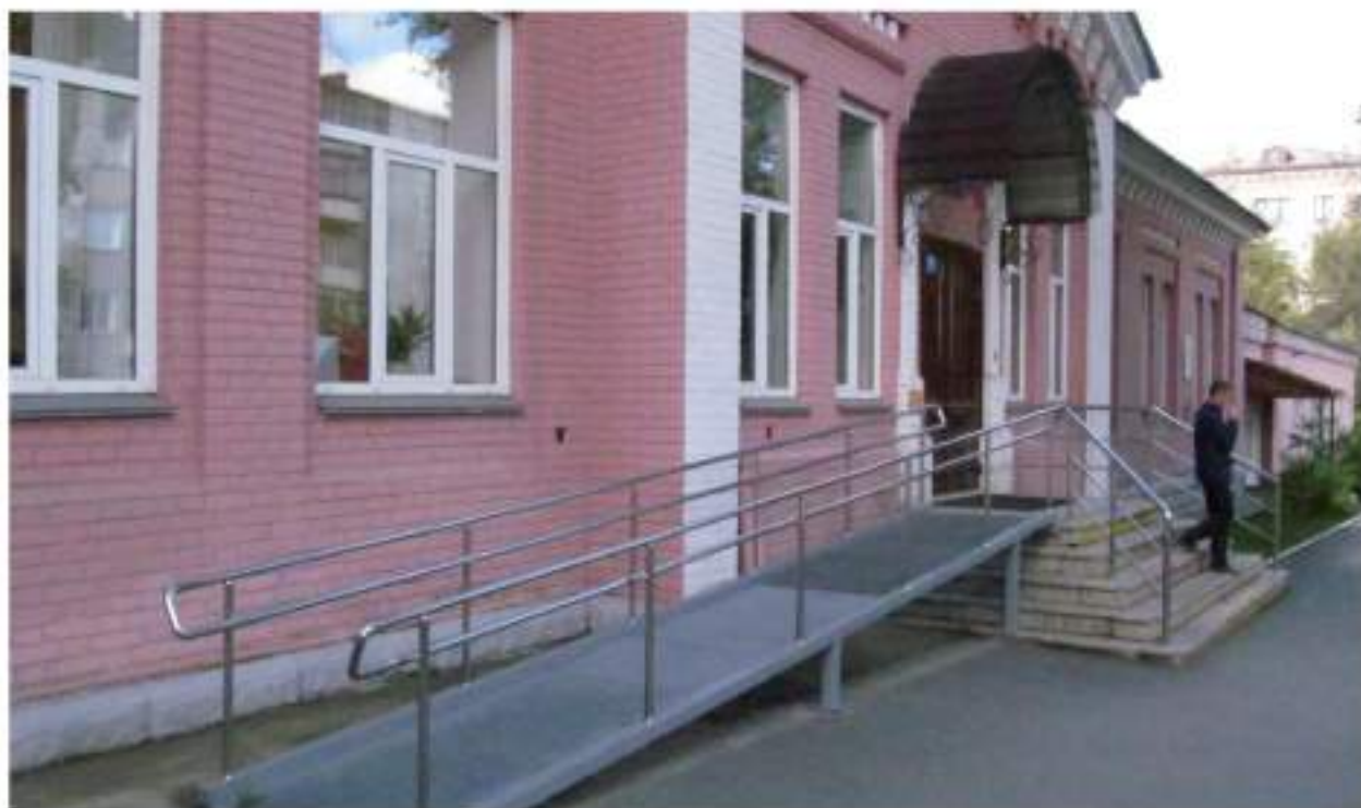
Рис. 14 Вид на входную группу главного фасада со стороны ул. Володарского
