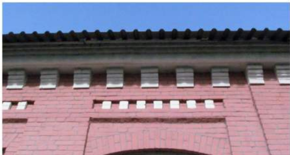
Рис. 29 Вид на карнизную зону южного фасада здания
