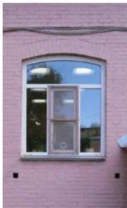
Рис. 24 Вид на оконный проем западного фасада здания
