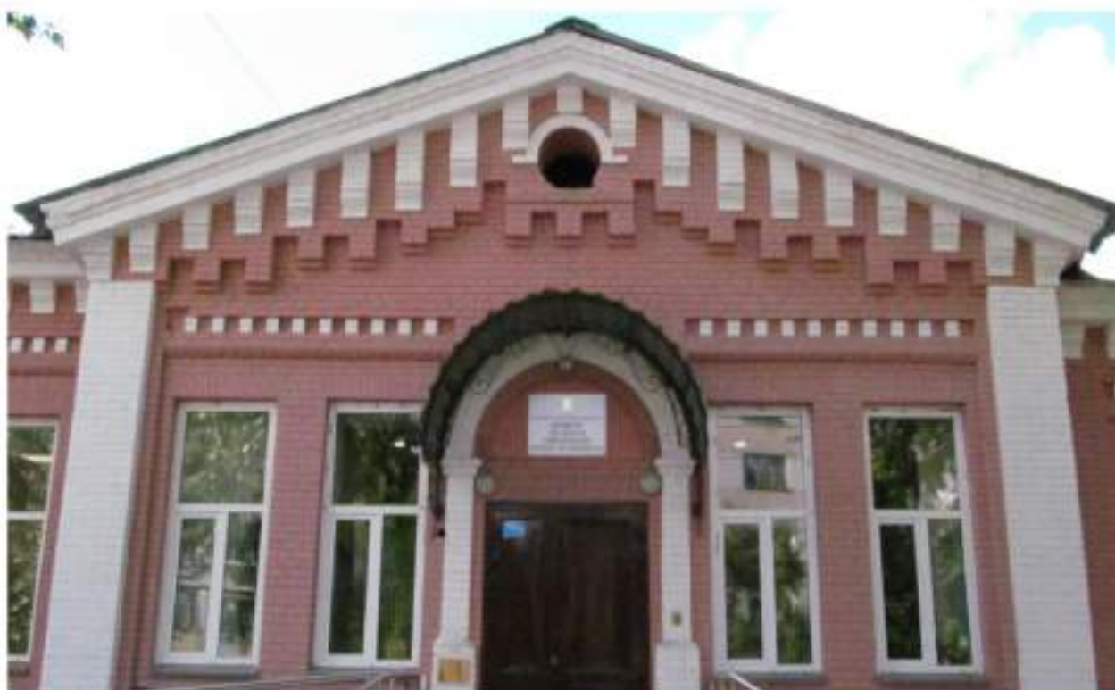
Рис. 15 Вид на фронтон главного фасада со стороны ул. Володарского
