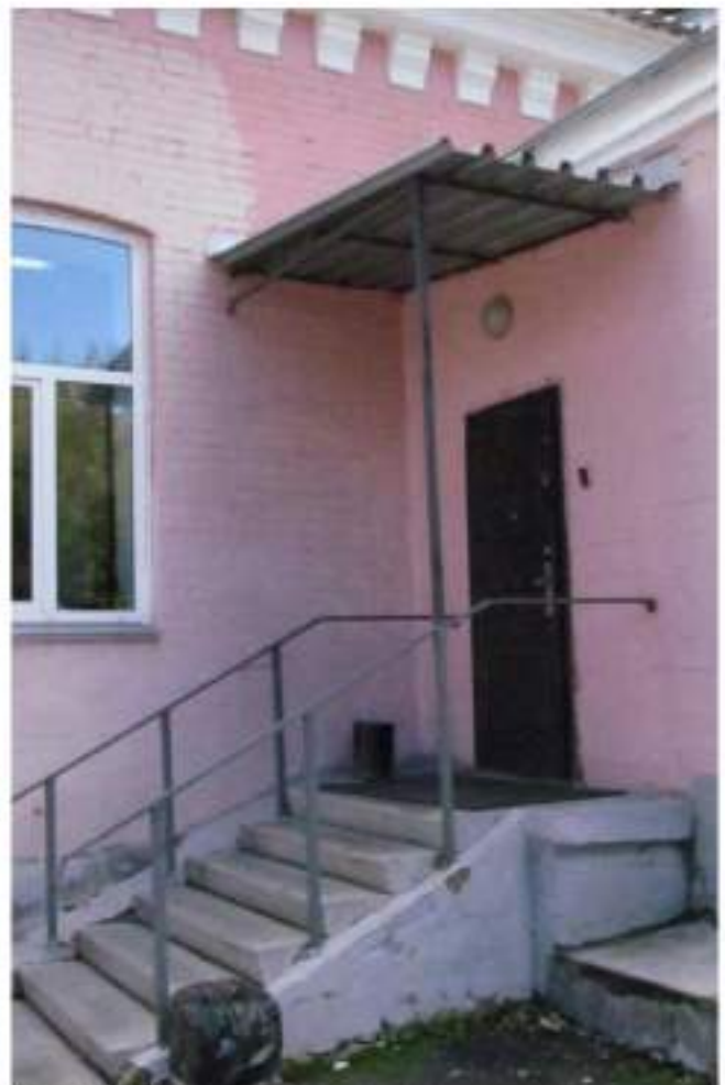
Рис. 20 Вид на крыльцо пристроя западного крыла здания
