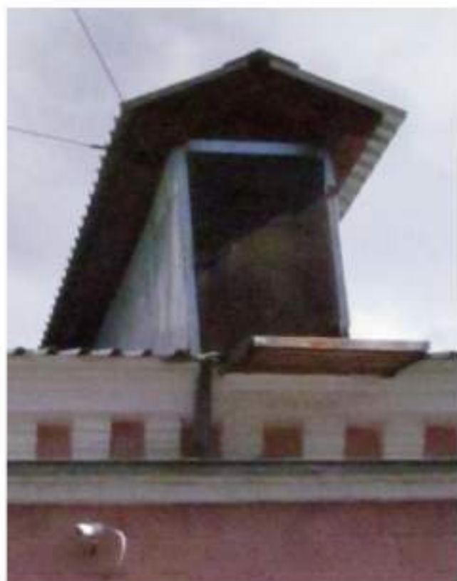
Рис. 25 Вид на вентиляционный выход здания
