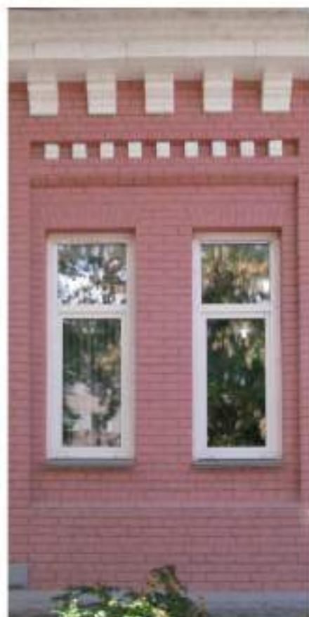
Рис. 22 Вид на оконные проемы восточного фасада здания
