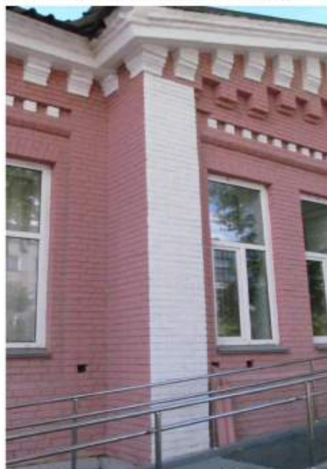
Рис. 27 Вид на пилястру входной группы восточного фасада здания
