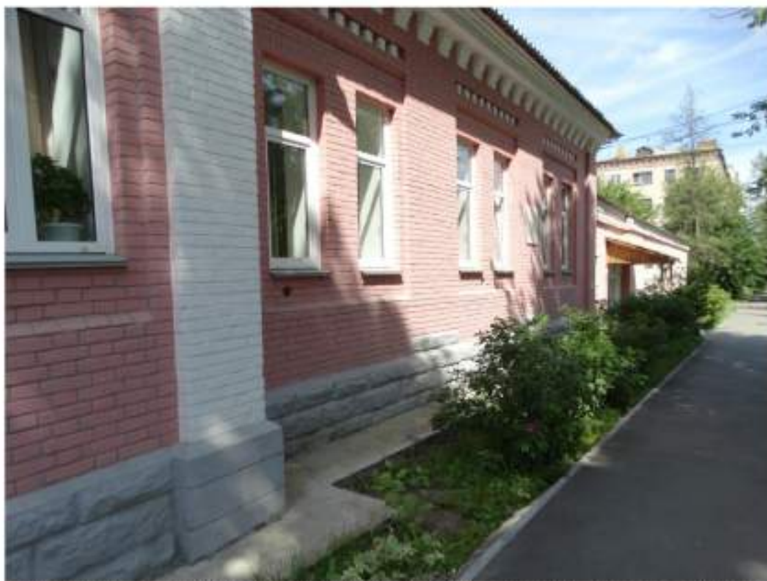
Рис. 42 Главный (восточный) фасад здания бывшего «3-го низшего начального (приходского) женского училища» по ул. Володарского, 14 (Фото – июль, 2015 г.). Ссылка: https://img-fotki.yandex.ru/get/5806/5661614.c5/0_b3fd7_b674735_orig .
