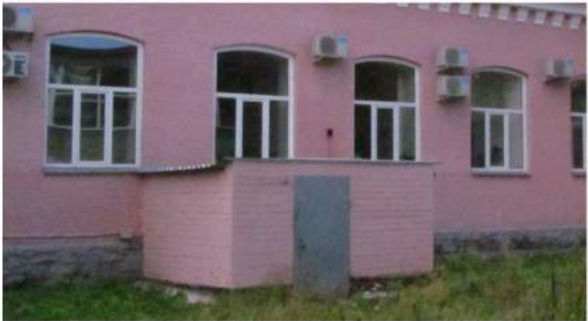
Рис. 18 Вид на вход в подвальную часть со стороны северного фасада западного крыла здания со стороны дворовой территории
