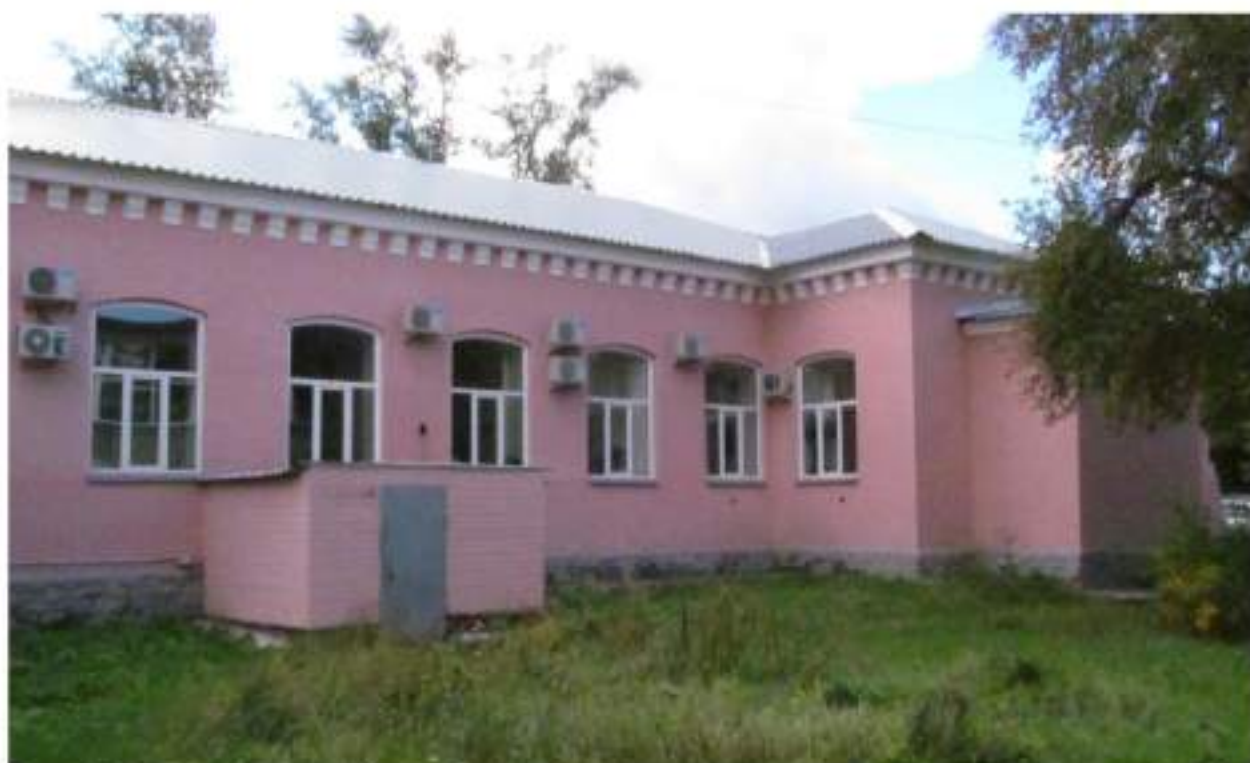
Рис. 12 Вид на северный фасад западного крыла здания-памятника со стороны дворовой территории
