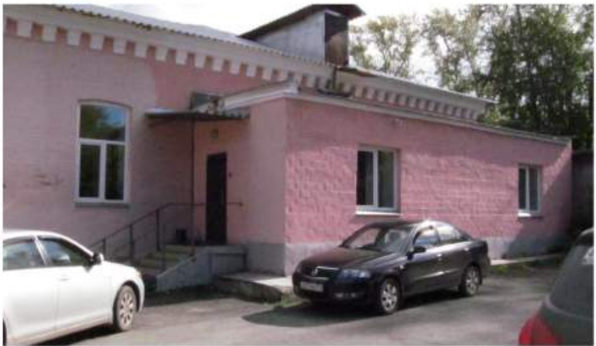
Рис. 16 Вид на пристрой западного фасада западного крыла здания со стороны дворовой территории
