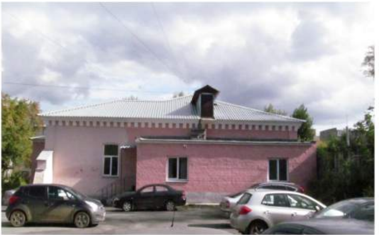
Рис. 10 Вид на западный фасад здания-памятника со стороны дворовой территории
