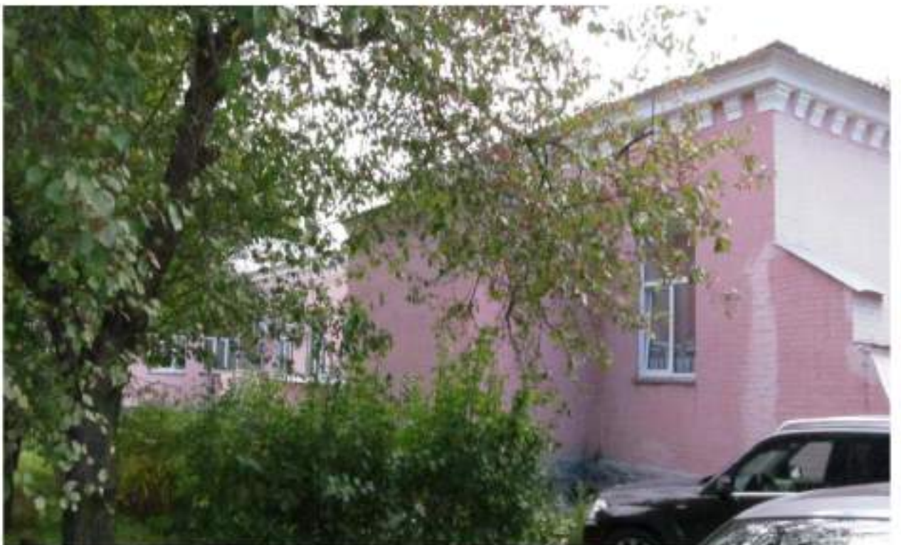
Рис. 11 Вид на северный фасад западного крыла здания-памятника со стороны дворовой территории
