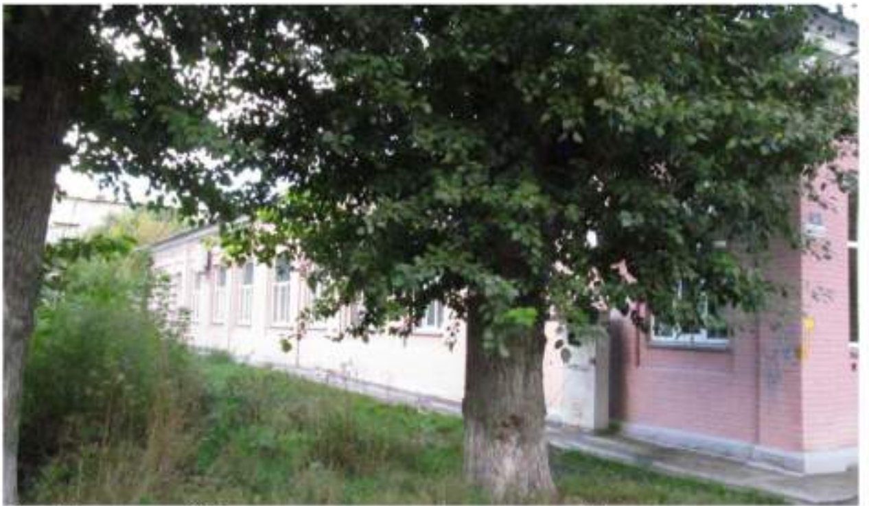
Рис. 8 Вид на южный фасад здания-памятника со стороны ул. Володарского
