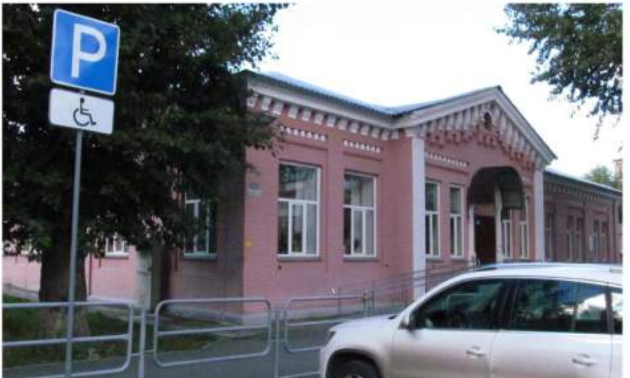
Рис. 6 Вид на юго-восточную угловую часть здания-памятника со стороны ул. Володарского
