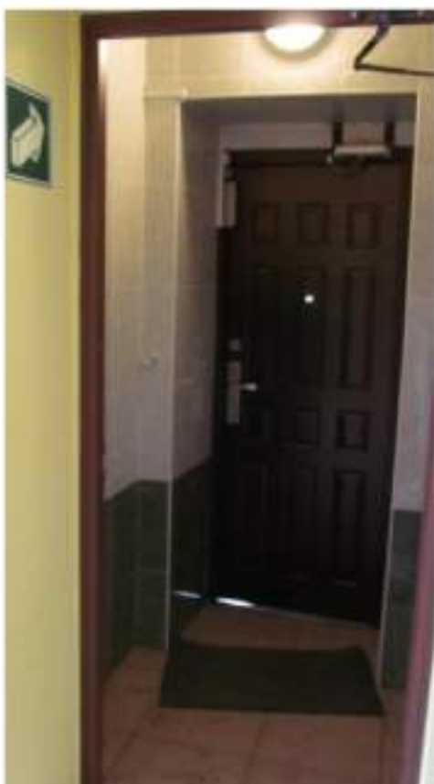
Рис. 37 Вид на тамбур пристроя западного крыла здания
