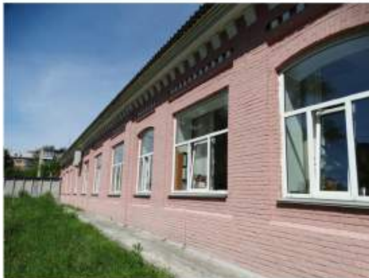
Рис. 44 Фрагмент южного фасада здания бывшего «3-го низшего начального (приходского) женского училища» по ул. Володарского, 14 (Фото – июль, 2015 г.). Ссылка: https://img-fotki.yandex.ru/get/5201/5661614.c5/0_b3fd3_e90b2982_orig .
