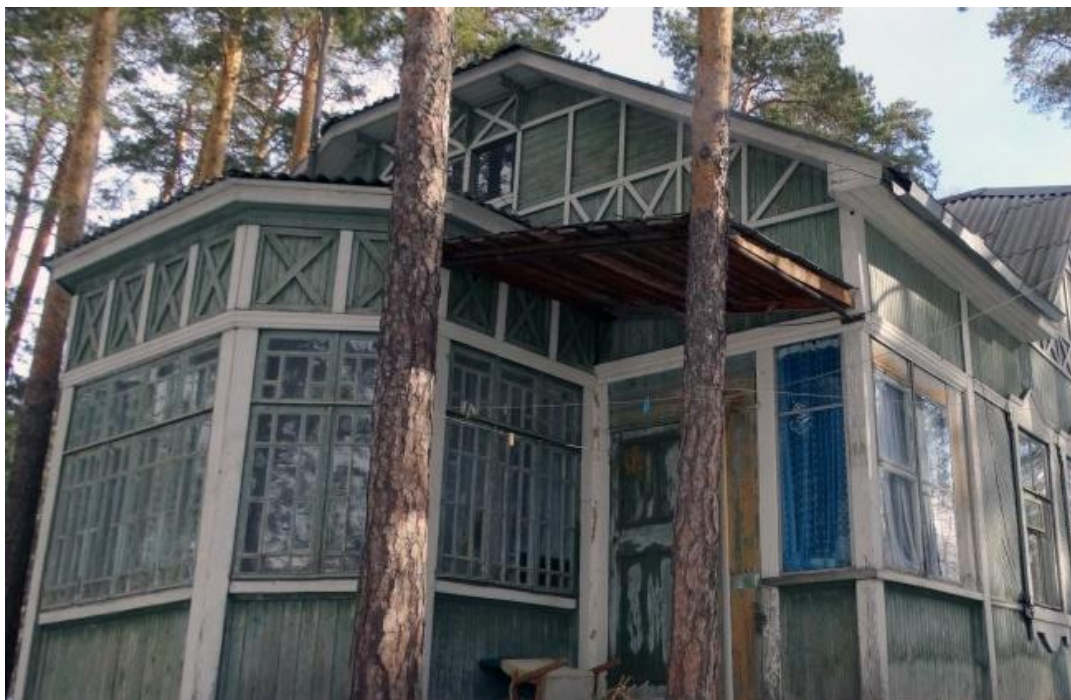
Рис. 5. Эркер западного фасада
