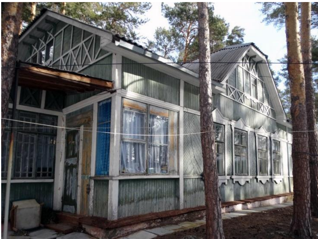
Рис. 3. Южный фасад и фрагмент западного фасада. Вид с юго-запада
