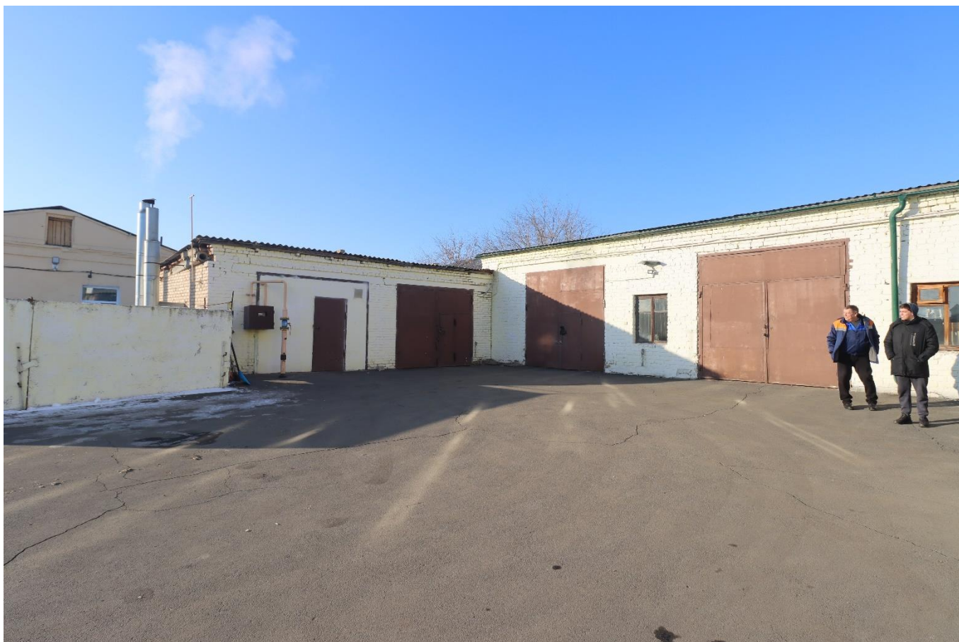
Фото 22. Вид на выявленный объект культурного наследия «Общественное здание», расположенный по адресу: Челябинская область, Троицкий городской округ, г. Троицк, ул. Красногвардейская, 81.
