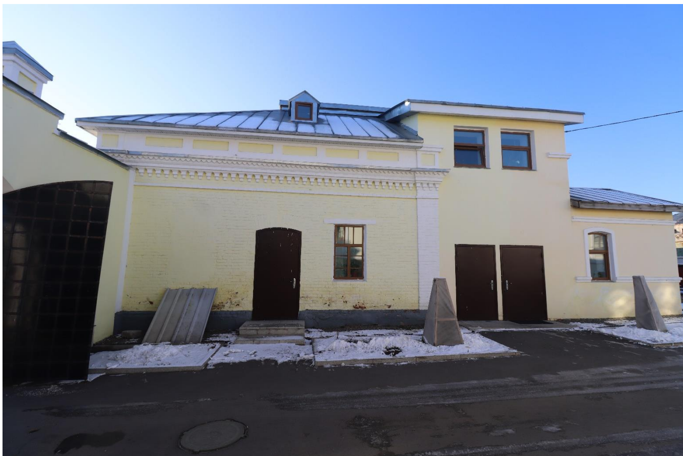
Фото 14. Вид на выявленный объект культурного наследия «Общественное здание», расположенный по адресу: Челябинская область, Троицкий городской округ, г. Троицк, ул. Красногвардейская, 81.
