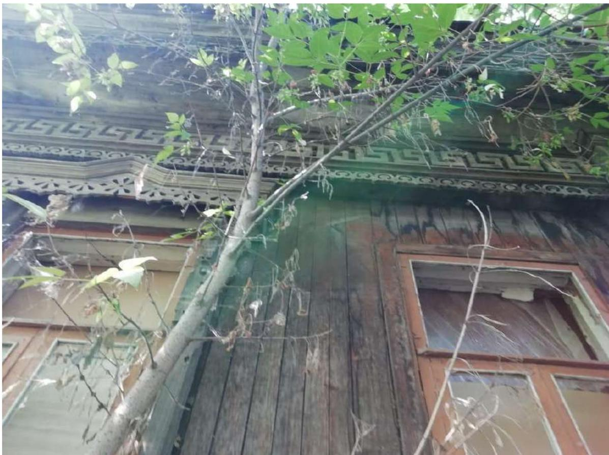
Фото 15. Резной декор - венчающий многоярусный карниз и обрамление оконных проемов. Обшивка фасада профилированной доской. 10.07.2020г.
