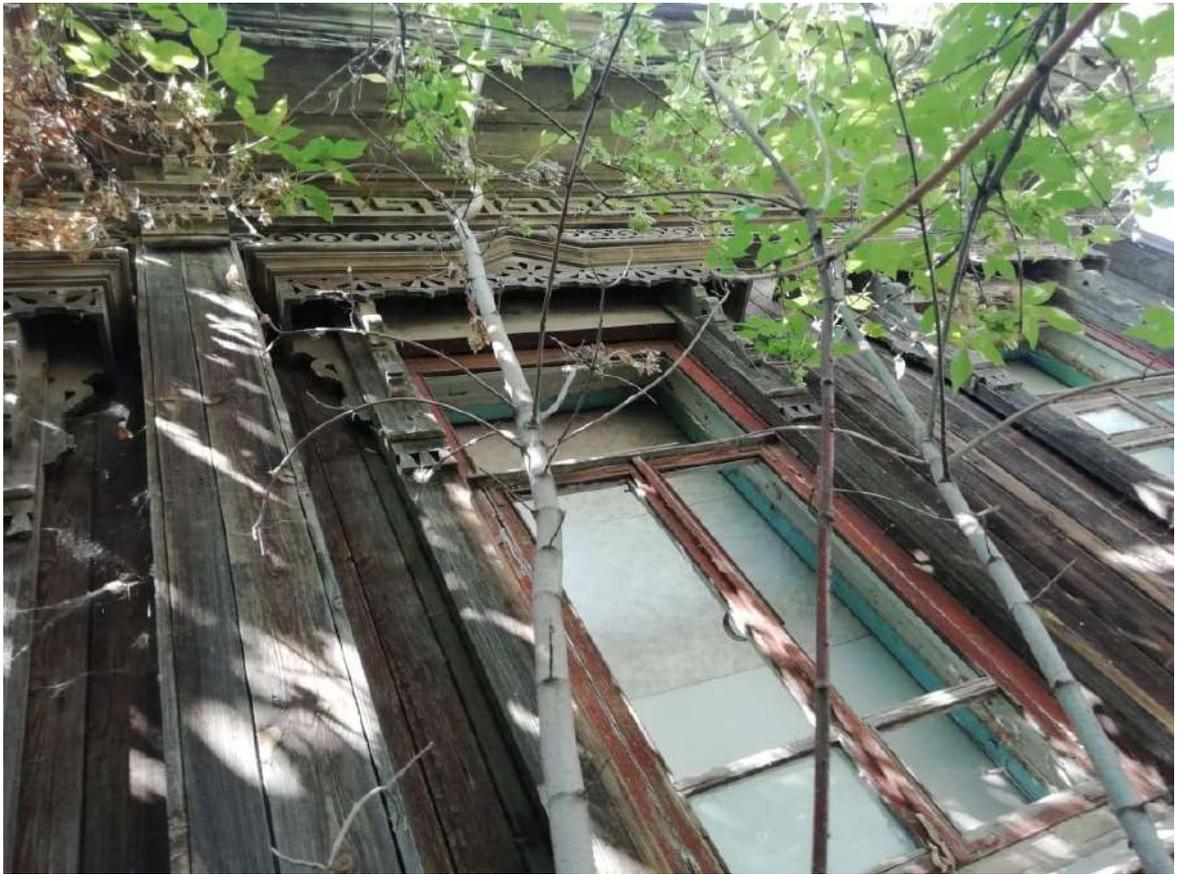
Фото 9. Резной декор главного фасада - венчающий карниз и обрамления оконных проемов главного фасада памятника. 10.07.2020г.
