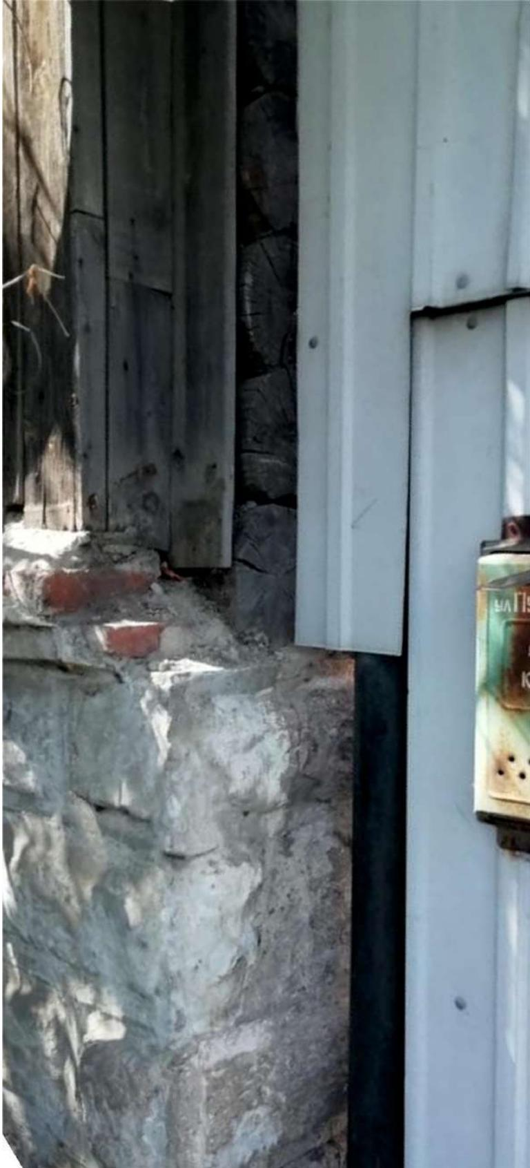
Фото 19. Фрагмент угловой части здания - место сопряжения деревянной брусчатой стены, обшитой доской, и каменного цоколя. 10.07.2020г.
