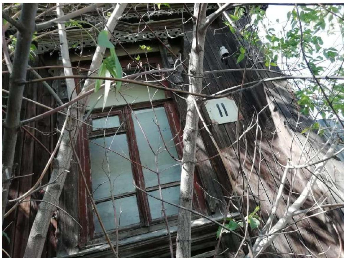
Фото 8. Резной декор главного фасада - венчающий карниз и обрамления оконных проемов главного фасада памятника. 10.07.2020г.
