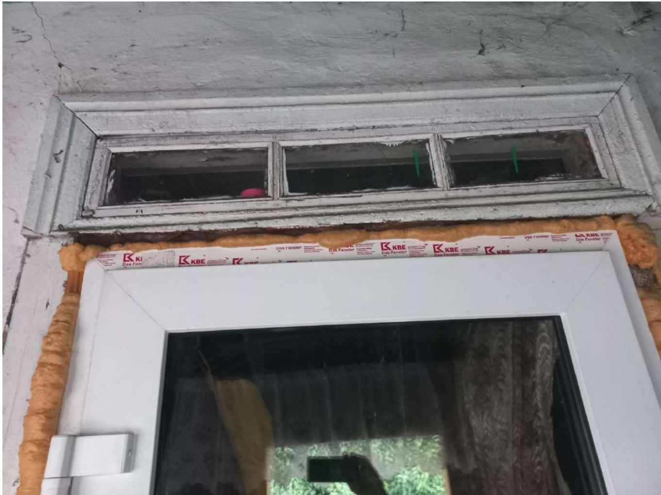
12. Фрамуга над дверным проемом. Август 2023 г.
