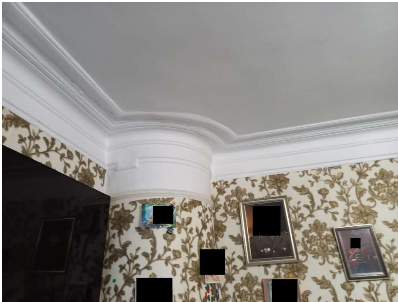
16. Интерьер. Печь. Потолочные карнизы. Август 2023 г.
