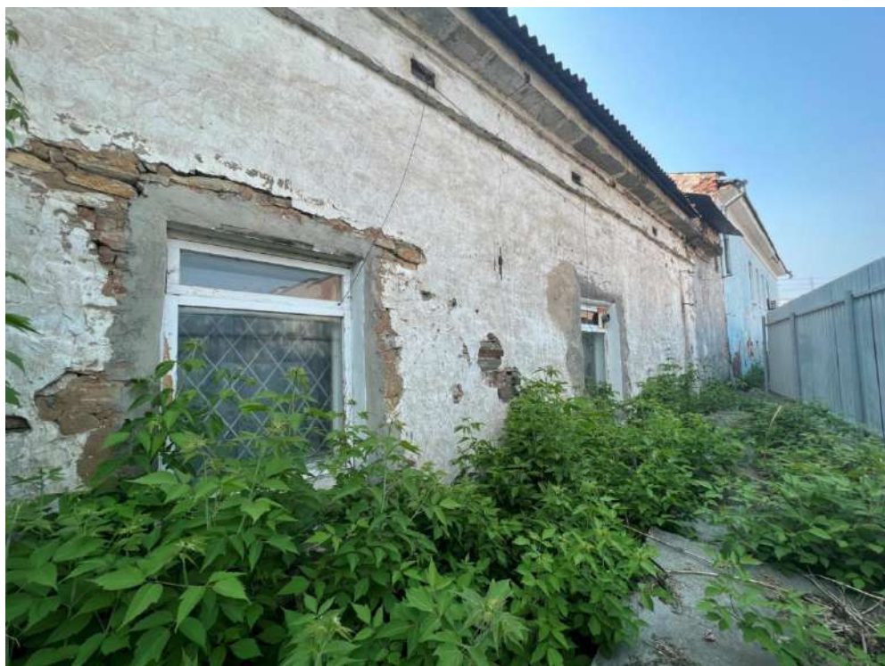
Рис. 29 а, б. Объем кладовой, примыкающий к заднему, южному фасаду выявленного ОКН «Особняк купеческий». Поздний пристрой, закрывающий западный фасад объема кладовой (вверху), восточный фасад с поздними оконными проемами (внизу)
