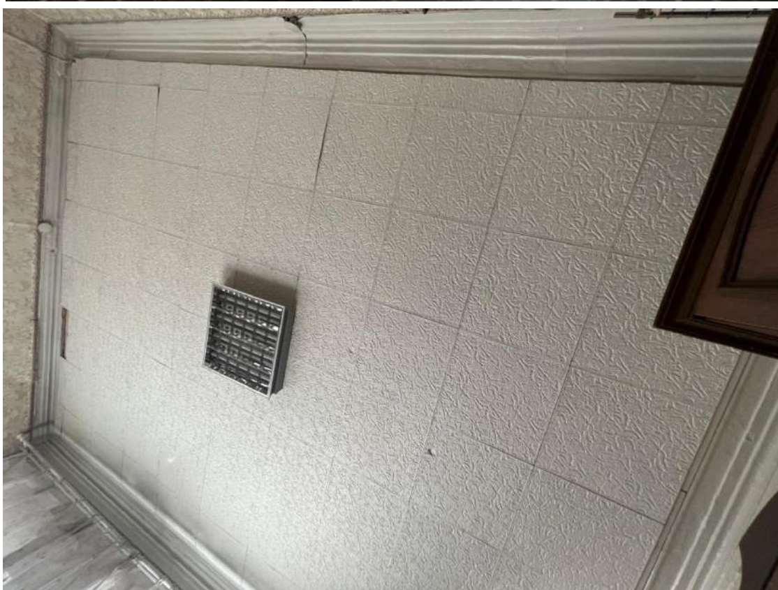
Рис. 24 а, б. Выявленный объект культурного наследия «Дом жилой, одноэтажный, каменный» (ул. Ленина, 50). Помещение № 8 технического плана. Общий вид (вверху), потолочный плафон (внизу)
