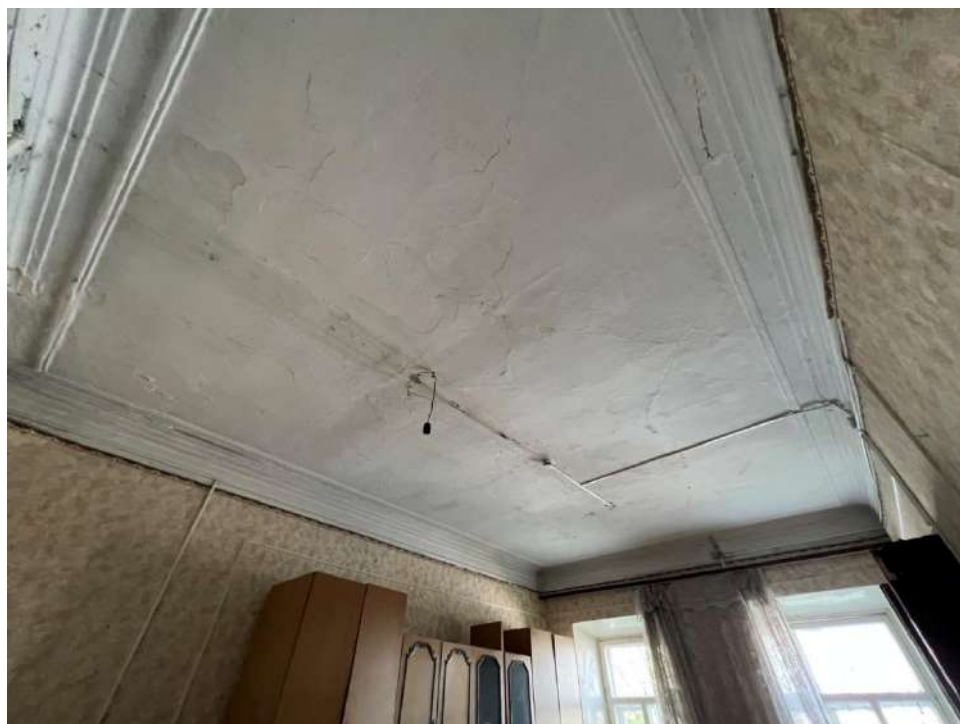
Рис. 26 а, б. Выявленный объект культурного наследия «Дом жилой, одноэтажный, каменный» (ул. Ленина, 50). Помещение № 9 технического плана. Заднее зеркало печи-голландки (лицевой фасад в помещении № 1) (вверху) и потолочный плафон (внизу)
