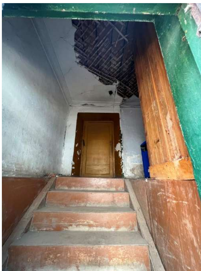
Рис. 16 а, б. Выявленный объект культурного наследия «Дом жилой, одноэтажный, каменный» (ул. Ленина, 50). Входной тамбур со стороны бокового, восточного фасада и лестничный марш
