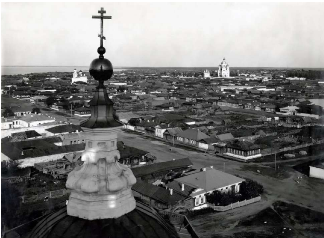
Рис. 20. Каслинский завод. Вид со стороны предзаводской площади. На дальнем плане – Вознесенская церковь. Фото начала 20в. Источник: фонды Пермского краеведческого музея
