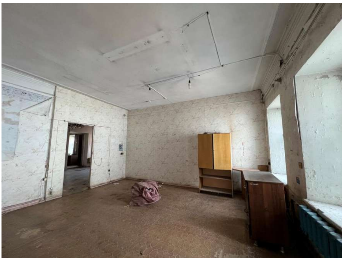
Рис. 18 а, б. Выявленный объект культурного наследия «Дом жилой, одноэтажный, каменный» (ул. Ленина, 50). Помещение № 3 технического плана. Общий вид
