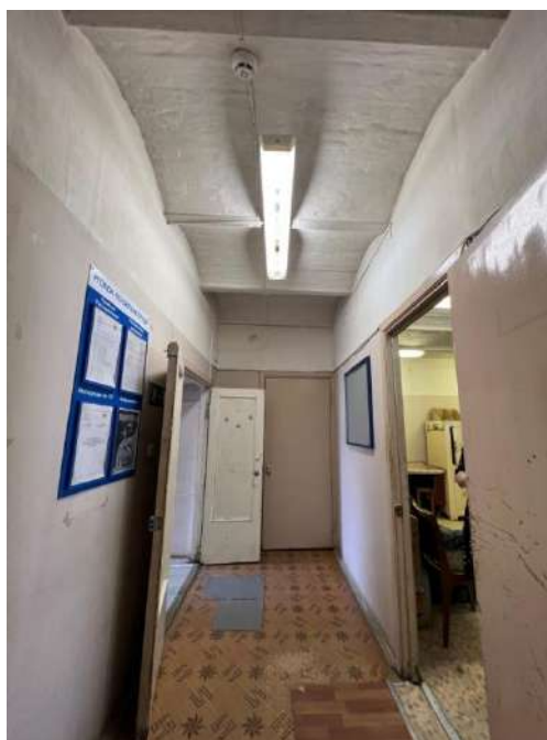
Рис. 31 а, б, в. Объем кладовой. Сводчатые перекрытия
