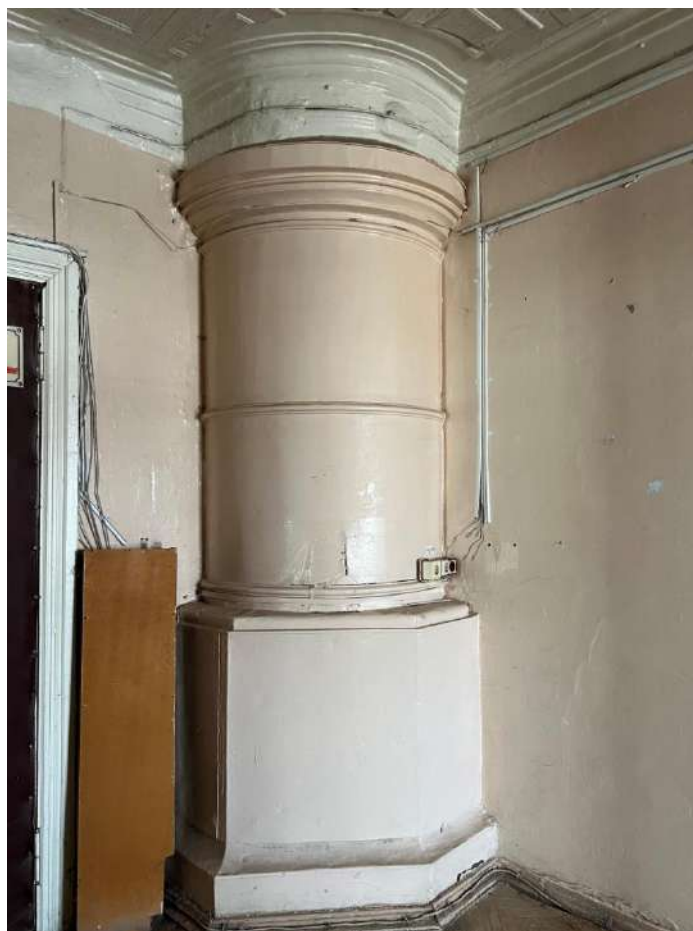
Рис. 20 а, б. Выявленный объект культурного наследия «Дом жилой, одноэтажный, каменный» (ул. Ленина, 50). Помещение № 1 технического плана. Общий вид с поздним входным проемом со стороны ул. Ленина (вверху), угловая печь-голландка (внизу)
