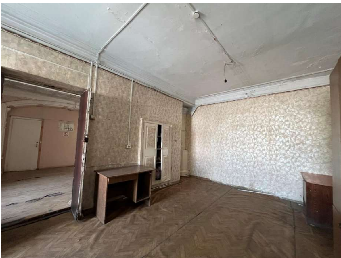
Рис. 25 а, б. Выявленный объект культурного наследия «Дом жилой, одноэтажный, каменный» (ул. Ленина, 50). Помещение № 9 технического плана. Общий вид
