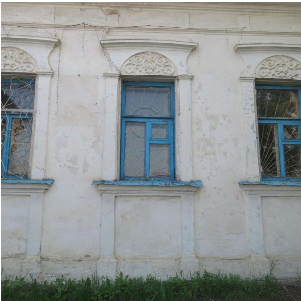
Рис. 12. Выявленный объект культурного наследия «Дом жилой, одноэтажный, каменный» (ул. Ленина, 50). Фрагмент главного, северного фасада. Оформление оконных проемов
