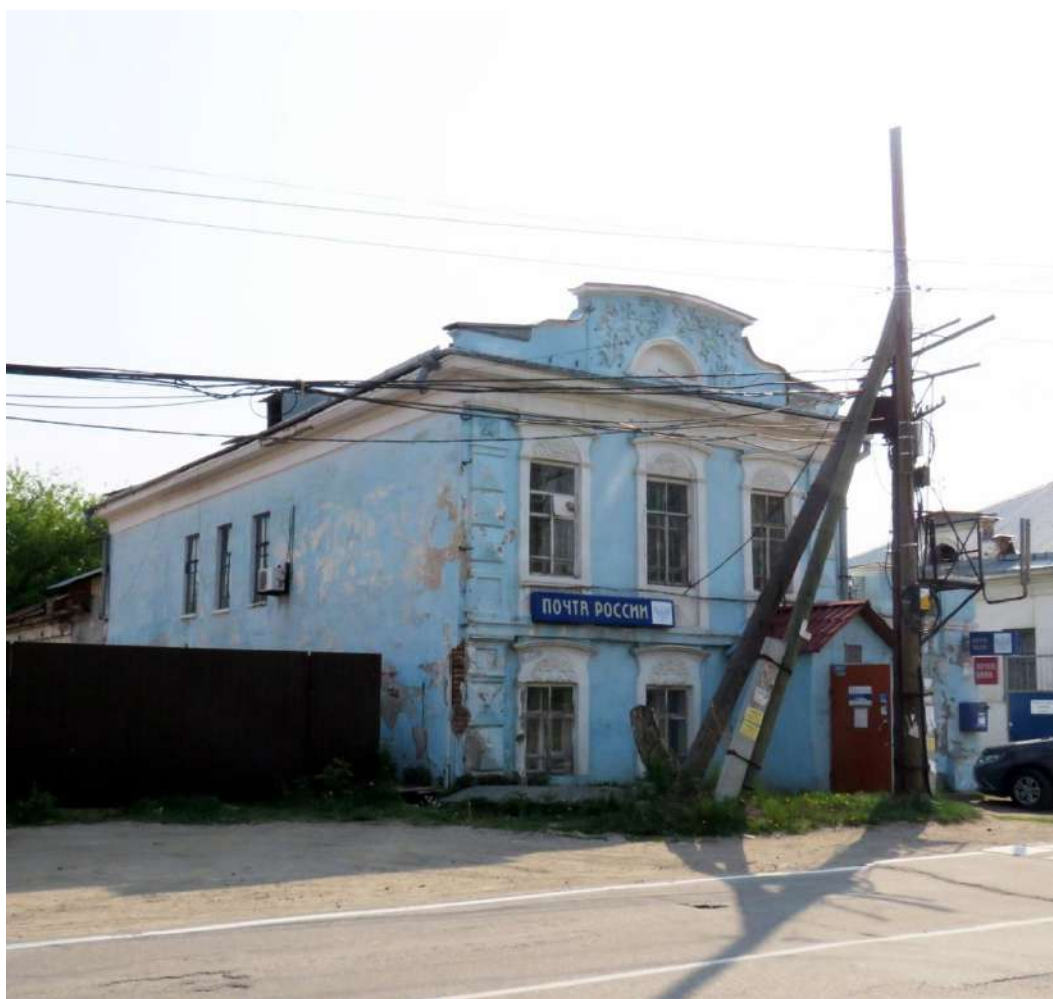
Рис. 2 а, б. Вид на выявленный объект культурного наследия «Особняк купеческий» (ул. Ленина, 52) со стороны ул. Ленина. Вид с северо-запада (вверху) и северо-востока (внизу)
