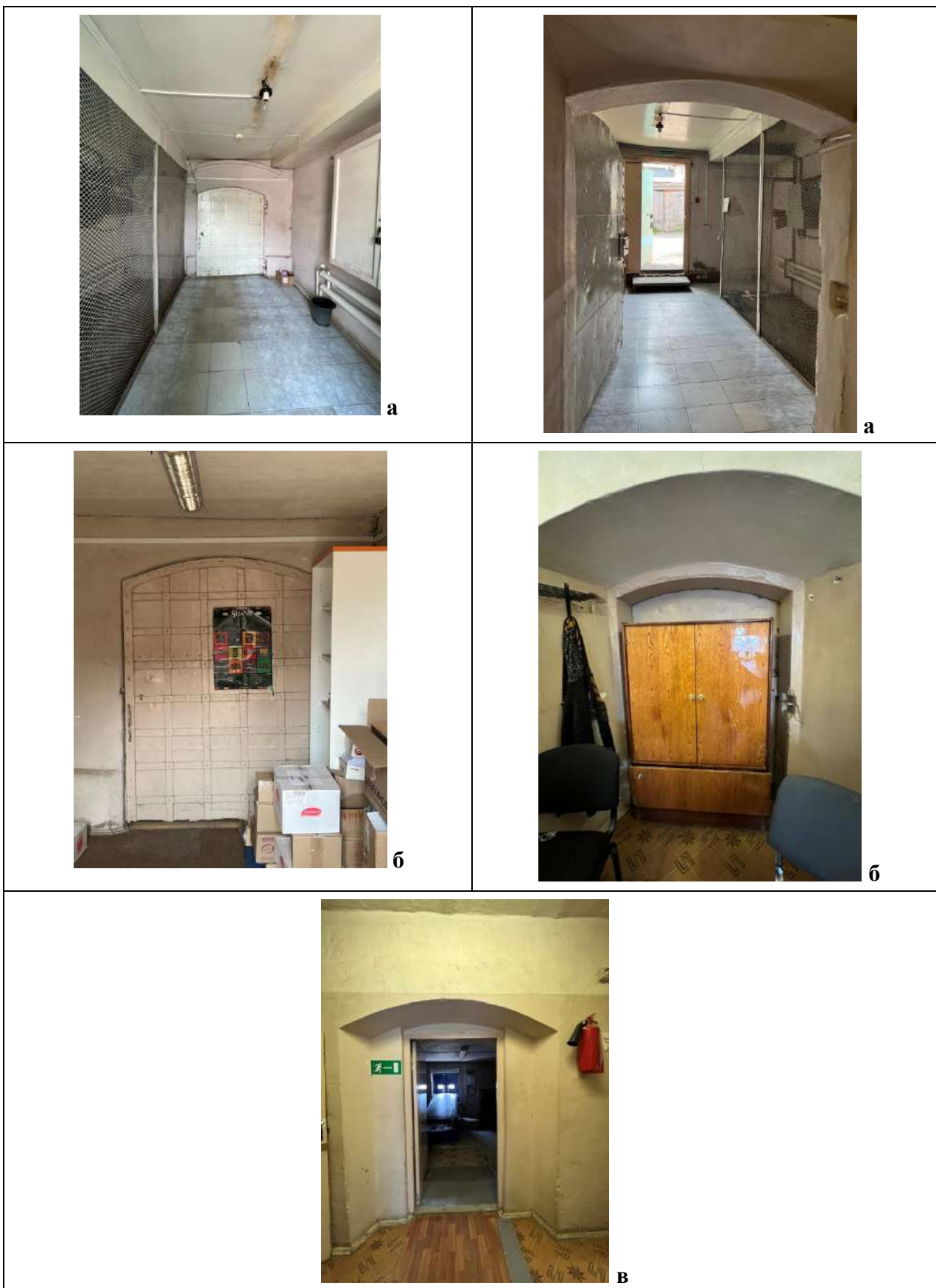
Рис. 30 а, б, в. Объем кладовой. Сохранившиеся 3 исторических проема (а, б, в) и сохранившиеся исторические металлические двери проемов (а, б)
