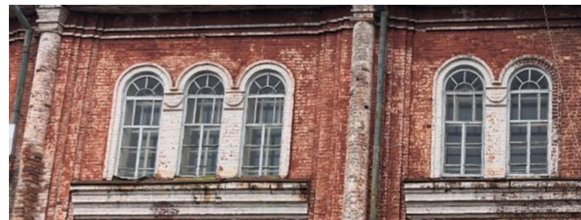
Фрагмент южного/северного фасадов: арочные сдвоенные и строенные оконные проемы в уровне второго света четверика с наличником
