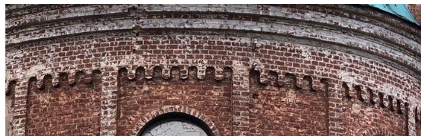
Фрагмент восточного фасада: зубчатое прясло из кирпича на апсидах
