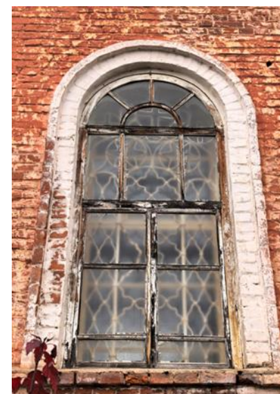
Фрагмент южного/северного фасадов: арочный оконный проем в уровне первого яруса с наличником
