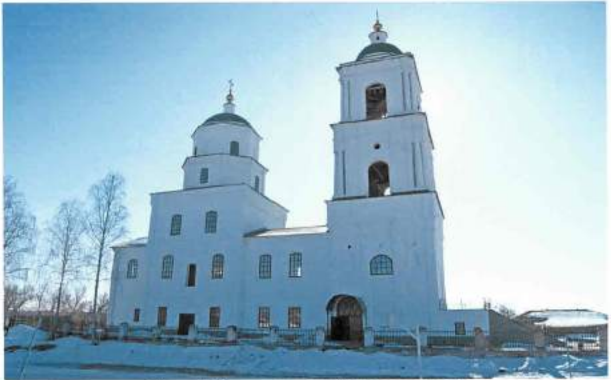
Фото 1. Вид на северный фасад церкви
