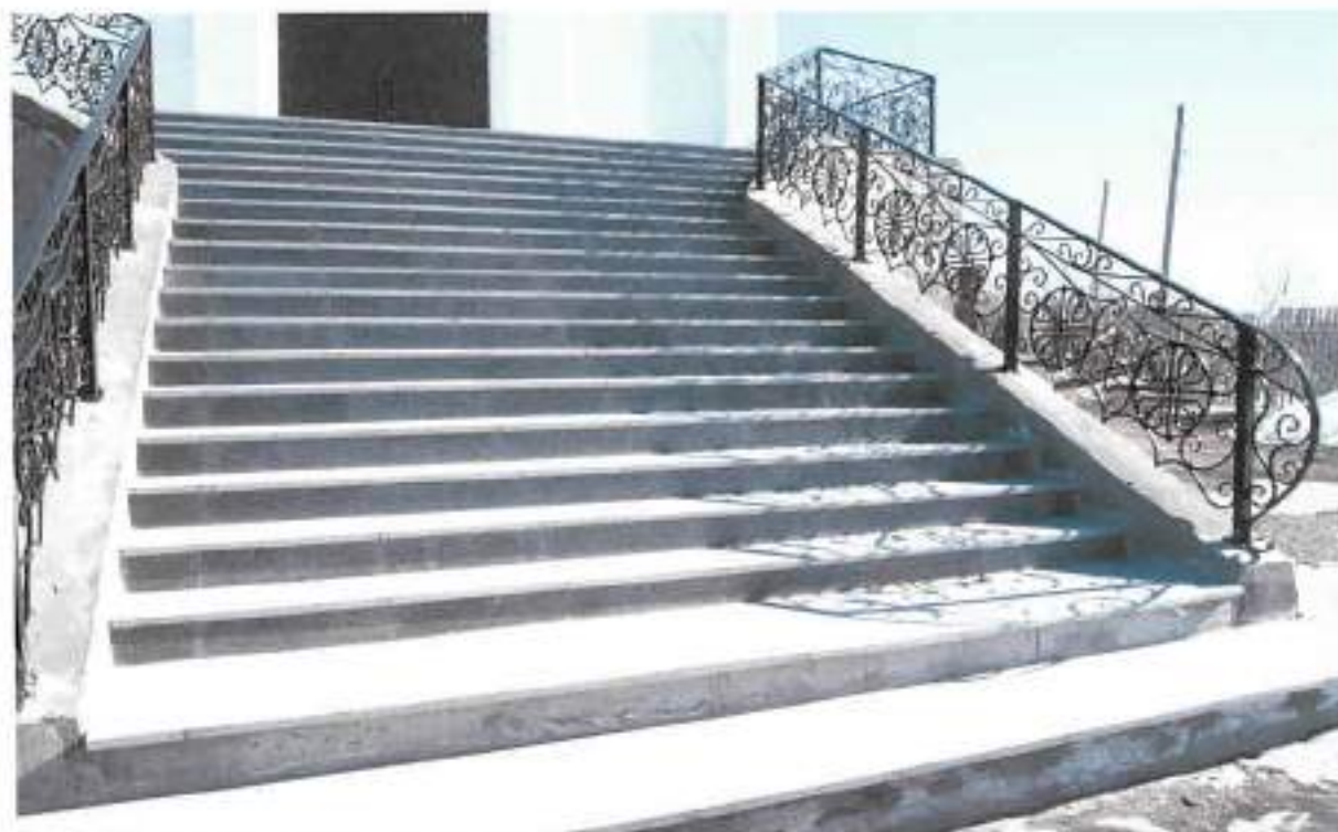
Фото 10. Вид на лестничный марш при входе на 2-й этаж церкви
