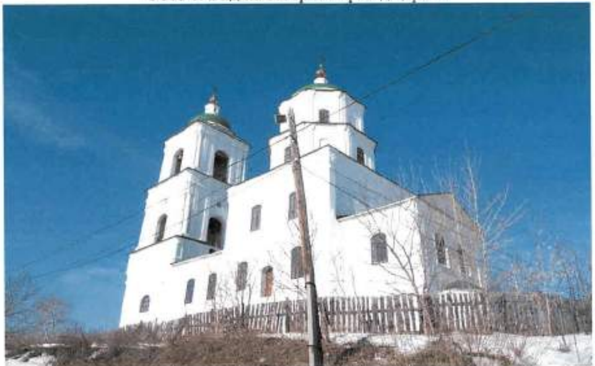
Фото 2. Южный фасад церкви. Вид с юго-востока
