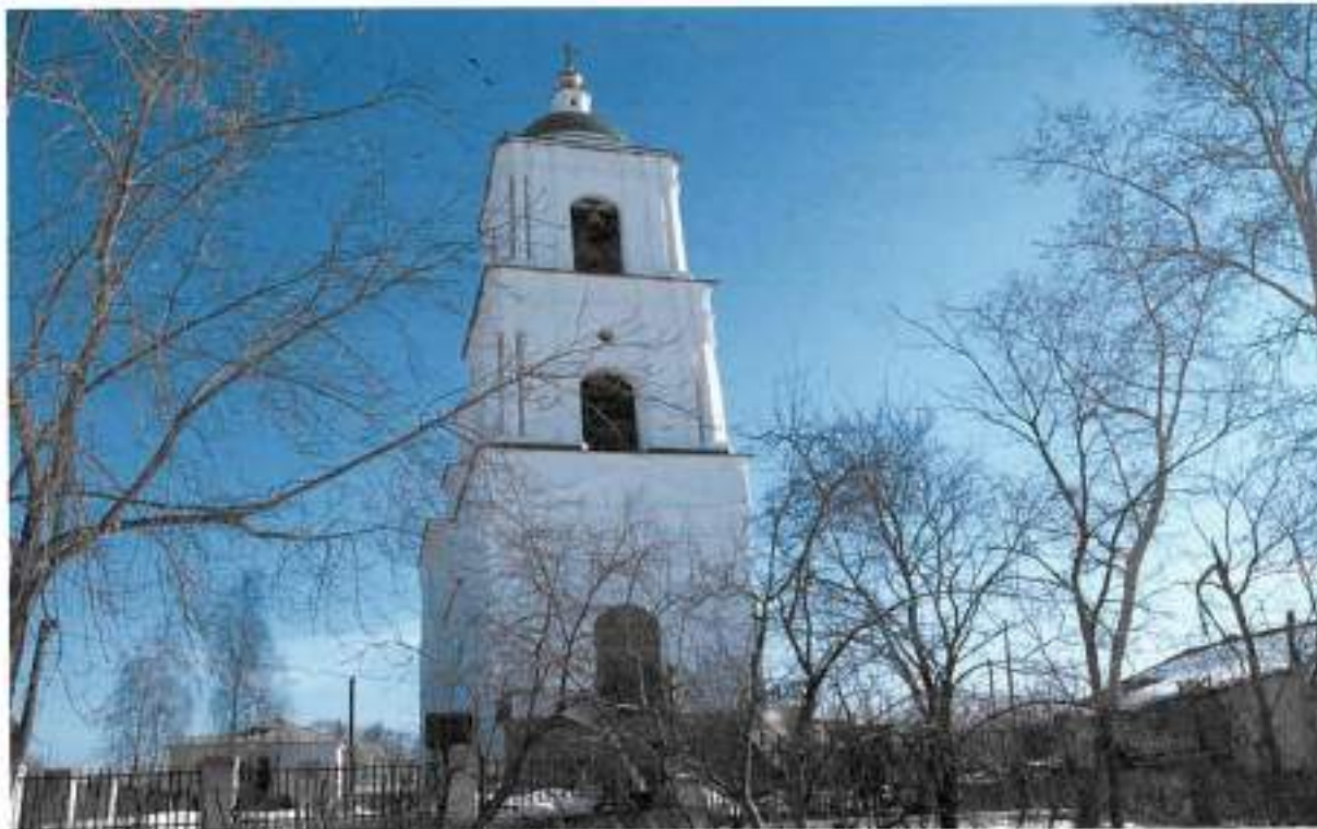
Фото 5. Вид на церковь с запада
