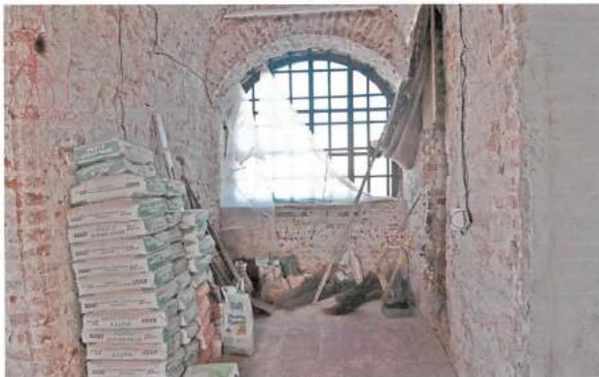
Фото 29. Фрагмент помещения № 4 с цилиндрическим сводом в верхнем этаже церкви
