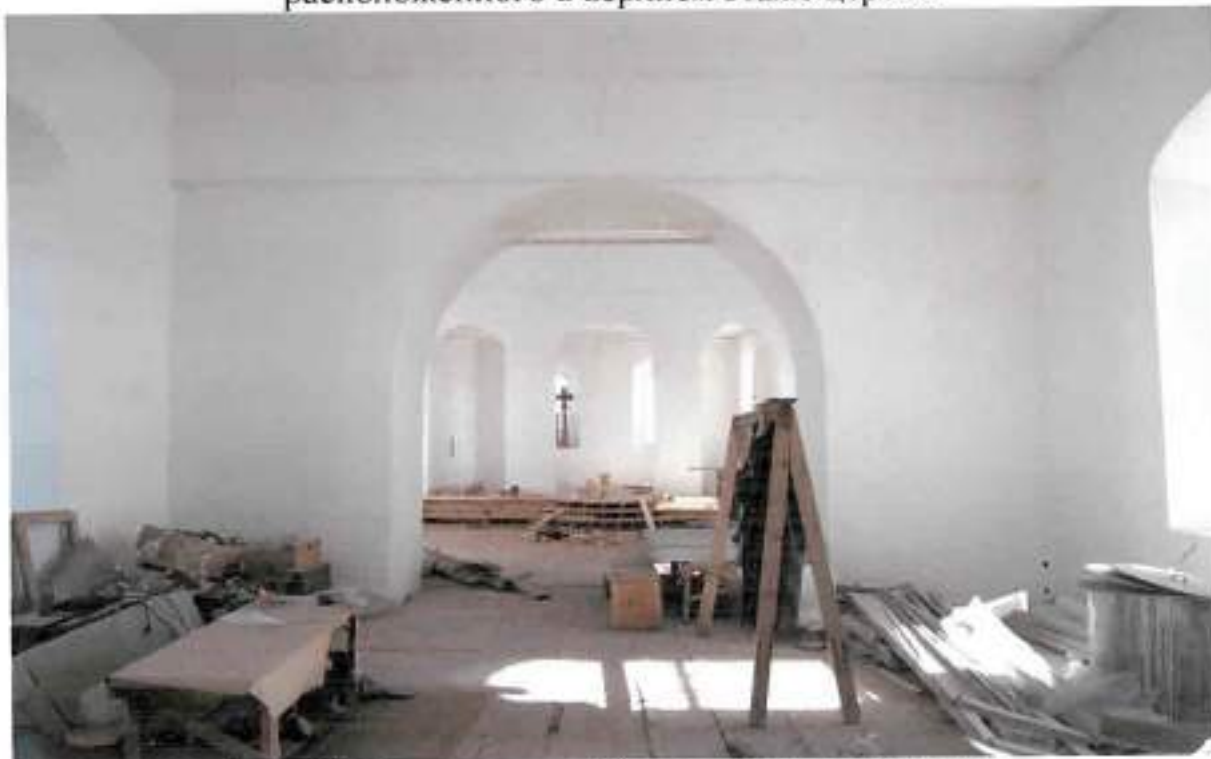
Фото 24. Вид на арочный проем в храмовую часть в верхнем этаже церкви
