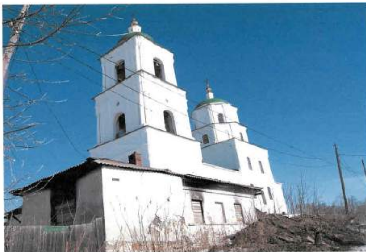
Фото 4. Вид на церковь с юго-запада
