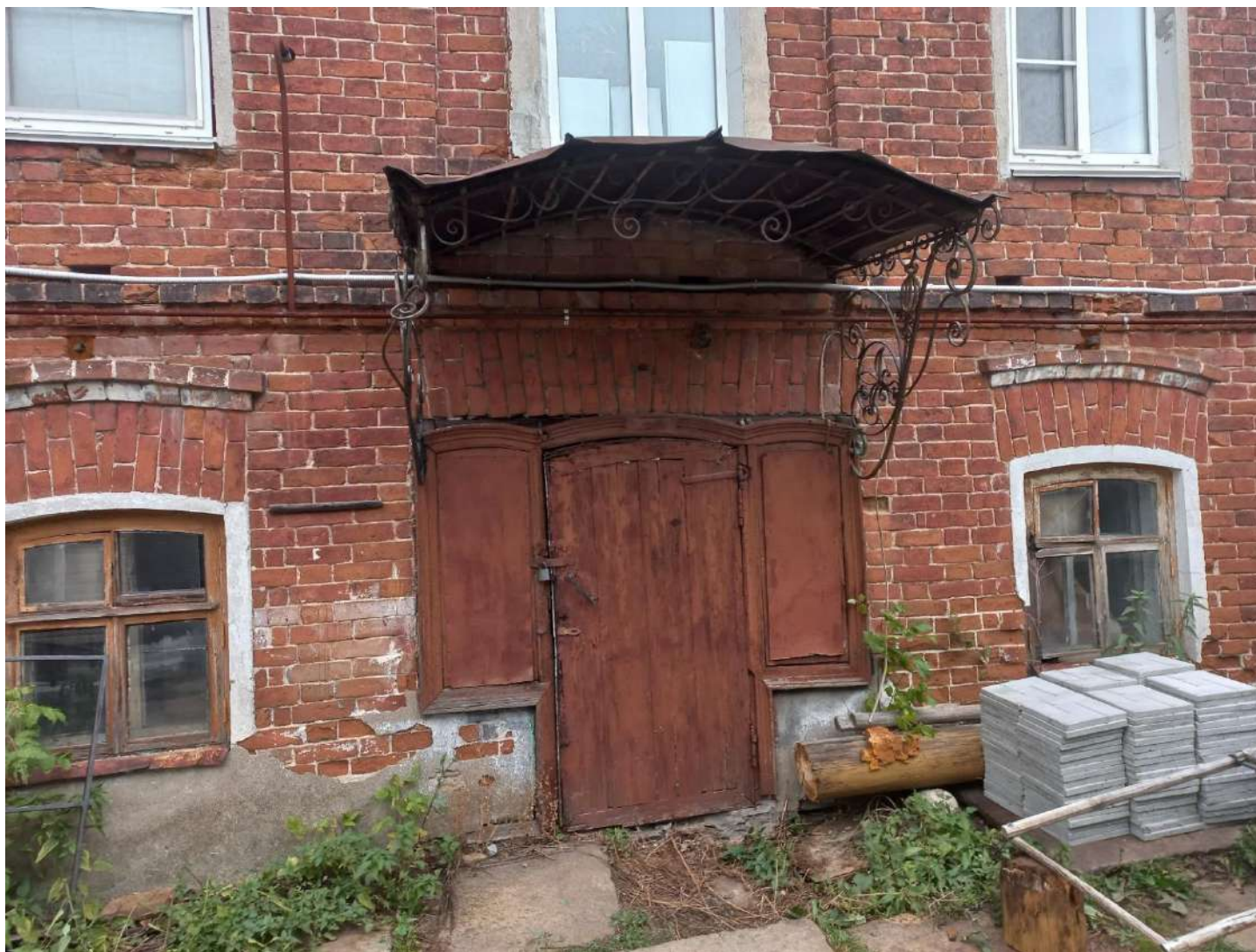
12. Вид на дворовой фасад. Козырек. Октябрь 2023 г.
