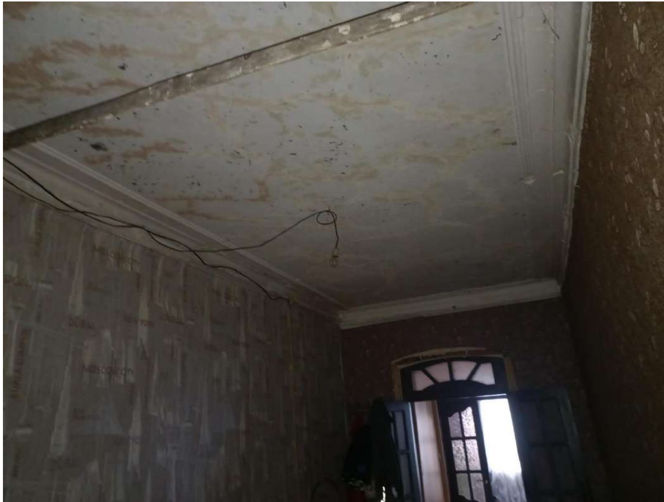
27. Интерьер. Потолочные карнизы.
