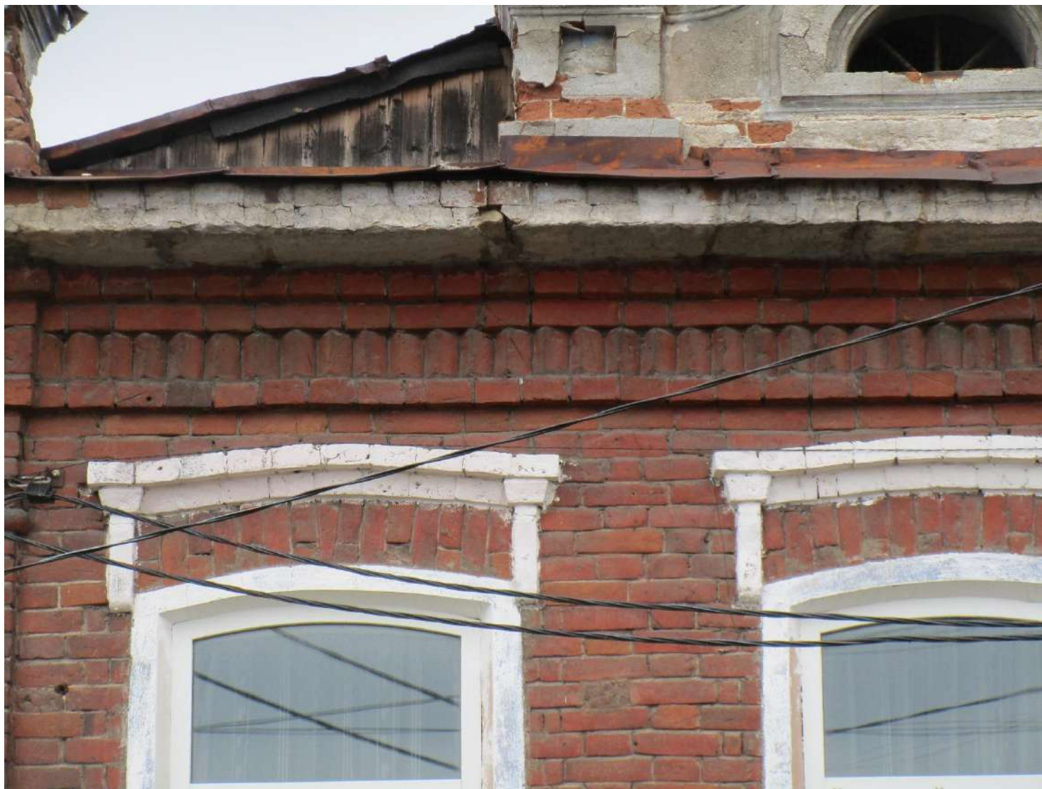
19. Фрагмент главного фасада. Поробрик фриза. Каменный карниз. Лучковые сандрики на кронштейнах. Октябрь 2023 г.
