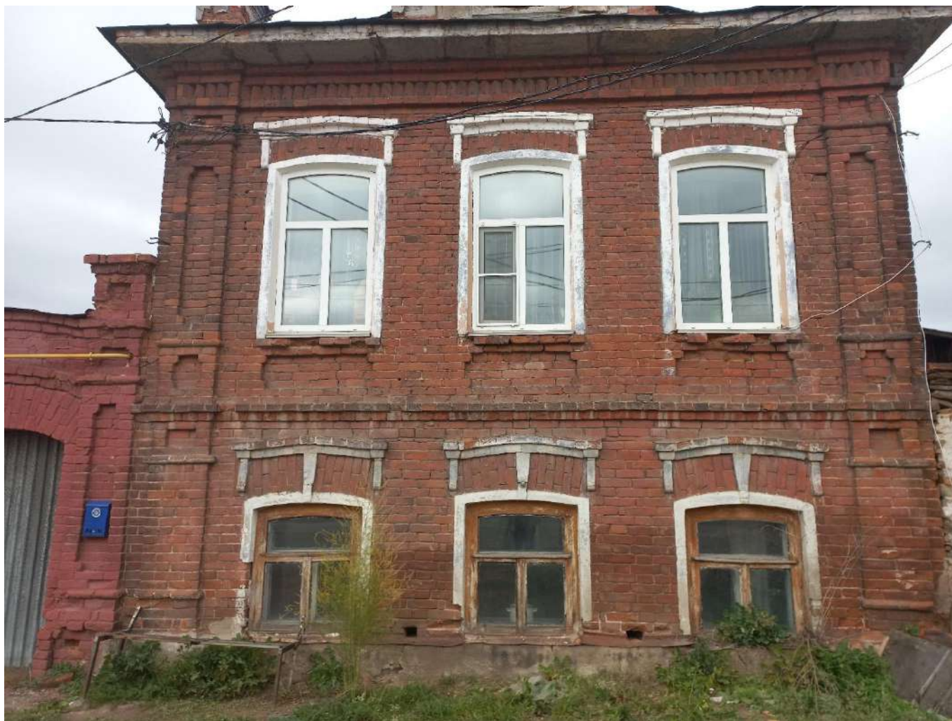
8. Главный юго-восточный фасад. Октябрь 2023 г.
