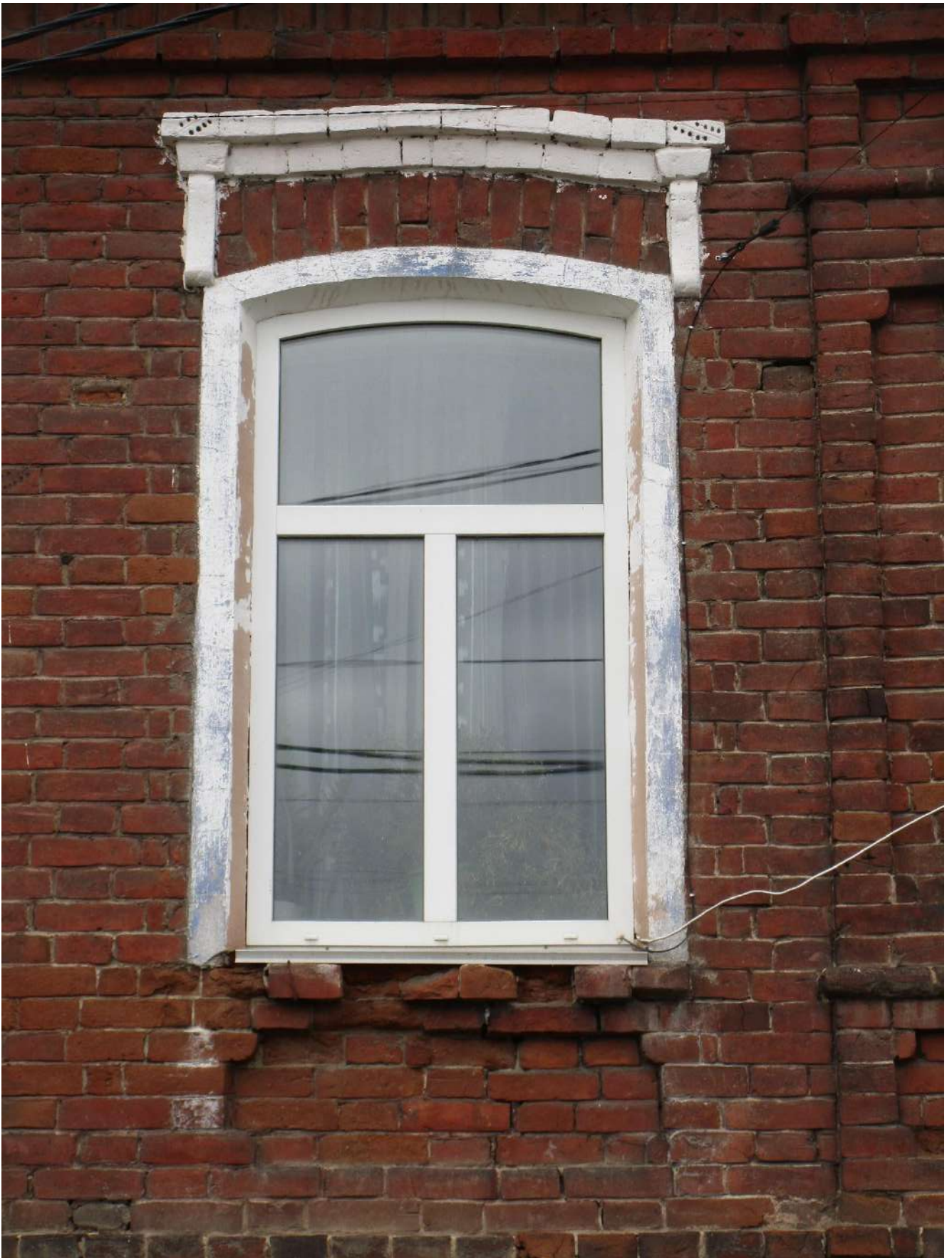
18. Фрагмент главного фасада. Оконный проем в уровне второго этажа. Штукатурный наличник. Сандрик на кронштейнах. Октябрь 2023 г.
