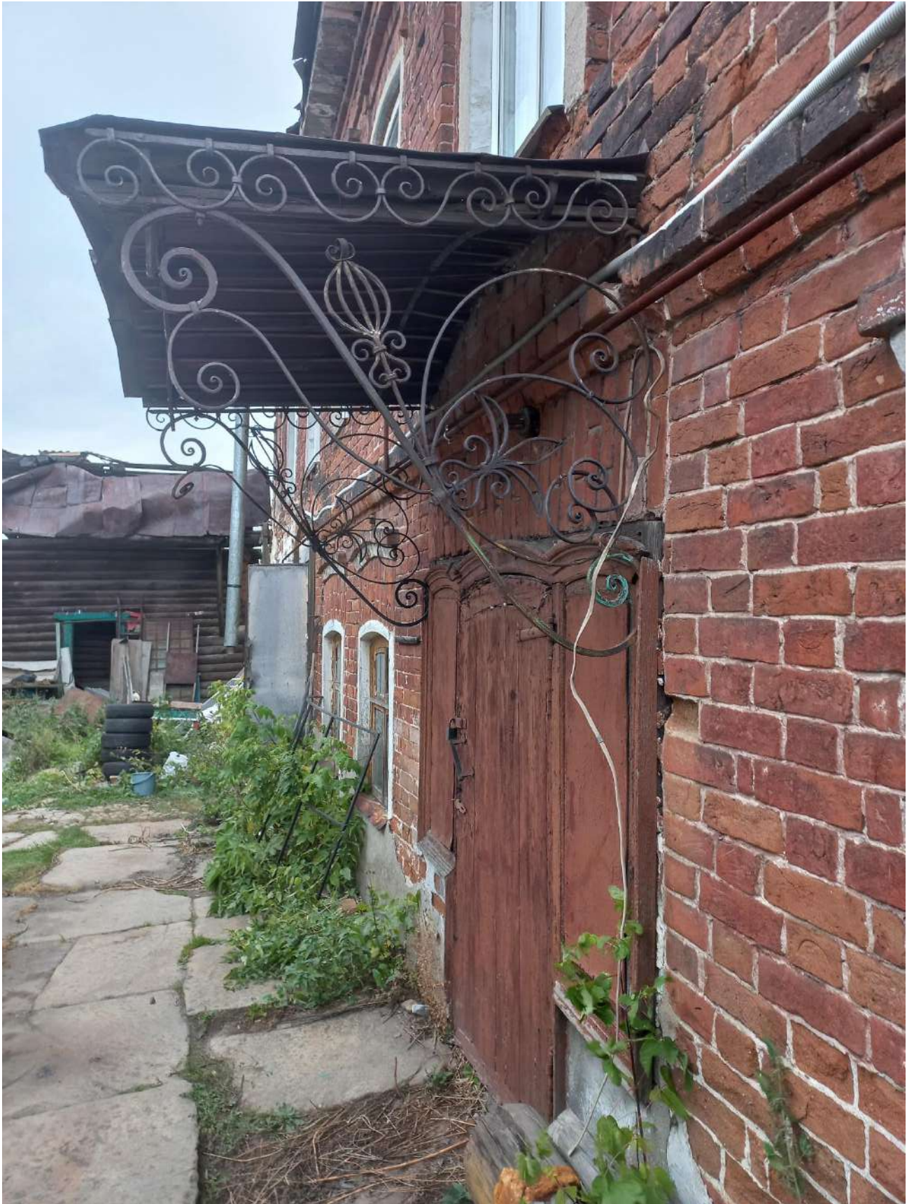
14. Дворовой фасад. Козырек, вид сбоку. Октябрь, 2023 г.
