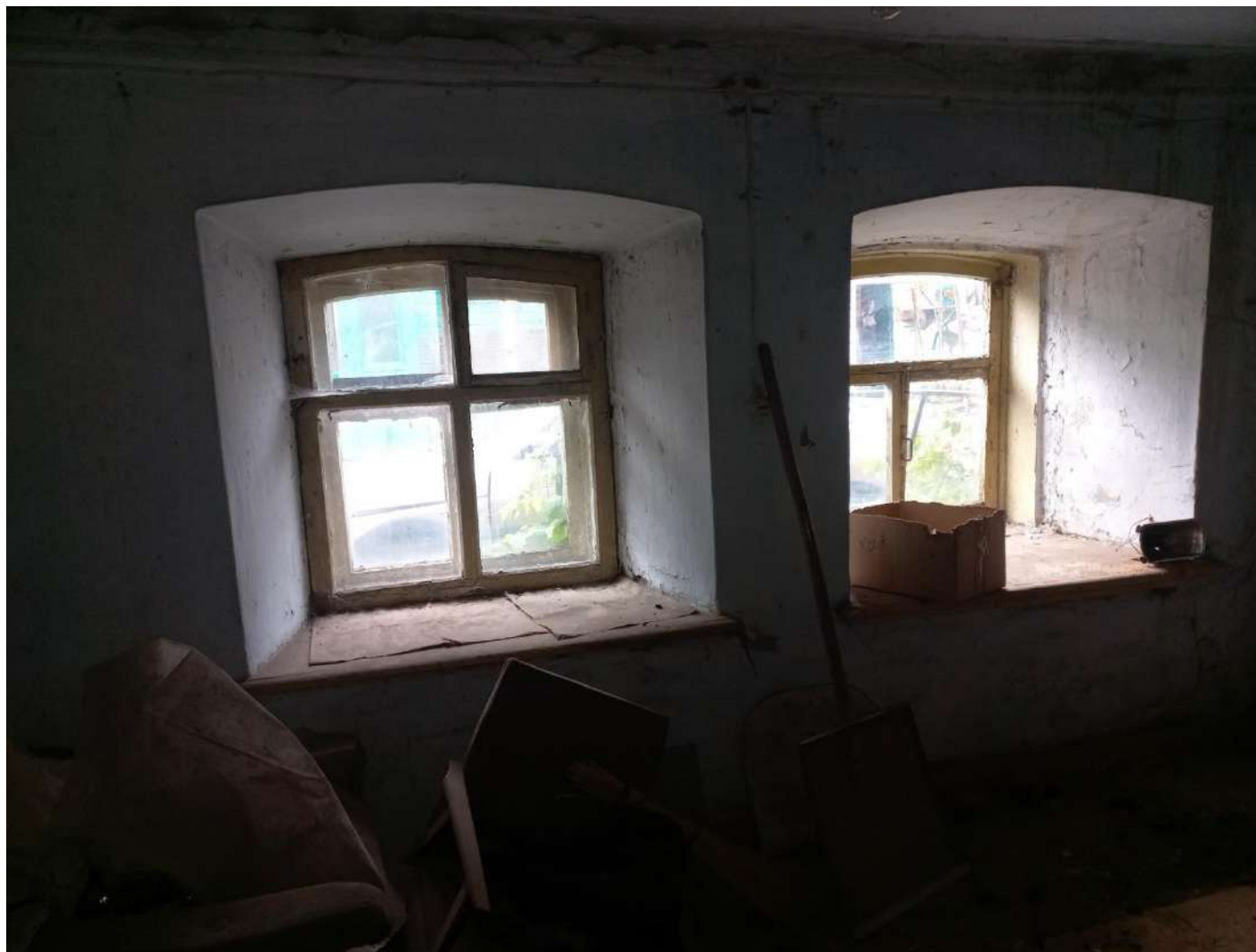
29. Интерьер. Первый этаж. Оконные проемы. Переплеты, подоконники. Откосы с рассветами.
