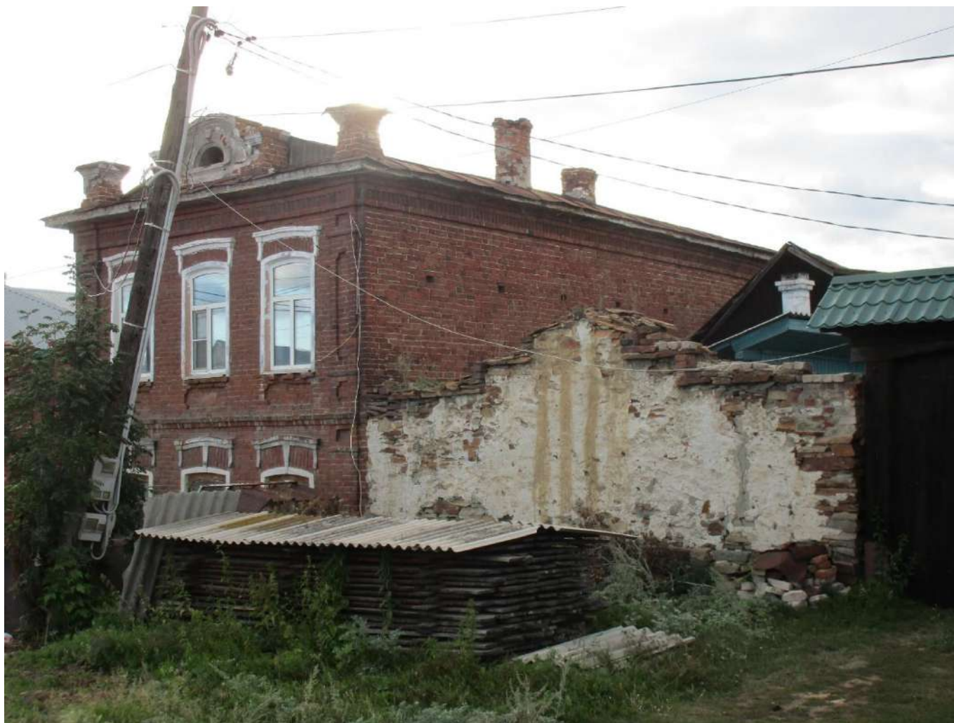
5. Вид с востока. Видна металлическая фальцевая кровля. Август 2023 г.
