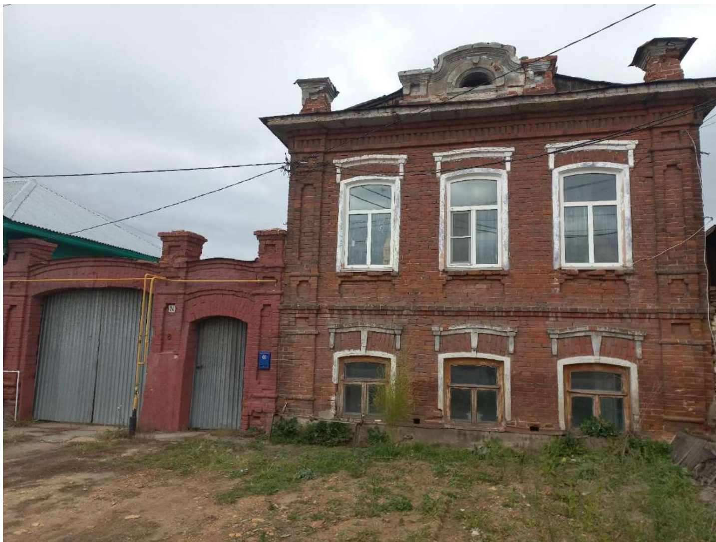
7. Главный юго-восточный фасад. Октябрь 2023 г.
