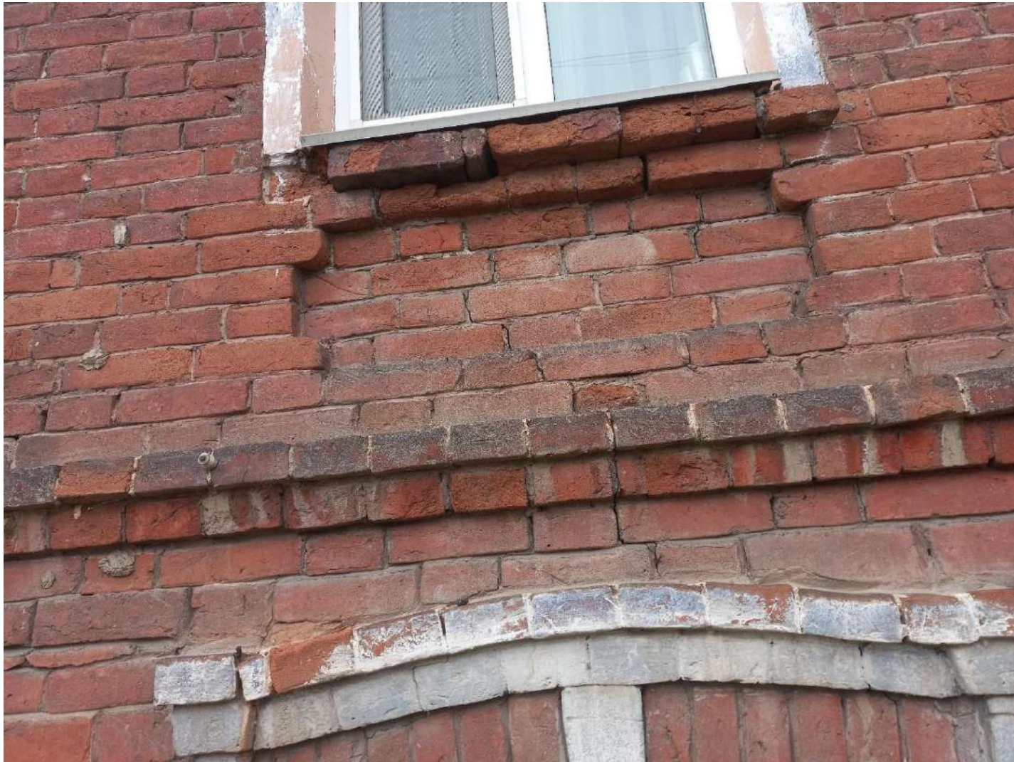
16. Подоконная филенка. Октябрь 2023 г.
