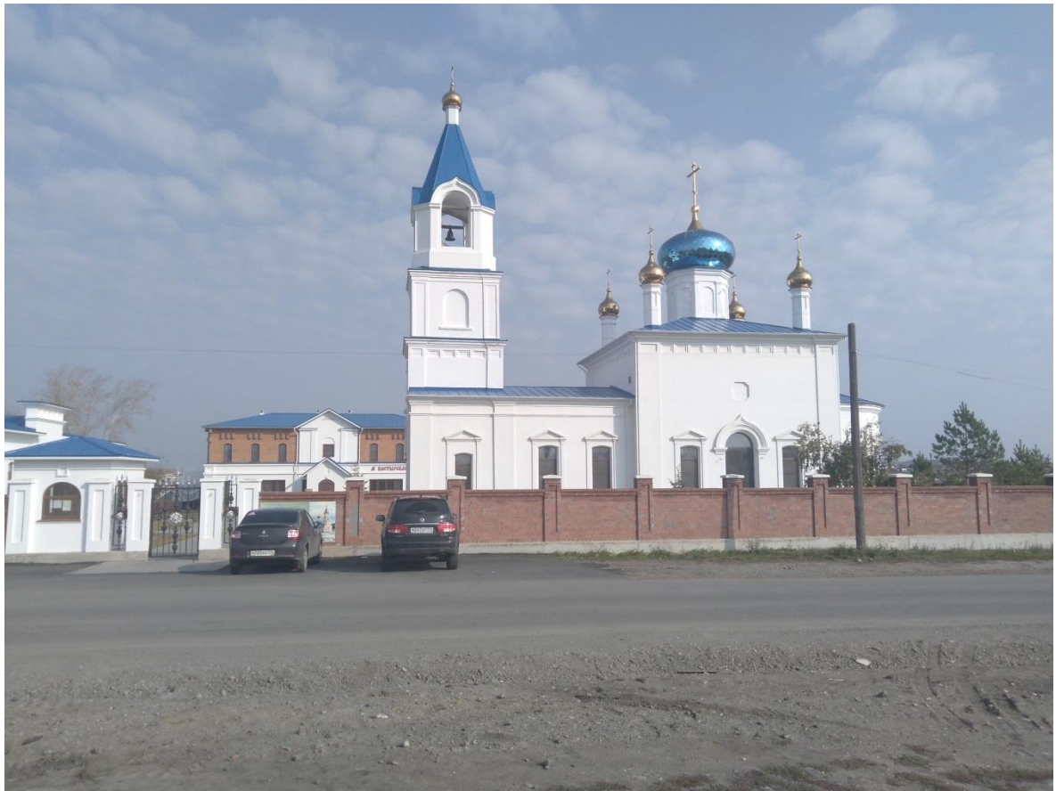
Фото 3. Вид памятника с южной стороны. 03.10.2020
