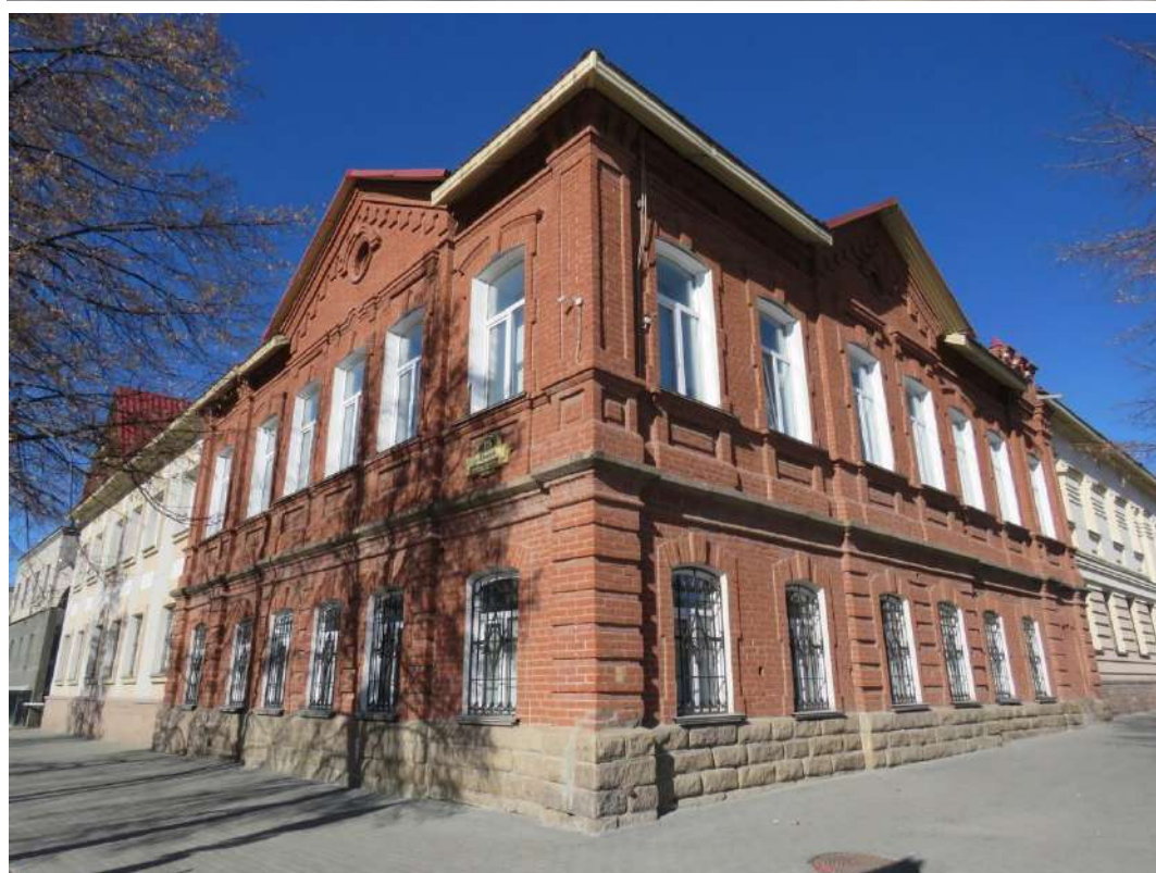
Рис. 3 а, б. Лицевые (западный и южный) фасады
