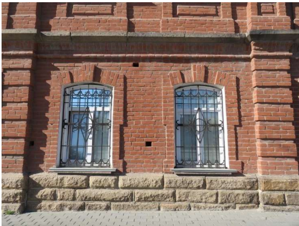
Рис. 9. Фрагмент южного фасада. Решение оконных проемов первого этажа
