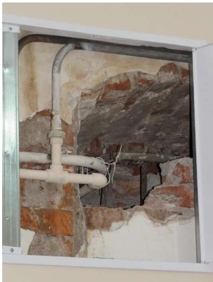
Рис. 14. Фрагмент исторической стены и арочного проема, скрытых за обшивкой ГВЛ.
