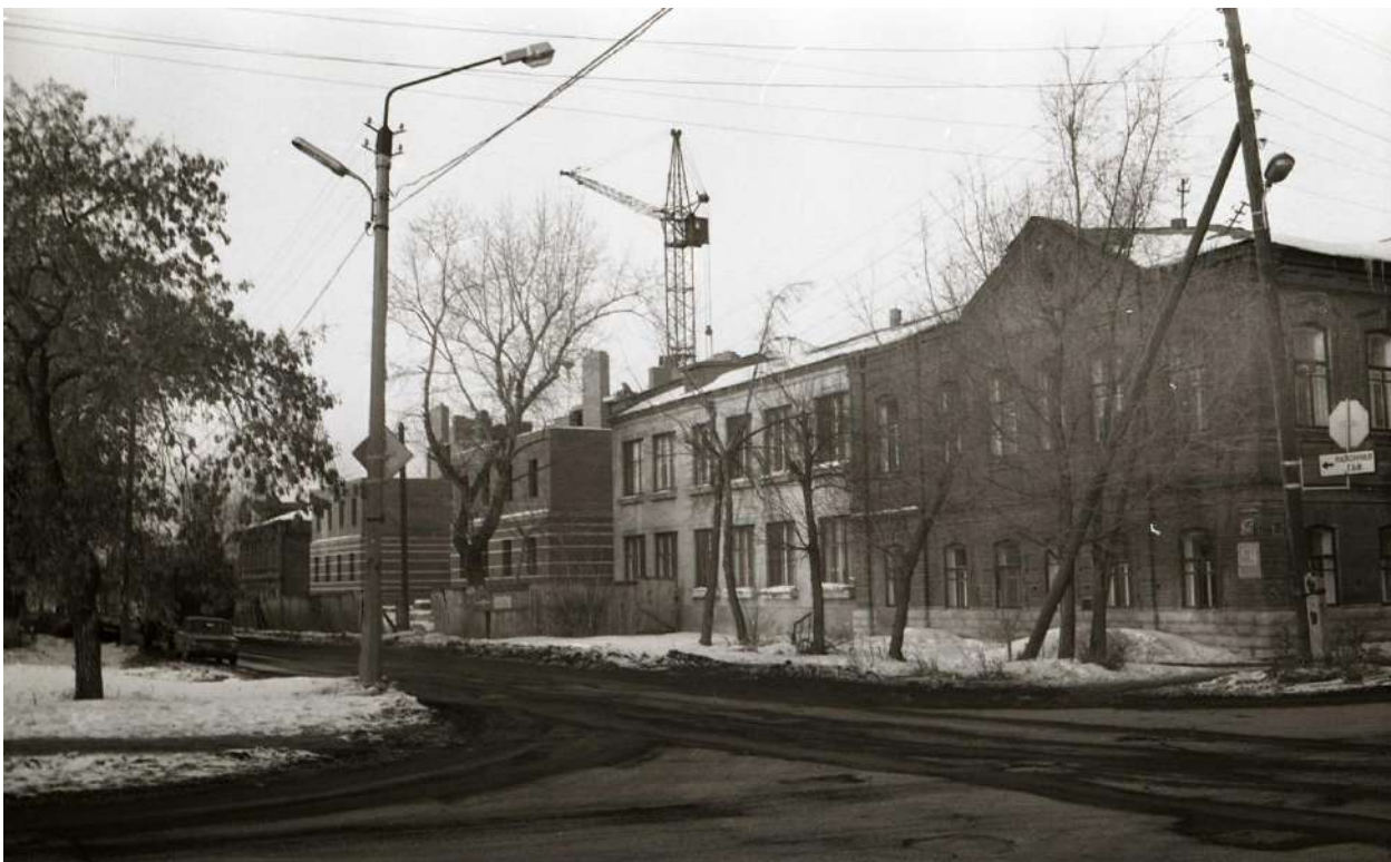
Рис. 25. Вид на восточную сторону ул. Елькина на пересечении с ул. Маркса (вид с юго-запада). На первом плане – здание по адресу Елькина, 15 / Маркса, 76 (литера «А»). Фото К.В. Хлобыстова, 1993 г. Источник: фонды Центра историко-культурного наследия Челябинска
