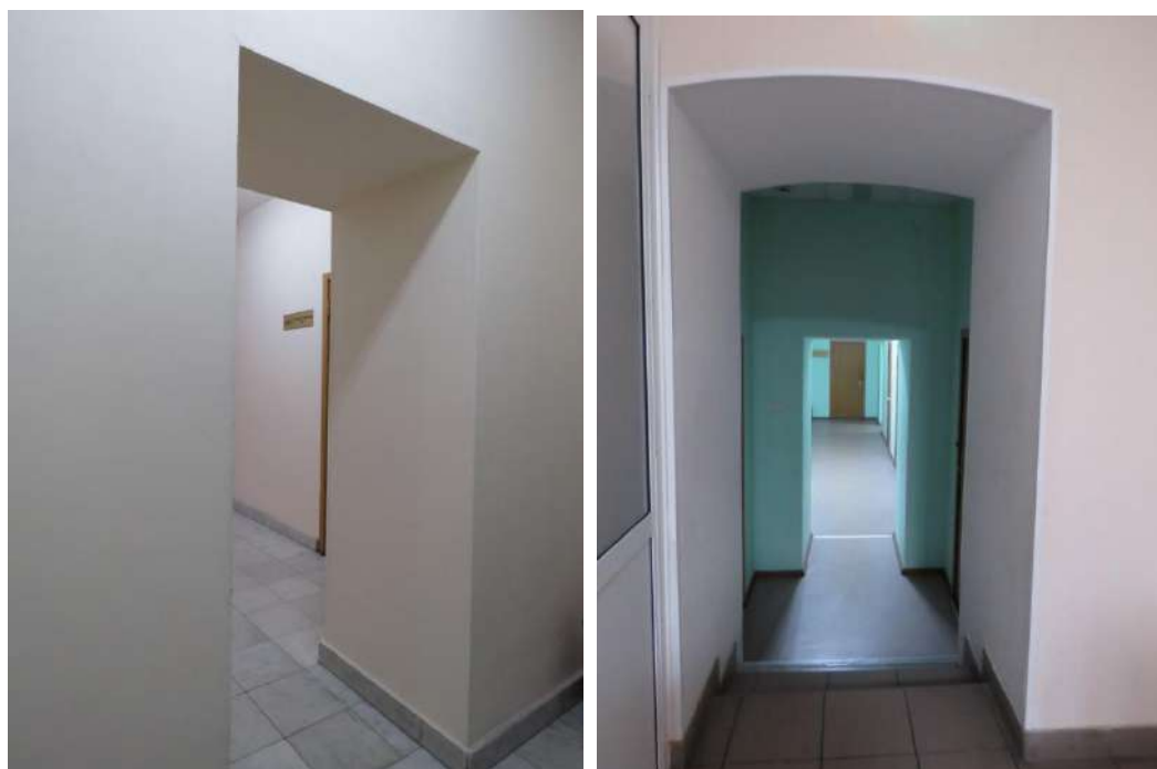
Рис. 19 а, б. Фрагменты интерьеров первого (а) и второго (б) этажей: проемы в исторических стенах
