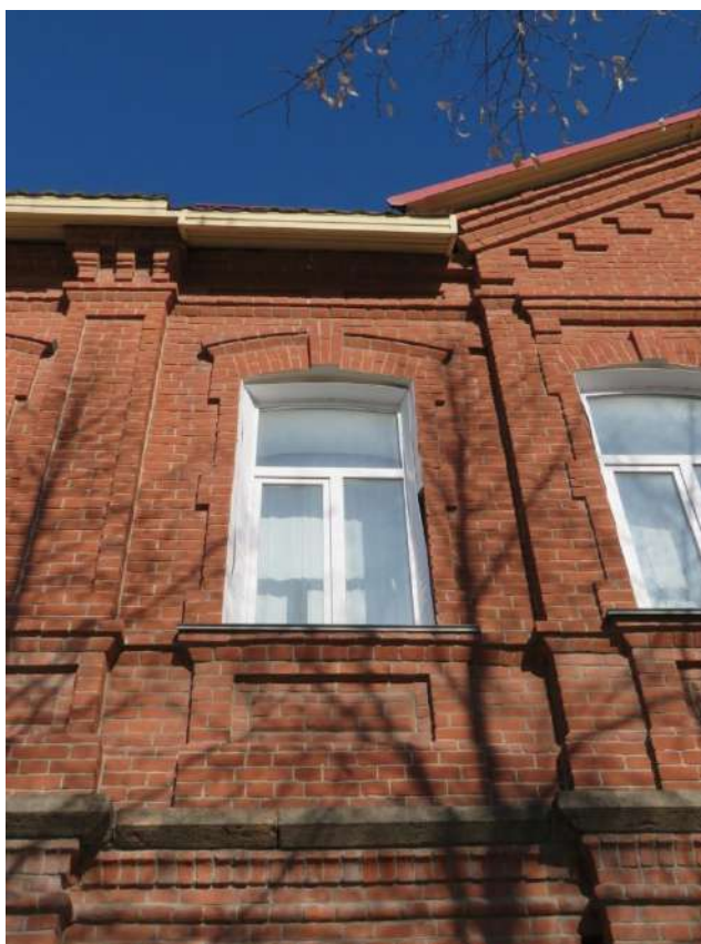
Рис. 10. Фрагмент западного фасада. Решение оконного проема второго этажа
