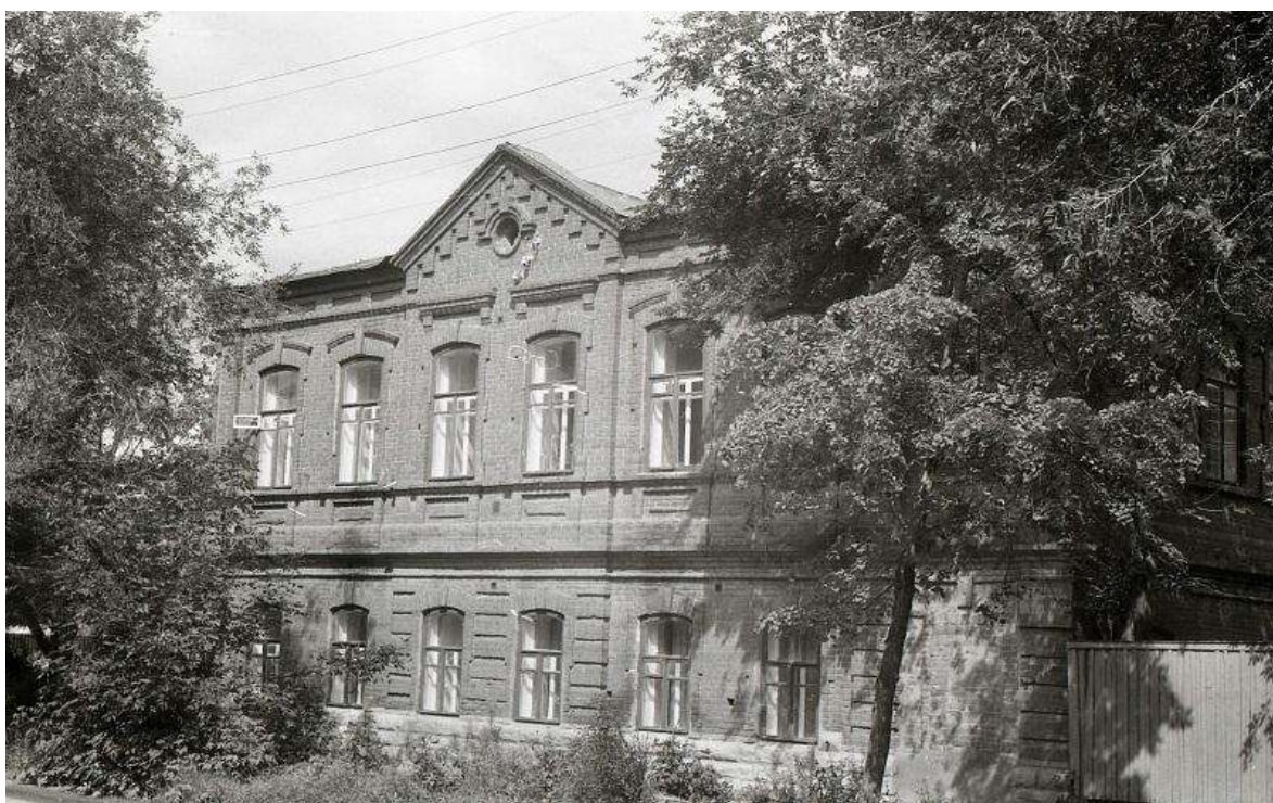
Рис. 22. Дом А.С. Бухарина. Южный фасад. Вид с юго-востока. Фото 1990-х гг. Источник: фонды Центра историко-культурного наследия Челябинска
