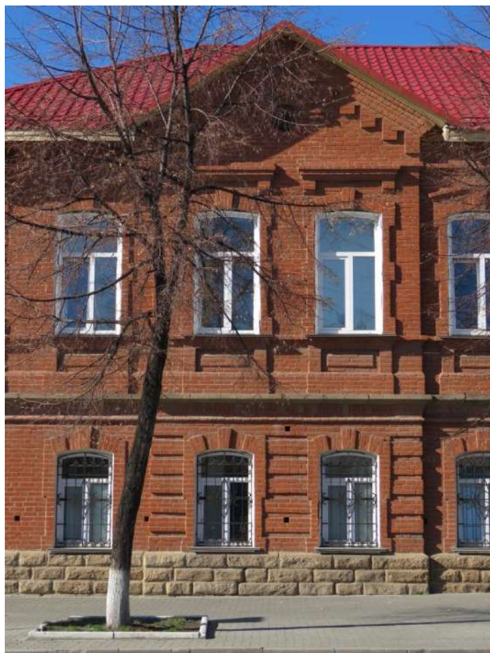
Рис. 8. Фрагмент южного фасада. Решение центрального ризалита с щипцовым завершением
