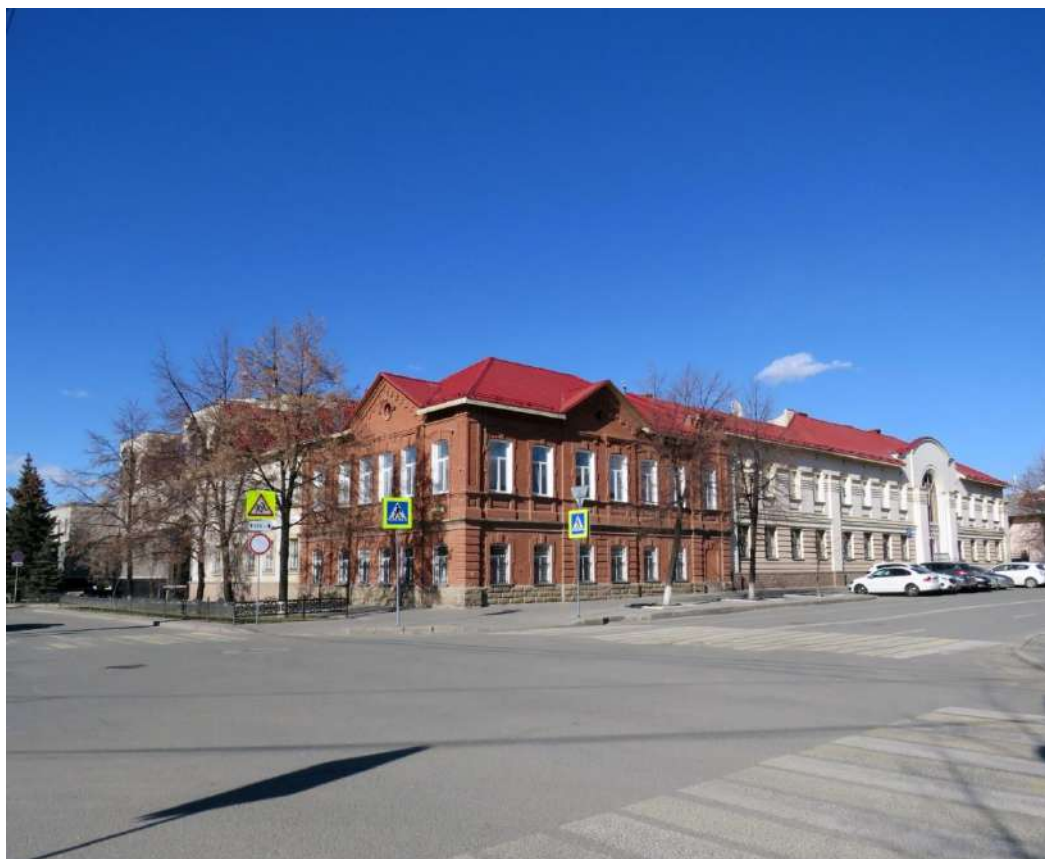
Рис. 1. Вид на здание со стороны перекрестка ул. Елькина и Маркса (вид с юго-запада)
