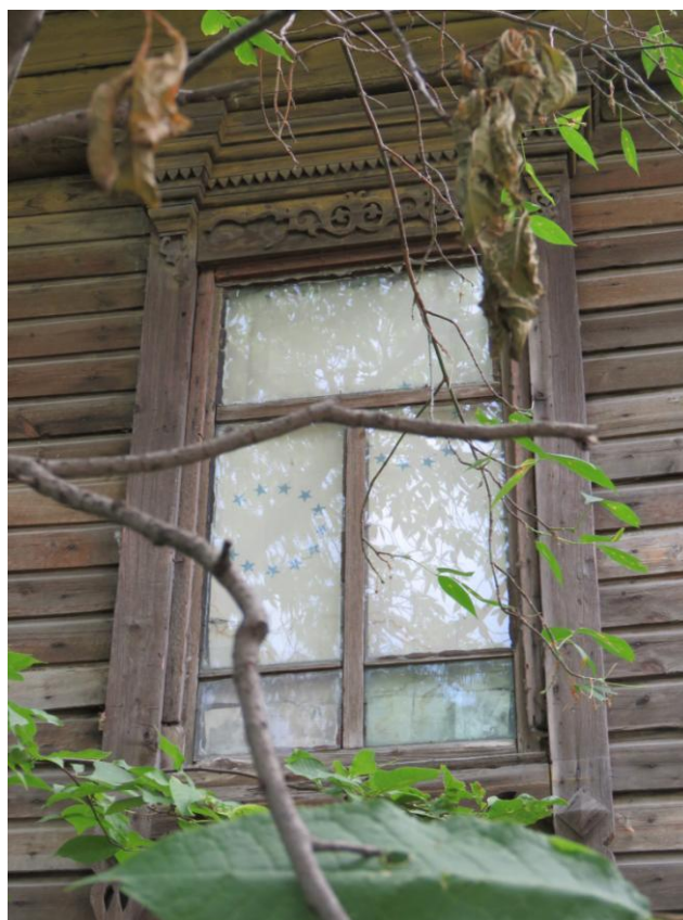
Рис. 8. Наличник оконного проема северного фасада
