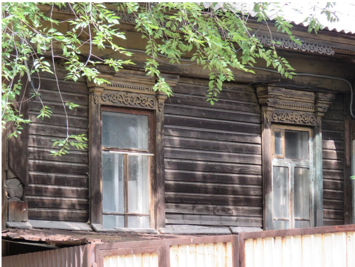
Рис. 5. Оконные проемы в наличниках. Южный фасад.
