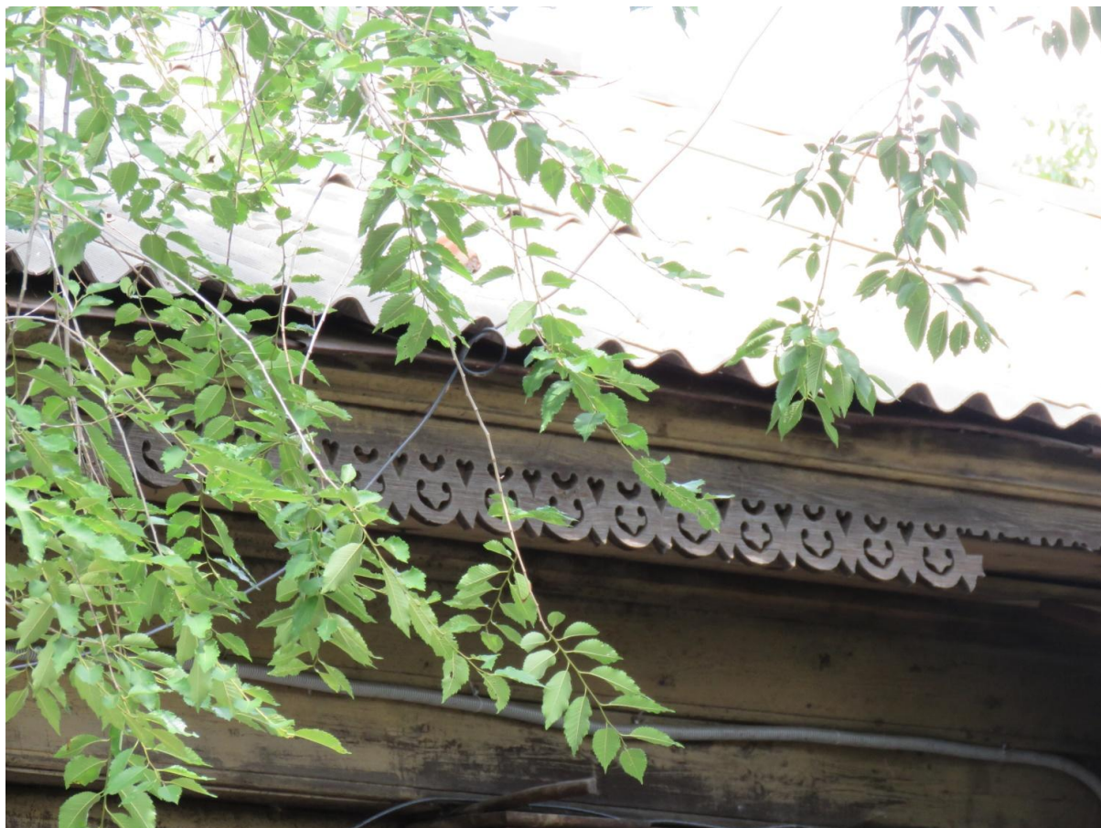
Рис. 11. Подзор с пропильной резьбой южного фасада
