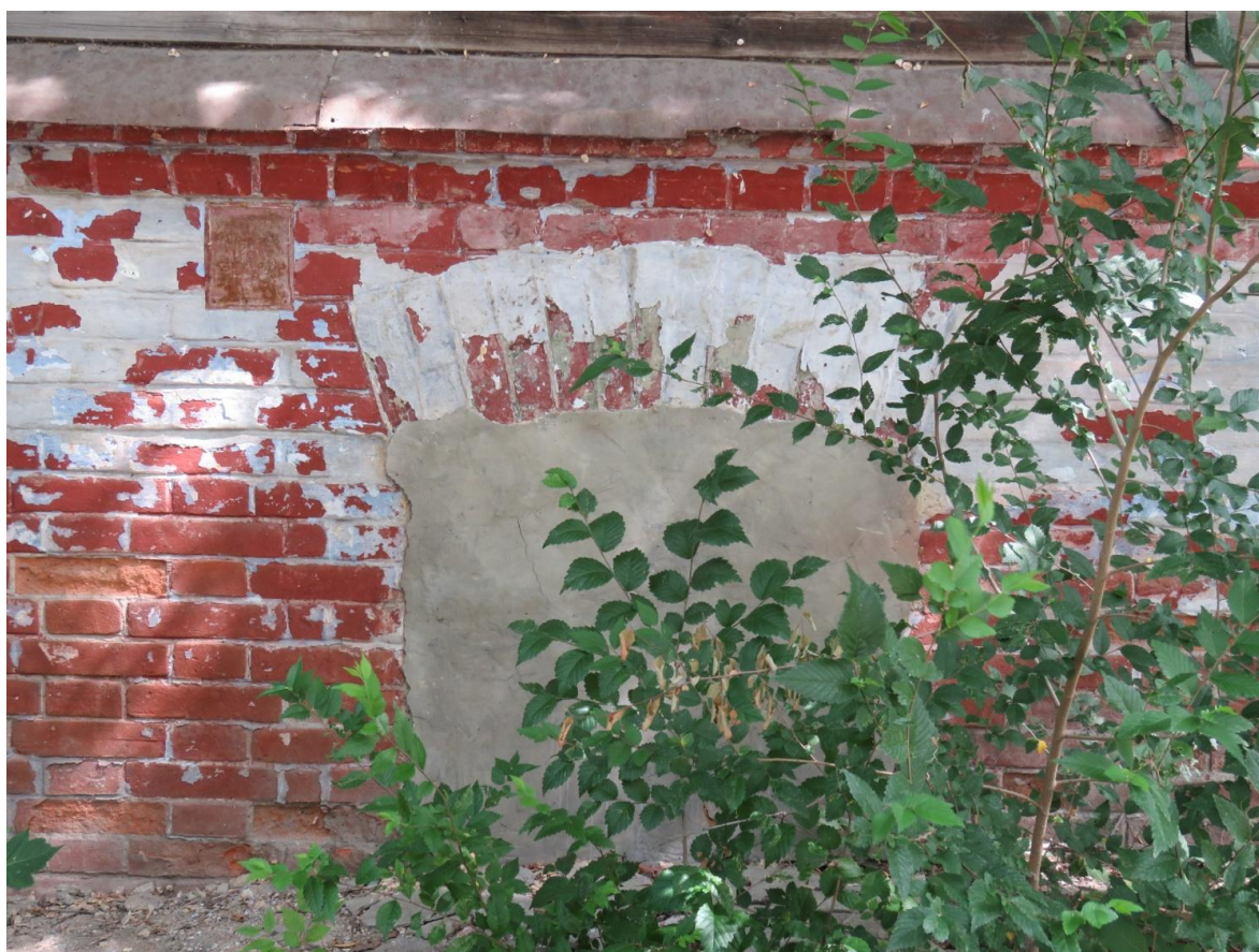
Рис. 4. Оконный проем цокольного этажа. Западный фасад.
