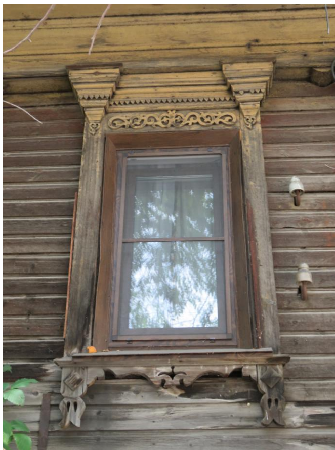
Рис. 7. Наличник оконного проема западного фасада
