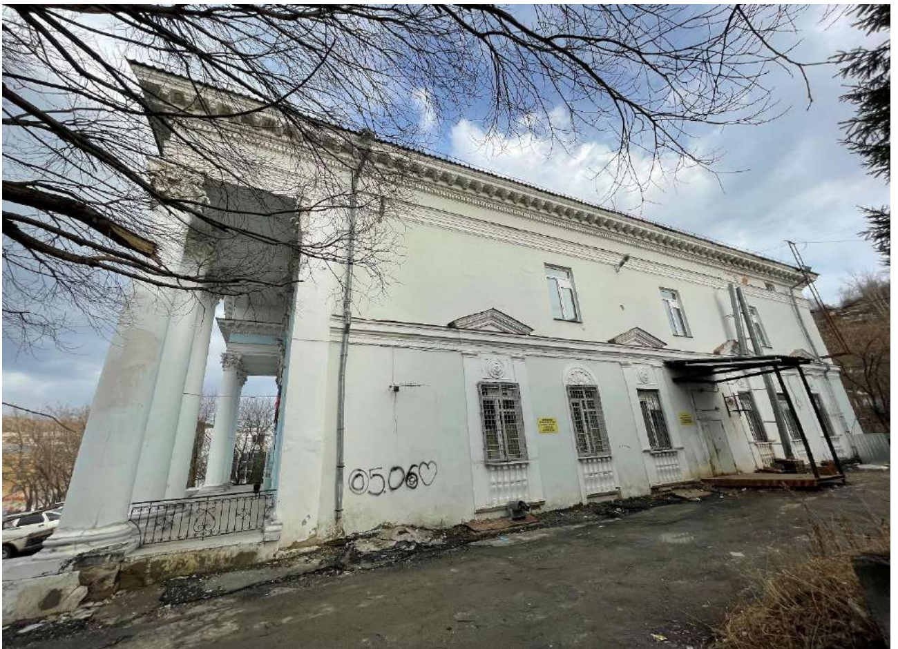
Фото 4. Объект культурного наследия. Общий вид с З.
