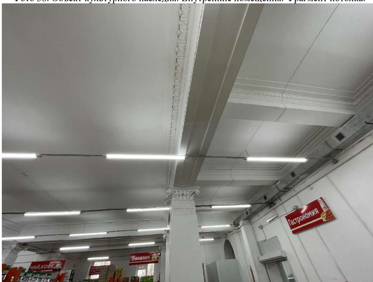
Фото 59. Объект культурного наследия. Внутренние помещения. Фрагмент потолка.
