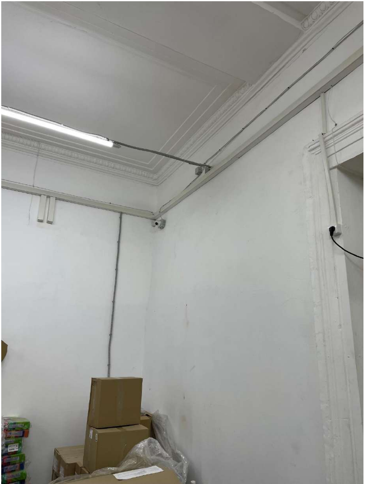
Фото 67. Объект культурного наследия. Внутренние помещения.
