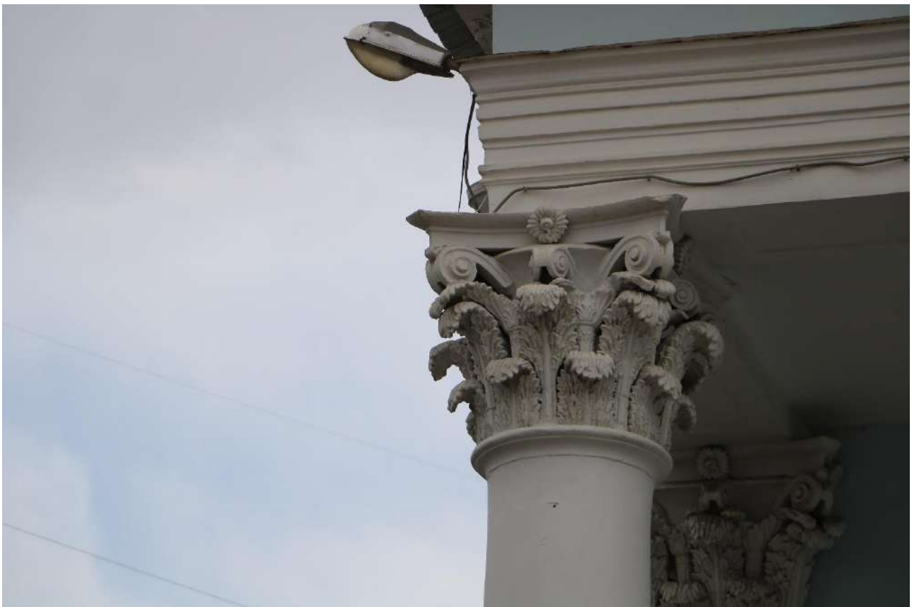
Фото 21. Объект культурного наследия. Главный вход. Фрагмент декоративного оформления колонн.
