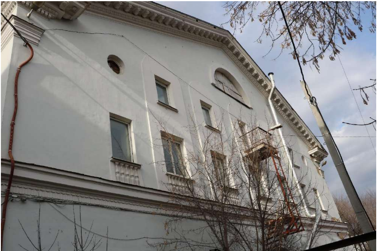
Фото 46. Объект культурного наследия. Фрагмент южного фасада.
