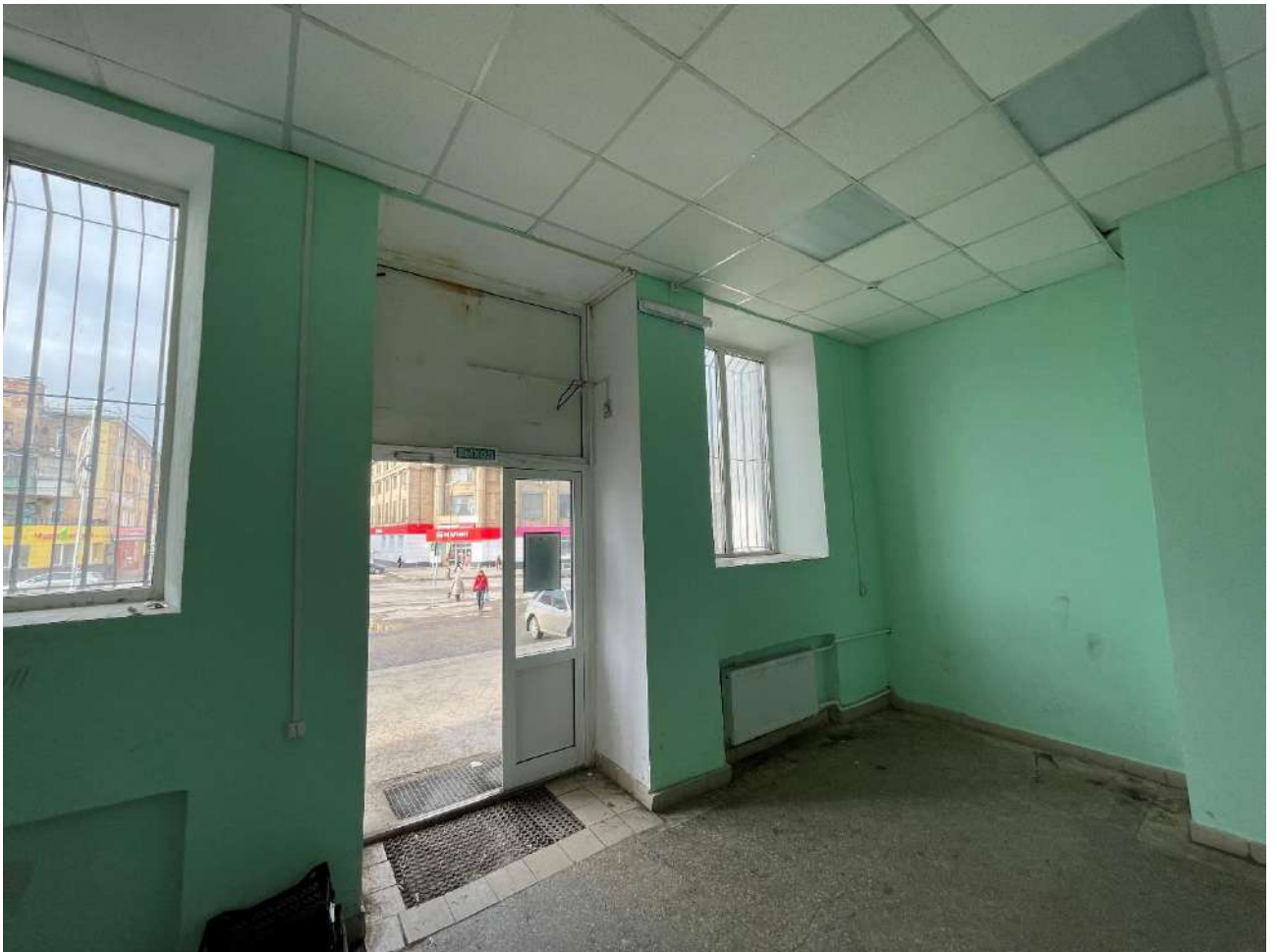
Фото 68. Объект культурного наследия. Внутренние помещения.
