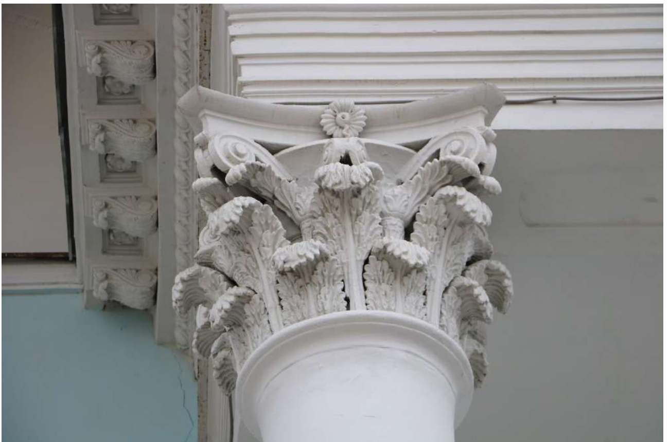
Фото 27. Объект культурного наследия. Главный вход. Фрагмент декоративного оформления колонн.
