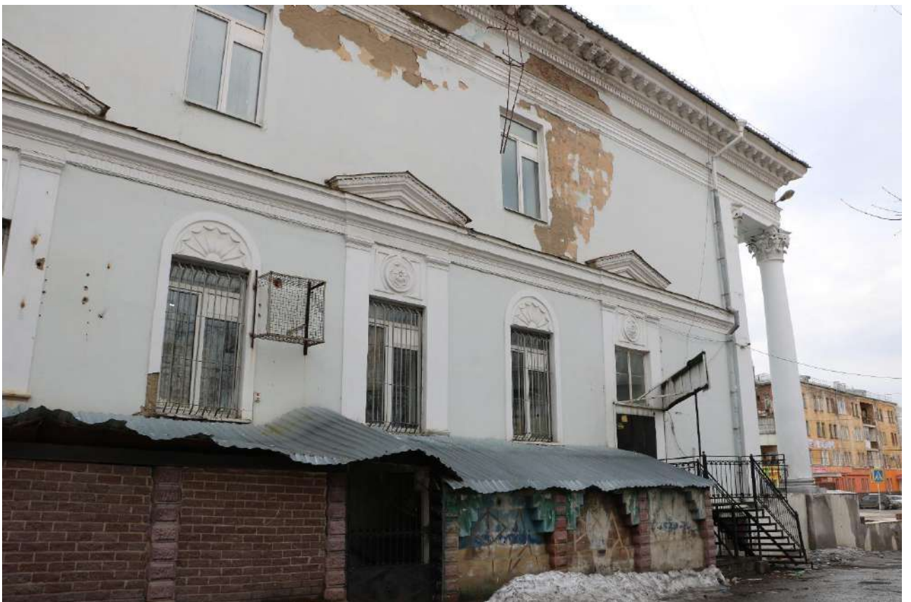
Фото 47. Объект культурного наследия. Восточный фасад.
