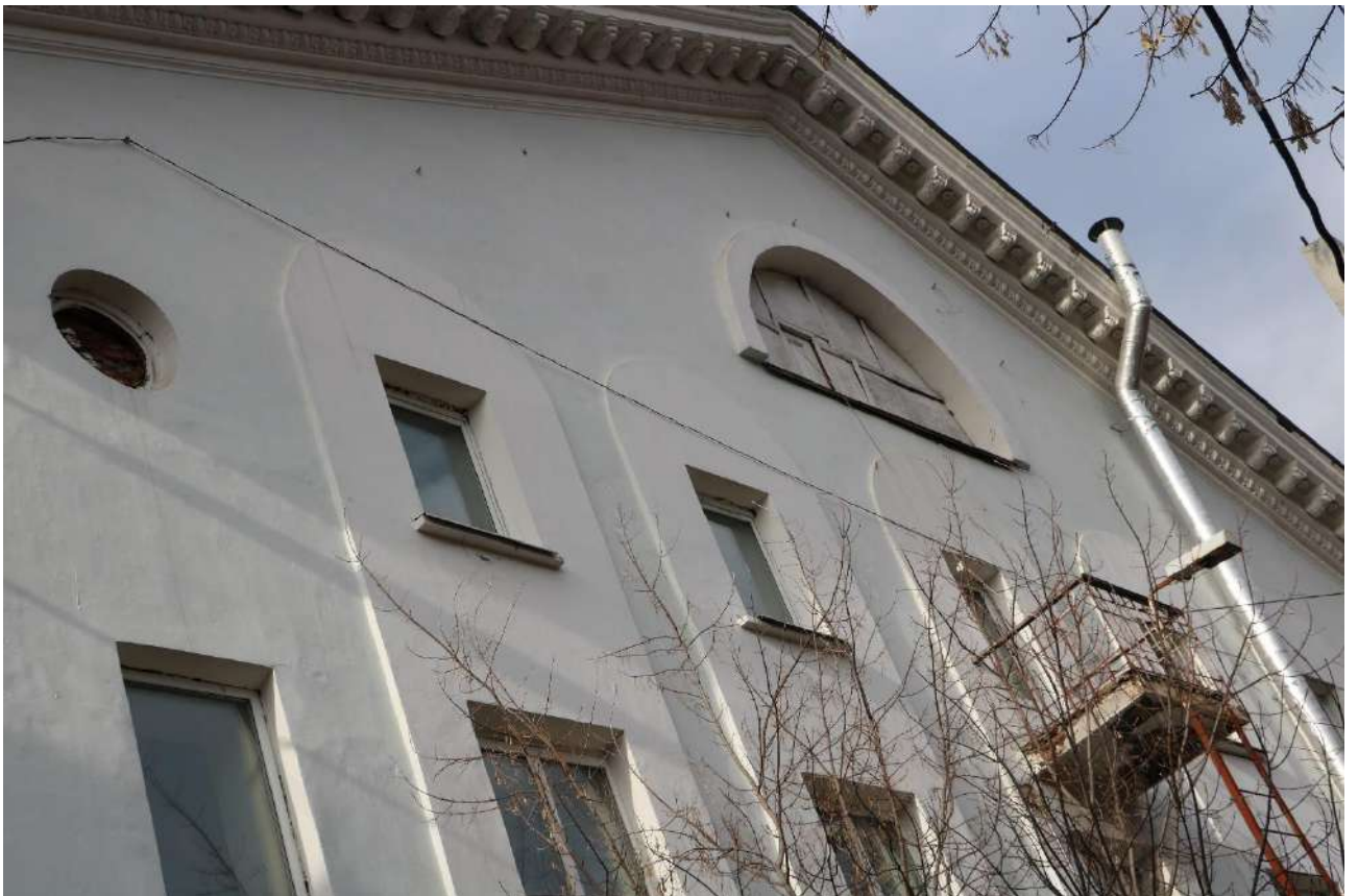
Фото 45. Объект культурного наследия. Фрагмент южного фасада.
