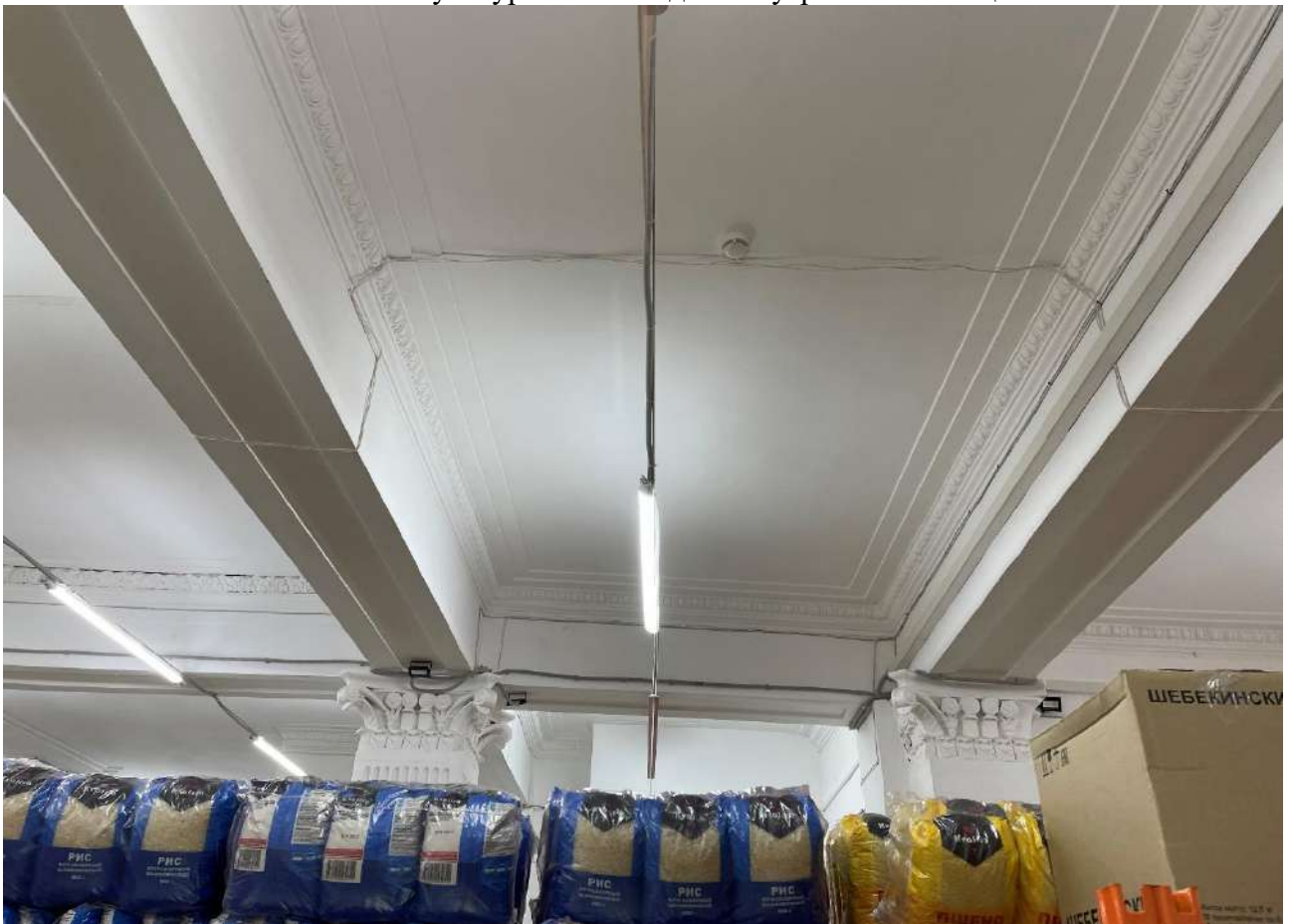
Фото 61. Объект культурного наследия. Внутренние помещения.
