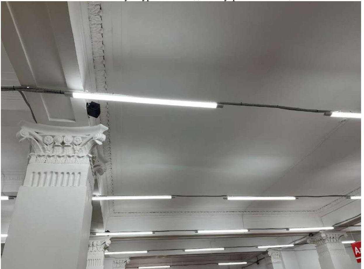
Фото 65. Объект культурного наследия. Внутренние помещения.
