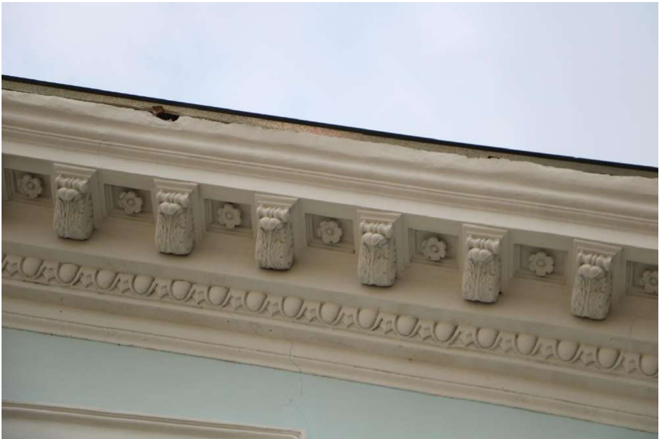
Фото 26. Объект культурного наследия. Главный вход. Фрагмент оформления фронтона.
