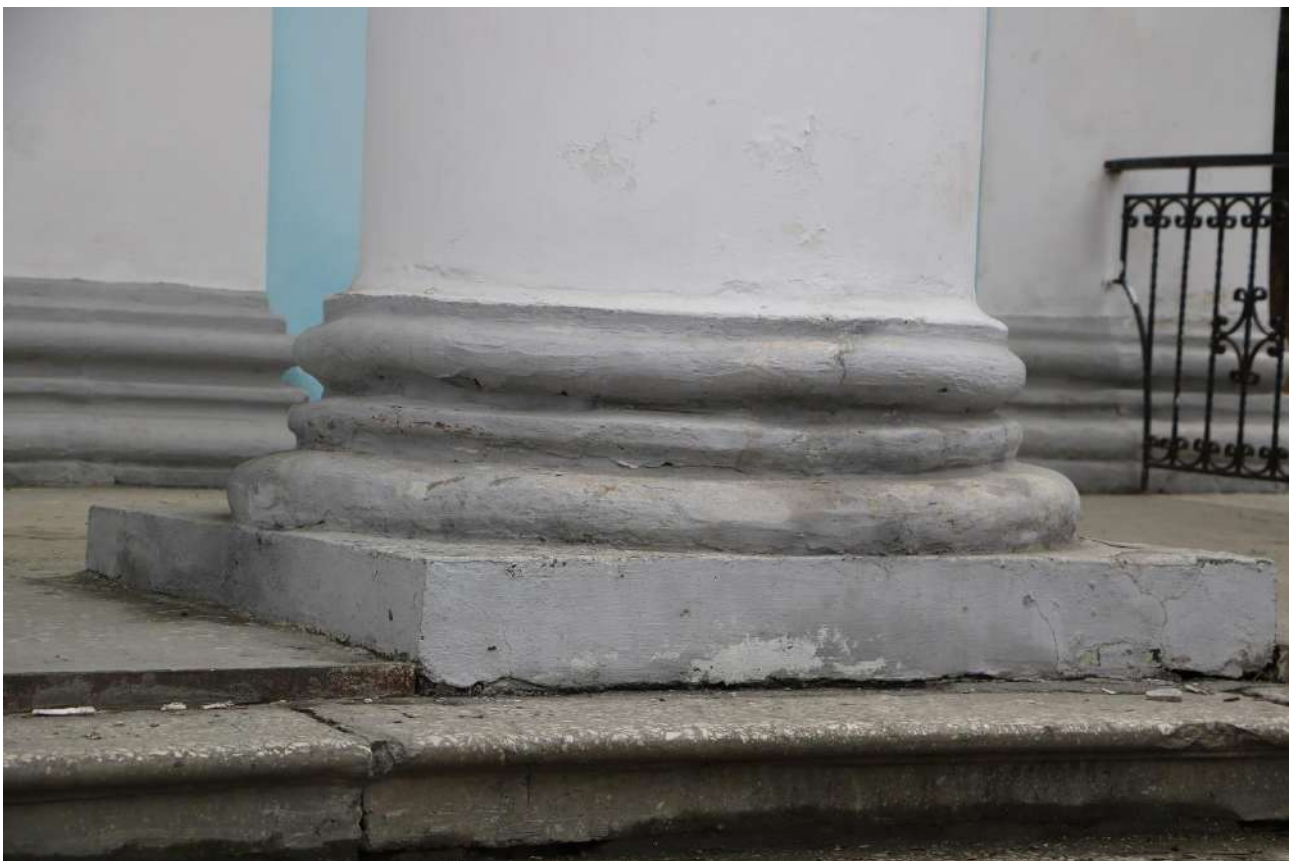
Фото 29. Объект культурного наследия. Главный вход. Основание колонны.
