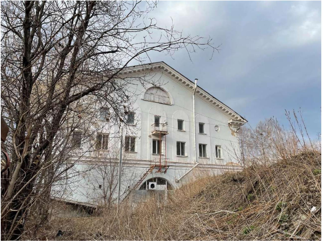
Фото 8. Объект культурного наследия. Общий вид с Ю.
