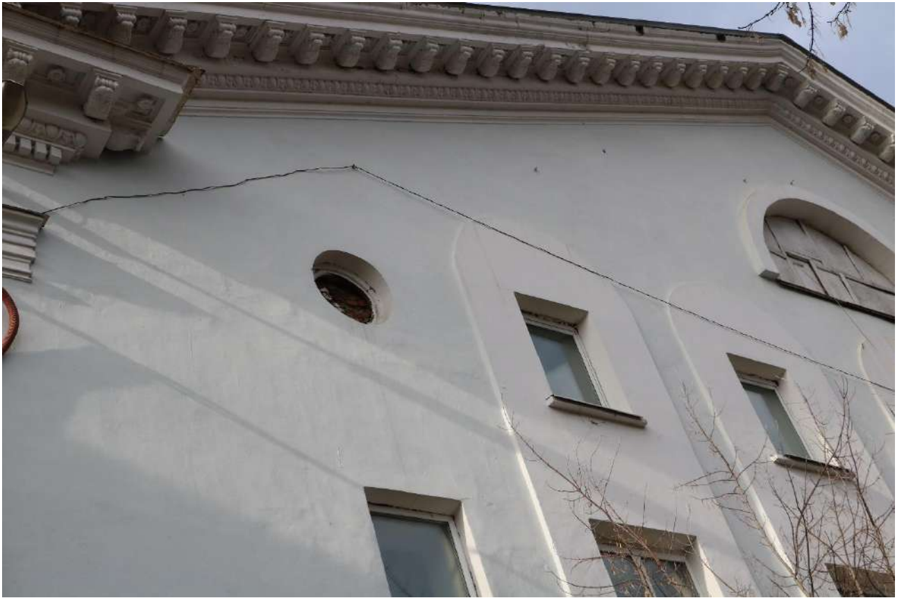
Фото 44. Объект культурного наследия. Фрагмент южного фасада.
