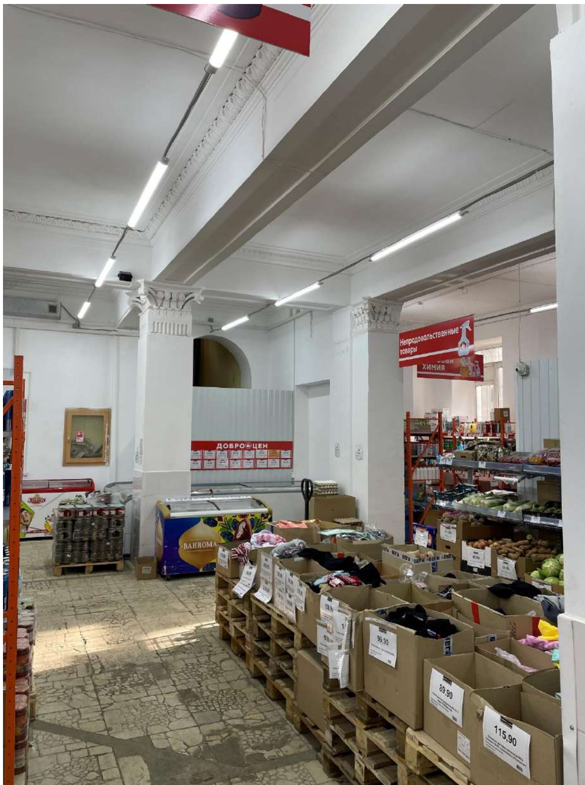
Фото 55. Объект культурного наследия. Внутренние помещения.
