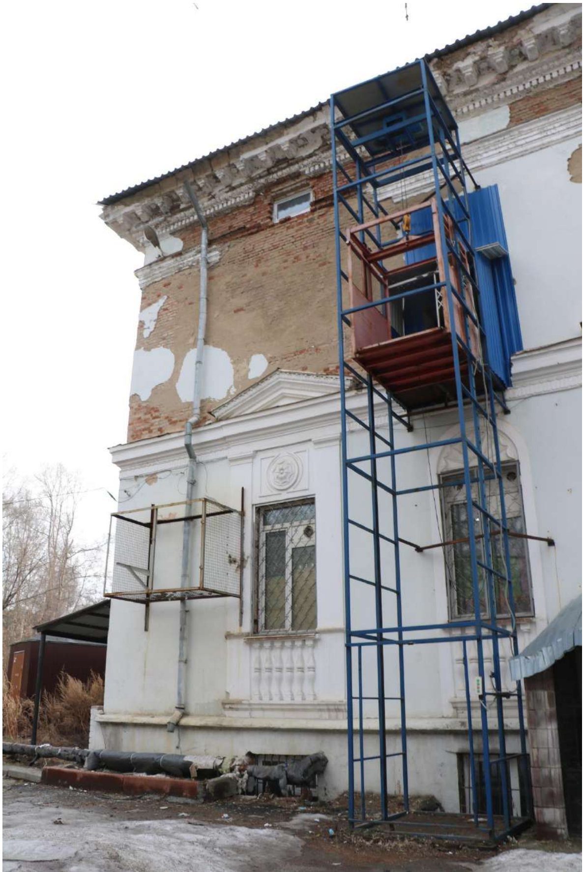
Фото 49. Объект культурного наследия. Восточный фасад.
