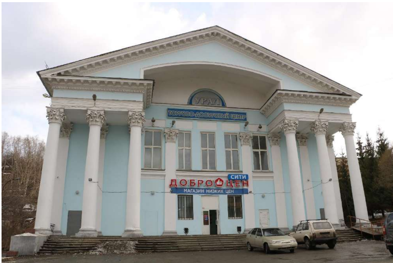
Фото 1. Объект культурного наследия. Общий вид с С.
