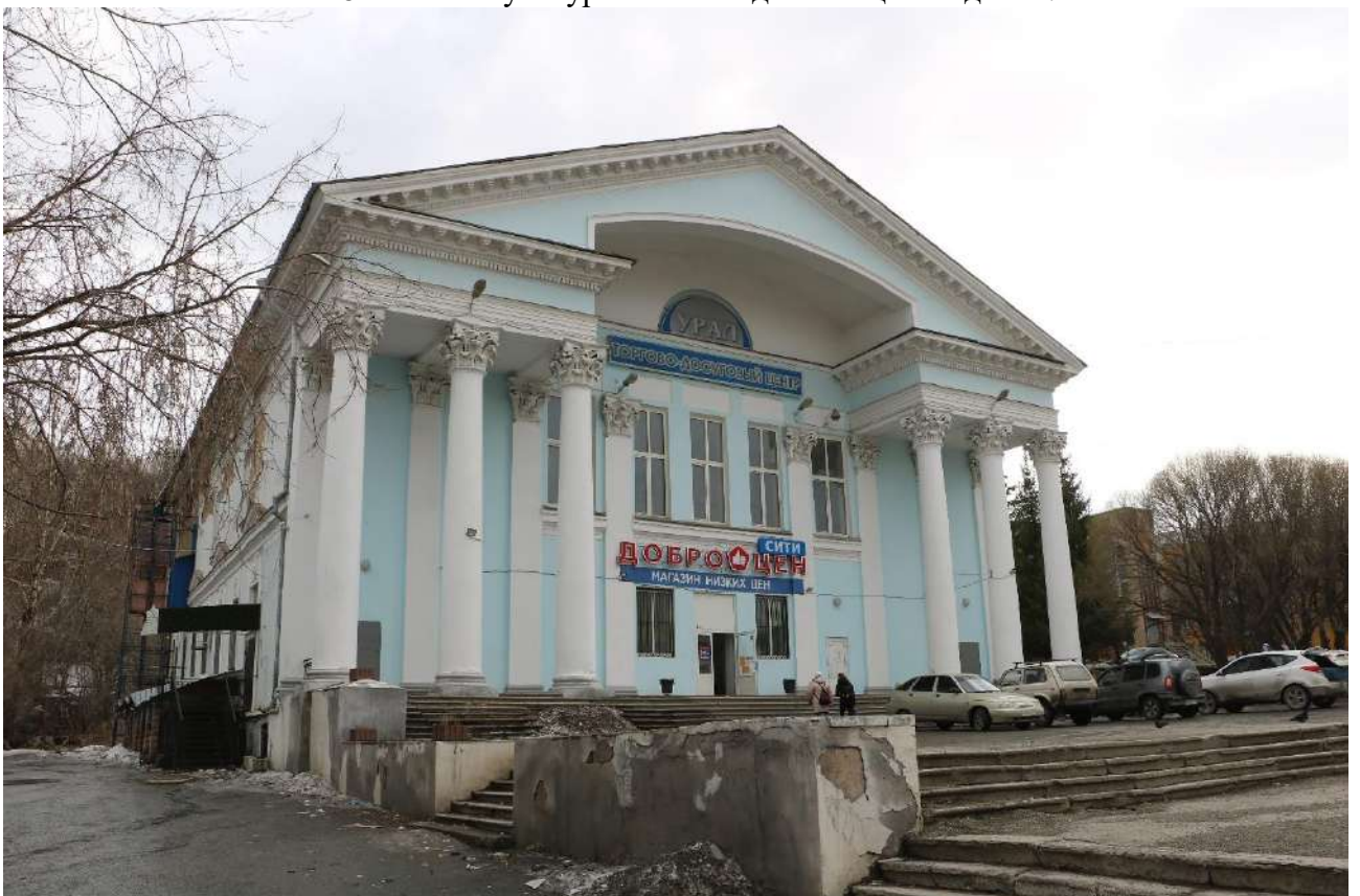
Фото 9. Объект культурного наследия. Общий вид с СЗ.
