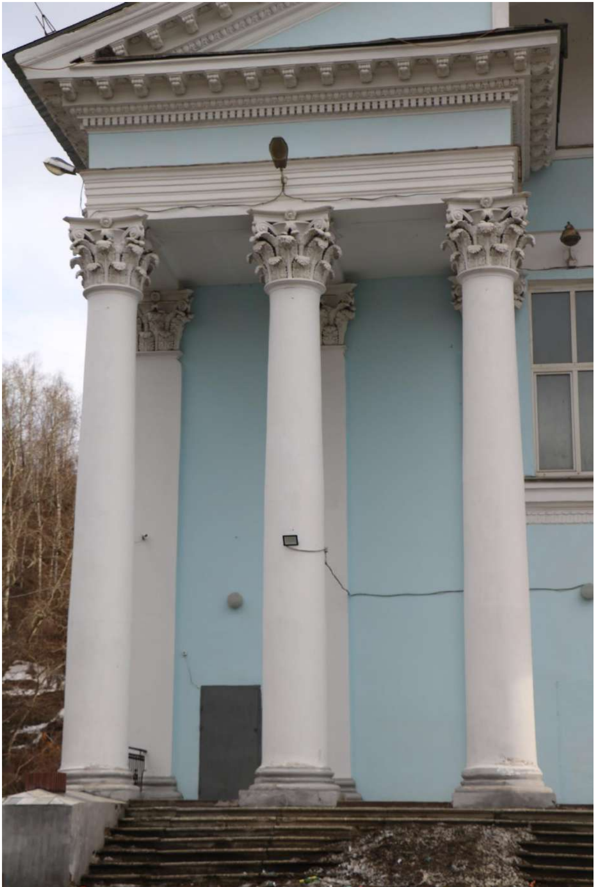
Фото 23. Объект культурного наследия. Главный вход. Колонны.
