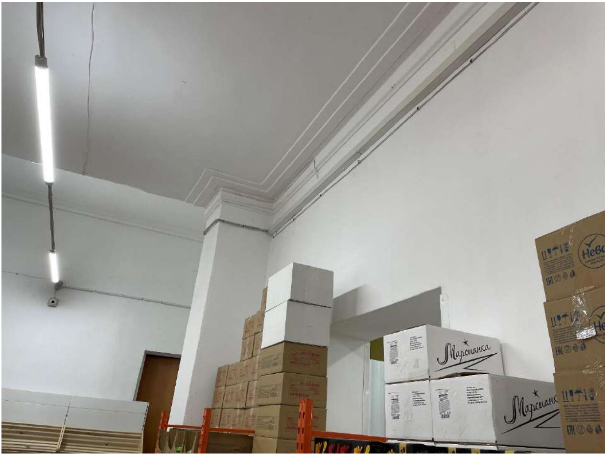
Фото 64. Объект культурного наследия. Внутренние помещения.
