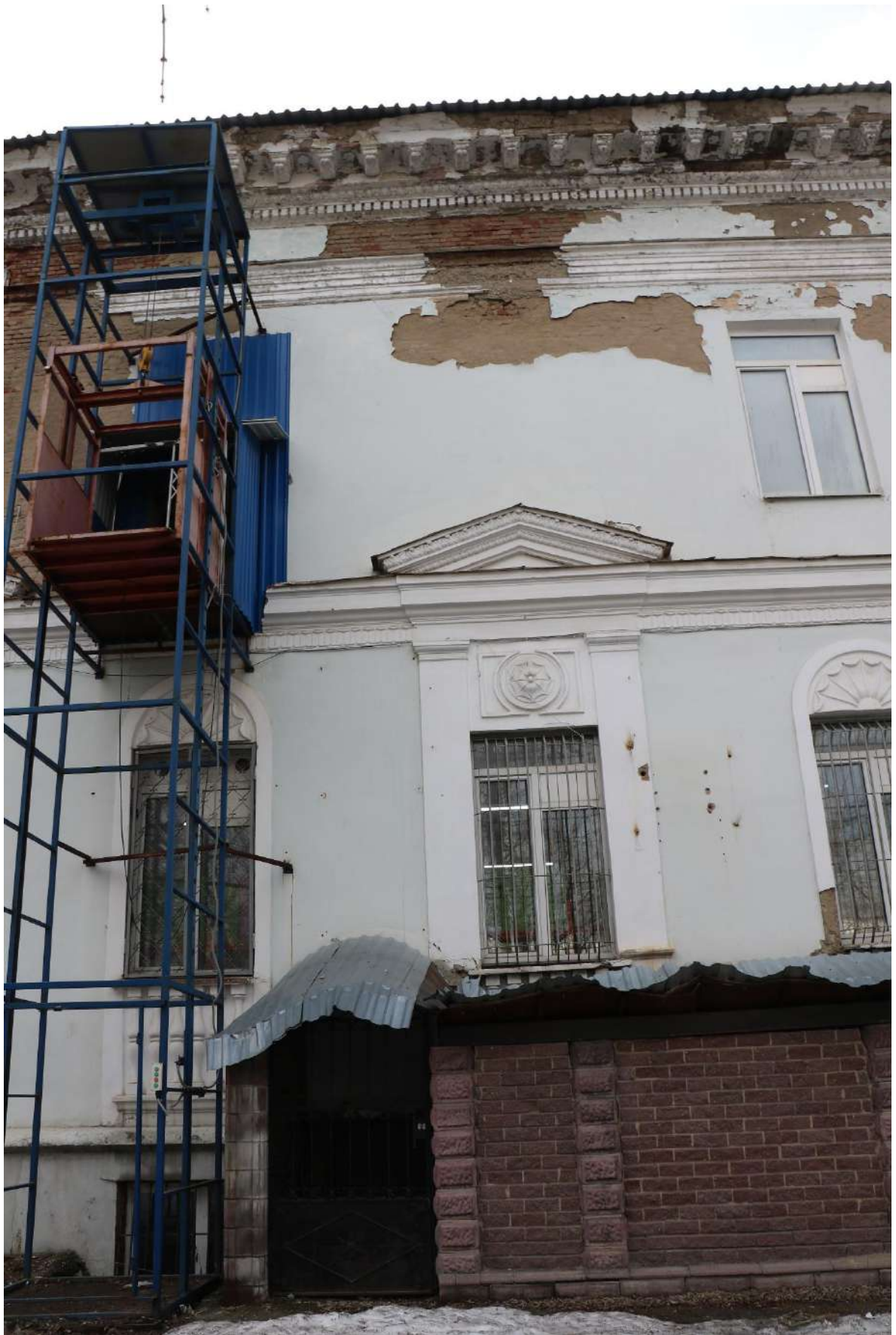
Фото 50. Объект культурного наследия. Восточный фасад.
