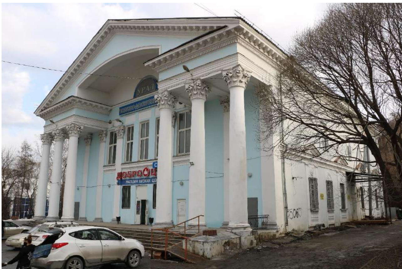
Фото 2. Объект культурного наследия. Общий вид с СЗ.
