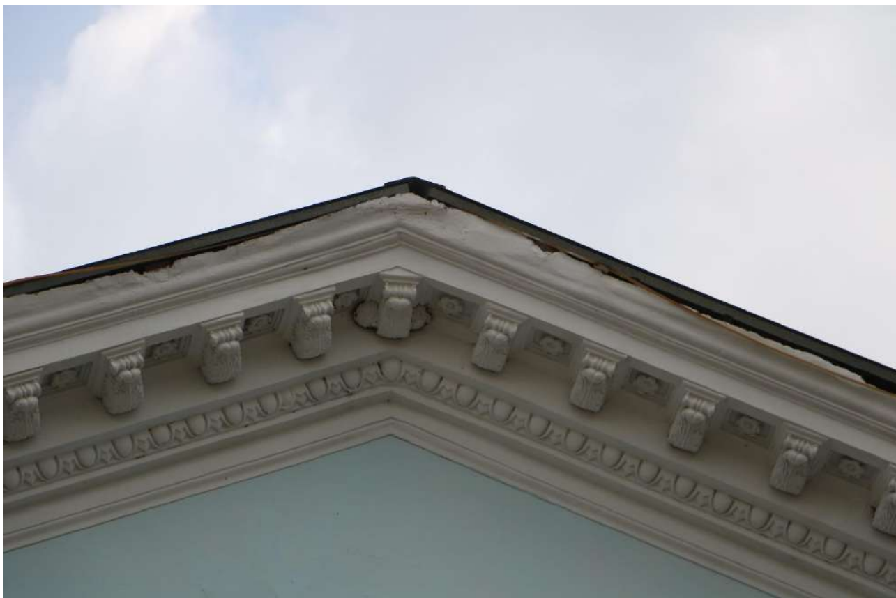
Фото 14. Объект культурного наследия. Главный вход. Фронтон.
