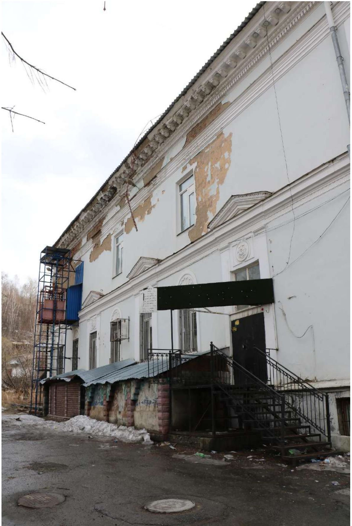
Фото 48. Объект культурного наследия. Восточный фасад.
