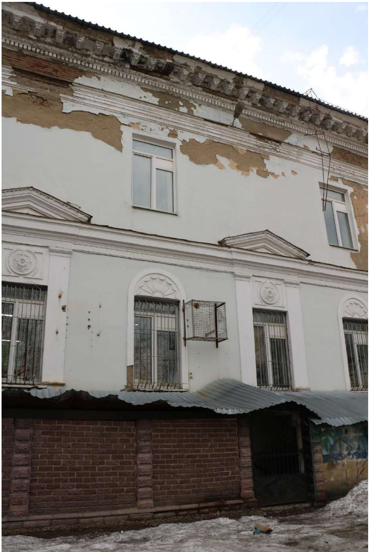
Фото 51. Объект культурного наследия. Восточный фасад.
