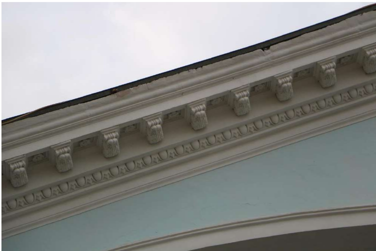
Фото 15. Объект культурного наследия. Главный вход. Фрагмент оформления фронтона.
