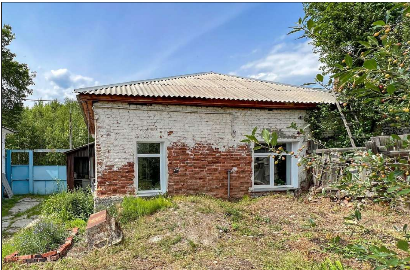
7. Общий вид на Объект.
