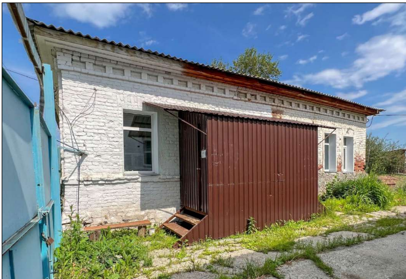
5. Общий вид на Объект.
