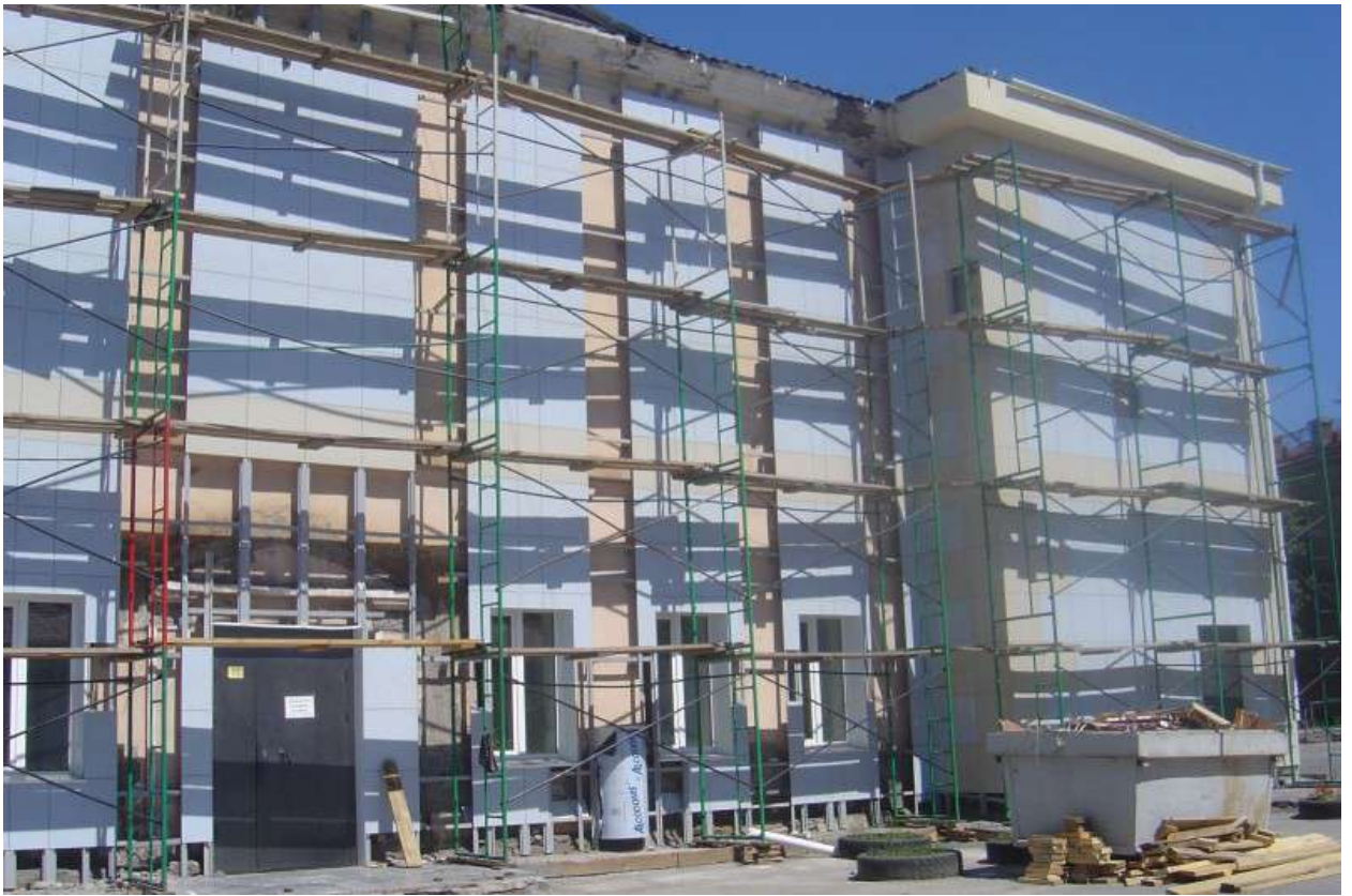
Рис. 21. Здание Саткинского краеведческого музея. Проведение ремонтных работ. Фото 2000-х гг.
