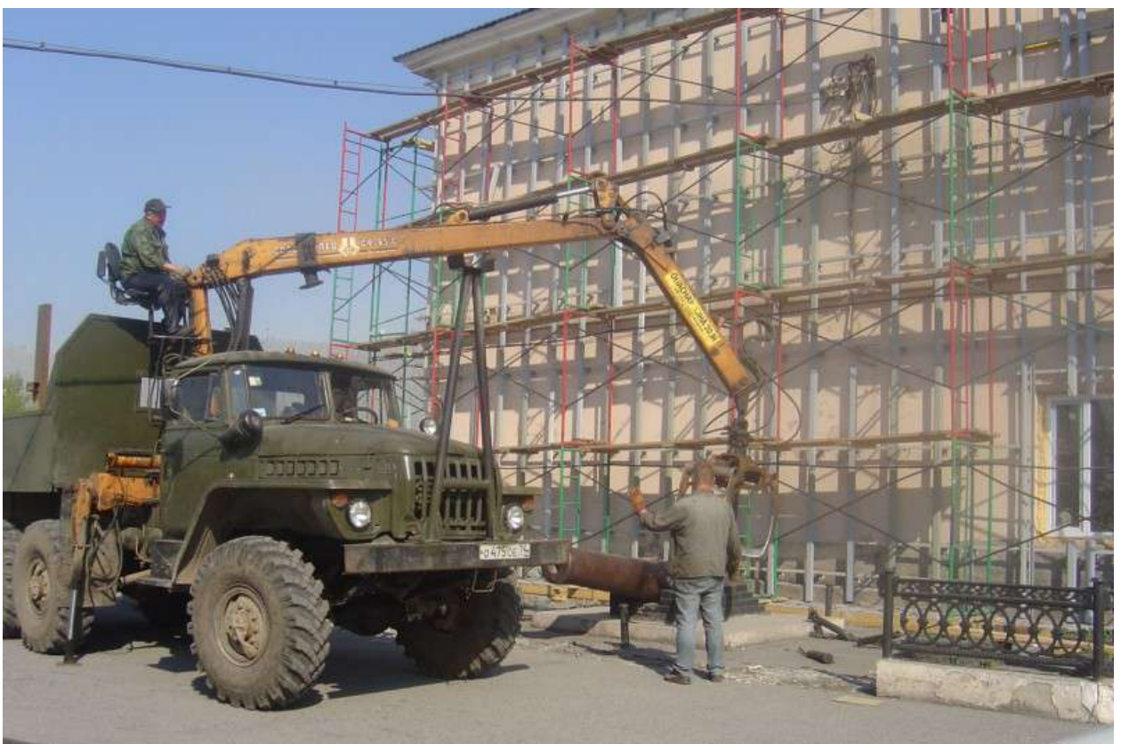
Рис. 20. Здание Саткинского краеведческого музея. Проведение ремонтных работ. Фото 2008 г.
