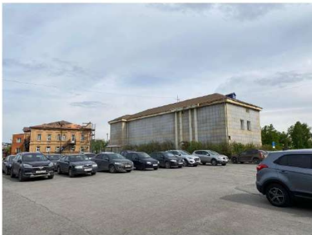
Вид с северо-запада.
