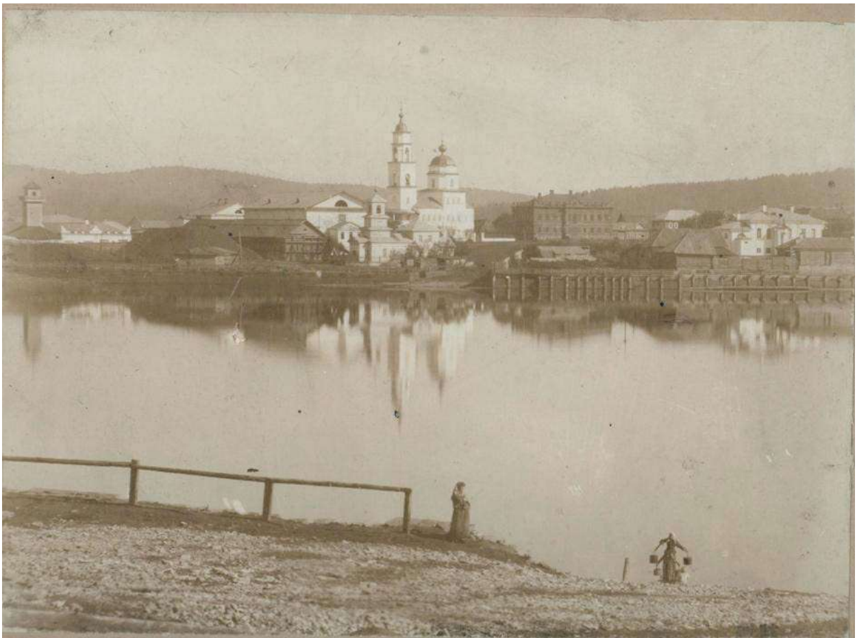
Рис. 10. Общий вид Свято-Троицкой церкви со стороны заводского пруда. Фото 1901 г.
