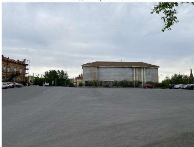
Вид с севера с ул. Толстого.
