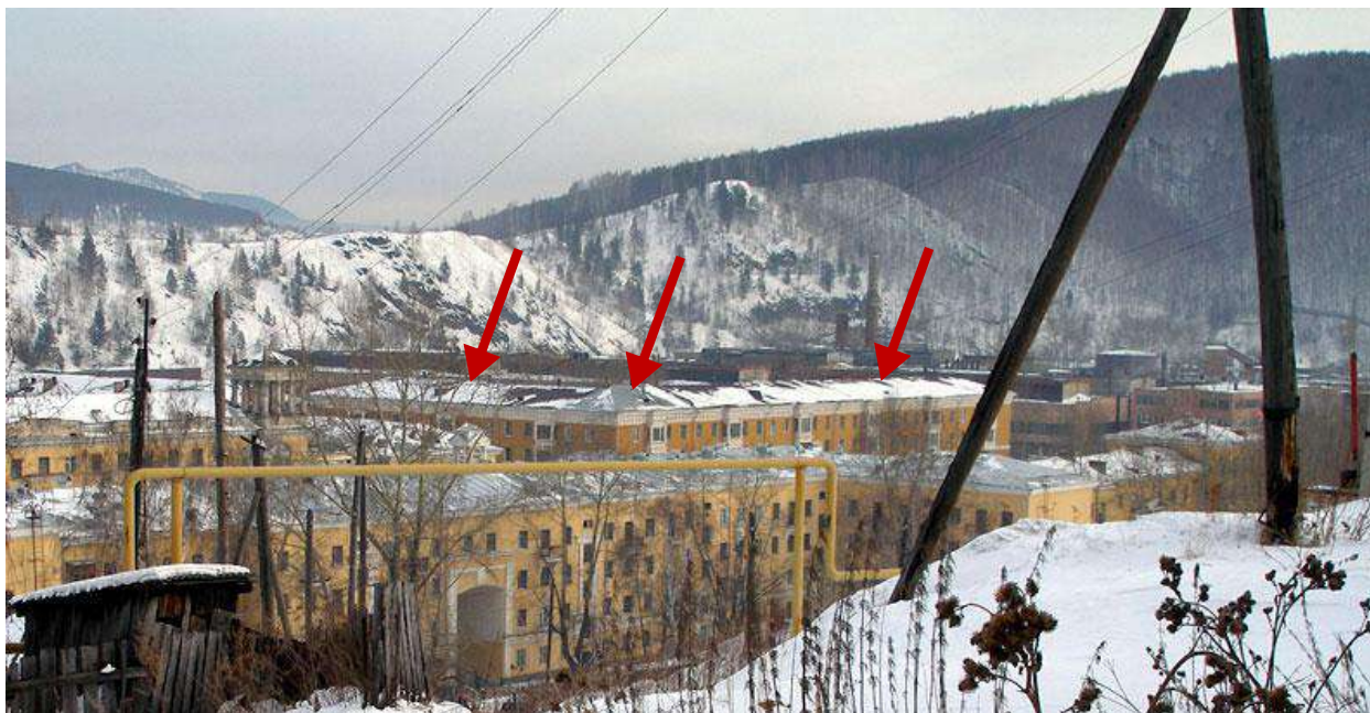
Вид Златоуста. 2007 г. Корпуса ПО «Булат» и многоквартирные дома на улице Карла Маркса, построенные в 50-е годы XX века. Рассматриваемый Объект обозначен стрелками.
