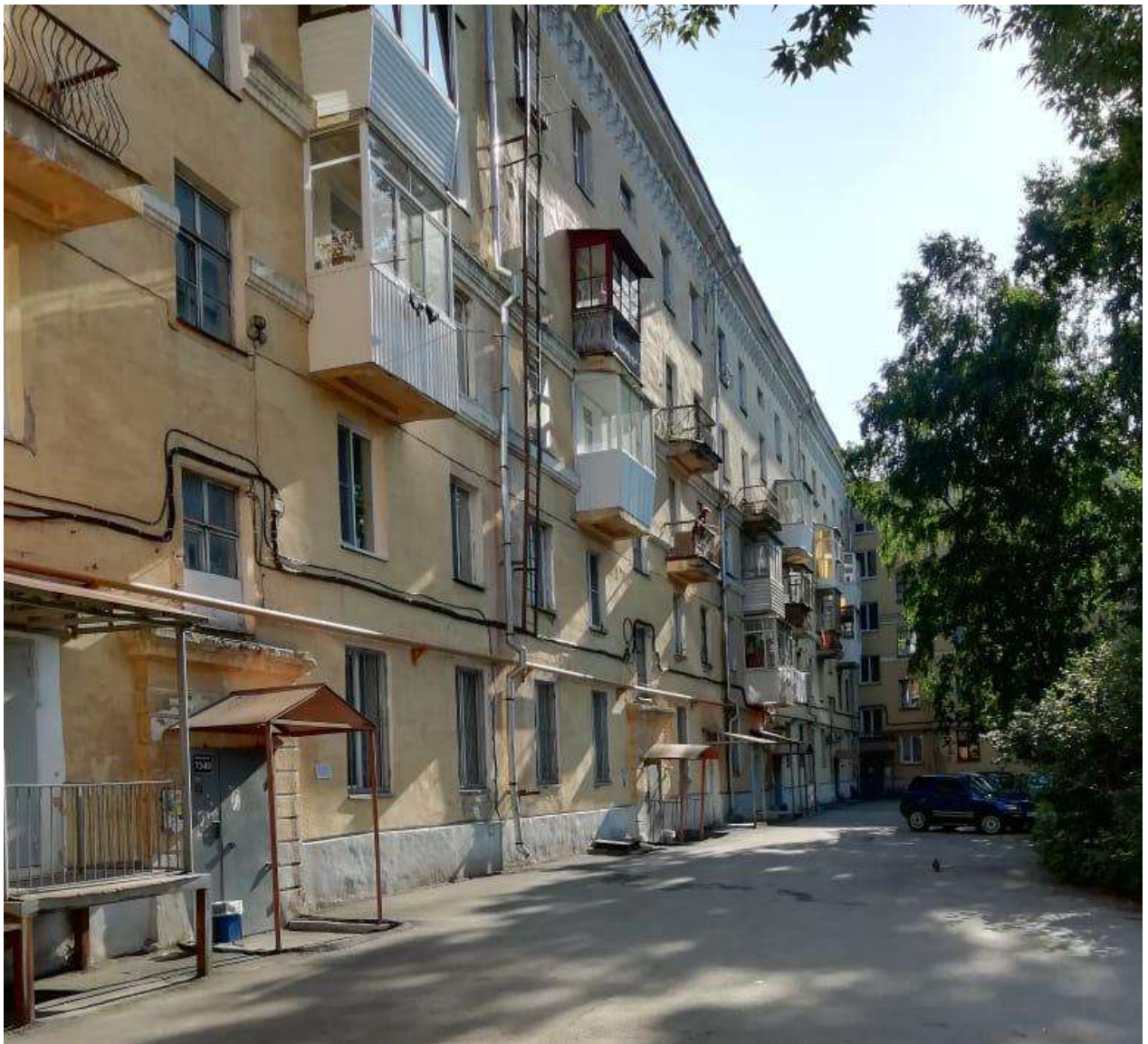
Фото 5. Северный фасад Объекта. Дворовая территория. 09.07.2020г.
