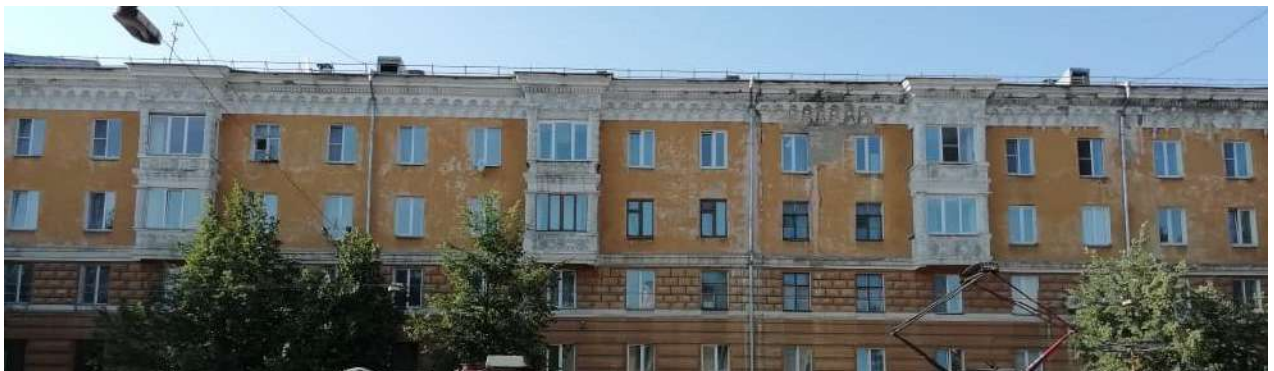
Фото 6. Фрагмент южного (главного) фасада Объекта, выходящий на ул. К. Маркса. 09.07.2020г.
