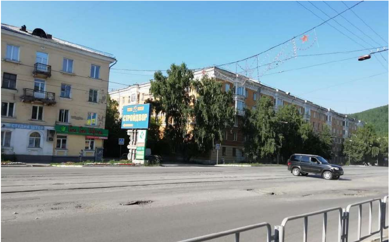
Фото 1. Общий вид Объекта со стороны ул. К. Маркса, недалеко от пересечения с ул. Ковшова. 09.07.2020г.
