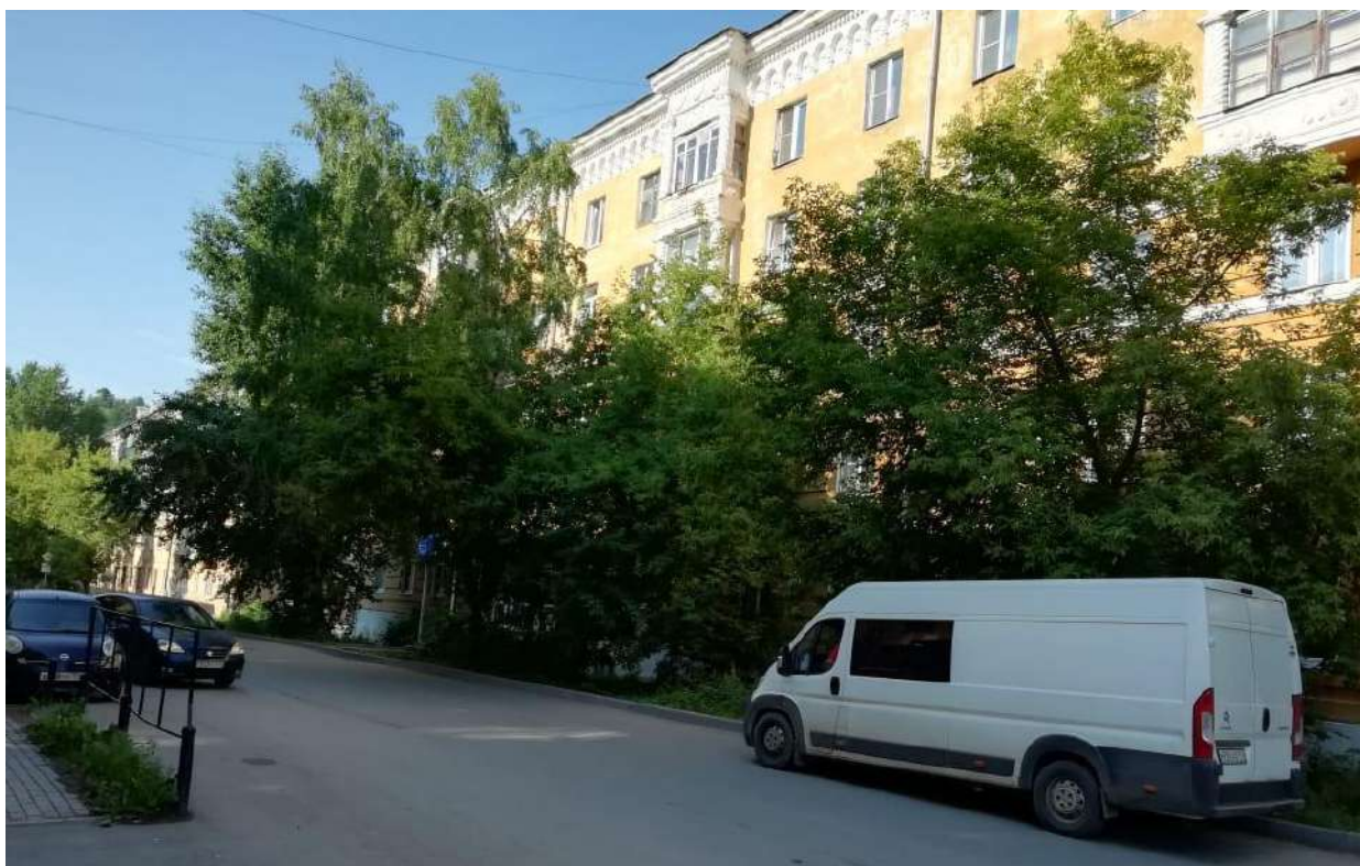
Фото 4. Западный фасад Объекта, выходящий на ул. Ковшова. 09.07.2020г.
