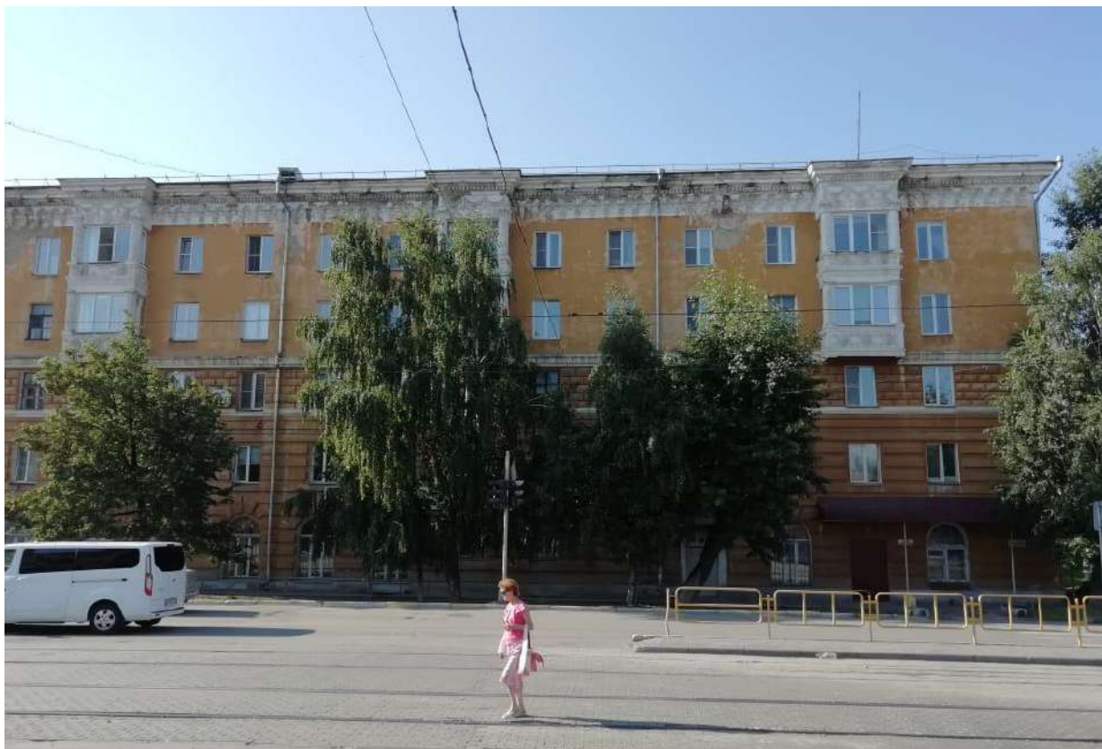
Фото 3. Фрагмент главного фасада, выходящего на ул. К. Маркса. 09.07.2020г.
