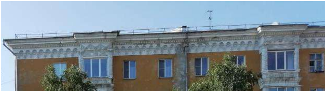
Фото 9. Фрагмент южного фасада Объекта, выходящий на ул. К.Маркса. 09.07.2020г.
