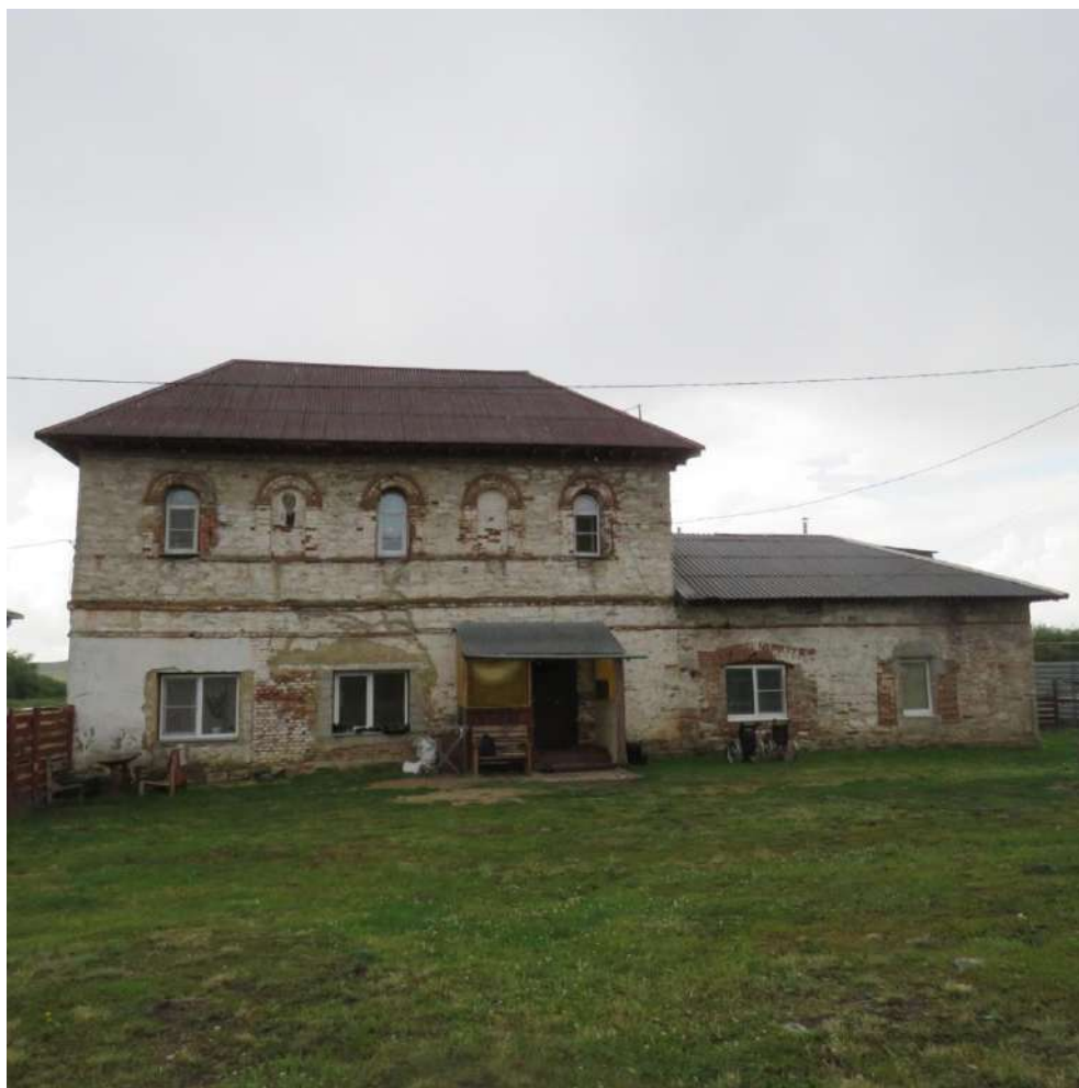
Рис. 3. Одно- двухэтажное административно-складское здание: двухэтажный дом с примыкающим с запада одноэтажным объемом. Главный, северный фасад
