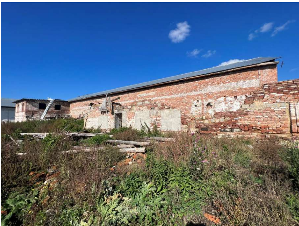
Рис. 32. Двухэтажный (в настоящее время – двухсветный) производственный корпус. Южный фасад. Вид с юго-востока
