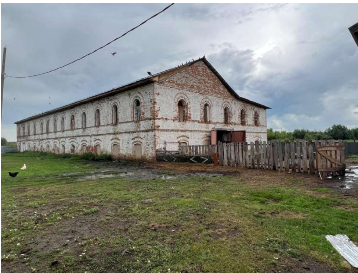
Рис. 29 а, б. Двухэтажный (в настоящее время – двухсветный) производственный корпус. Вид с северо-запада
