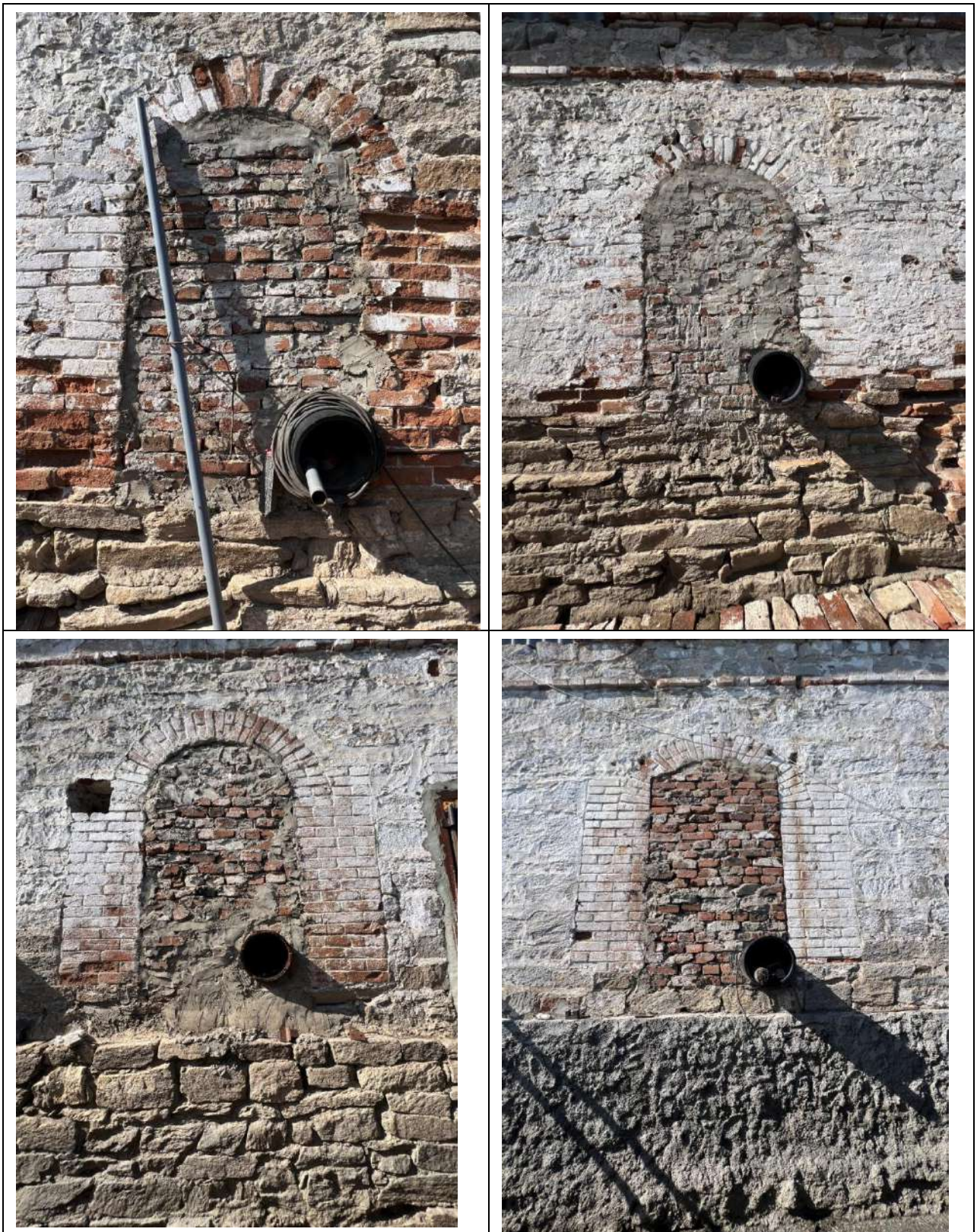
Рис. 11. Оконные проемы восточного фасада складского здания
