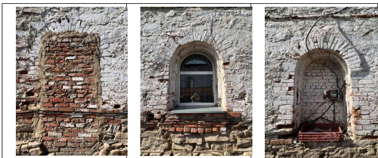
Рис. 5. Двухэтажный дом. Оконные проемы восточного фасада
