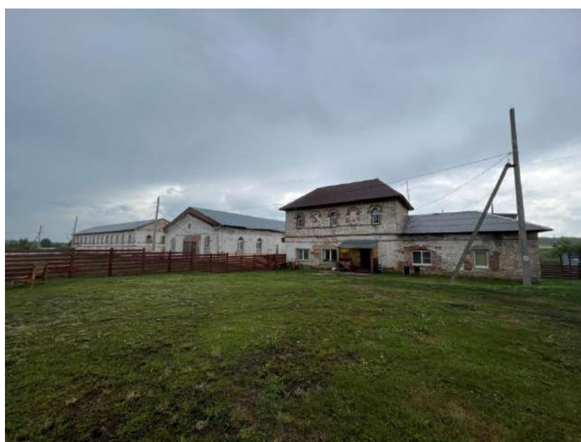
Рис. 1 а, б, в. Общий вид комплекса зданий с севера, со стороны ул. Ленина
