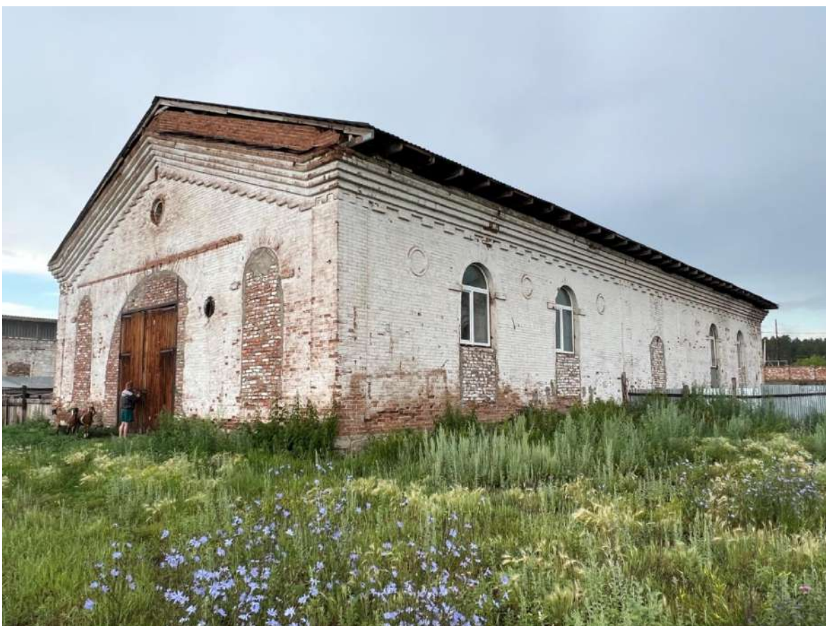
Рис. 22. Одноэтажное производственное здание. Боковой, восточный фасад
