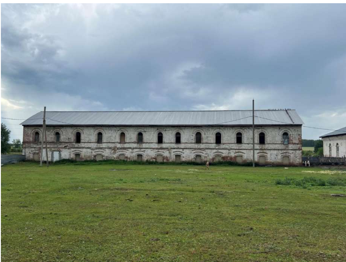
Рис. 30 а, б. Двухэтажный (в настоящее время – двухсветный) производственный корпус. Западный (вверху) и северный (внизу) фасады
