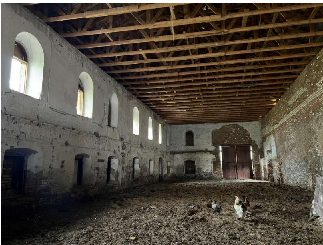
Рис. 36 а, б. Двухэтажный (в настоящее время – двухсветный) производственный корпус. Интерьер основного корпуса. Западная (вверху) и восточная (внизу) торцевые стены
