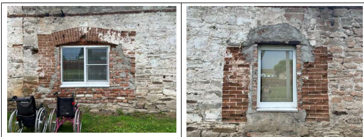
Рис. 7. Оконные проемы северного фасада примыкающего одноэтажного объема (левый проем исторически являлся дверным)
