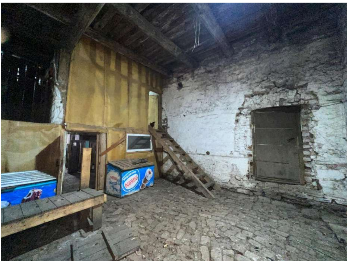
Рис. 17 а, б. Фрагмент интерьеров одноэтажного складского здания. Помещение № 2 технического плана
