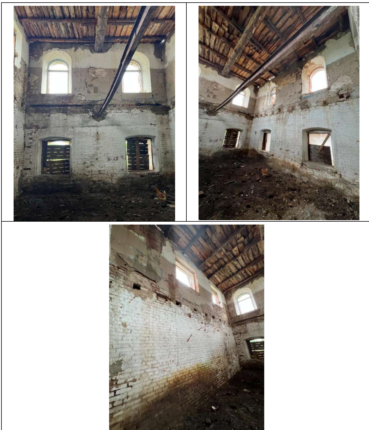
Рис. 38 а, б, в. Двухэтажный (в настоящее время – двухсветный) производственный корпус. Интерьер бокового объема
