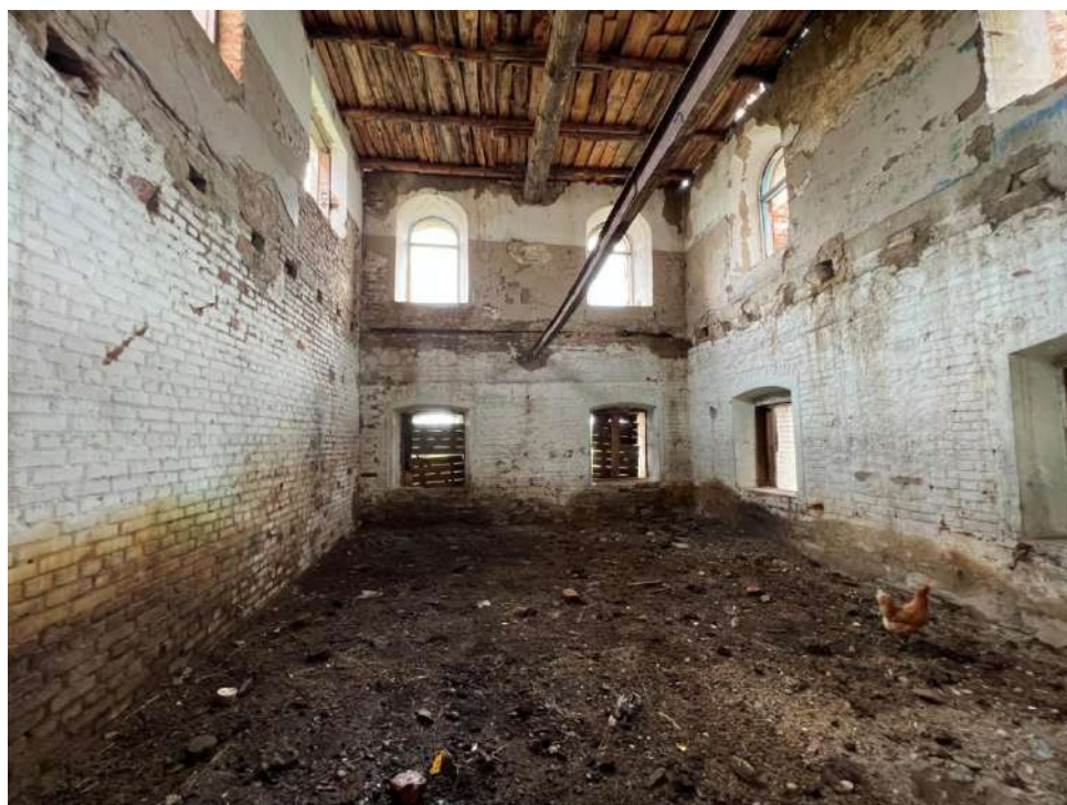
Рис. 37 а, б. Двухэтажный (в настоящее время – двухсветный) производственный корпус. Внутренняя стена и интерьер бокового объема
