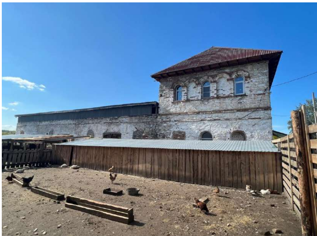
Рис. 10. Одно- двухэтажное административно-складское здание: двухэтажный дом с примыкающим с юга прямоугольным в плане объемом складов. Восточный фасад
