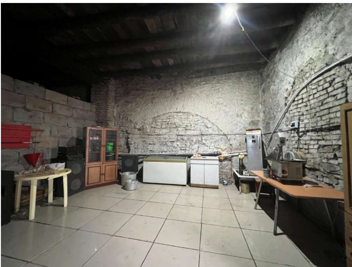
Рис. 16 а, б. Фрагмент интерьеров одноэтажного складского здания. Помещение № 3 технического плана
