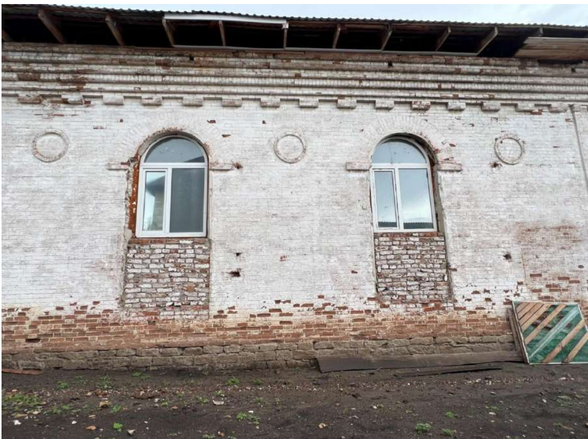
Рис. 21. Одноэтажное производственное здание. Фрагмент бокового, западного фасада
