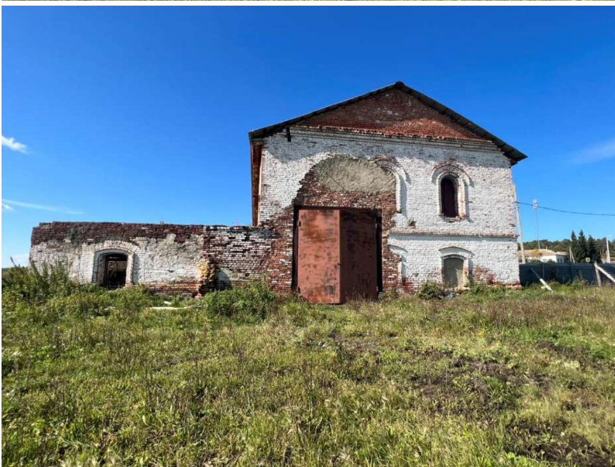
Рис. 34 а, б. Двухэтажный (в настоящее время – двухсветный) производственный корпус. Восточный фасад с примыкающим руинированным историческим объемом
