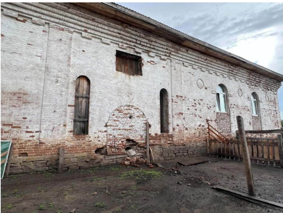
Рис. 20 а, б. Одноэтажное производственное здание. Боковой, западный фасад
