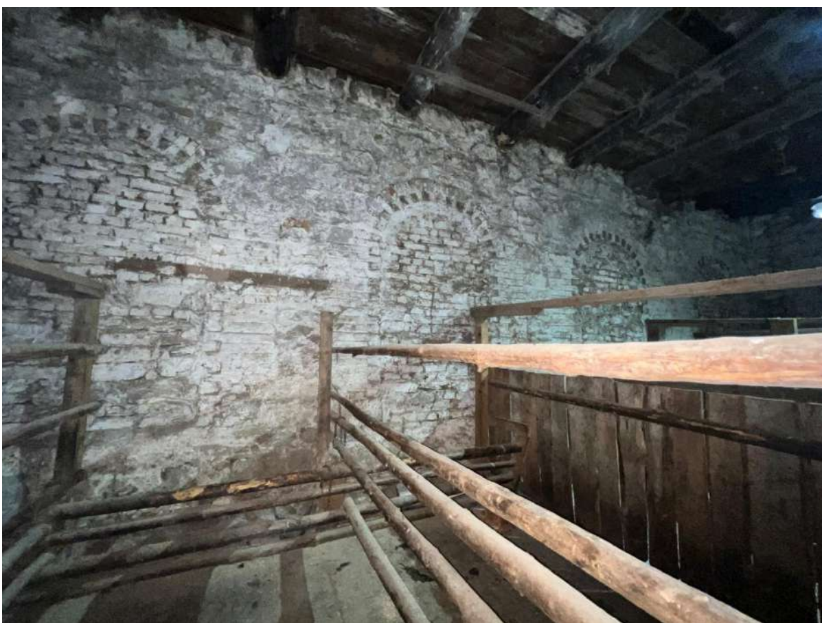
Рис. 18 а, б. Фрагмент интерьеров одноэтажного складского здания. Помещение № 1 технического плана
