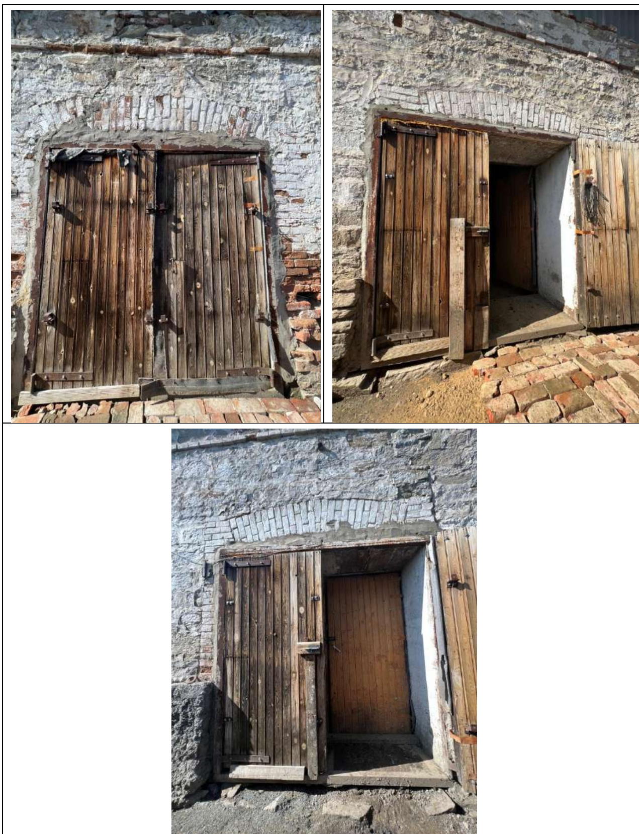
Рис. 12. Дверные проемы восточного фасада складского здания
