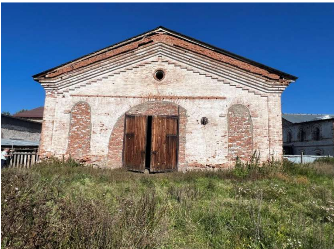
Рис. 23. Одноэтажное производственное здание. Дворовый, южный фасад
