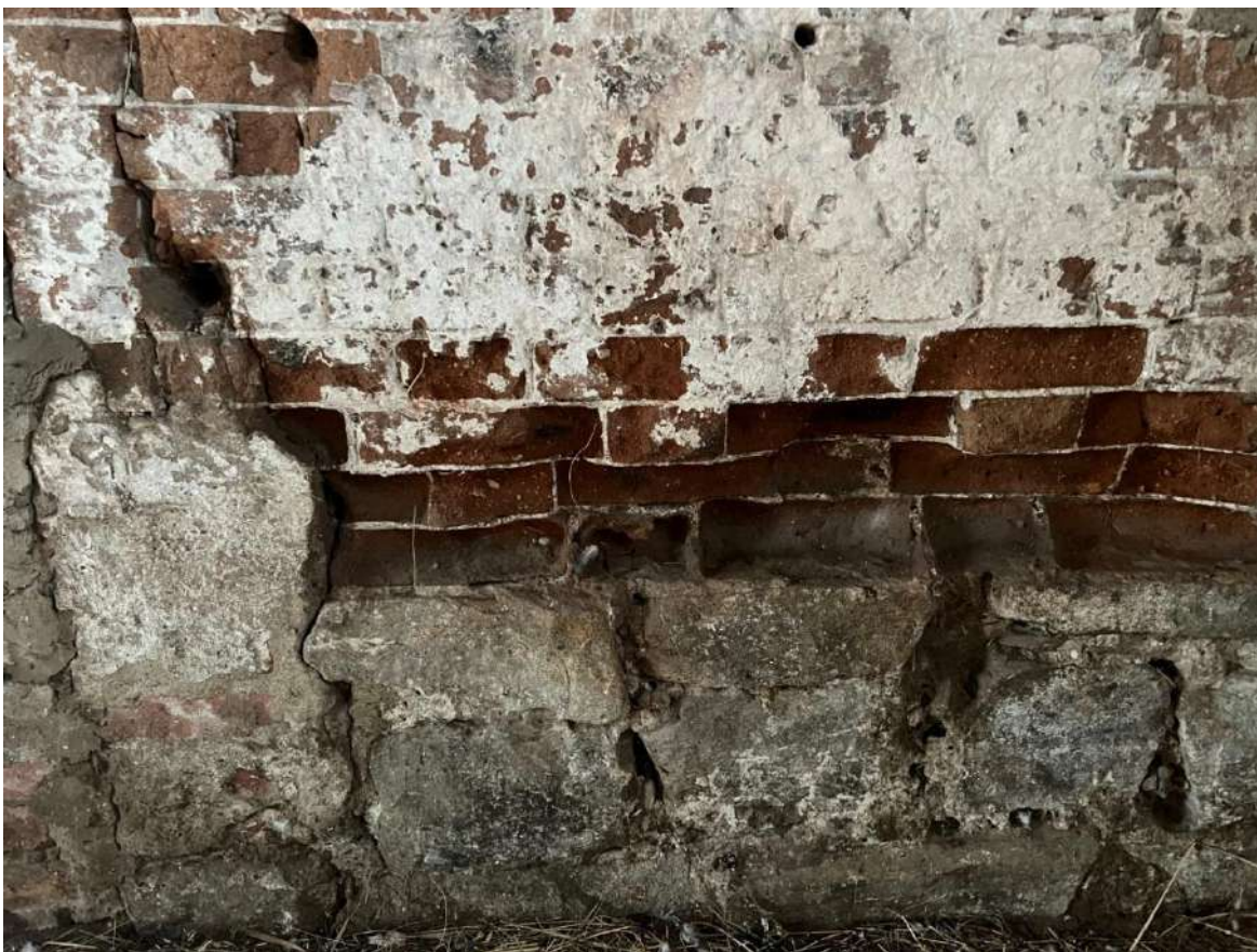
Рис. 28. Одноэтажное производственное здание. Бутовая кладка цоколя и кирпичная кладка стены
