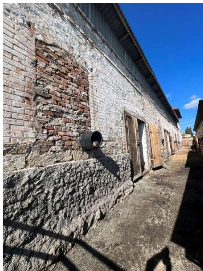
Рис. 11. Объем складского здания. Восточный фасад
