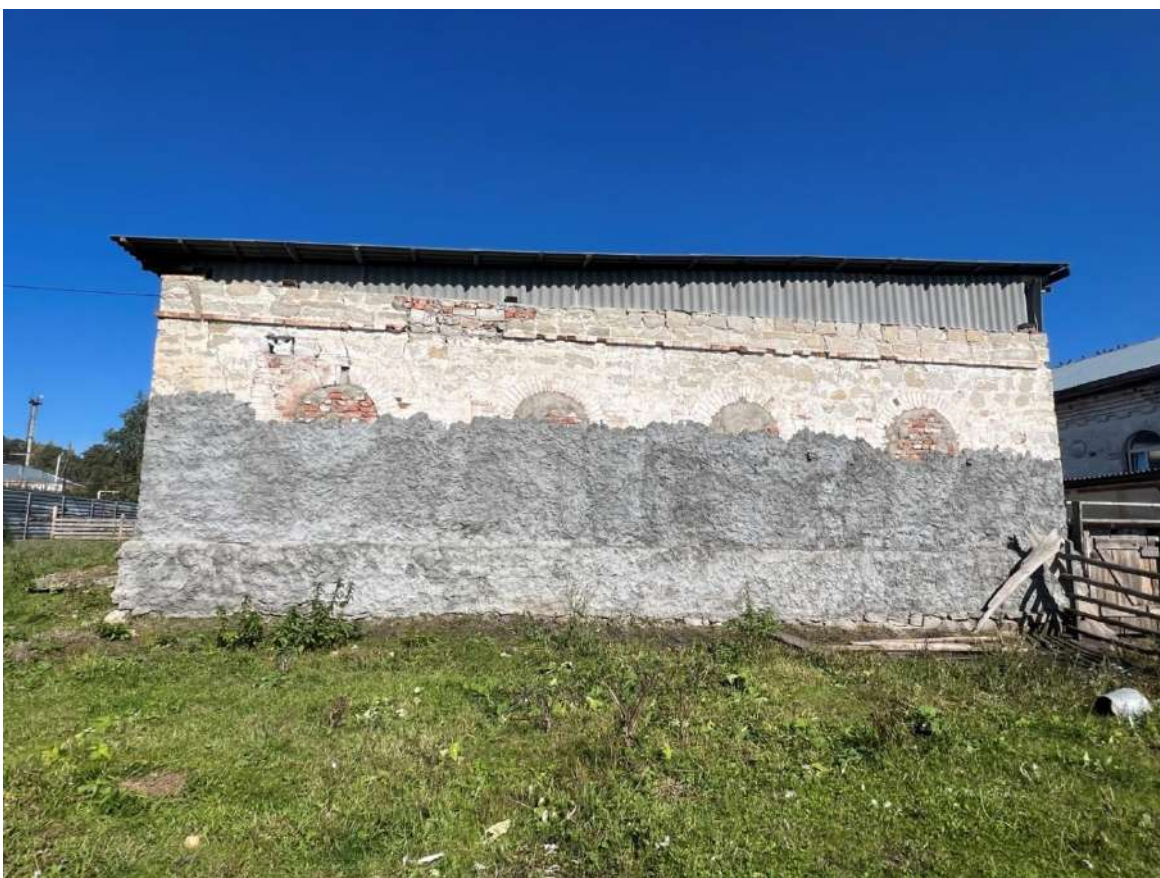
Рис. 14. Объем складского здания. Дворовый, южный фасад
