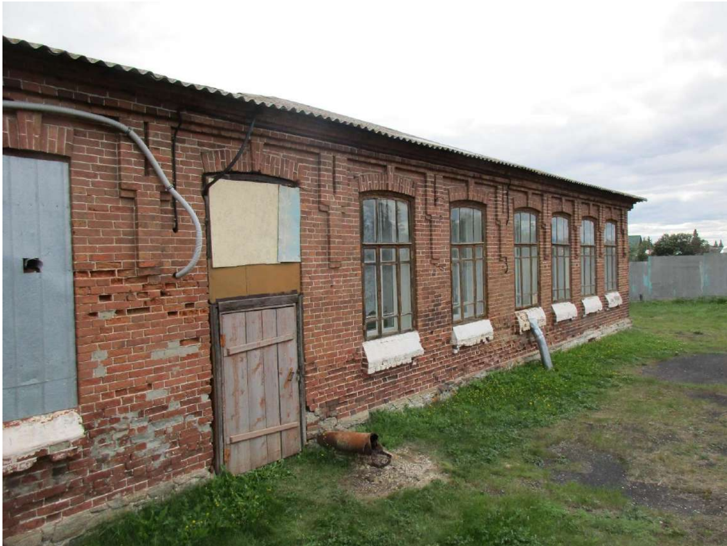
4. Западный фасад. Август 2023 г.
