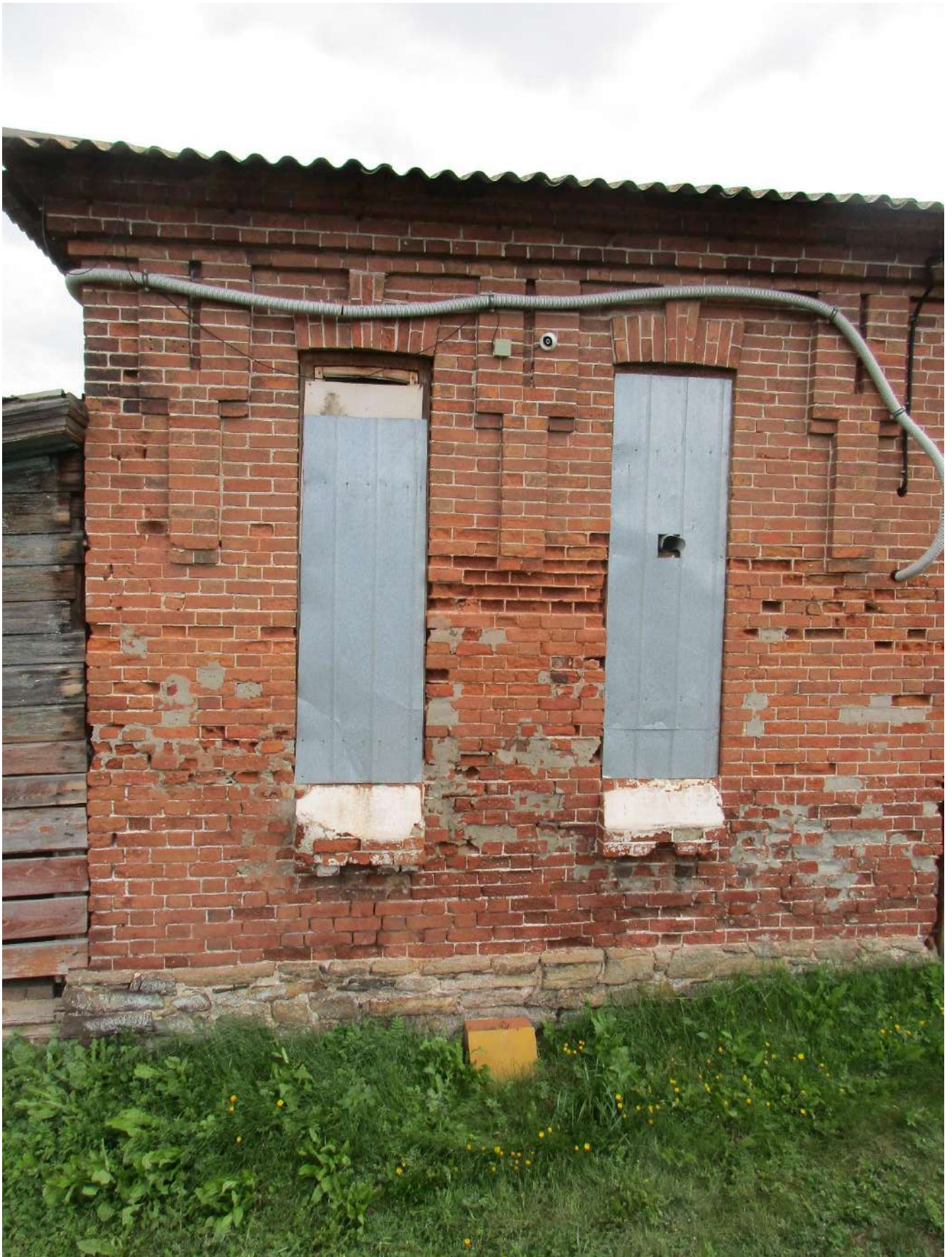
16. Левая часть западного фасада. Оконные проемы клозета. Август, 2023 г.
