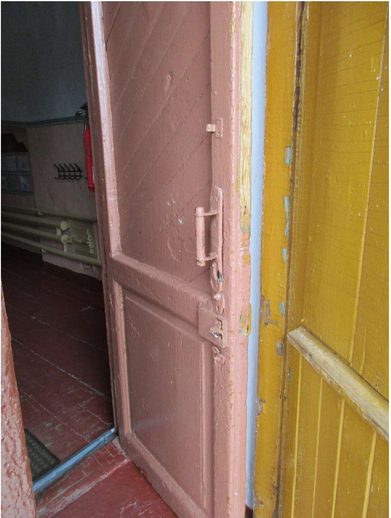
18. Интерьер. Дверной проем. Заполнение в виде створы с сохранившейся нижней филенчатой частью. Август 2023 г
