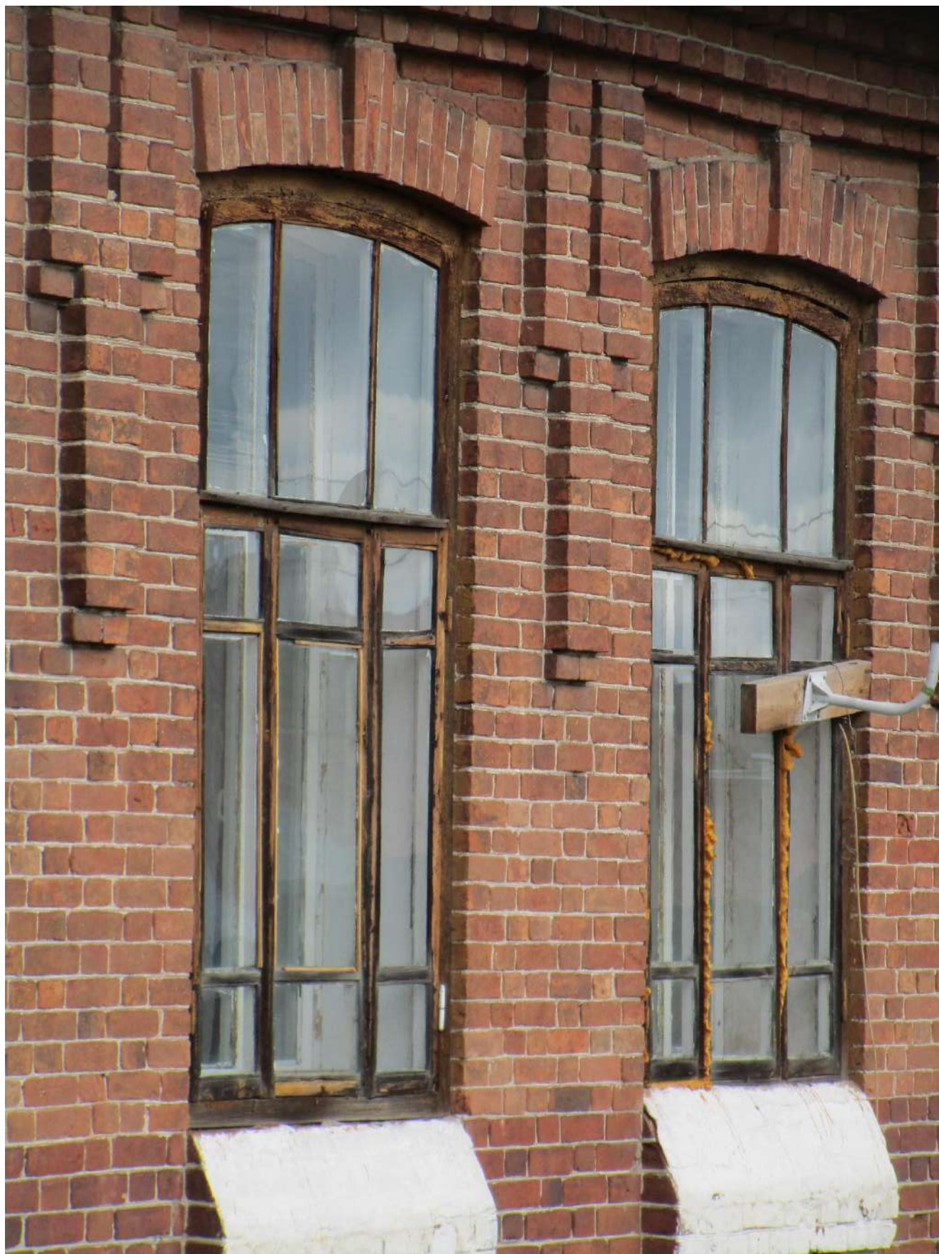
13. Фрагмент фасада. Оконные заполнения в две нити. Август 2023 г.
