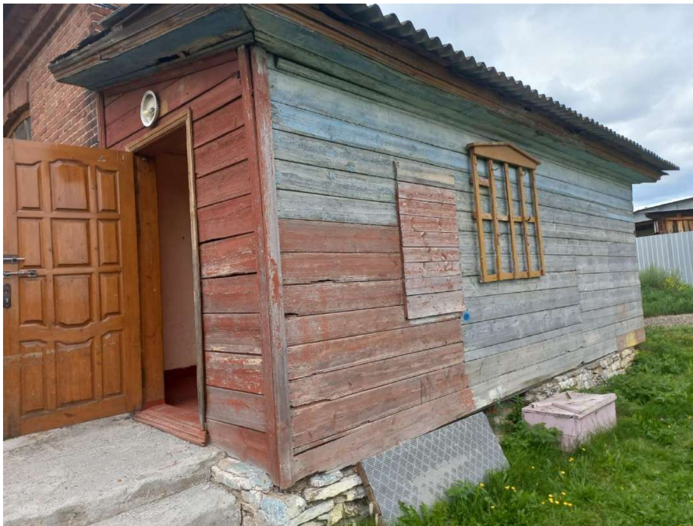
11. Пристройка, август 2023 г.
