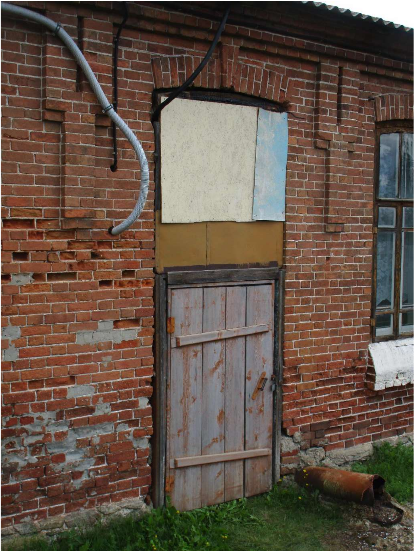
14. Западный фасад. Дверной проем на месте исторического оконного. Август 2023 г.
