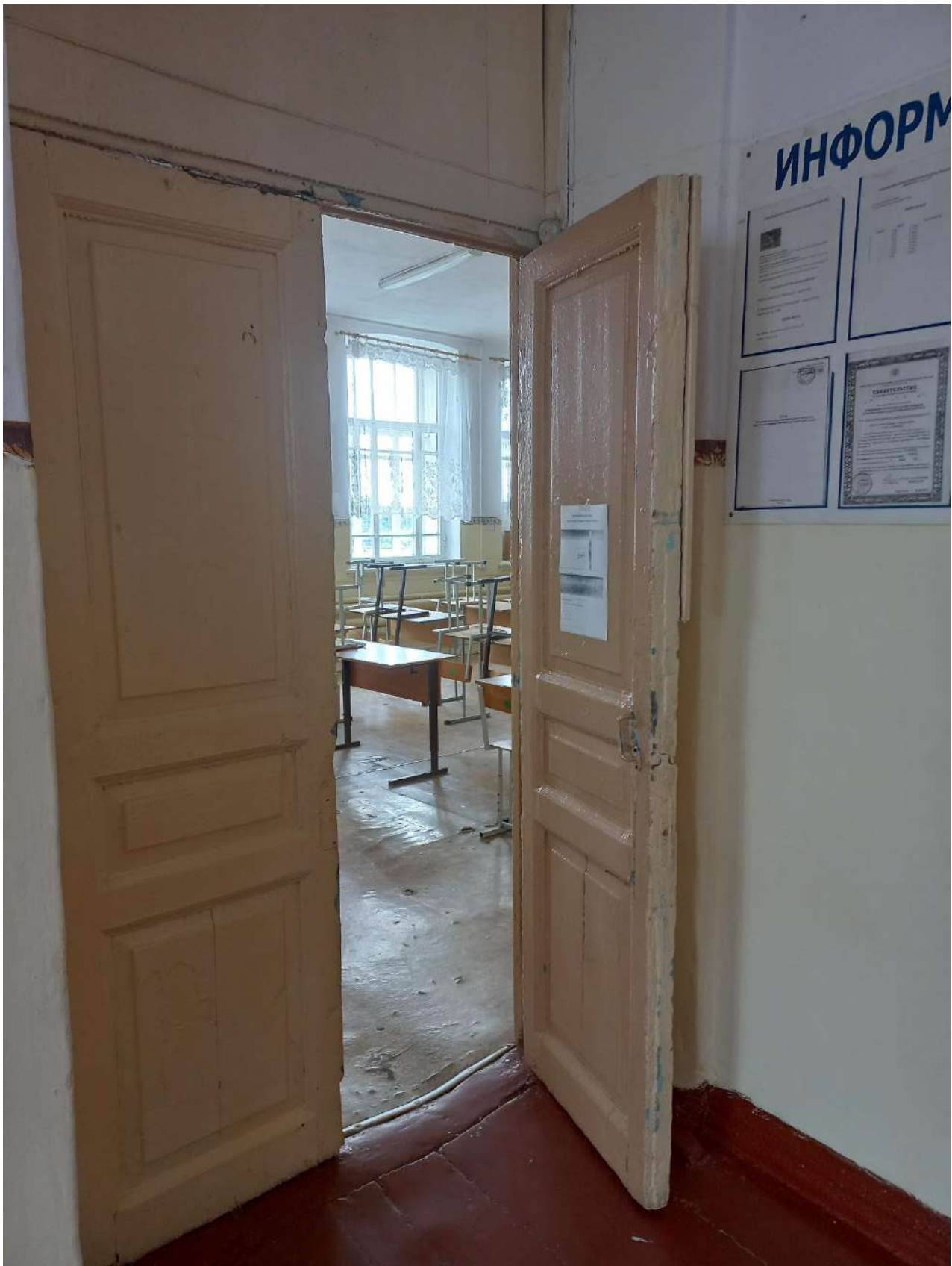
29. Интерьер. Дверной проем. Филенчатые двери. Август 2023 г.
