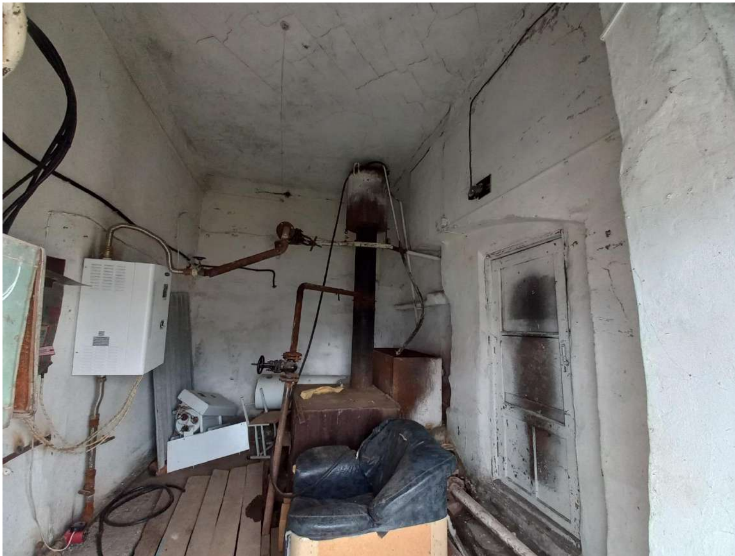
38. Интерьер. Котельная. Август 2023 г.
