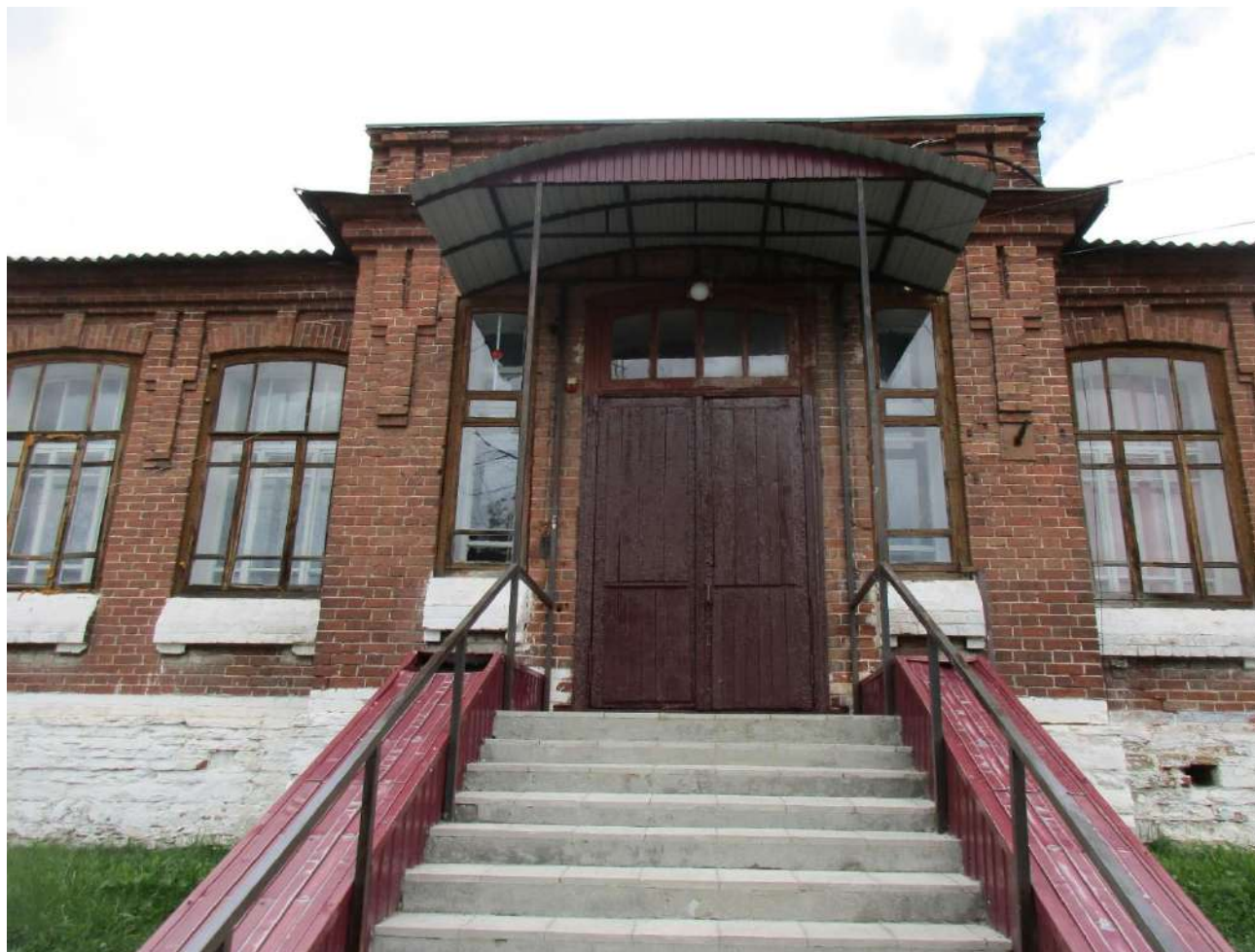
9. Главный фасад. Центральный ризалит. Парадный дверной проем с боковыми оконными проемами. Фрамуга дверного проема. Август 2023 г.
