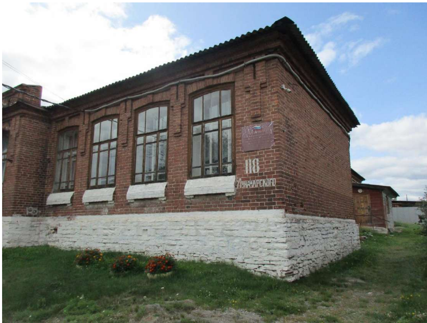
8. Правая часть главного фасада. Август 2023 г.
