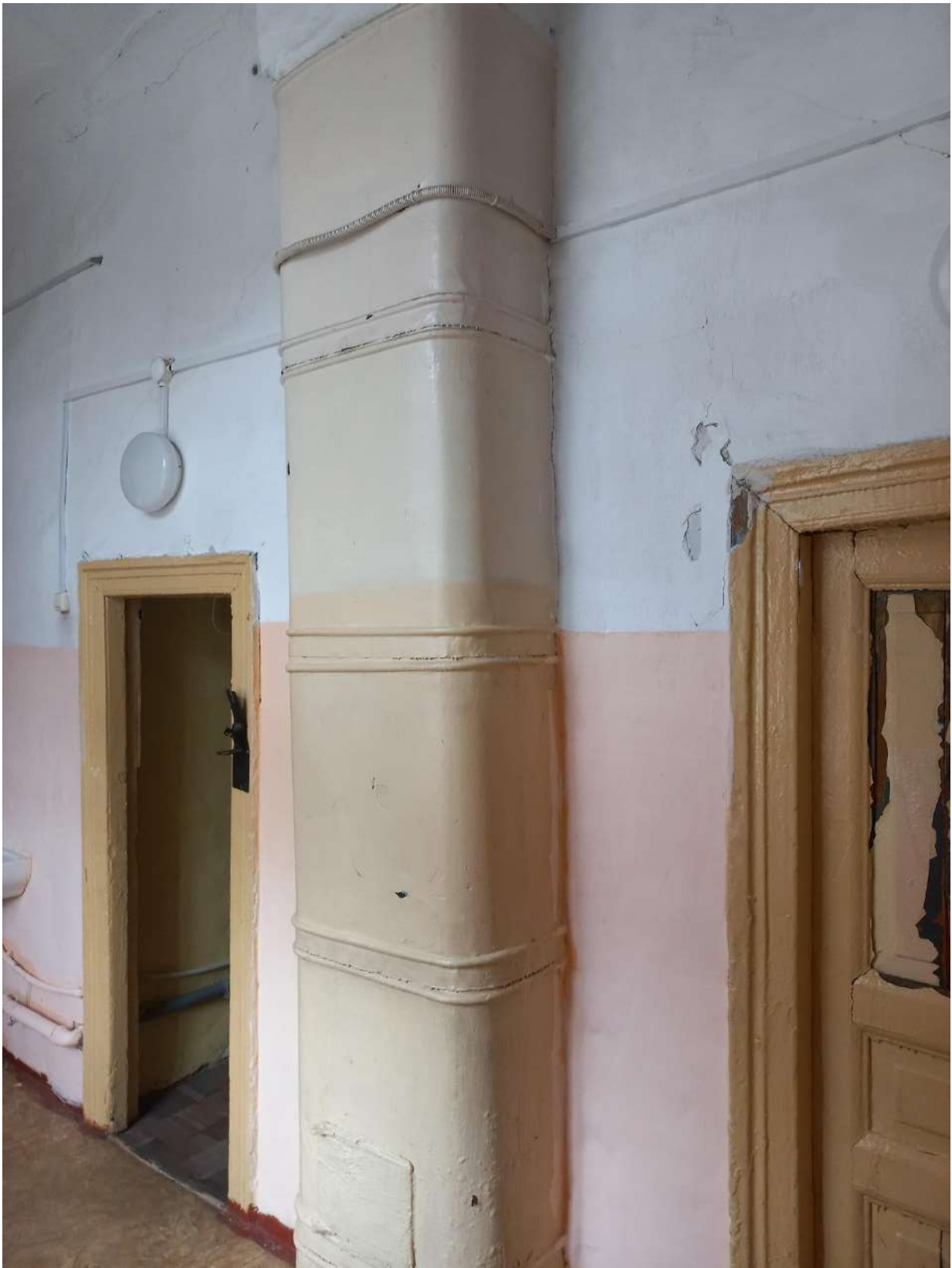
31. Интерьер. Дверные проемы в клозет. Печь. Август. 2023 г.
