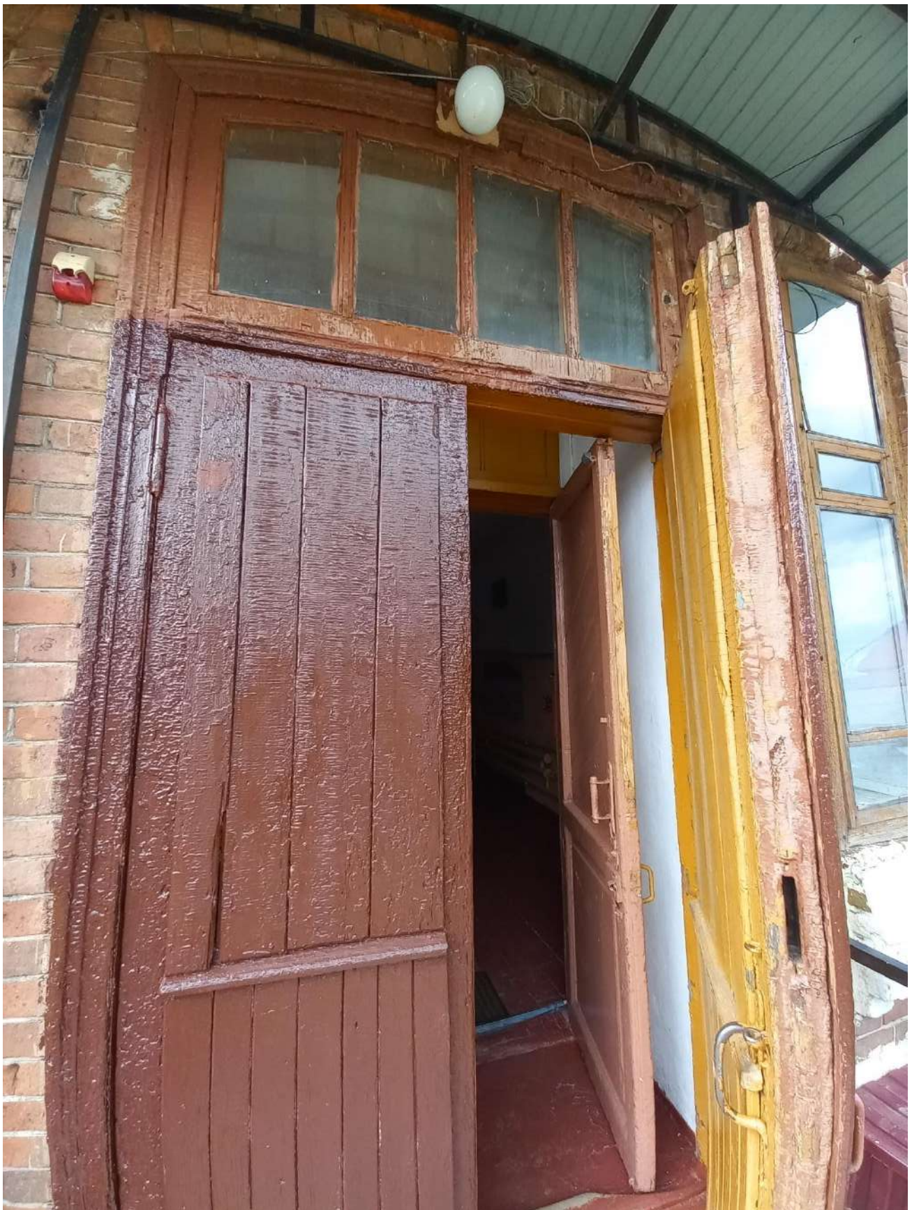
17. Дверной проем. Заполнение, включающее подлинную фрамугу. Август, 2023.
