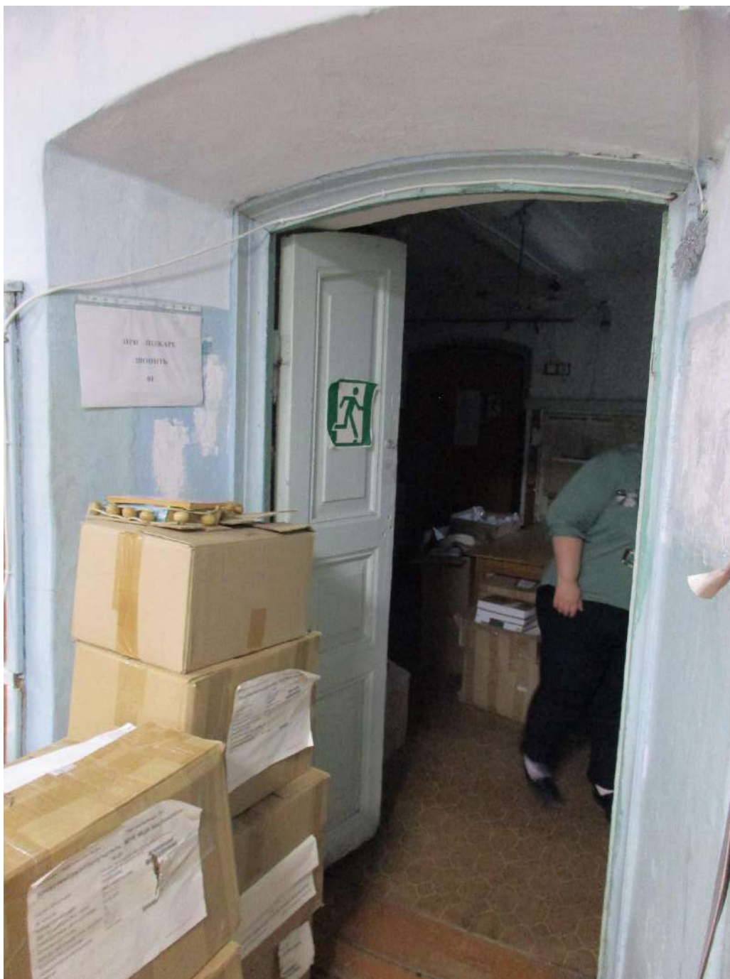
20. Основное здание. Интерьер. Цокольный этаж. Дверной проем. Филенчатые двери. Октябрь 2023 г.
