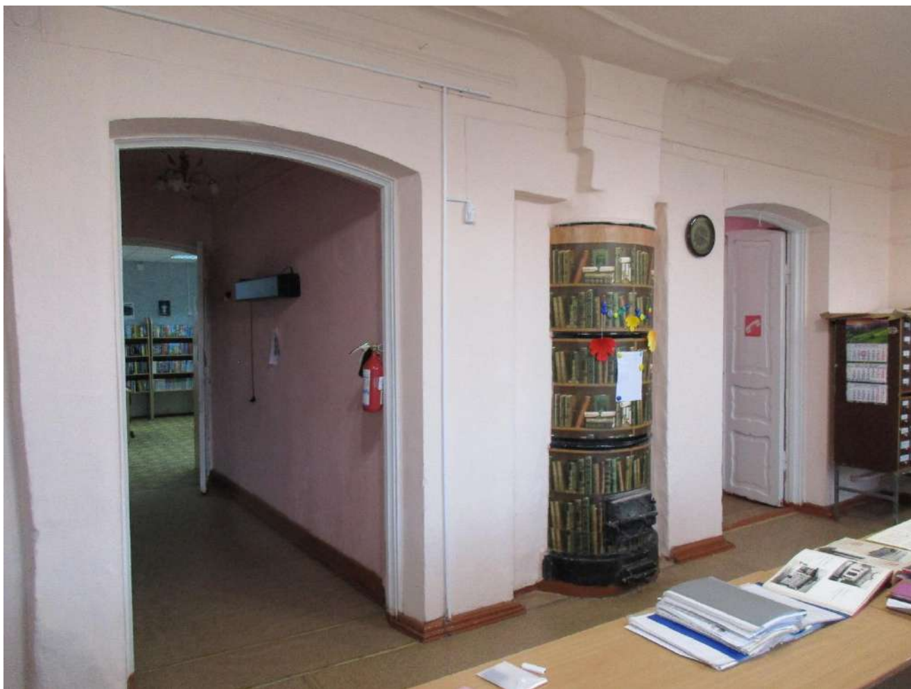
16. Основное здание. Интерьер. Первый этаж. Дверные проемы с лучковым завершением, филенчатые двери. Октябрь 2023 г.
