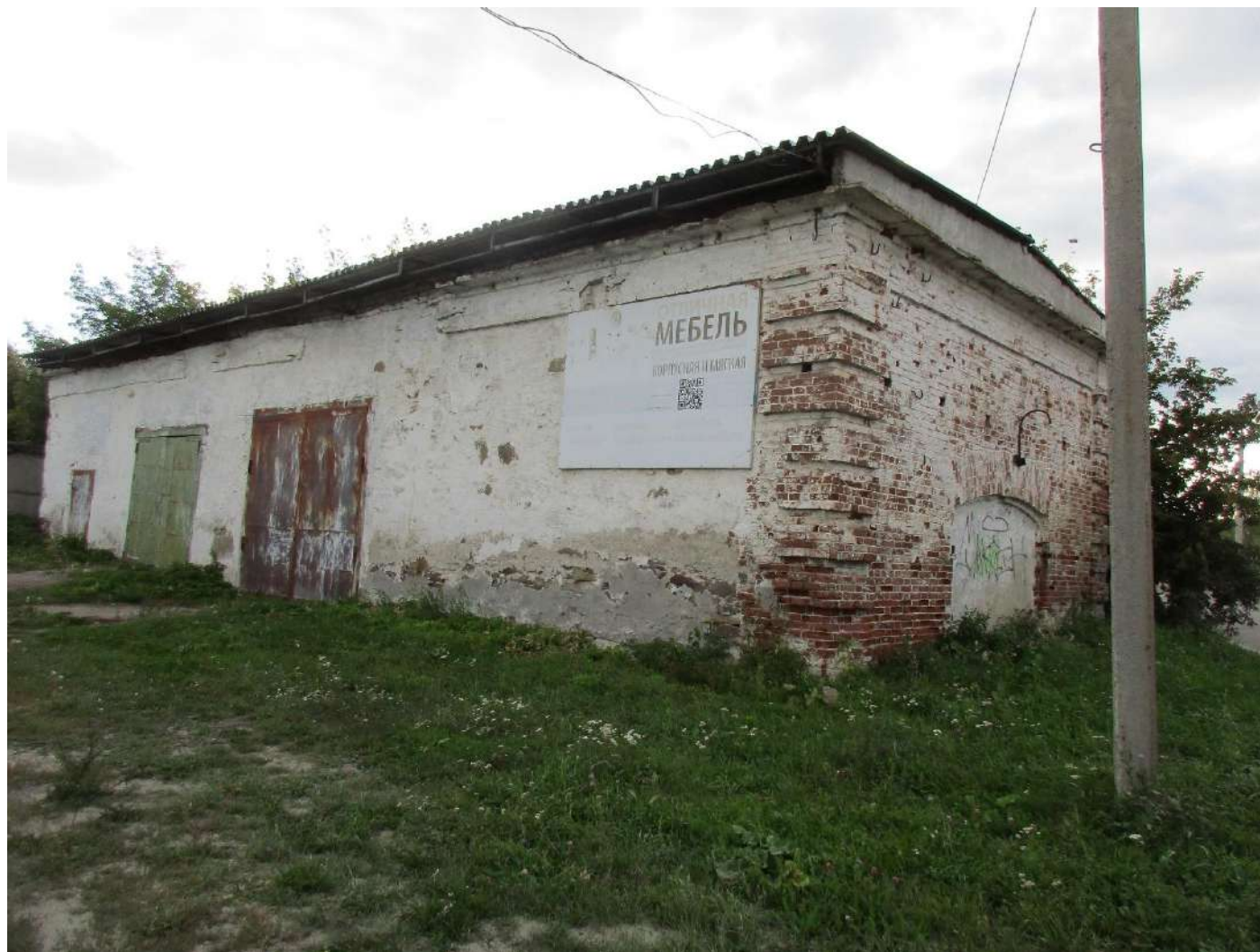
11. Приусадебное здание. Август, 2023 г.
