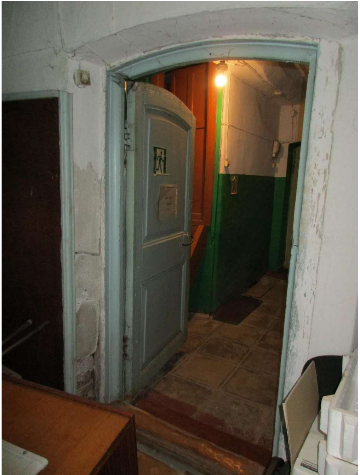
19. Основное здание. Интерьер. Цокольный этаж. Дверной проем. Филенчатая дверь. Октябрь 2023 г.
