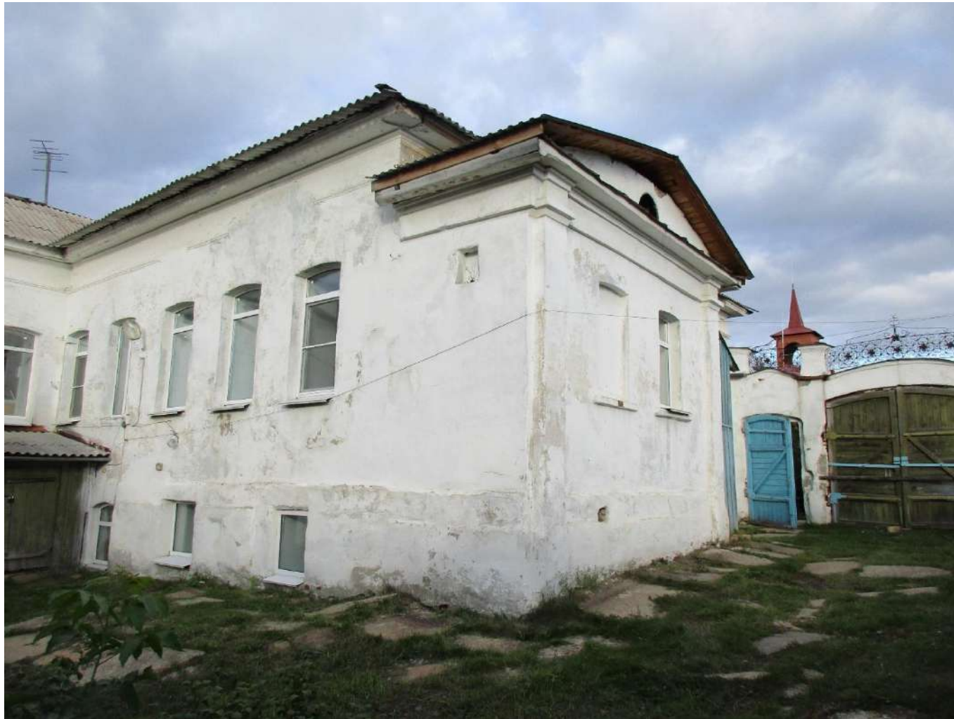
8. Основное здание. Тамбур сеней. Август 2023 г.
