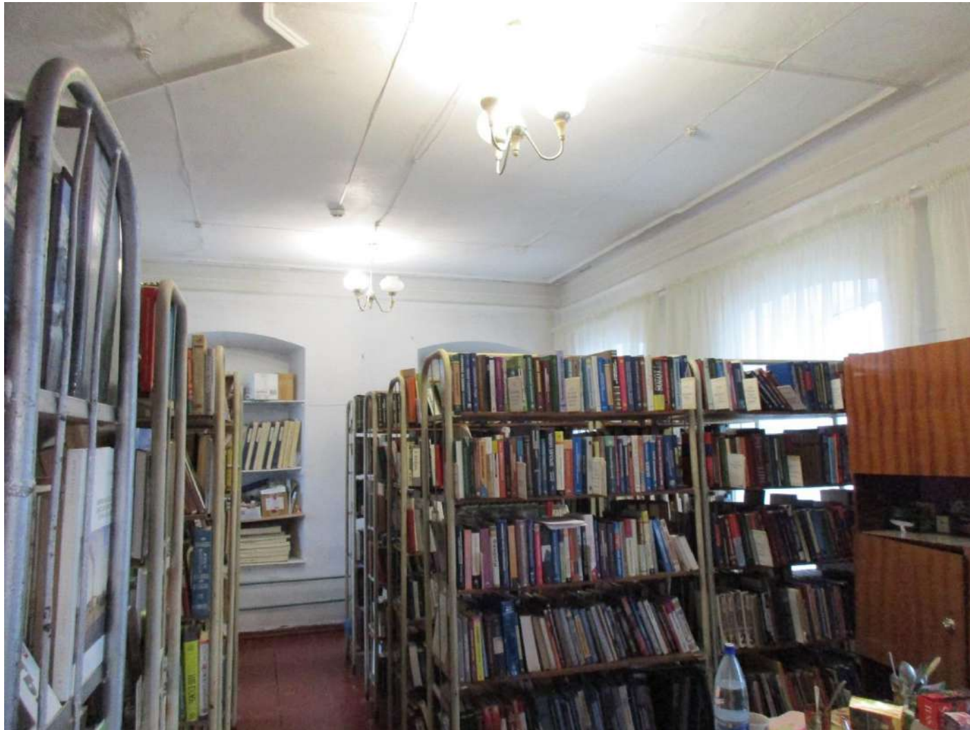
17. Основное здание. Интерьер. Первый этаж. Потолочные карнизы. Октябрь 2023 г.
