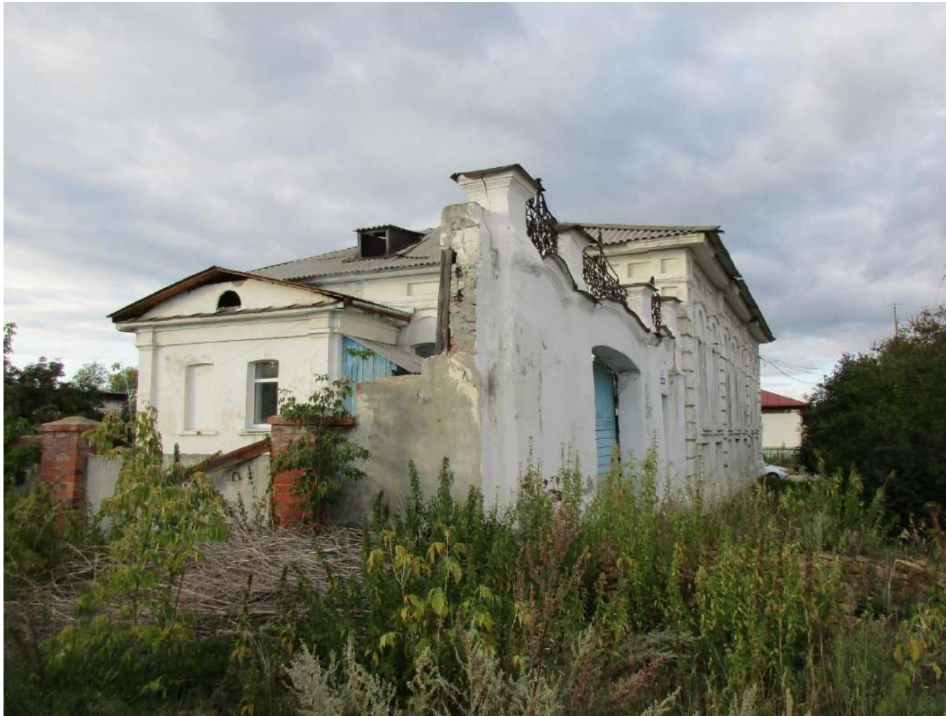
5. Основное здание. Вид с юго-запада. Август 2023 г.
