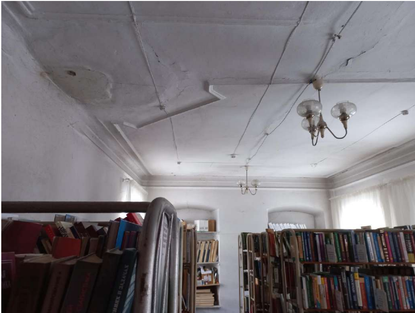
18. Основное здание. Интерьер. Первый этаж. Потолочные карнизы. Место демонтажа исторической печи. Октябрь 2023 г.
