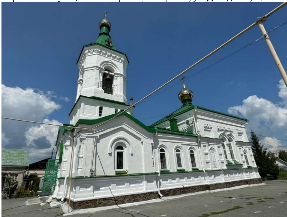
Фото 6. Вид на выявленный объект культурного наследия «Церковь Святых апостолов Петра и Павла», расположенный по адресу: Челябинская область, Коркинский муниципальный район, г. Коркино, ул. Д. Бедного, 40.
