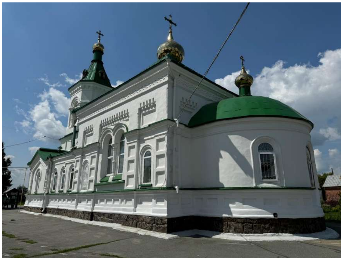
Фото 18. Вид на выявленный объект культурного наследия «Церковь Святых апостолов Петра и Павла», расположенный по адресу: Челябинская область, Коркинский муниципальный район, г. Коркино, ул. Д. Бедного, 40.
