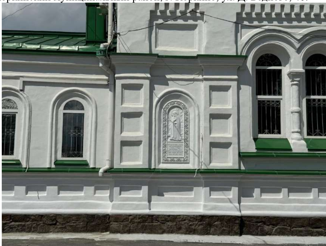
Фото 10. Вид на выявленный объект культурного наследия «Церковь Святых апостолов Петра и Павла», расположенный по адресу: Челябинская область, Коркинский муниципальный район, г. Коркино, ул. Д. Бедного, 40.
