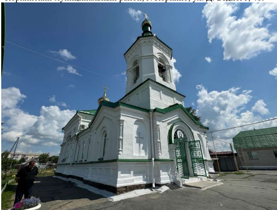
Фото 27. Вид на выявленный объект культурного наследия «Церковь Святых апостолов Петра и Павла», расположенный по адресу: Челябинская область, Коркинский муниципальный район, г. Коркино, ул. Д. Бедного, 40.
