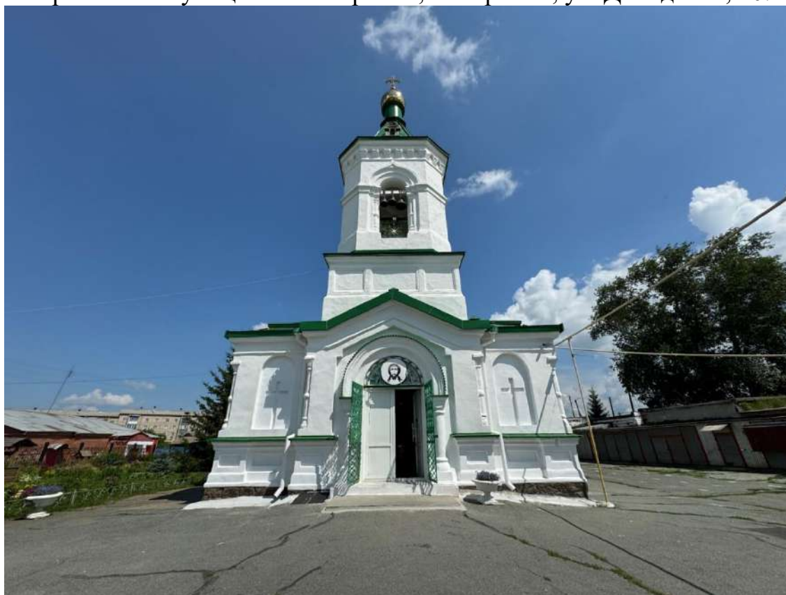
Фото 2. Вид на выявленный объект культурного наследия «Церковь Святых апостолов Петра и Павла», расположенный по адресу: Челябинская область, Коркинский муниципальный район, г. Коркино, ул. Д. Бедного, 40.
