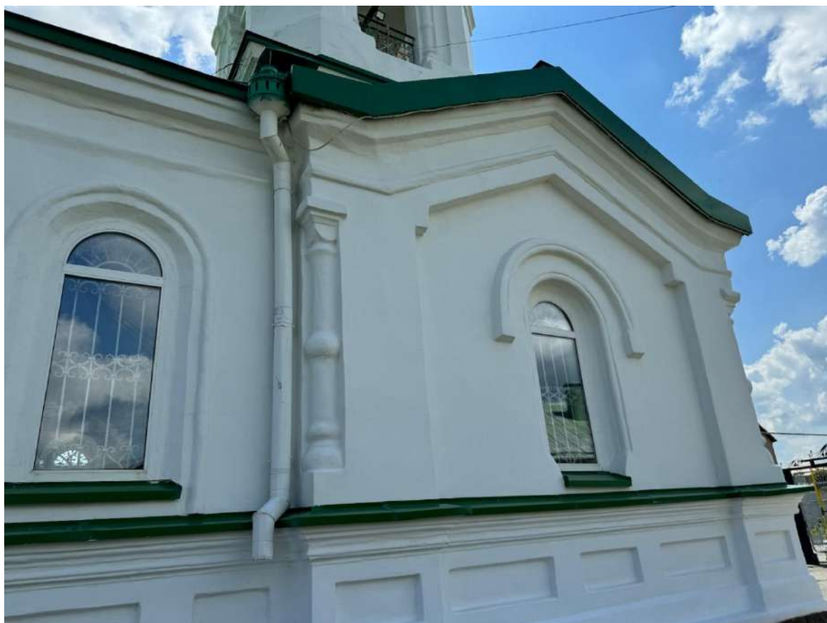
Фото 26. Вид на выявленный объект культурного наследия «Церковь Святых апостолов Петра и Павла», расположенный по адресу: Челябинская область, Коркинский муниципальный район, г. Коркино, ул. Д. Бедного, 40.
