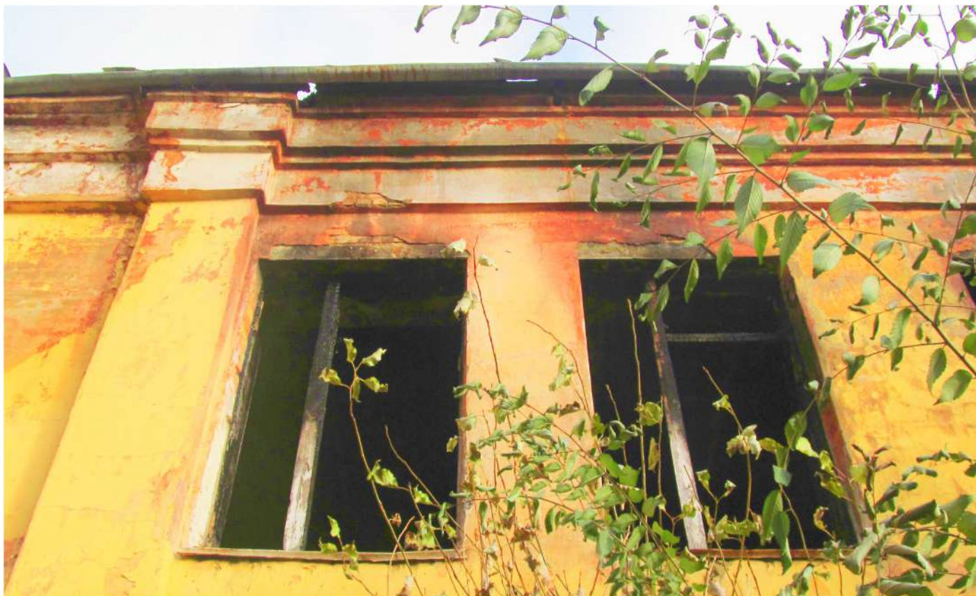
Рис. 34 Вид на карнизную зону восточного фасада южного пристроя здания бывшей казармы (Лит. 17)
