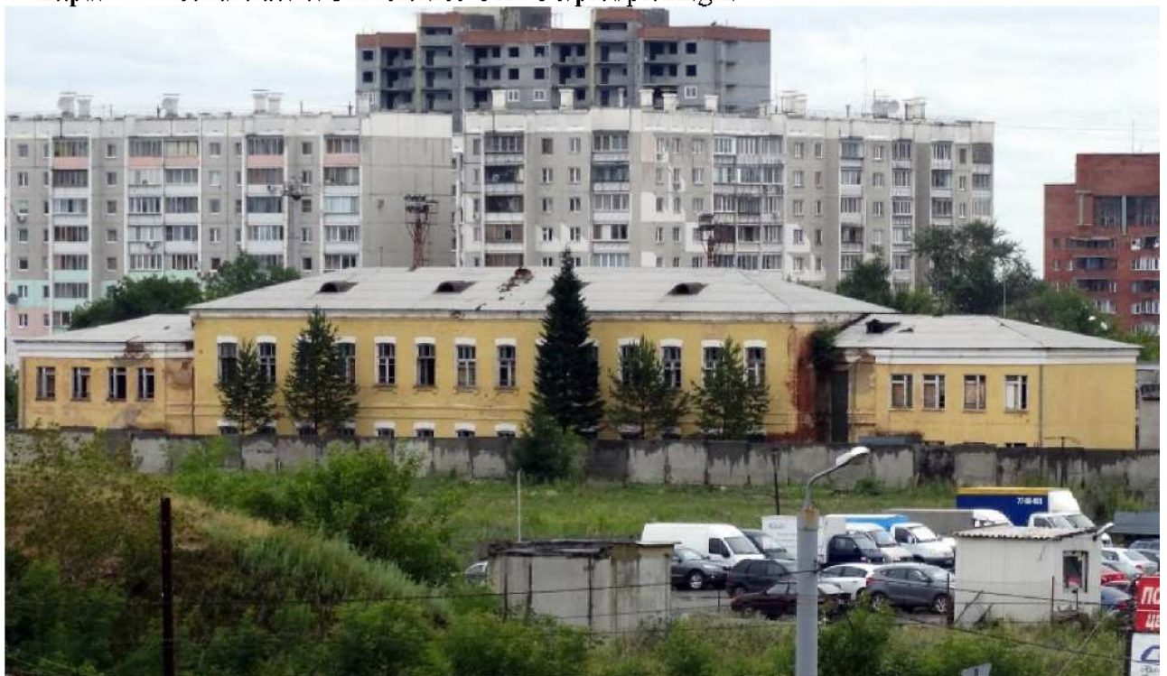
Рис. 29 Здание Казармы № 3 бывшего Войскового остановочного пункта по ул. Монакова, 1а/2 (Фото - июль 2014 г., автор – Ю.В. Латышев). Ссылка: http://img-fotki.yandex.ru/get/6814/5661614.75/0_a4774_721e8cb4_XL.jpg .
