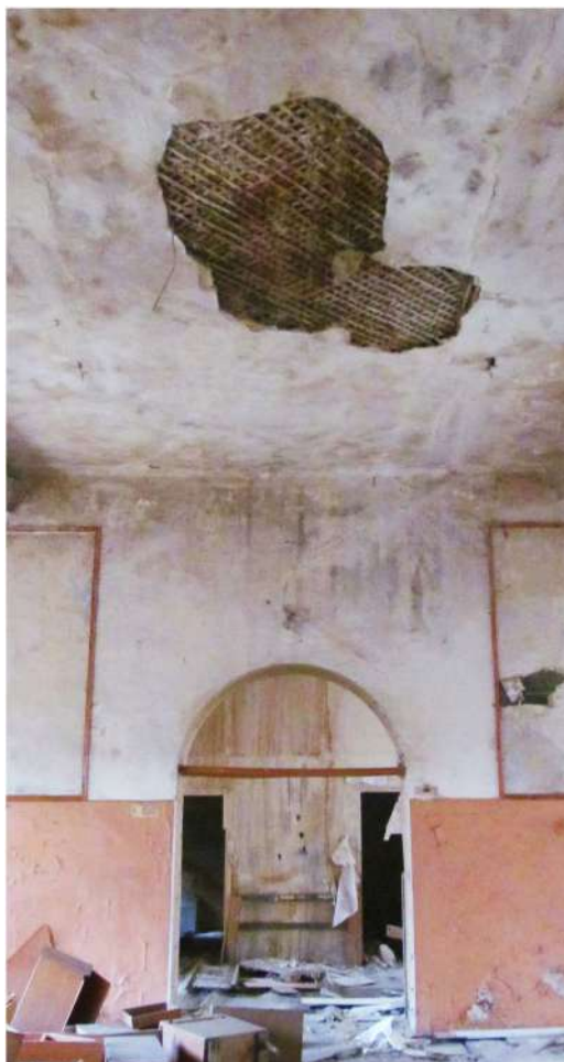
Рис. 50 Вид на интерьер помещения бывшей казармы (Лит. 17)
