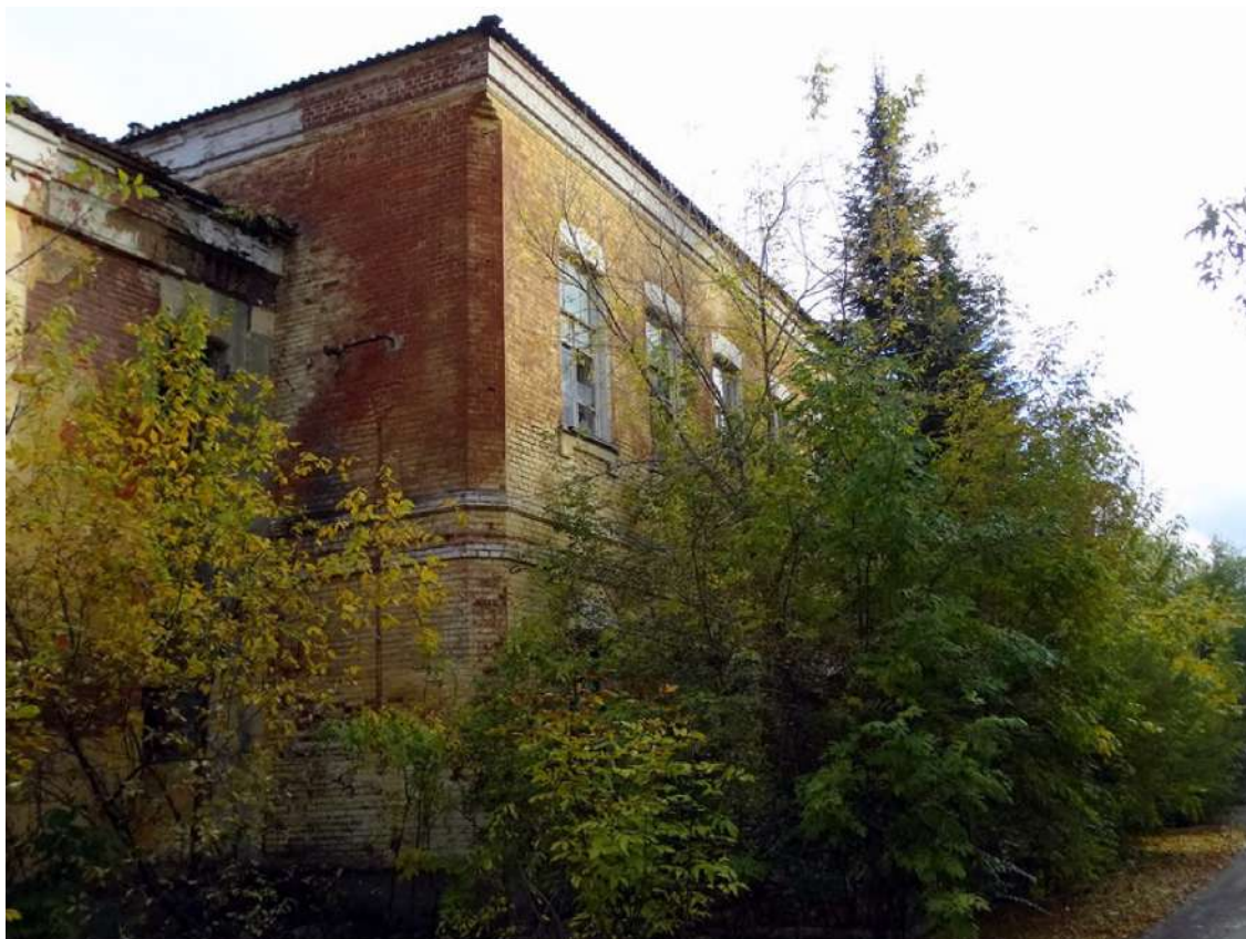
Рис. 56 Здание Казармы № 1 бывшего Войскового остановочного пункта по ул. Монакова, 1а/4 (Фото - октябрь 2016 г., автор – Ю.В. Латышев). Ссылка: https://img-fotki.yandex.ru/get/50666/5661614.149/0_c175a_40f36fdb_XL.jpg .
