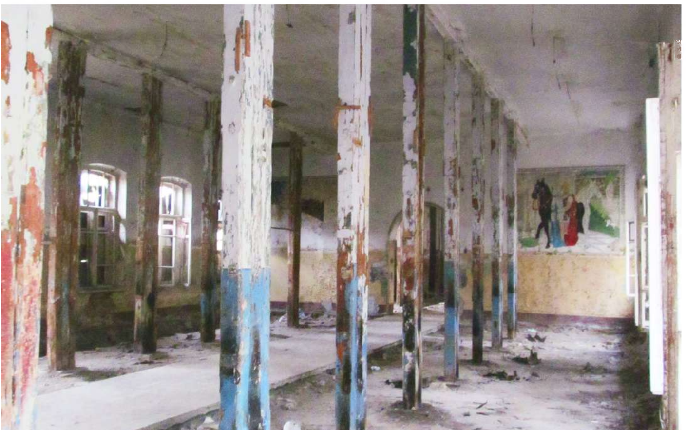
Рис. 23 Вид на помещение бывшей казармы (Лит. 18) северо-запада
