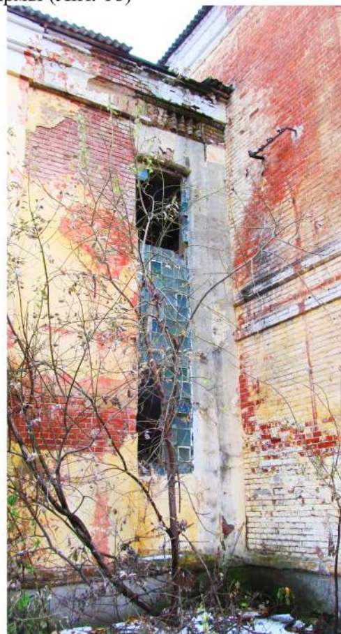
Рис. 8 Вид на лестничную клетку северного пристроя здания бывшей казармы (Лит. 18)
