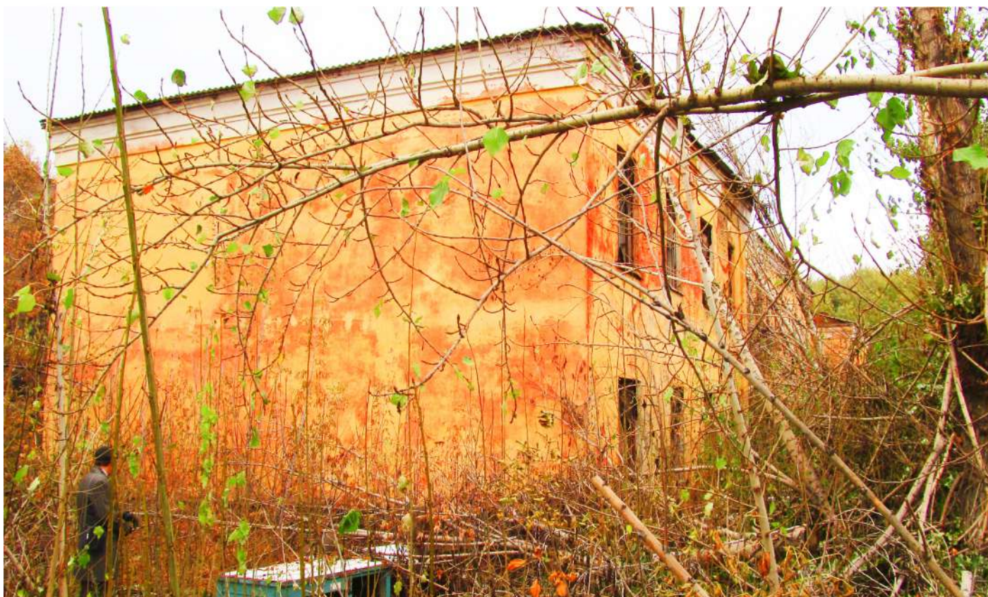
Рис. 6 Вид на юго-западный фасад здания бывшей казармы (Лит. 18)
