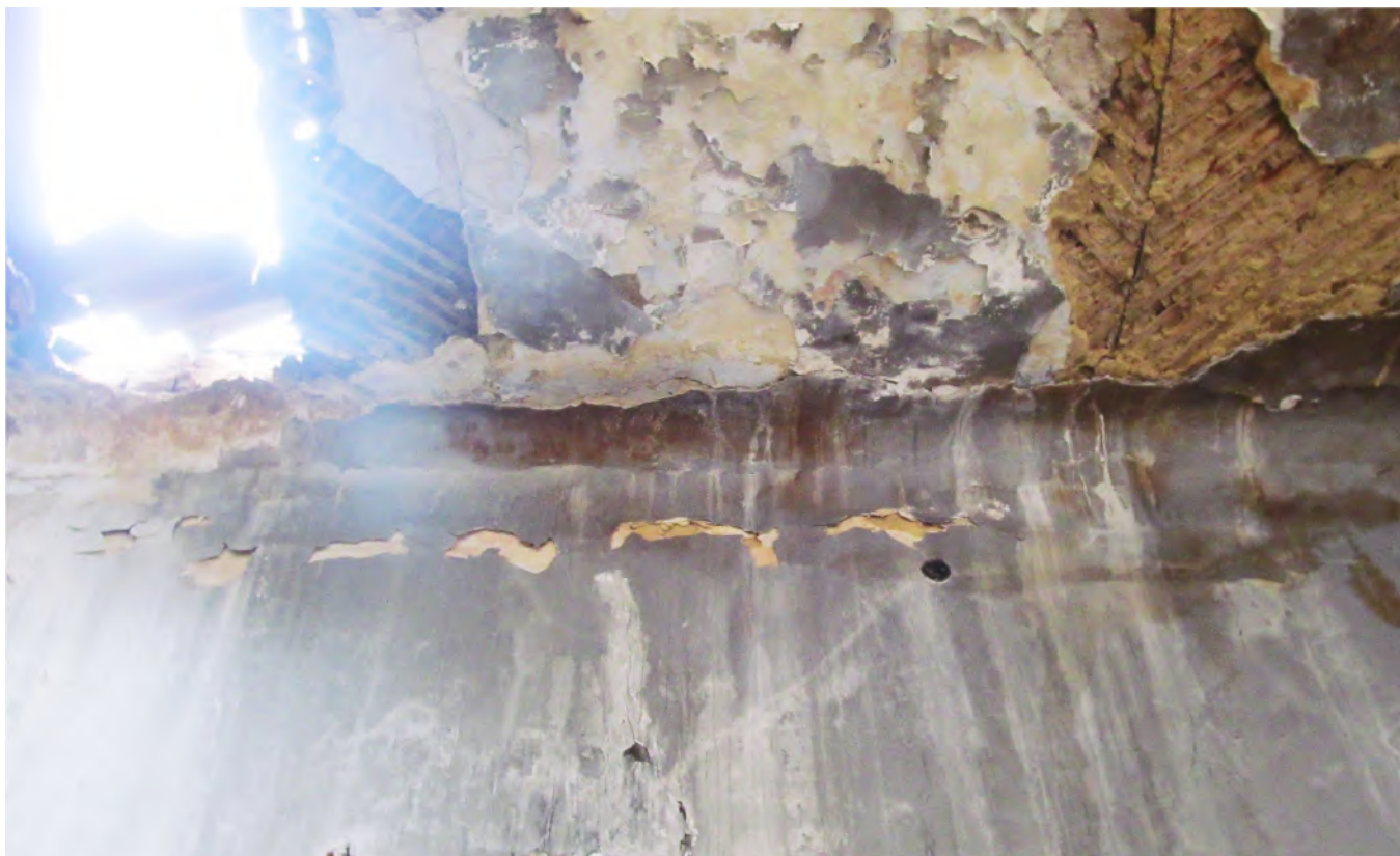
Рис. 67 Вид на стены и потолок помещения 2-го этажа бывшей казармы (Лит. 17)
