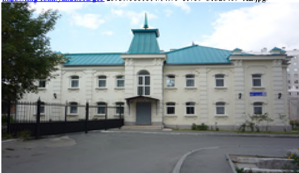
Рис. 31 «Баня» (сейчас офис «Союзлифтмонтаж») по ул. Монакова, 39 (прибл. 1914). Здание в «краснокирпичном стиле» (в современном виде оштукатуренно), 2-х этажное. Схожая схема построения фасада: ризалит с центральным входом, лопатки на углах здания выделяют группу окон, арочные окна с замками на 2-ом этаже ризалитов, уступчатый карниз.
