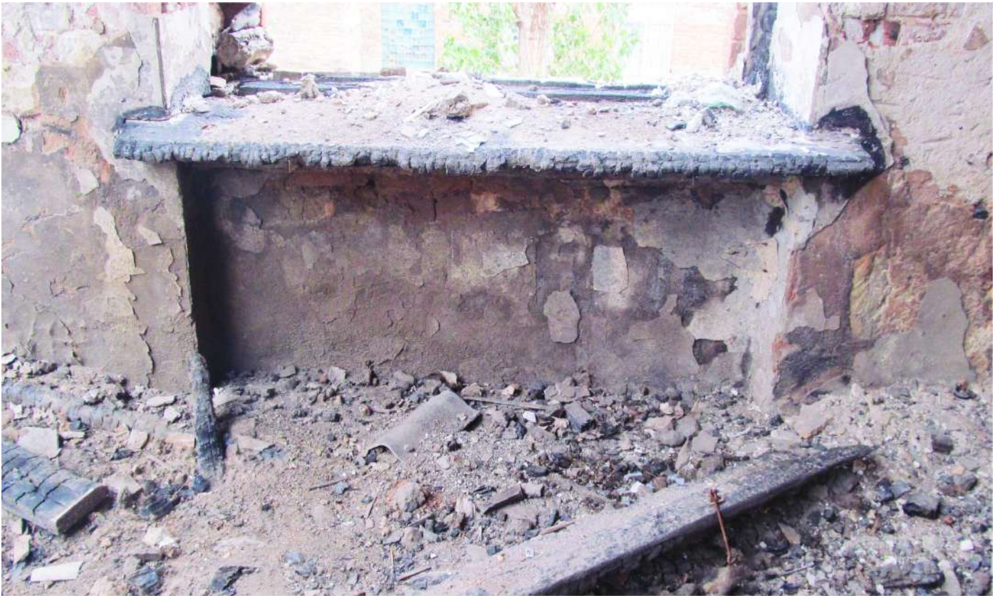
Рис. 57 Вид на подоконную зону помещения 2-го этажа бывшей казармы (Лит. 17)
