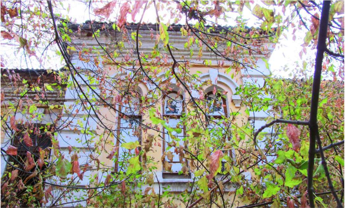
Рис. 82 Вид на окна 2-го этажа ризалита западного фасада здания бывшего штаба (Лит. 23)
