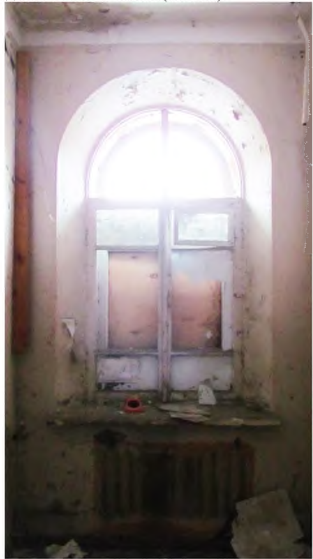
Рис. 91 Вид на оконный проем 1-го этажа здания бывшего штаба (Лит. 23) с юга
