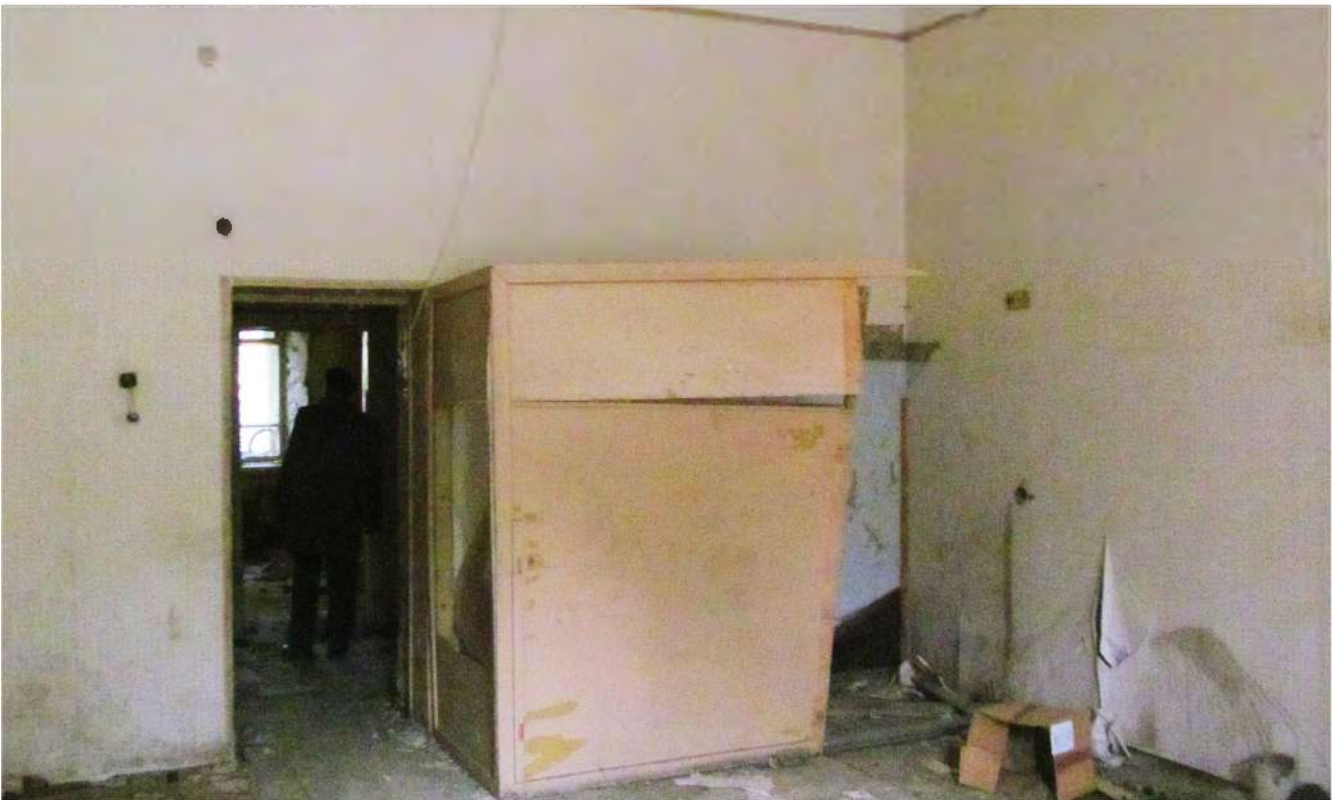
Рис. 93 Вид на помещение 1-го этажа здания бывшего штаба (Лит. 23) с юго-запада
