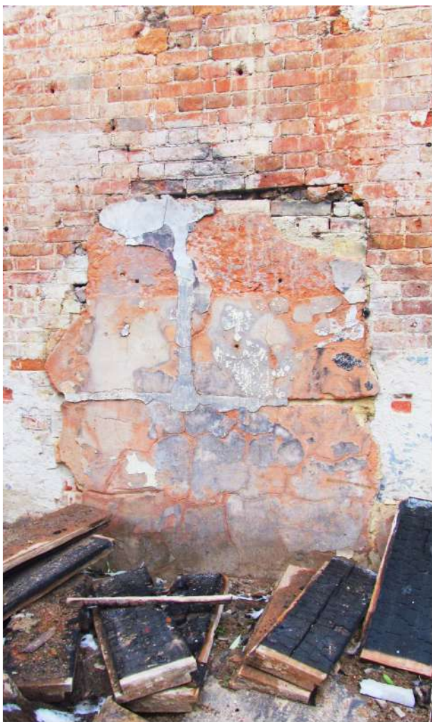
Рис. 59 Вид на заложенный печной проем помещения 2-го этажа бывшей казармы (Лит. 17)
