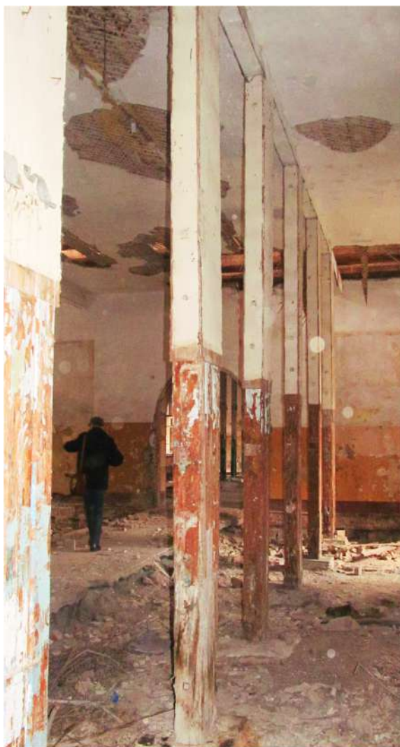
Рис. 19 Вид на сохранившиеся колонны помещения бывшей казармы (Лит. 18)
