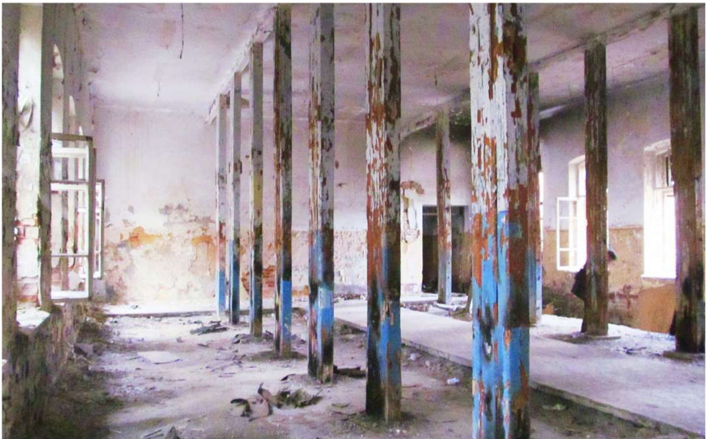
Рис. 22 Вид на помещение бывшей казармы (Лит. 18) с юго-запада
