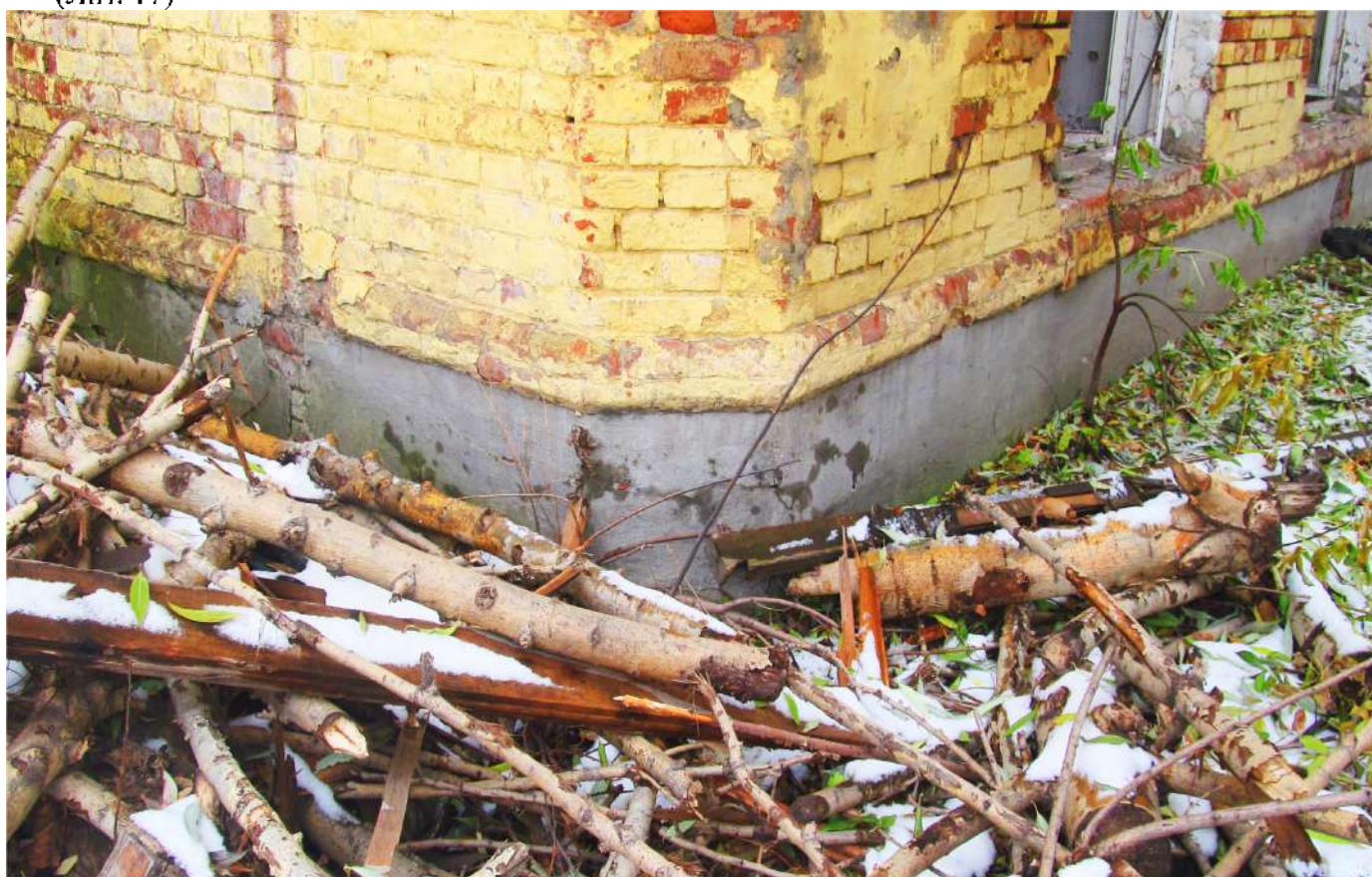
Рис. 38 Вид на цоколь северо-восточной угловой части здания бывшей казармы (Лит. 17)
