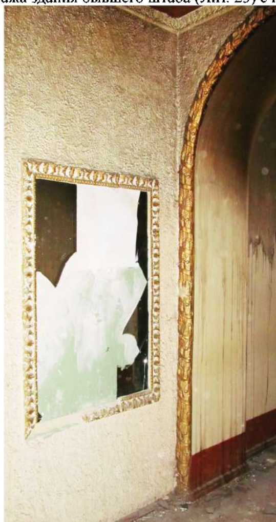
Рис. 99 Вид на коридор 2-го этажа здания бывшего штаба (Лит. 23) с юго-запада
