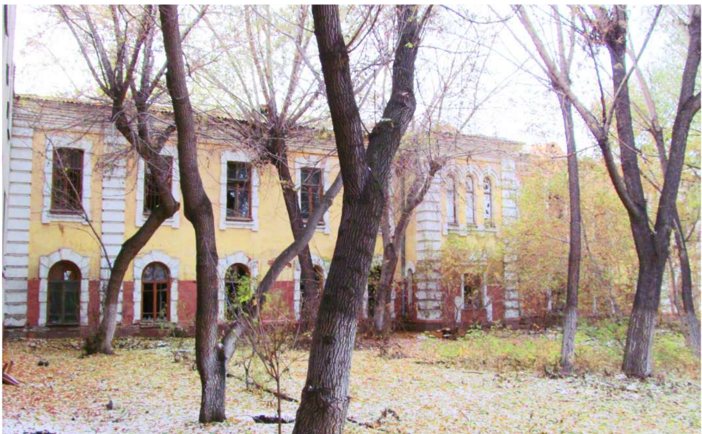
Рис. 74 Вид на западный фасад здания бывшего штаба (Лит. 23)
