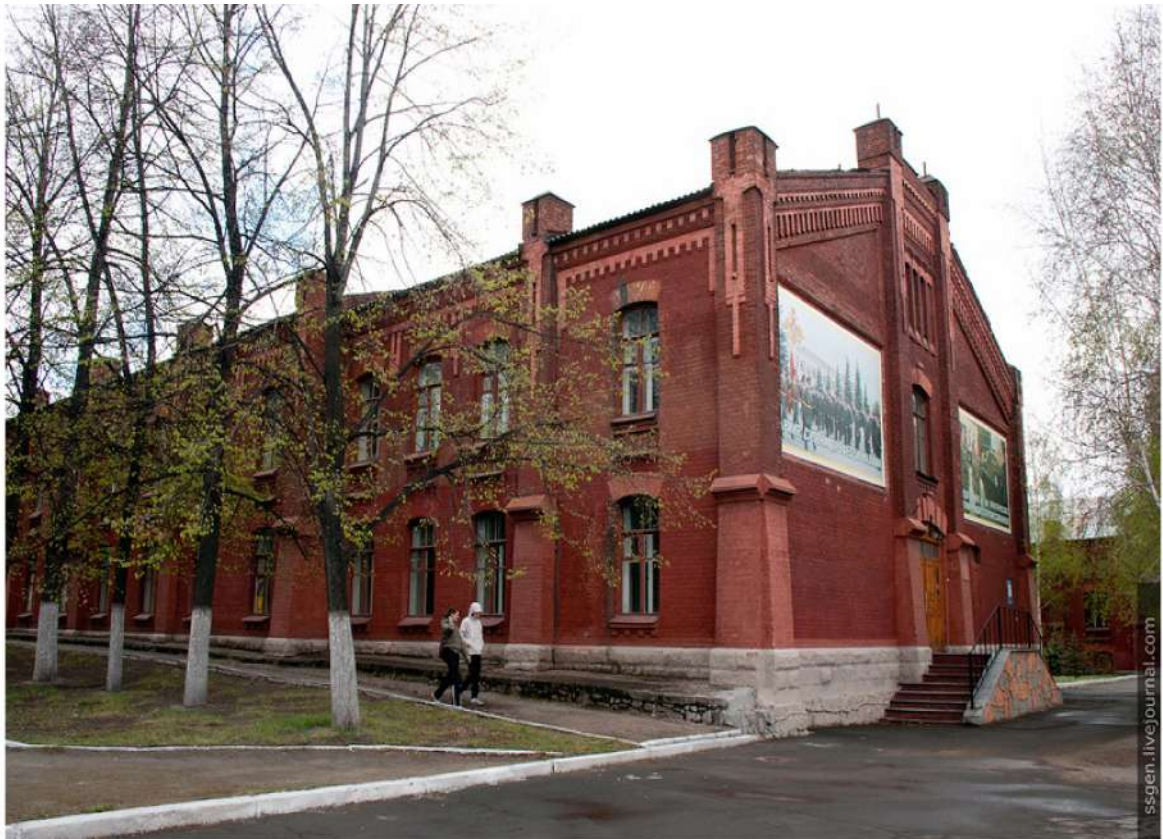
Рис. 32 «Красные казармы» по Свердловскому пр-ту, на территории ЧВАКУ (1913-1914 гг.). Схожее построение фасдов: углы здания фланкируют лопатки, на ризалите спаренные узкие арочные окна, наборный карниз.
