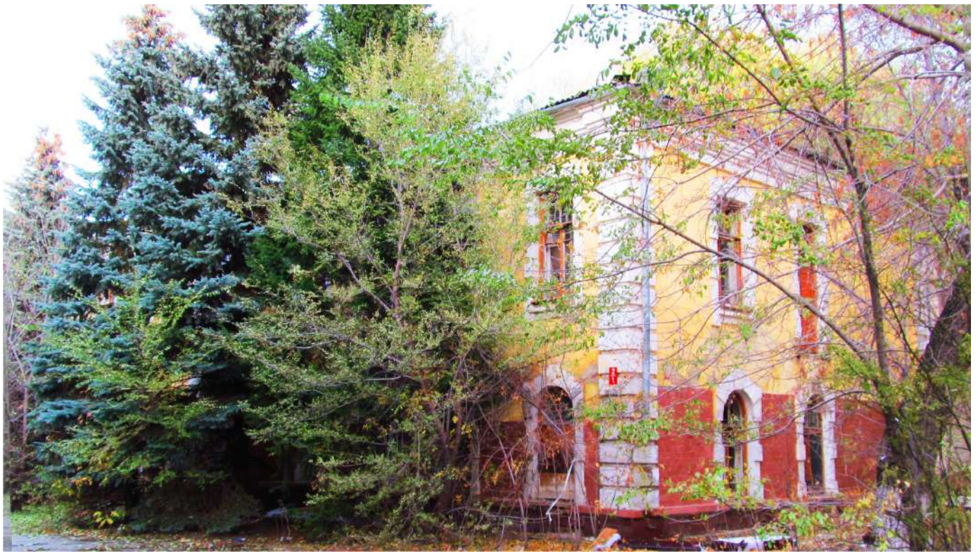
Рис. 69 Вид на юго-восточный фасад здания бывшего штаба (Лит. 23)
