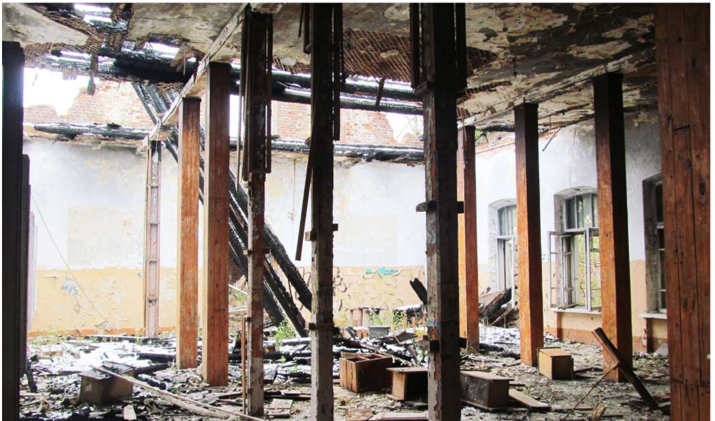
Рис. 63 Вид на интерьер помещения 2-го этажа бывшей казармы (Лит. 17) с северо-востока
