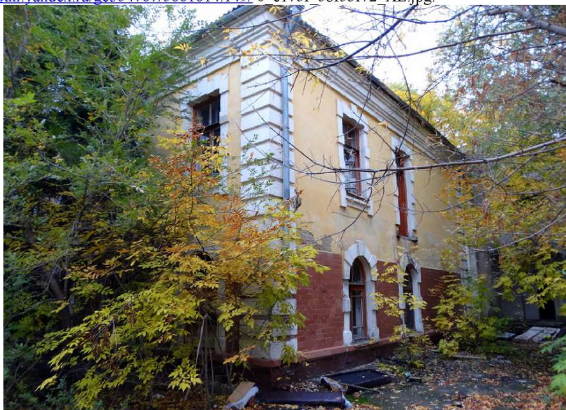
Рис. 55 Здание штаба бывшего Войскового остановочного пункта по ул. Монакова, 1а/5 (Фото - октябрь 2016 г., автор – Ю.В. Латышев). Ссылка: https://img-fotki.yandex.ru/get/62701/5661614.149/0_c1760_169e73_69_XL.jpg .
