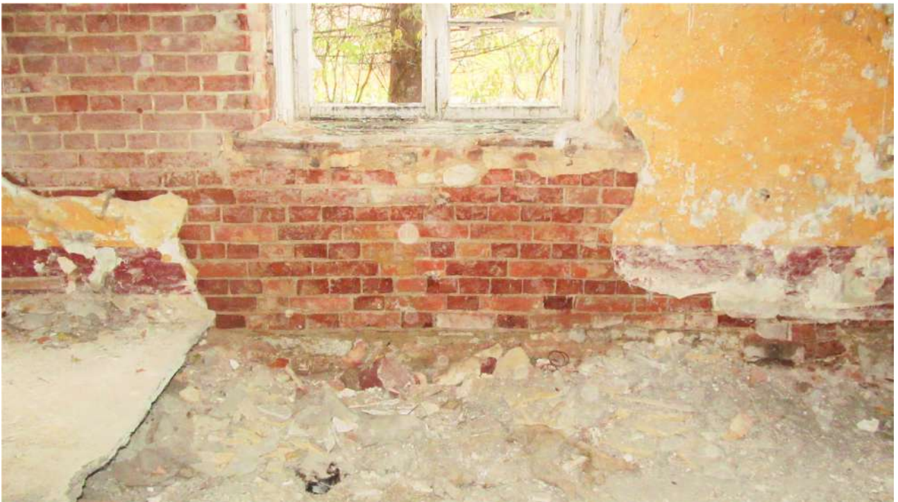
Рис. 18 Вид на подоконную зону помещения бывшей казармы (Лит. 18)
