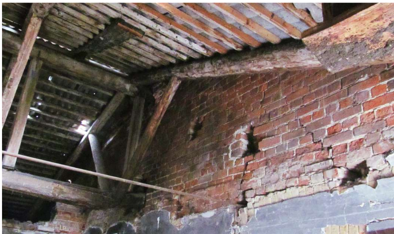
Рис. 68 Вид на стропильные конструкции над лестничной клеткой бывшей казармы (Лит. 17)
