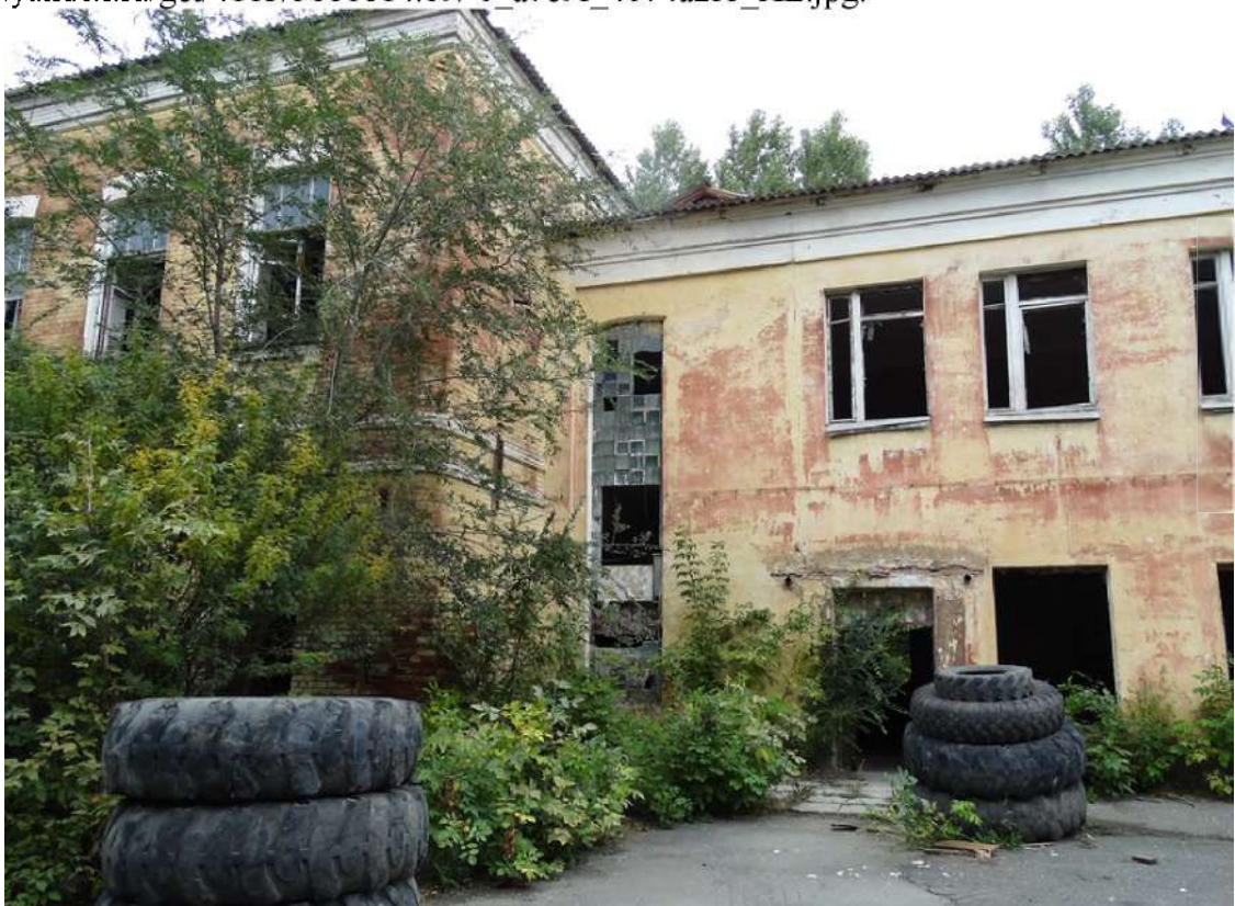
Рис. 47 Здание Казармы № 1 бывшего Войскового остановочного пункта по ул. Монакова, 1а/4 (Фото - сентябрь 2014 г., автор – Ю.В. Латышев). Ссылка: http://img-fotki.yandex.ru/get/5110/5661614.89/0_a7ea1_34c919e5_XL.jpg .
