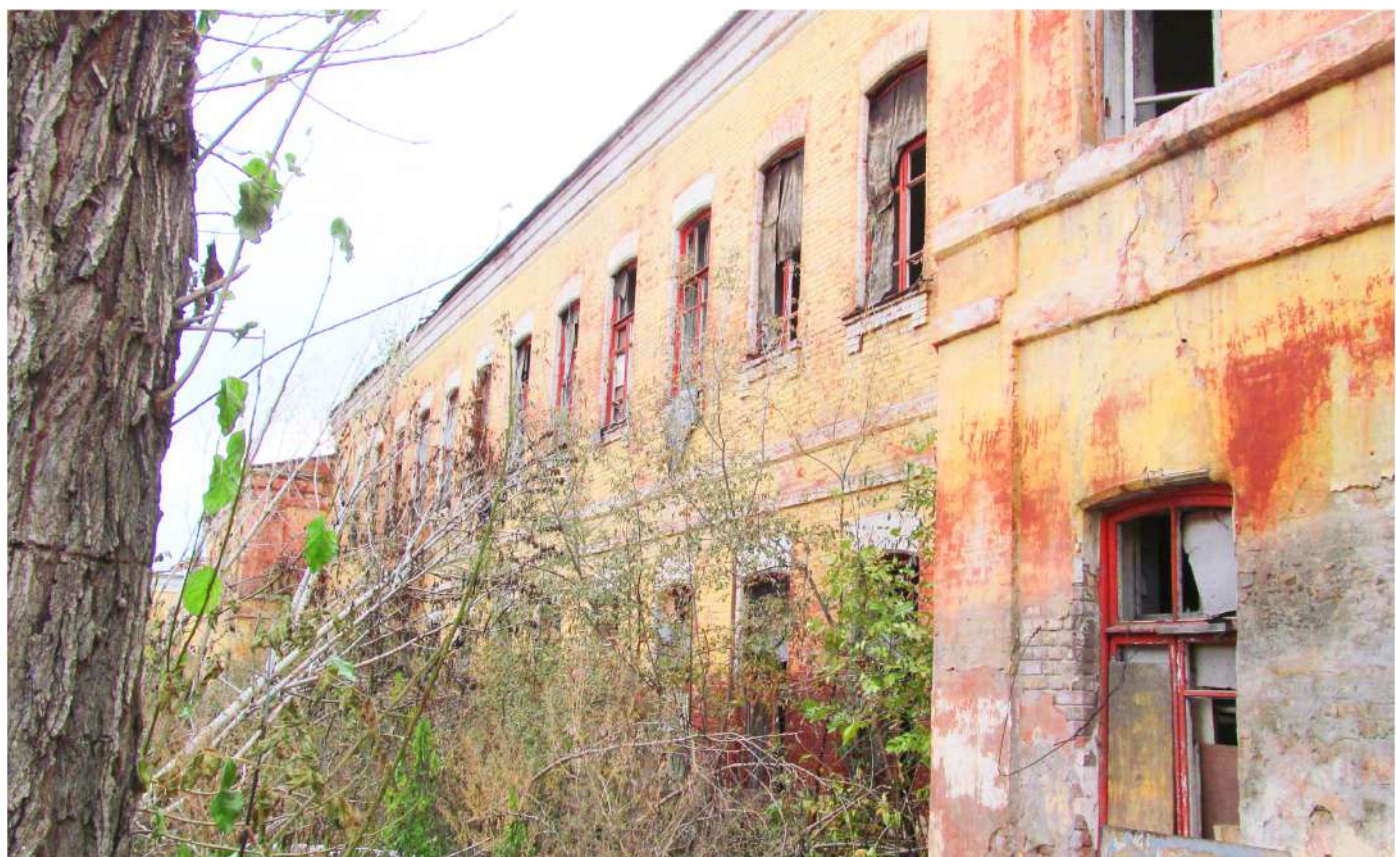
Рис. 5 Вид на западный фасад здания бывшей казармы (Лит. 18)
