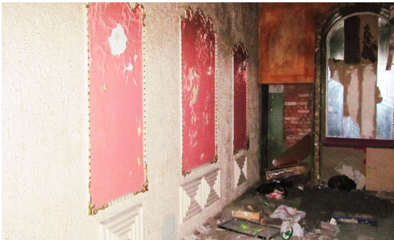
Рис. 98 Вид на холл 2-го этажа здания бывшего штаба (Лит. 23) с юго-востока
