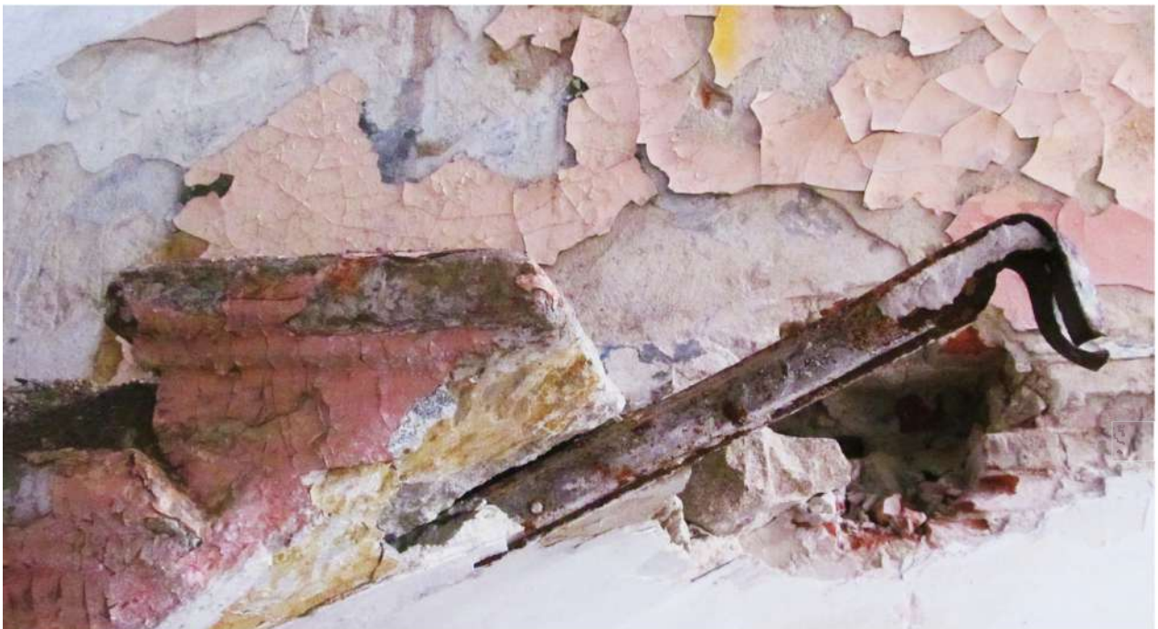
Рис. 29 Вид на фрагмент металлической тетевы лестницы на 2-ой этаж бывшей казармы (Лит. 18)
