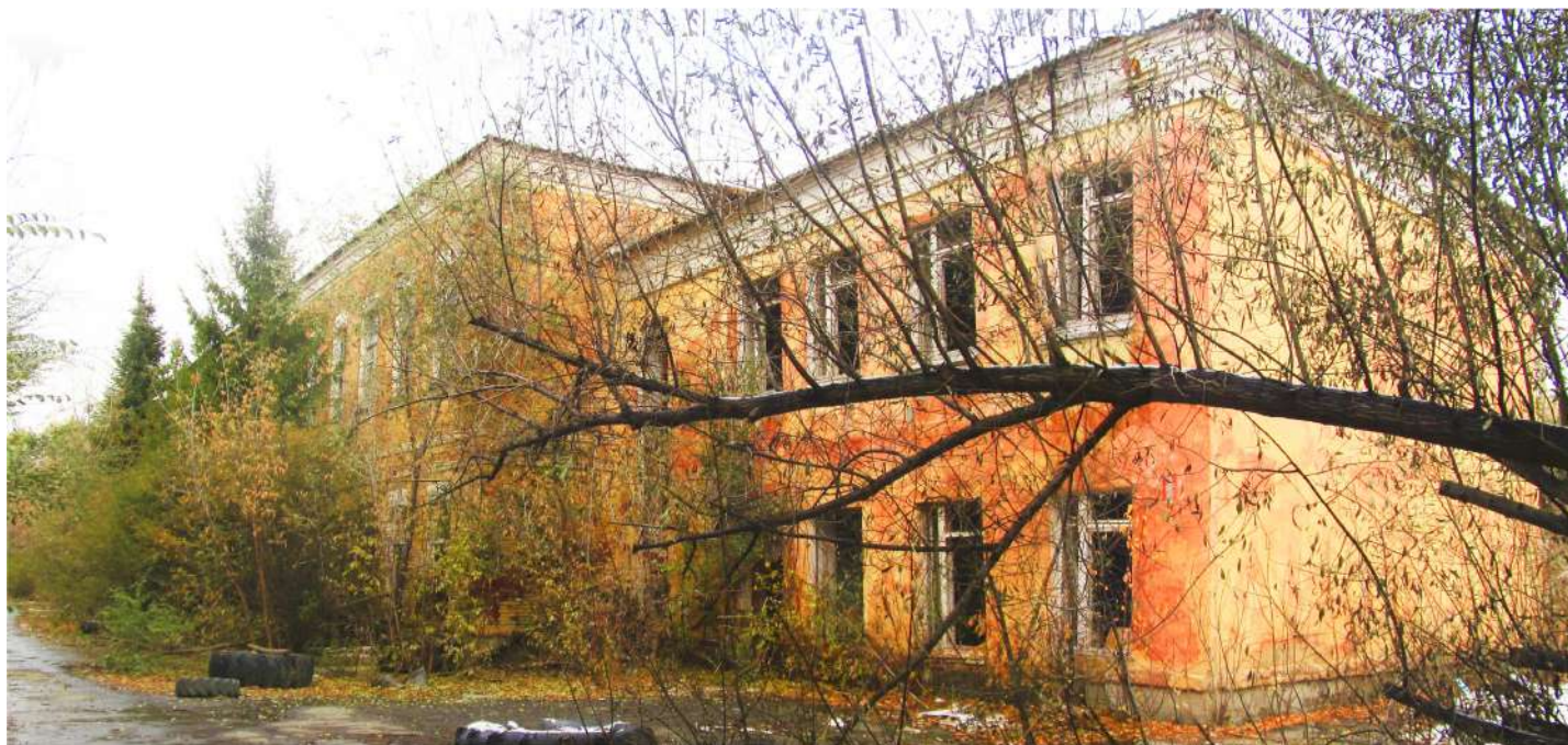
Рис. 2 Вид на юго-восточный фасад здания бывшей казармы (Лит. 18)
