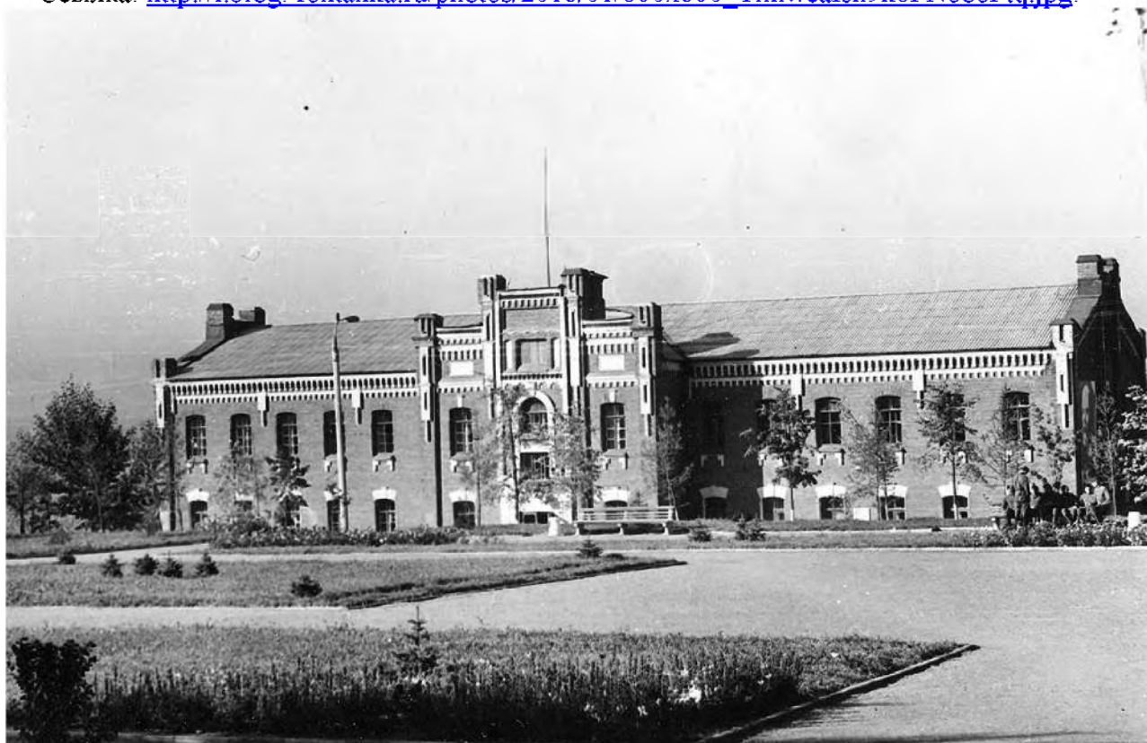
Рис. 21 Красные казармы. Здание, в котором в ноябре 1917 г. был расквартирован сводный отряд рабочих и красногвардейцев (Ориентировочно 1970-е годы)// Фотография из Музея трудовой славы Челябинского электровозоремонтного завода. Ссылка: http://www.gnpc74.ru/images/red_quarters_01.jpg .
