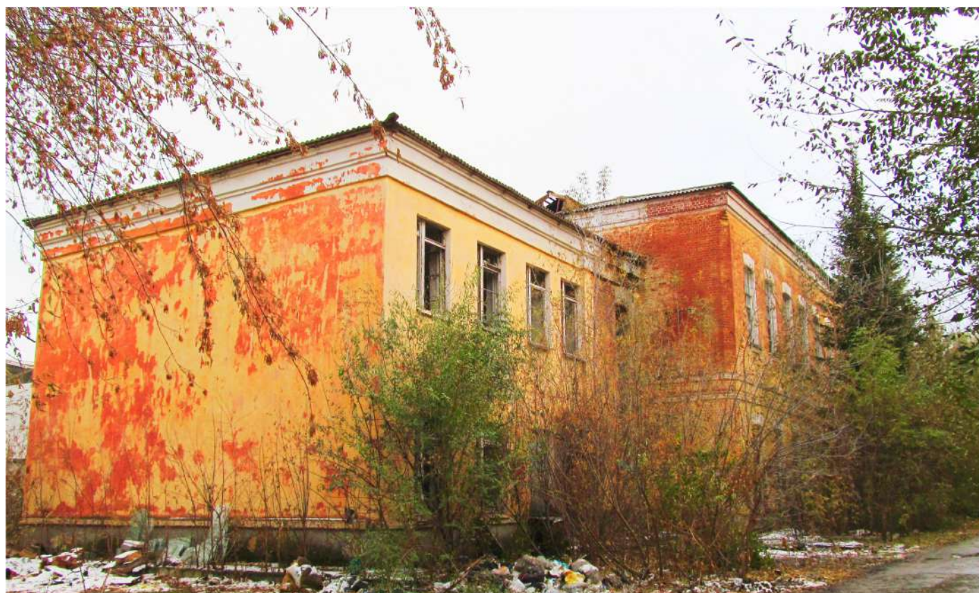
Рис. 3 Вид на северо-восточный фасад здания бывшей казармы (Лит. 18)
