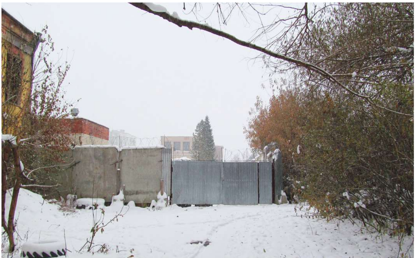
Рис. 104 Вид на местоположение здания бывшей казармы (Лит. А) с севера со стороны дворовой территории
