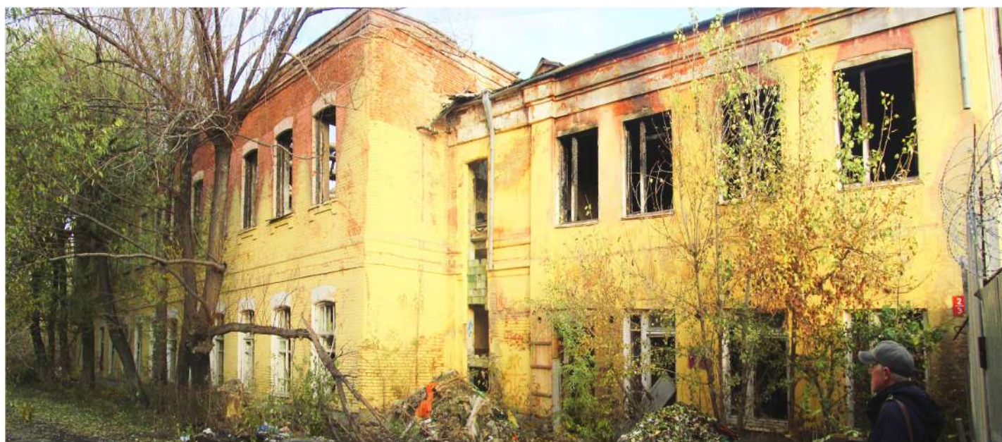
Рис. 31 Вид на юго-восточный фасад здания бывшей казармы (Лит. 17)
