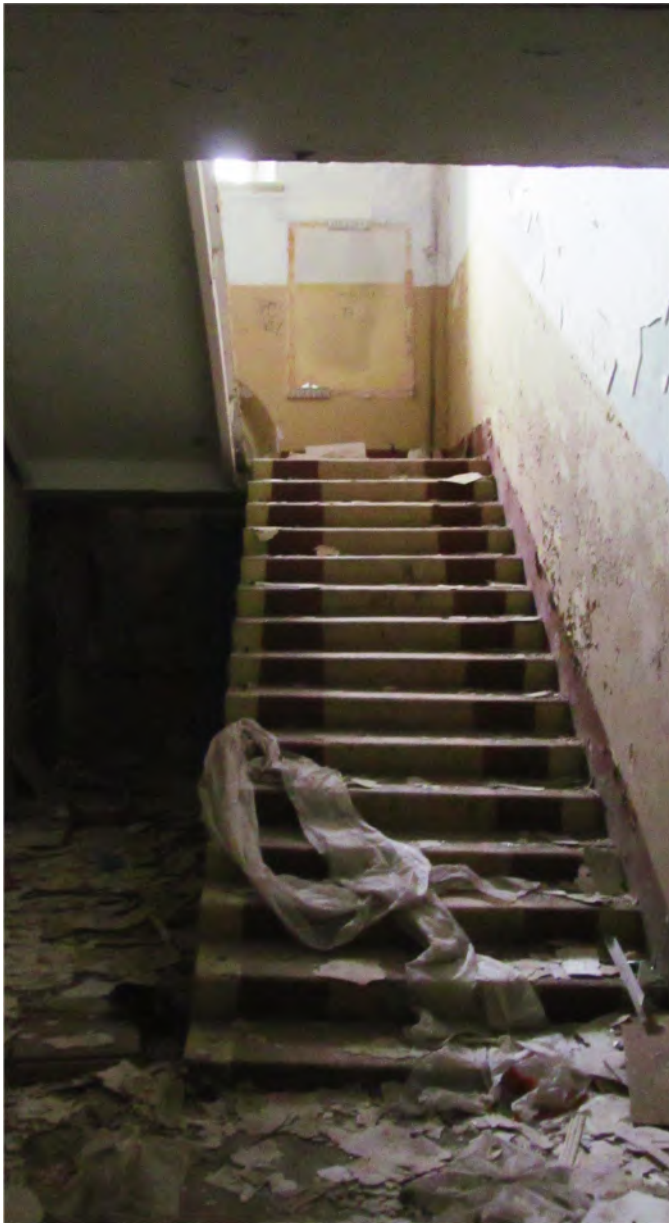
Рис. 94 Вид на лестничную клетку здания бывшего штаба (Лит. 23) с 1-го этажа
