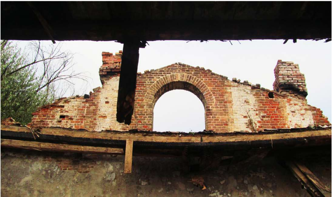
Рис. 58 Вид на фрагмент брандмауэрной стены чердака с аркой для прохода помещения 2-го этажа бывшей казармы (Лит. 17) с юга
