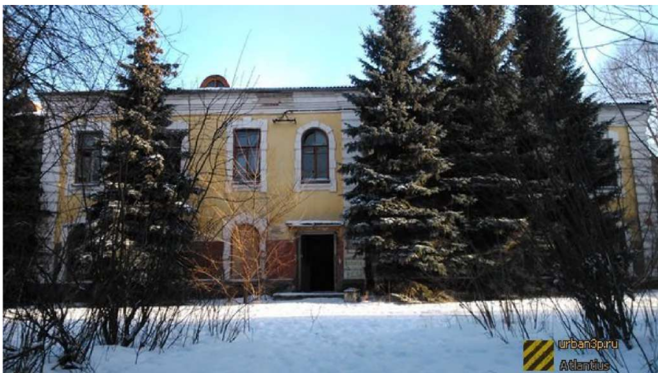
Рис. 40 Здание штаба бывшего Войскового остановочного пункта по ул. Монакова, 1а/5 (Фото – начала 21 века). Ссылка: http://img04.urban3p.ru/up/o/6536/gallery/424007.jpg .
