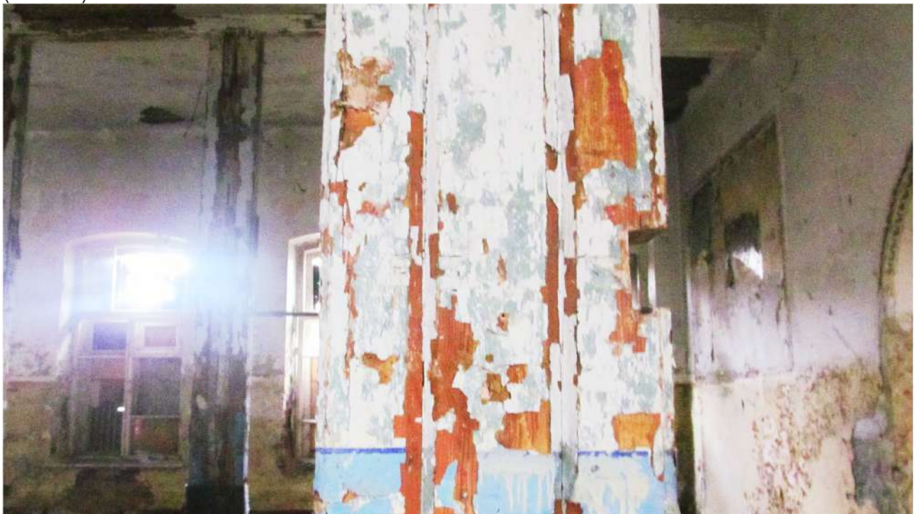
Рис. 26 Вид на деревянную колонну помещения бывшей казармы (Лит. 18)
