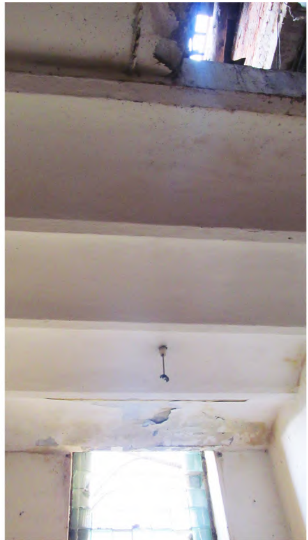
Рис. 53 Вид на своды Манье северной лестничной клетки бывшей казармы (Лит. 17)
