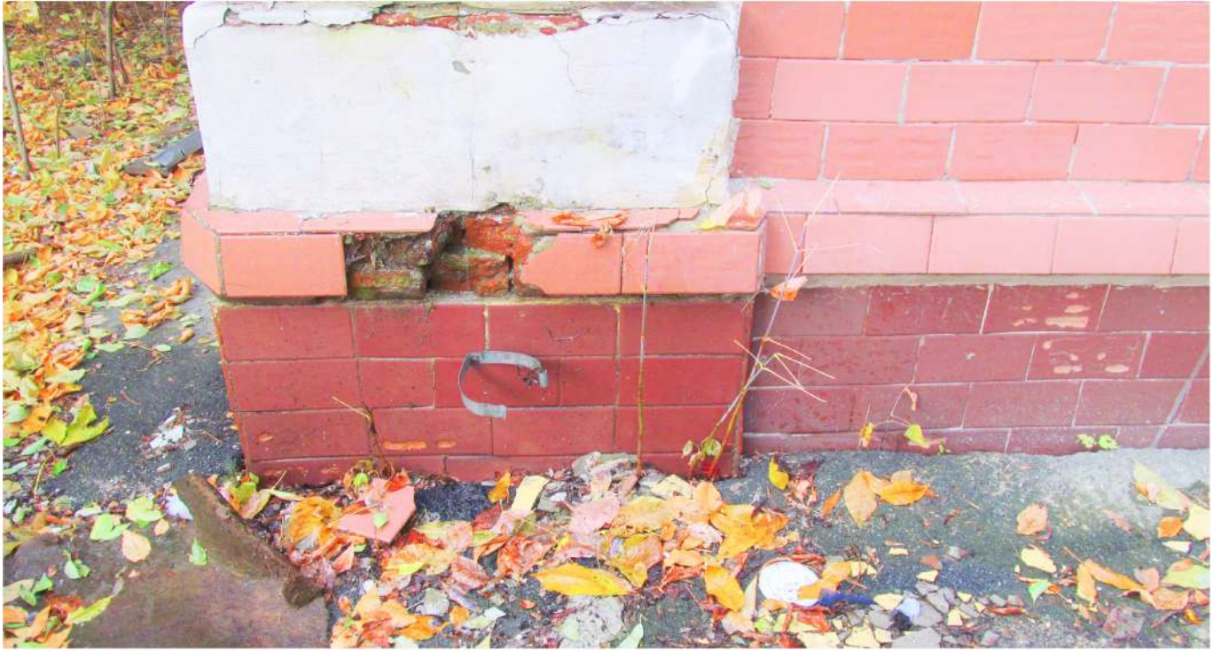
Рис. 86 Вид на цоколь южного фасада здания бывшего штаба (Лит. 23)
