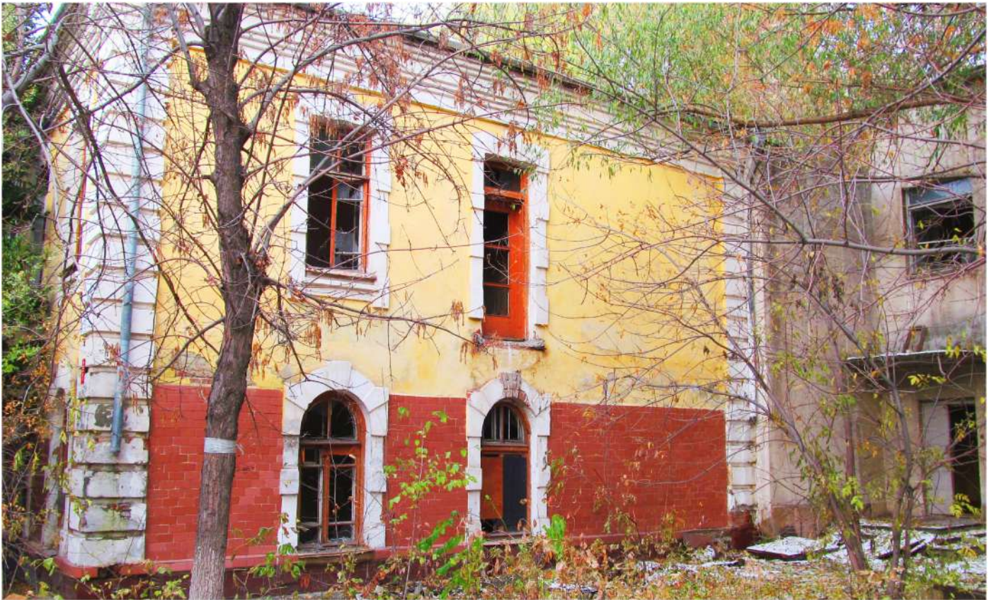
Рис. 75 Вид на южный фасад здания бывшего штаба (Лит. 23)
