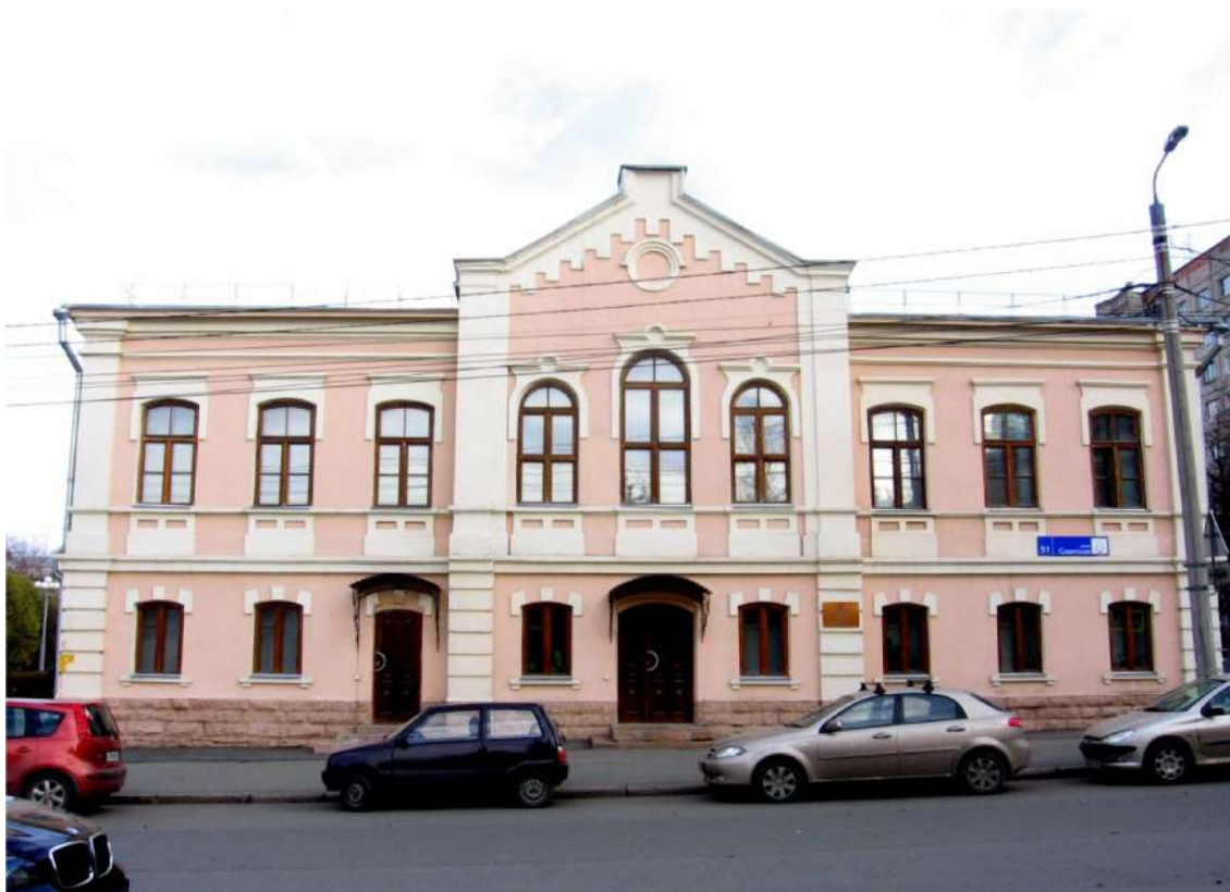
Рис. 34 «Первое приходское училище» по ул. Советской, 51 (кон. 1860-х гг.). Схожая схема построения фасада: ризалит с центральным входом, лопатки на углах здания, на первом этаже под руст, также как на казармах, арочные окна с выделенными замками и угловыми камнями на 1-ом этаже, так же как и на здании штаба, уступчатый карниз.
