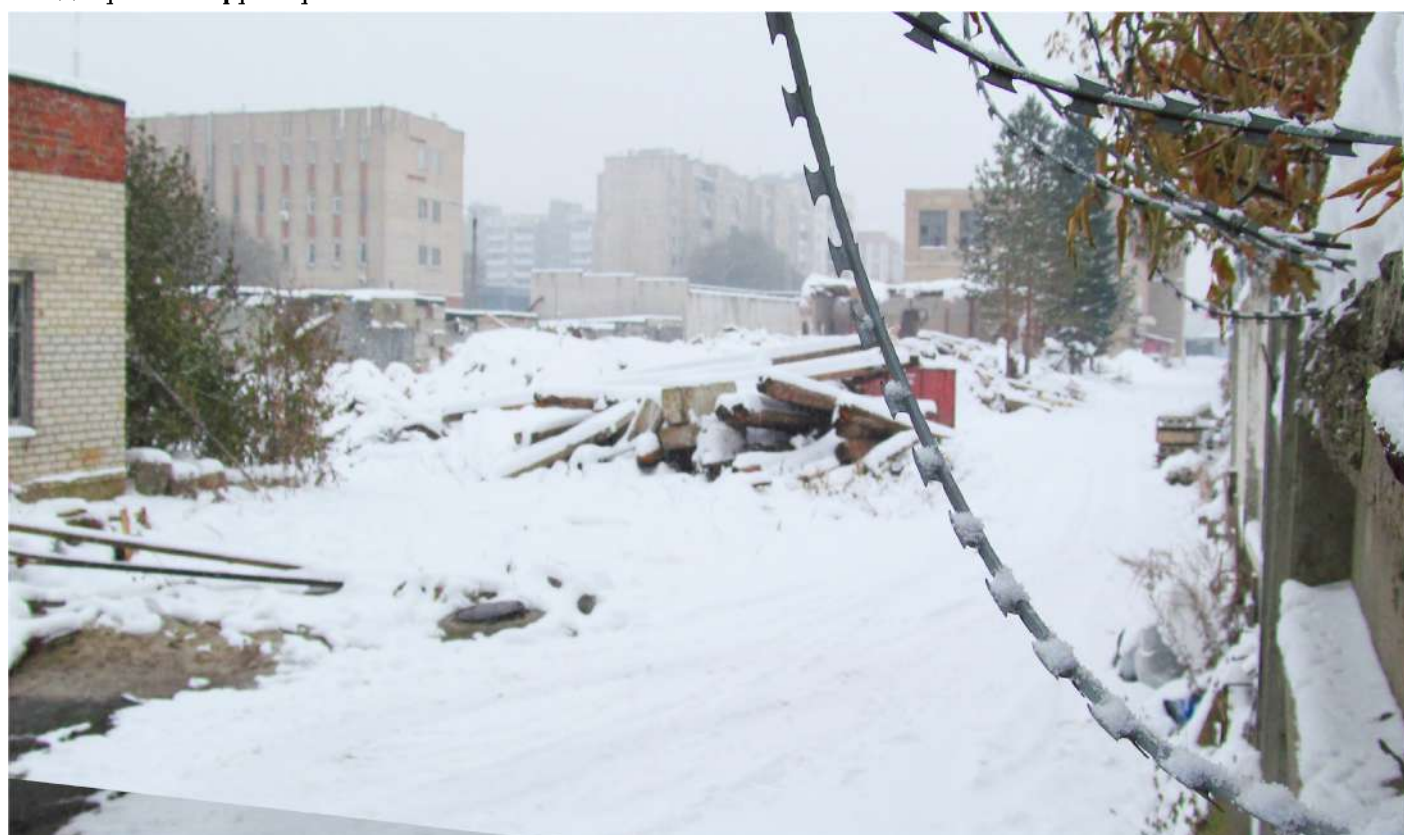
Рис. 106 Вид на местоположение здания бывшей казармы (Лит. А) с северо-запада со стороны дворовой территории
