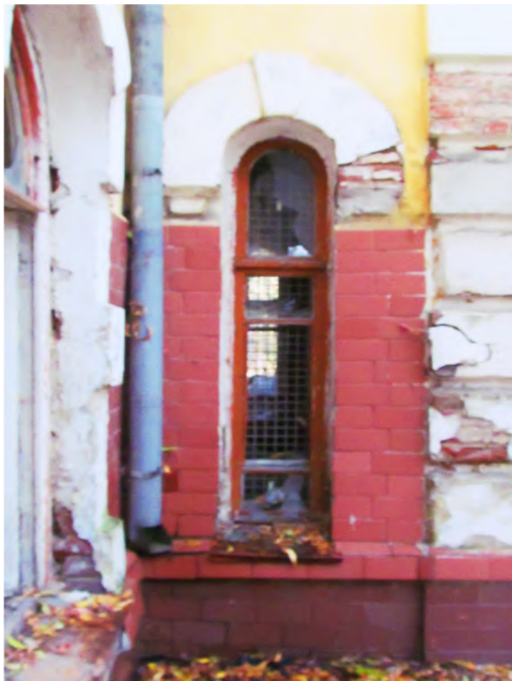
Рис. 81 Вид на боковое южное окно 1-го этажа ризалита западного фасада здания бывшего штаба (Лит. 23)
