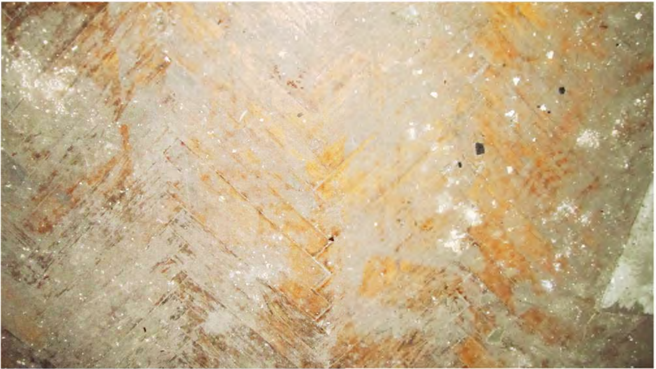
Рис. 89 Вид на сохранившийся паркет интерьера здания бывшего штаба (Лит. 23)
