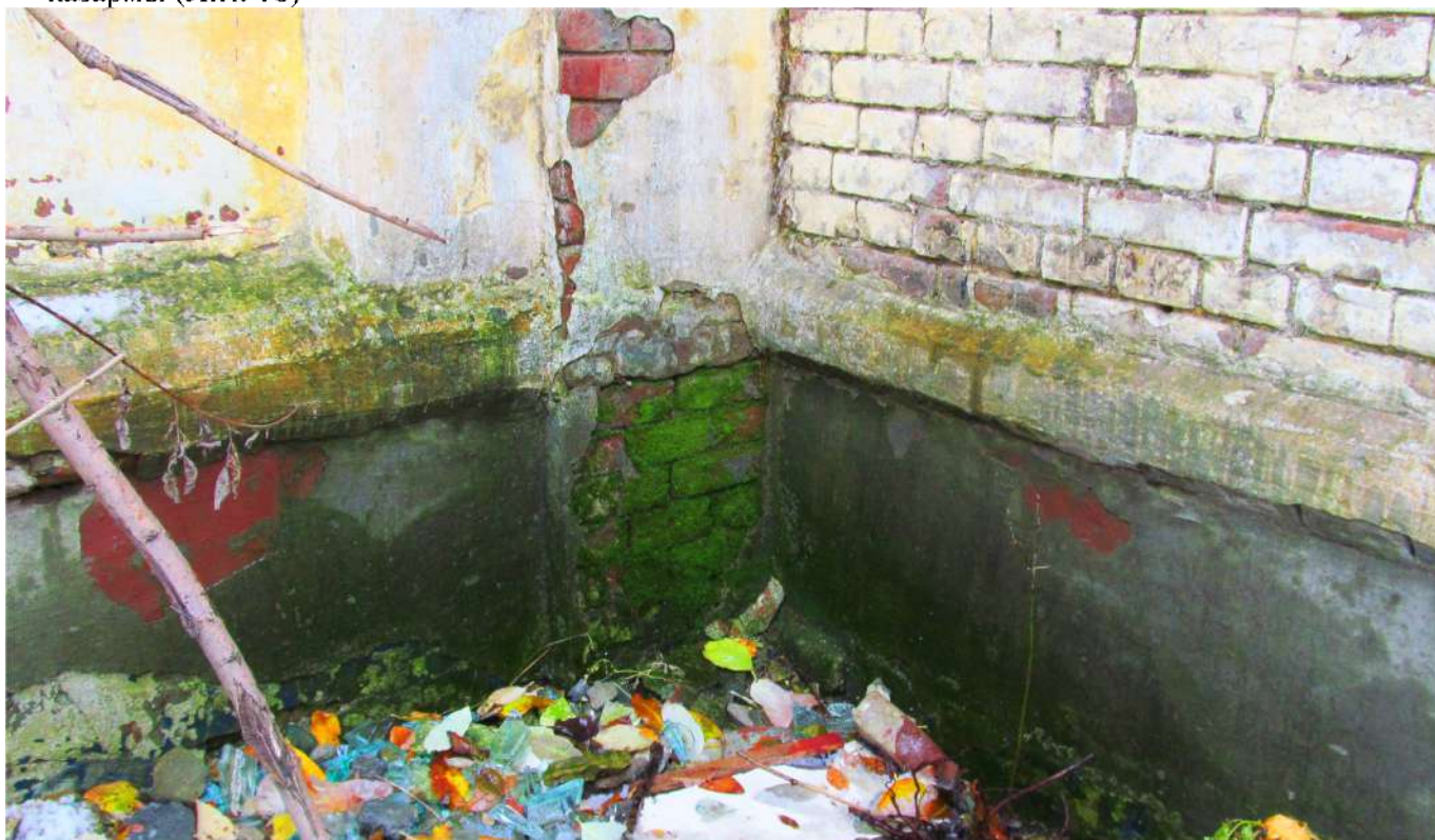
Рис. 14 Вид на цоколь восточного фасада здания бывшей казармы (Лит. 18)
