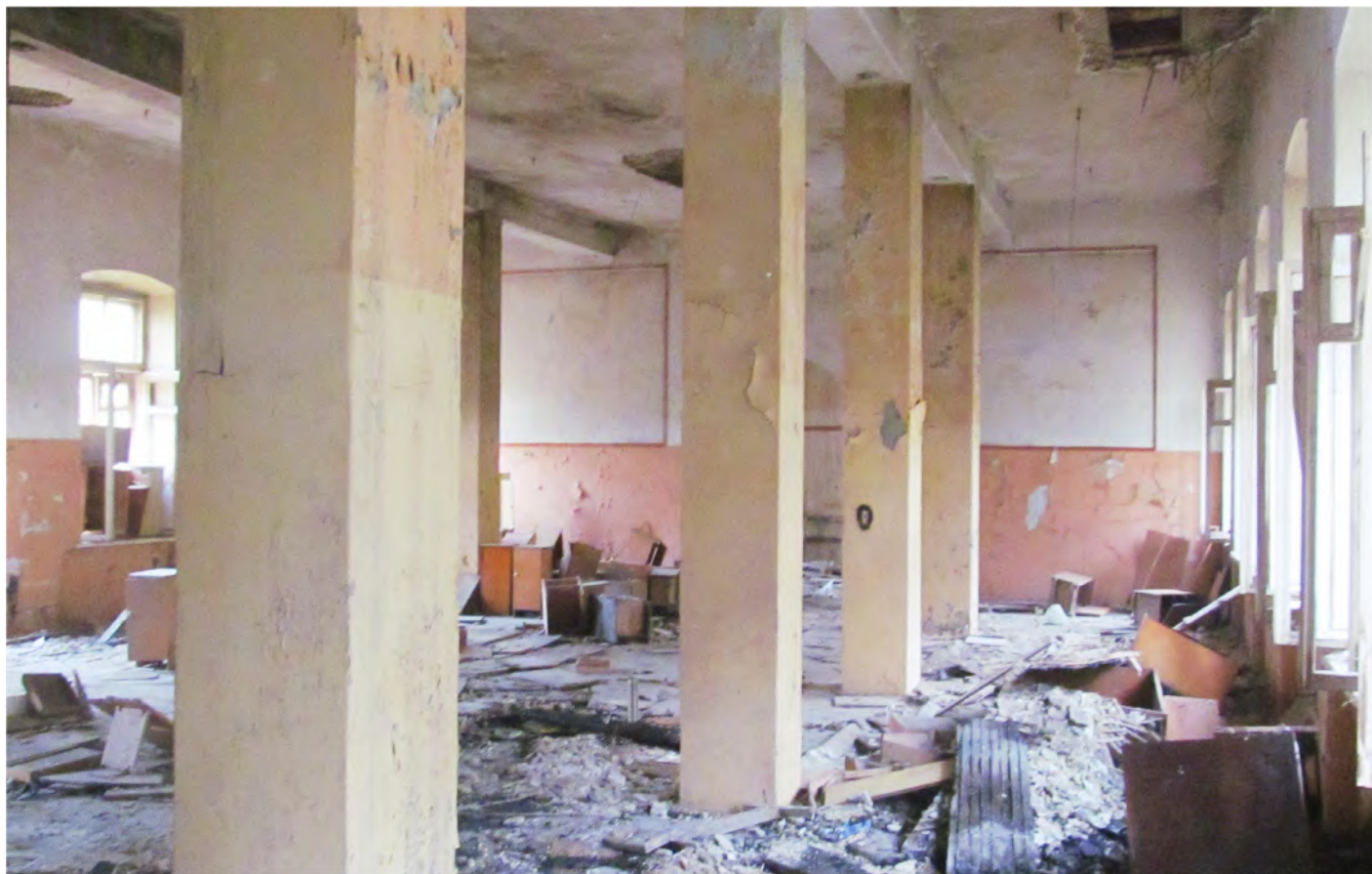
Рис. 48 Вид на интерьер помещения бывшей казармы (Лит. 17)
