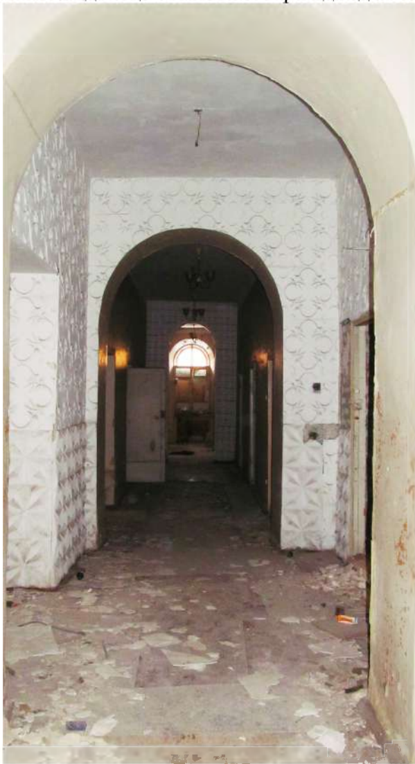
Рис. 87 Вид на коридор 1-го этажа здания бывшего штаба (Лит. 23) с юга
