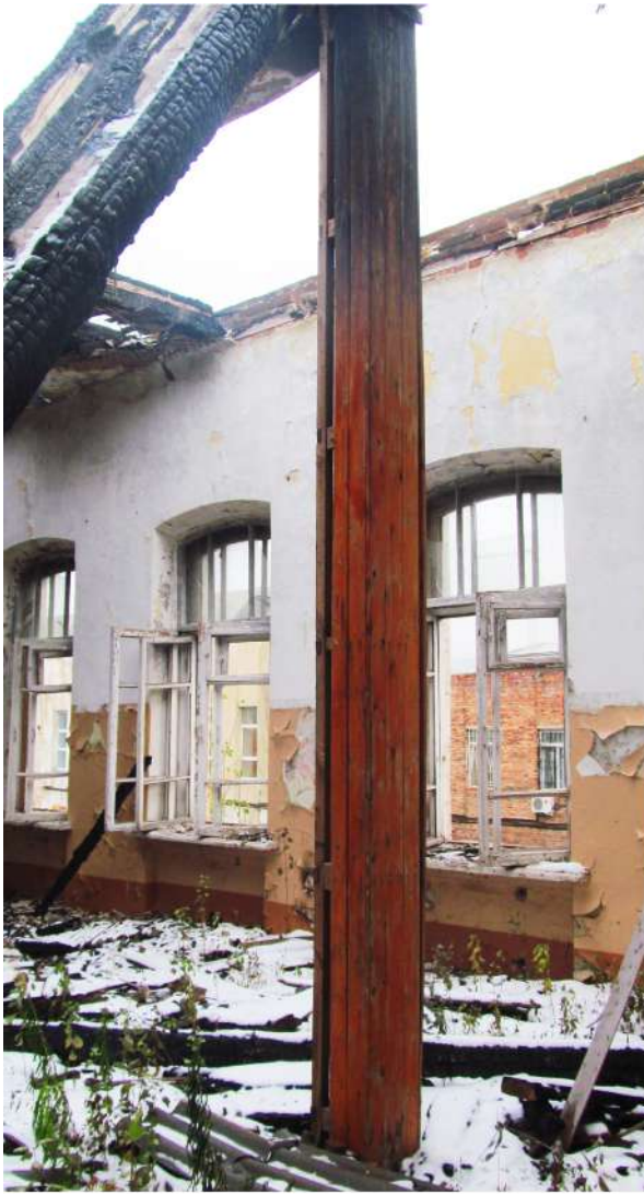
Рис. 64 Вид на колонну помещения 2-го этажа бывшей казармы (Лит. 17)
