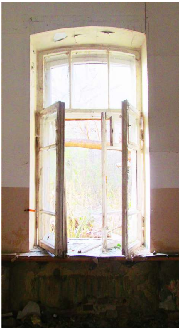
Рис. 45 Вид на оконный проем помещения бывшей казармы (Лит. 17)
