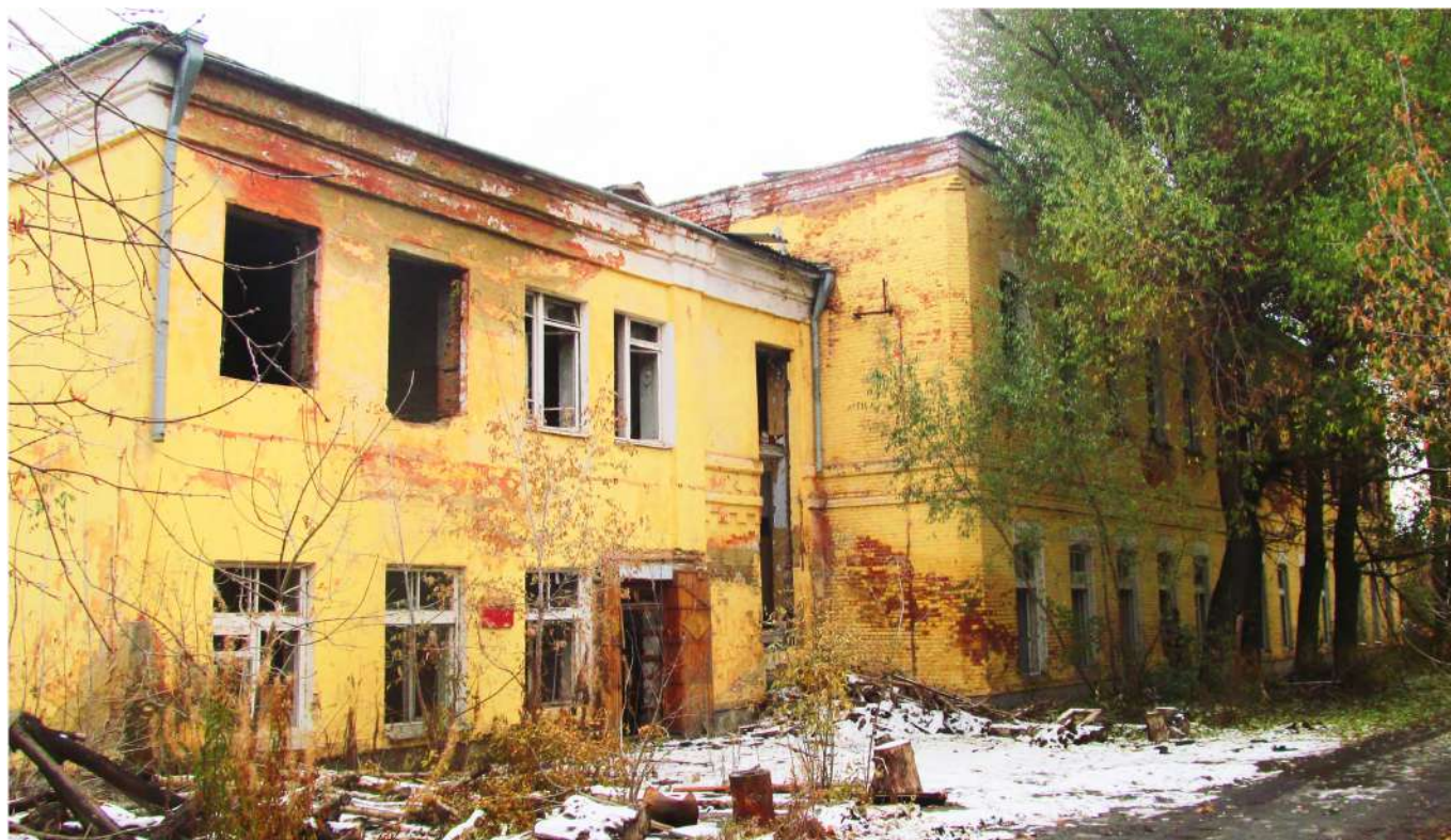
Рис. 32 Вид на северо-восточный фасад здания бывшей казармы (Лит. 17)
