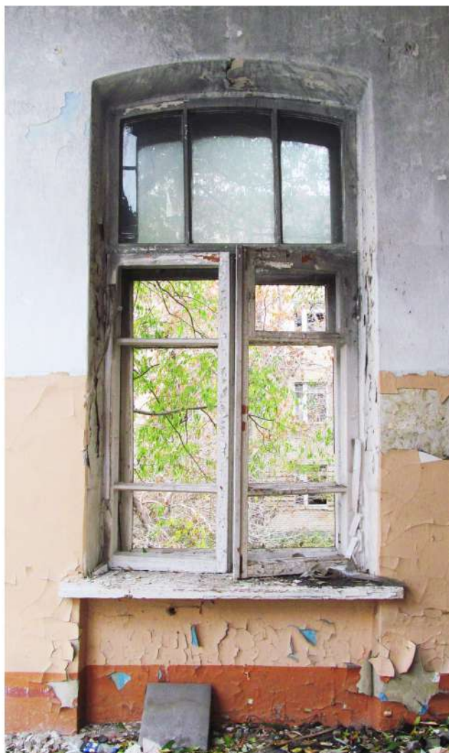
Рис. 60 Вид на оконный проем помещения 2-го этажа бывшей казармы (Лит. 17)
