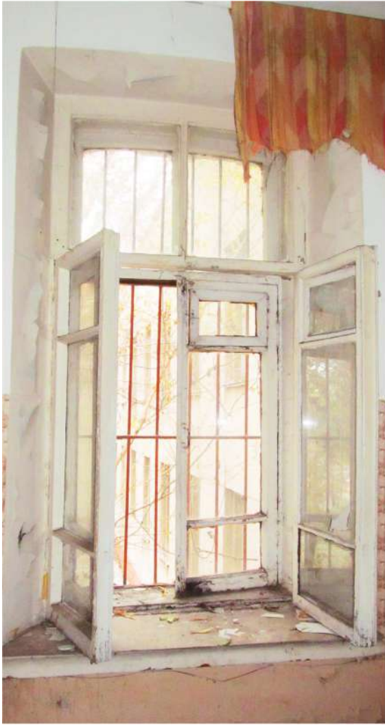
Рис. 100 Вид на оконный проем помещения 2-го этажа здания бывшего штаба (Лит. 23)
