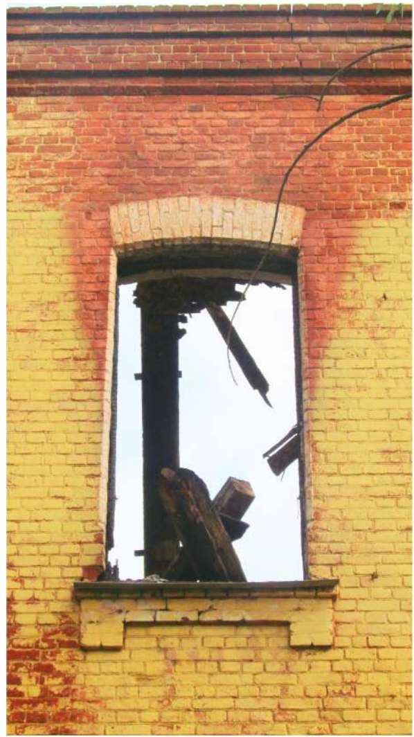
Рис. 40 Вид на окно второго этажа восточного фасада здания бывшей казармы (Лит. 17)
