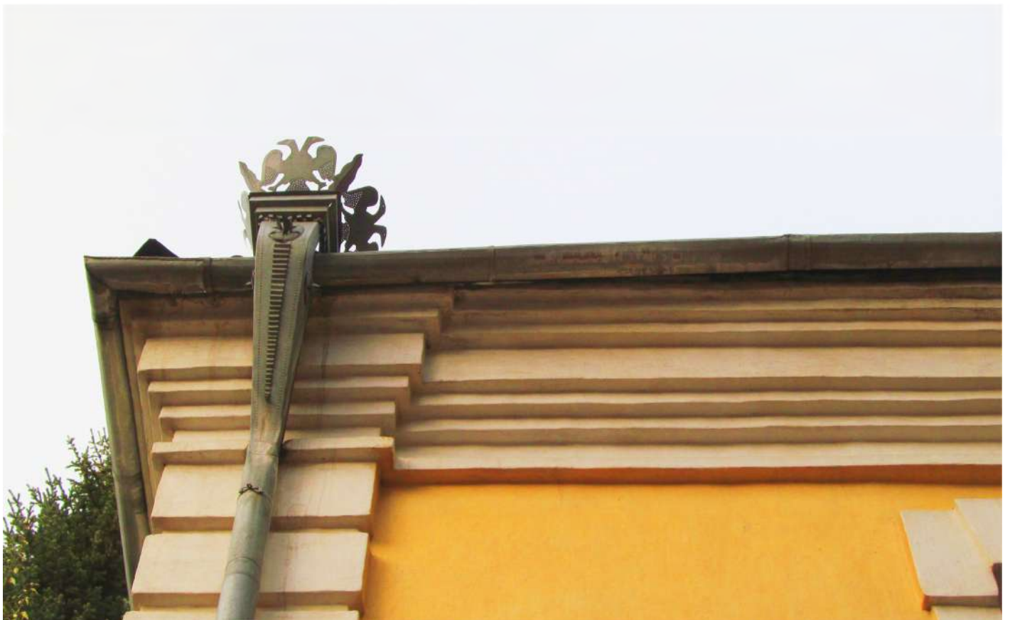
Рис. 85 Вид на карнизную зону южного фасада здания бывшего штаба (Лит. 23)
