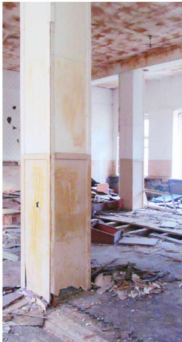
Рис. 46 Вид на колонну помещения бывшей казармы (Лит. 17)
