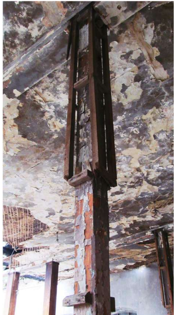
Рис. 65 Вид на колонну помещения 2-го этажа бывшей казармы (Лит. 17)
