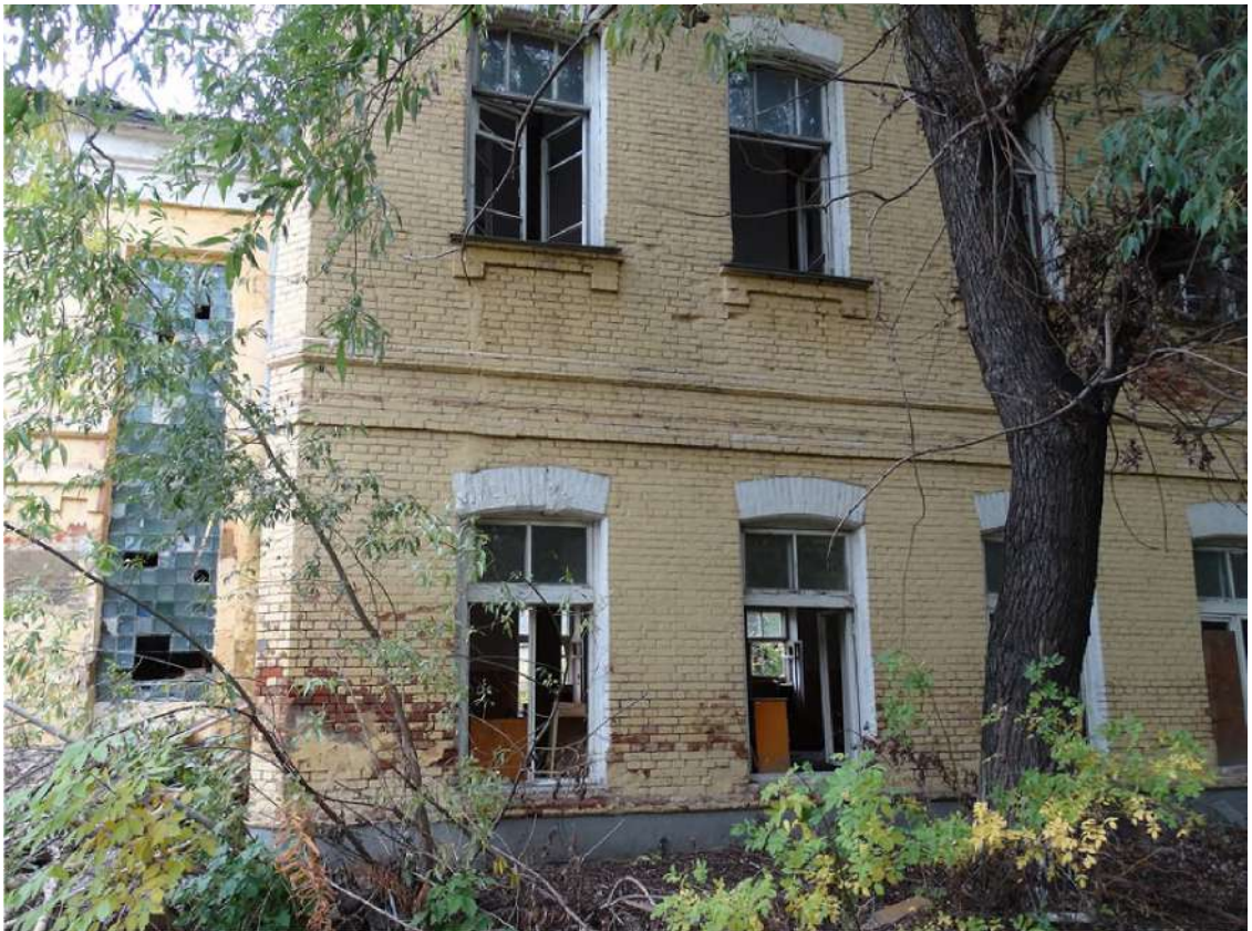
Рис. 50 Фрагмент фасада здания Казармы № 2 бывшего Войскового остановочного пункта по ул. Монакова, 1а/3 (Фото - сентябрь 2014 г., автор – Ю.В. Латышев). Ссылка: http://img-fotki.yandex.ru/get/4807/5661614.89/0_a7ea7_15e96d58_XL.jpg .
