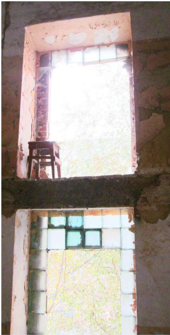
Рис. 27 Вид на оконные проемы северной лестничной клетки бывшей казармы (Лит. 18)
