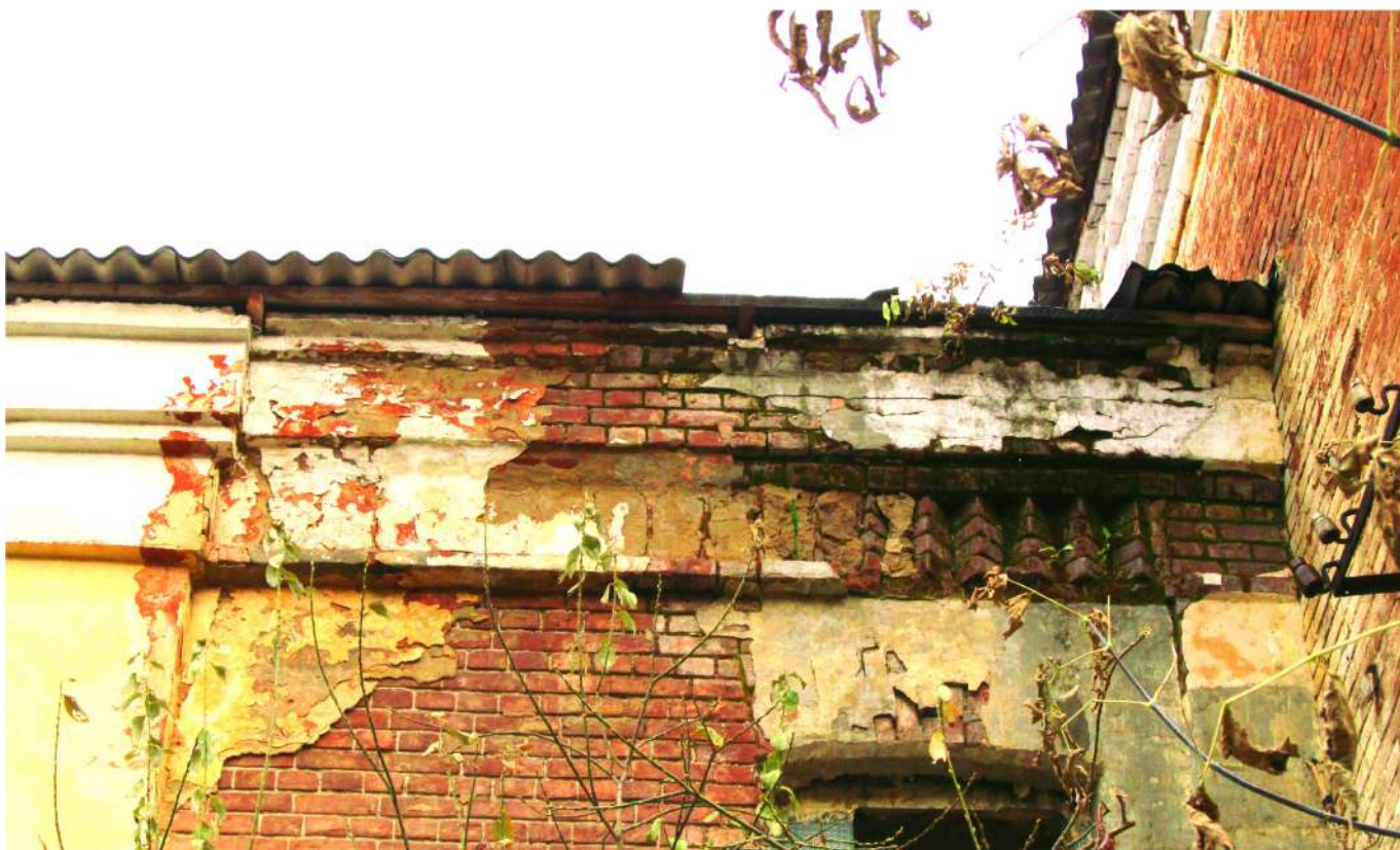
Рис. 13 Вид на карнизную зону восточного фасада северного пристроя здания бывшей казармы (Лит. 18)
