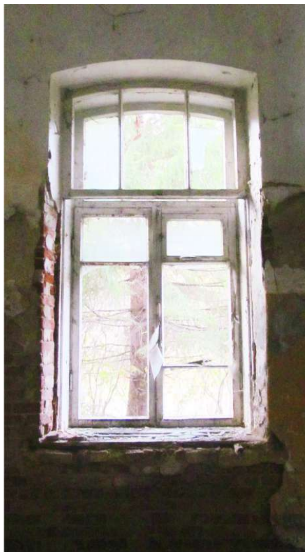
Рис. 20 Вид на оконный проем помещения бывшей казармы (Лит. 18)
