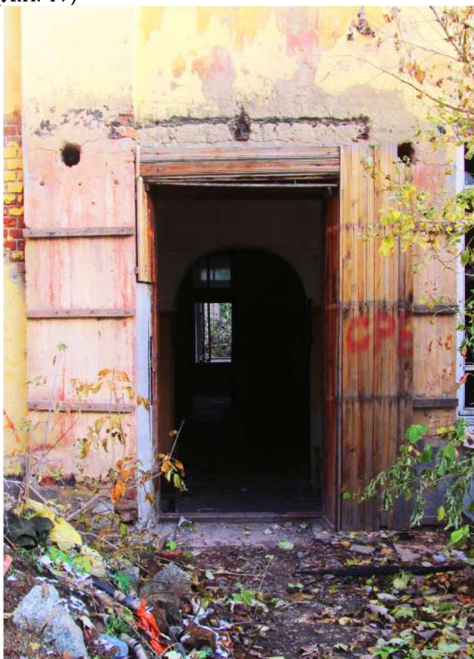
Рис. 35 Вид на южный вход в здание бывшей казармы (Лит. 17)
