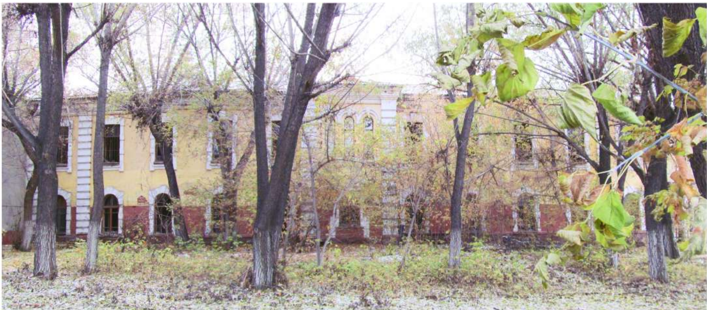
Рис. 73 Вид на западный фасад здания бывшего штаба (Лит. 23)
