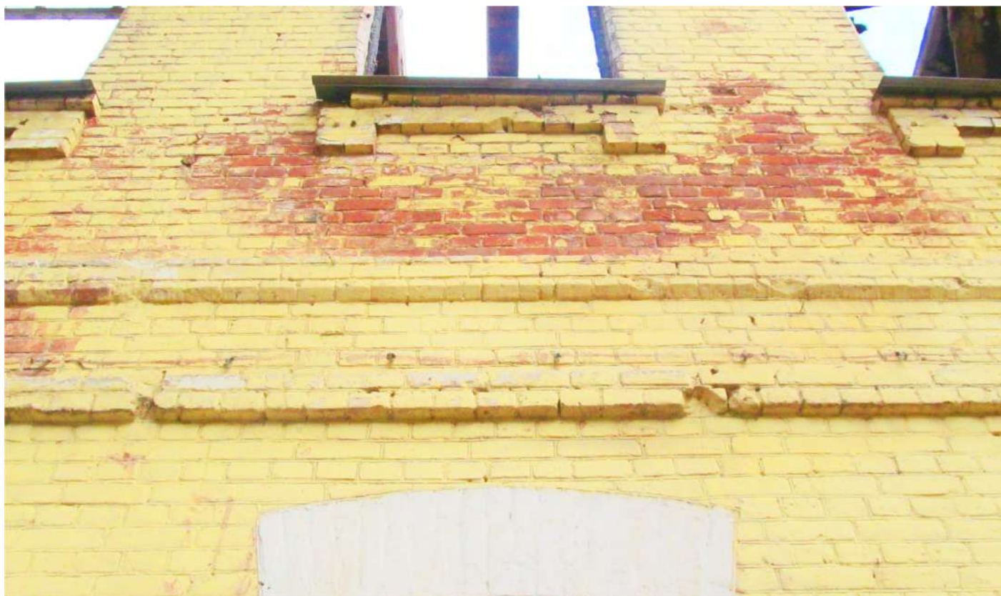
Рис. 37 Вид на декоративное оформление стены восточного фасада здания бывшей казармы (Лит. 17)
