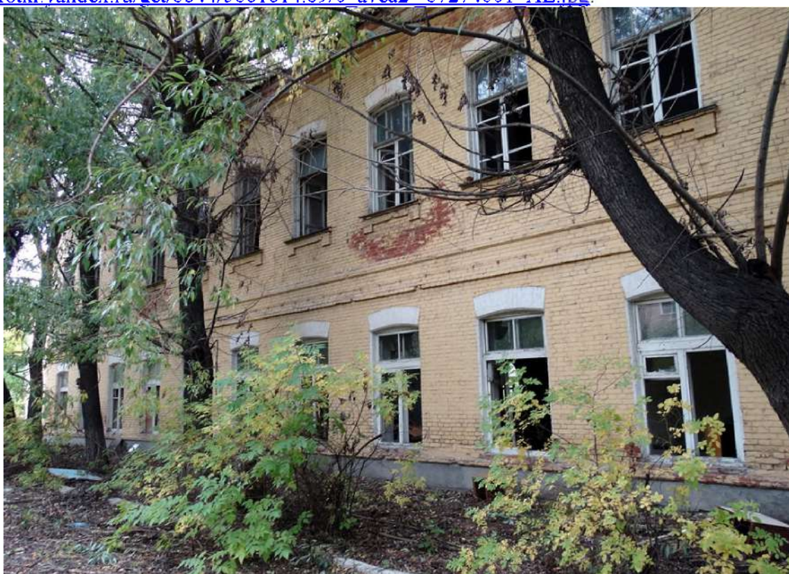
Рис. 49 Здание Казармы № 2 бывшего Войскового остановочного пункта по ул. Монакова, 1а/3 (Фото - сентябрь 2014 г., автор – Ю.В. Латышев). Ссылка: http://img-fotki.yandex.ru/get/6845/5661614.89/0_a7ea6_9fbde62e_XL.jpg .
