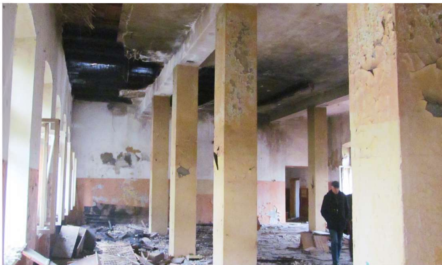
Рис. 49 Вид на интерьер помещения бывшей казармы (Лит. 17)
