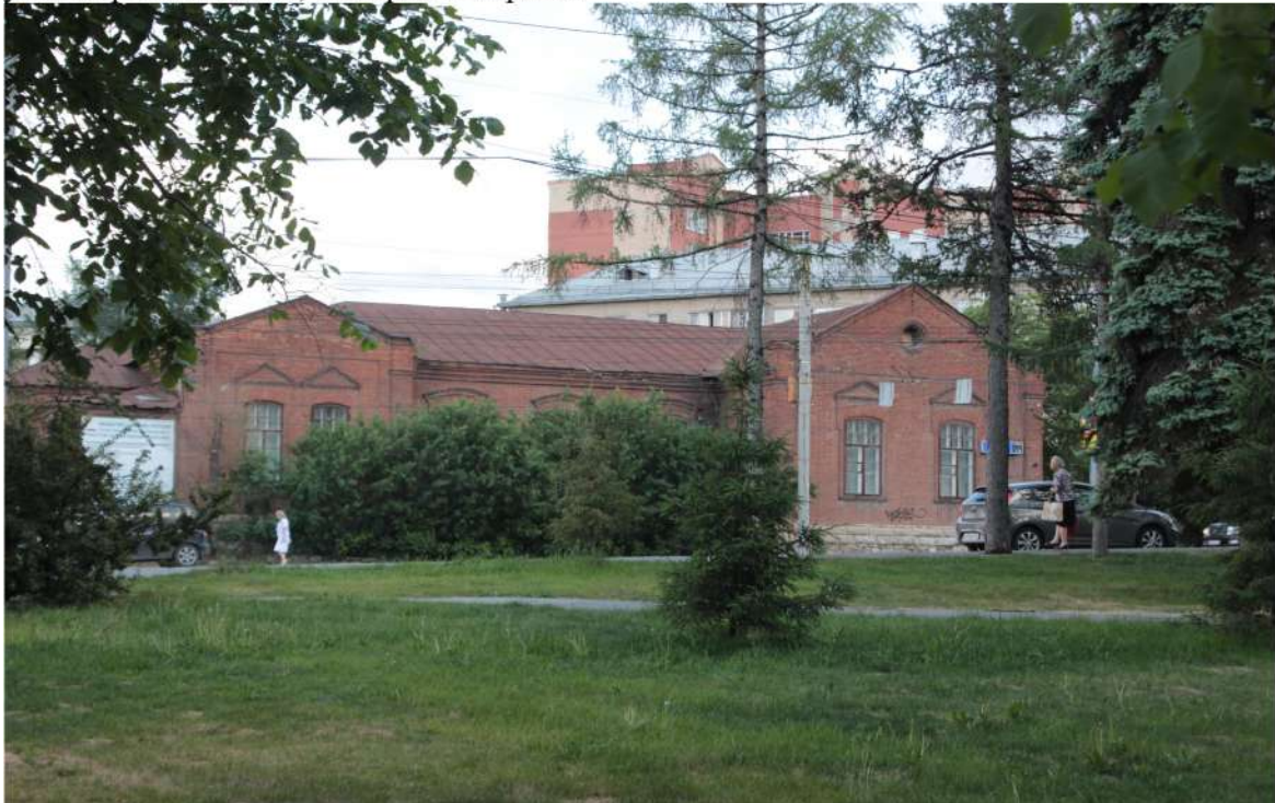
Рис. 33 «Земская школа» по ул. Воровского, 5 (1901 г.). Одноэтажное кирпичное здание смешанного приходского училища. Здание фланкировано лопатками, уступчатый карниз из обломов простой конфигурации. Сдержанный декор, соответствующий казённым постройкам.
