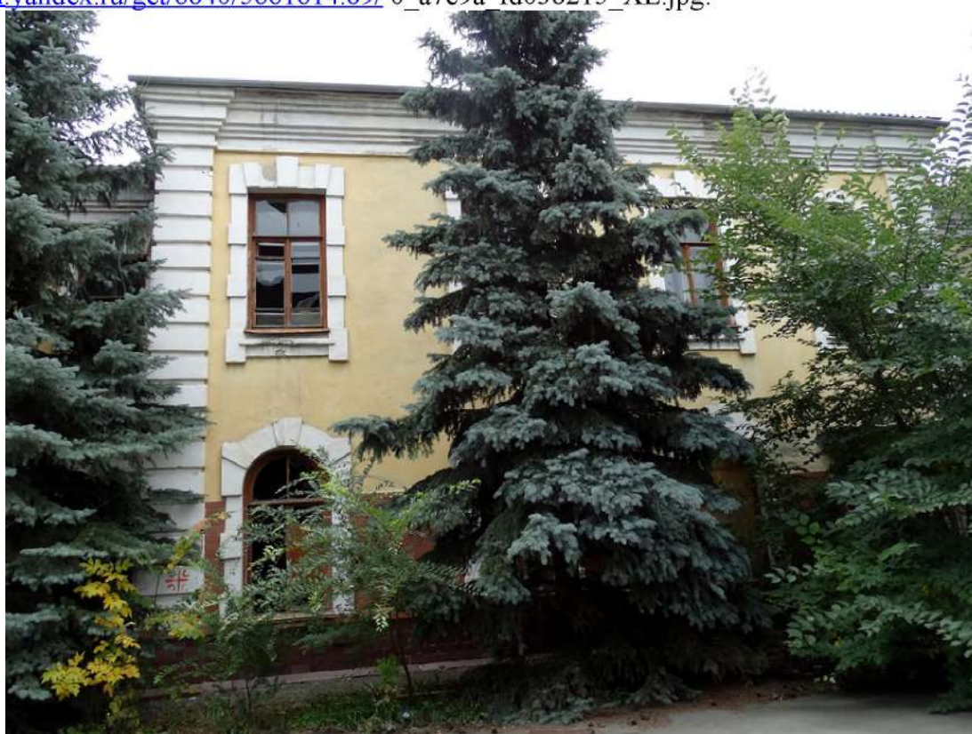
Рис. 43 Здание штаба бывшего Войскового остановочного пункта по ул. Монакова, 1а/5 (Фото - сентябрь 2014 г., автор – Ю.В. Латышев). Ссылка: http://img-fotki.yandex.ru/get/6743/5661614.89/0_a7e9b_d348de65_XL.jpg .
