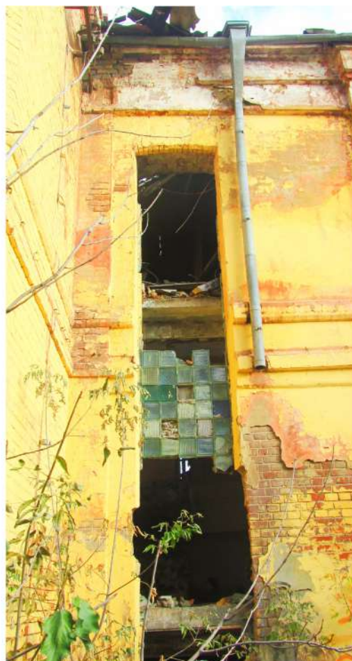
Рис. 36 Вид на лестничную клетку южного пристроя здания бывшей казармы (Лит. 17)
