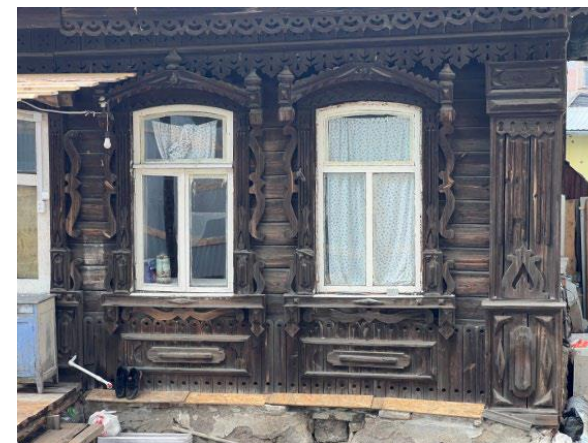
Оформление оконных проемов восточного фасада
