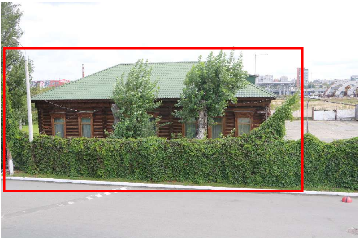
Фото. 4. Объект культурного наследия, ограждение территории («живая» изгородь), вид с западного направления
