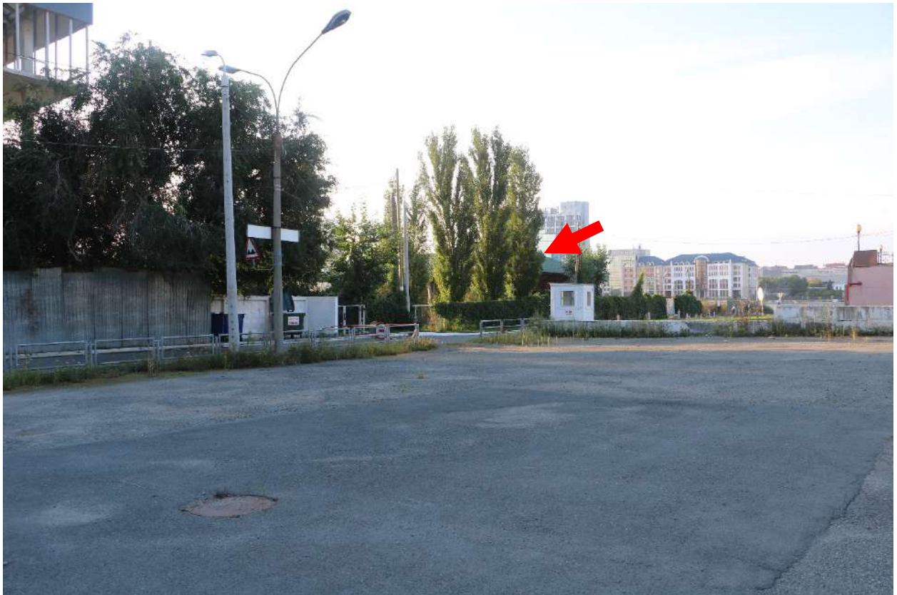
Фото. 15. Вид в направлении Объекта культурного наследия с северо-запада
