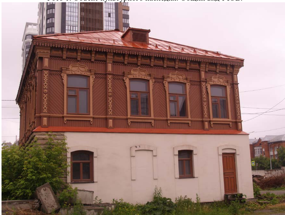
Фото 2. Объект культурного наследия. Общий вид с С.
