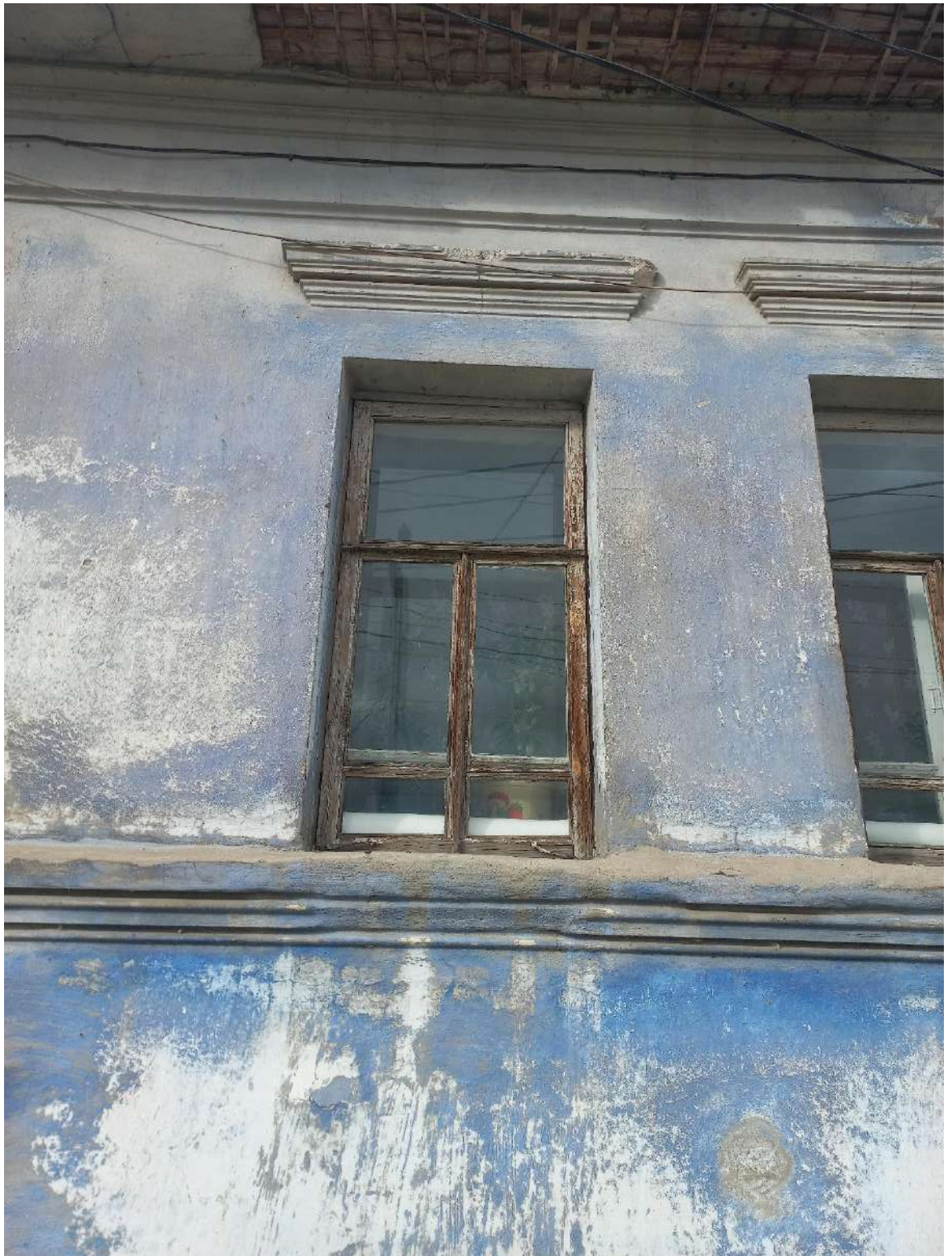
10. Оконный проем с заполнением. Подоконная профилированная тяга. Сандрик. Октябрь 2023 г.
