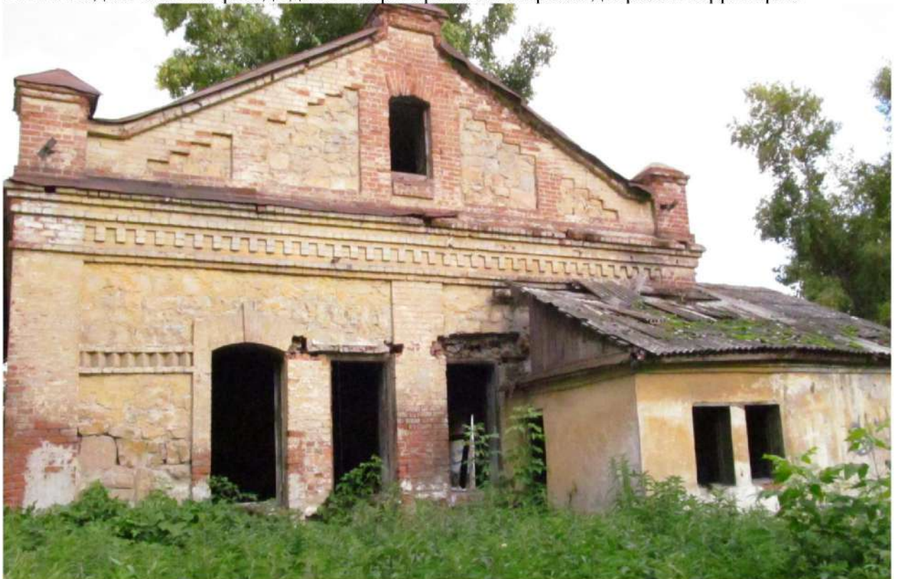
Рис. 9 Вид на западный фасад здания с пристроем со стороны дворовой территории
