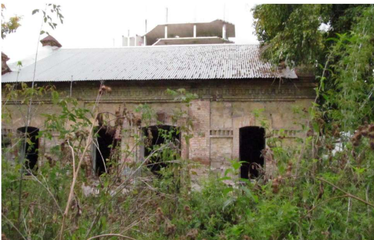
Рис. 7 Вид на южный фасад здания со стороны дворовой территории
