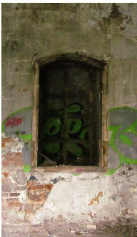
Рис. 37 Вид на заложенный оконный проем северной стены основного помещения здания
