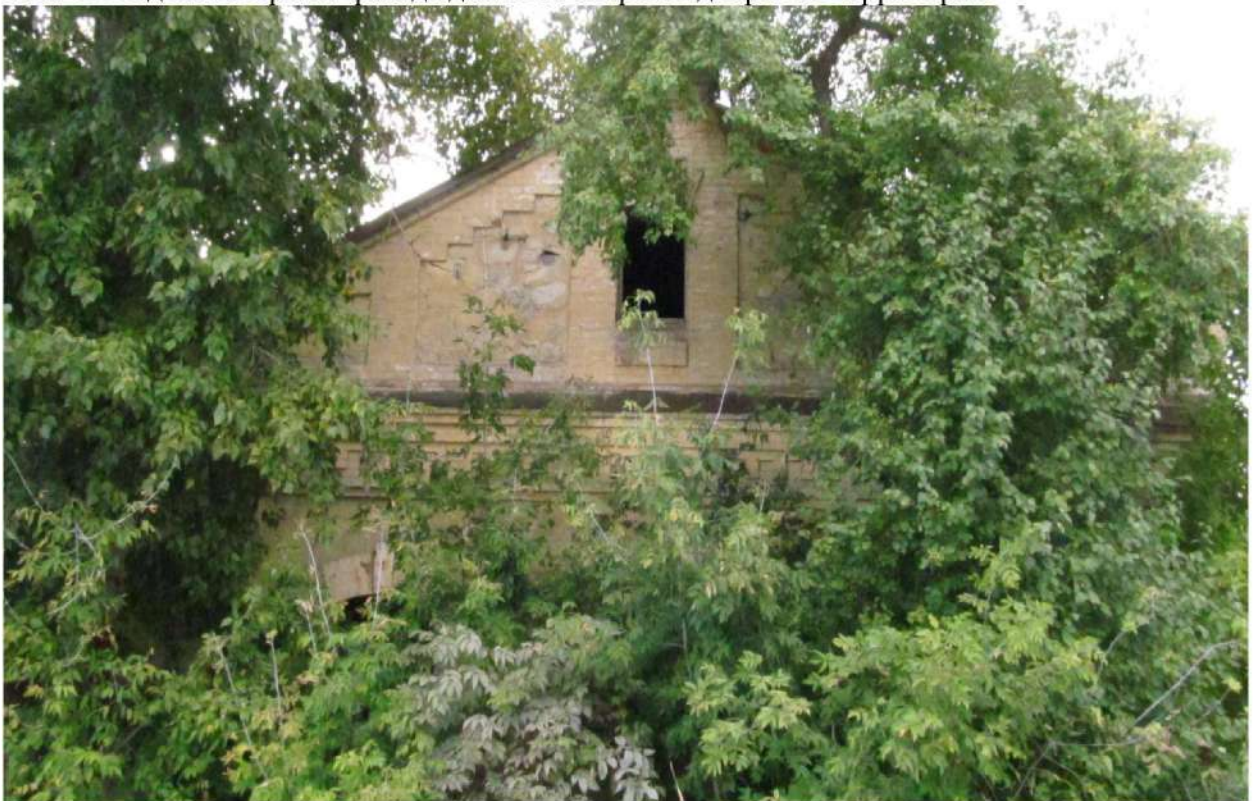
Рис. 11 Вид на чердачную часть главного фасада здания со стороны ул. Свободы
