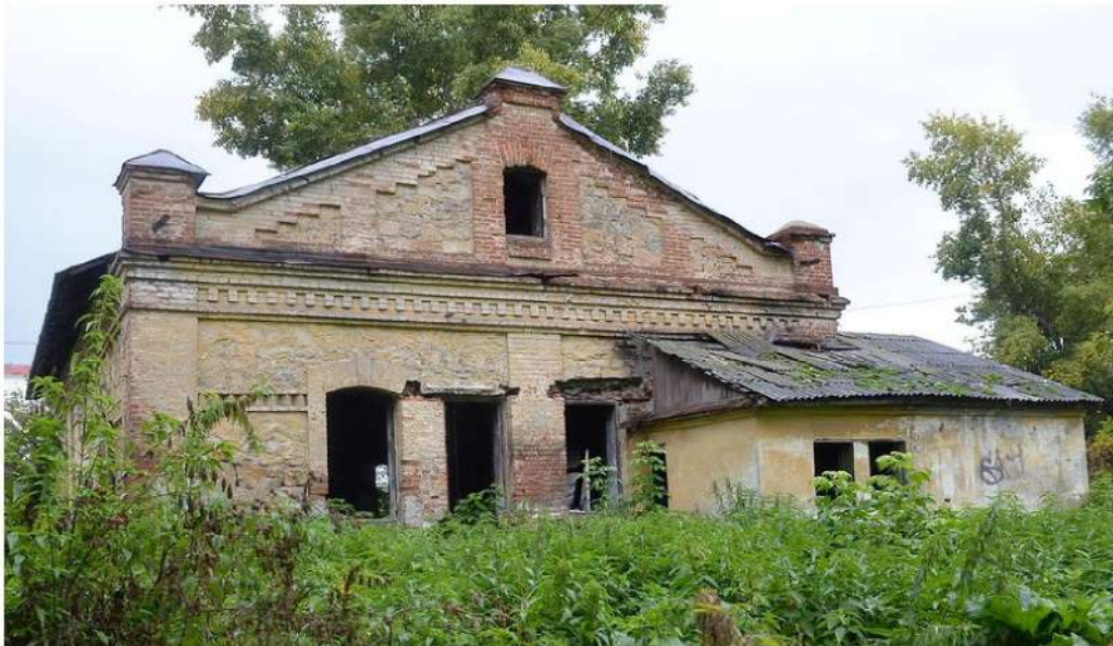
Рис. 54 Западный фасад здания бывшей насосной (водокачки) водопровода железной дороги по ул.Свободы, 6 (Фото - 2016 г.). Ссылка: https://img-fotki.yandex.ru/get/50388/130498157.48/0_189ddc_bc57e84c_XXL.jpg .
