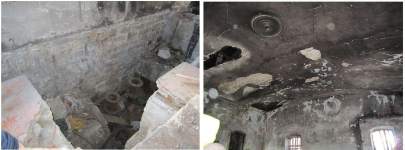
Рис. 49 Интерьеры и остатки оборудования здания бывшей насосной (водокачки) водопровода «Златоусто-Челябинской» железной дороги (участка Самаро-Златоустовской железной дороги) по ул.Свободы, 6 (Фото – апрель, 2015 г.). Ссылки: http://cs622016.vk.me/v622016824/35193/POjw-QZUrGs.jpg , http://cs622016.vk.me/v622016824/3519c/YuhBtW7yTdE.jpg .
