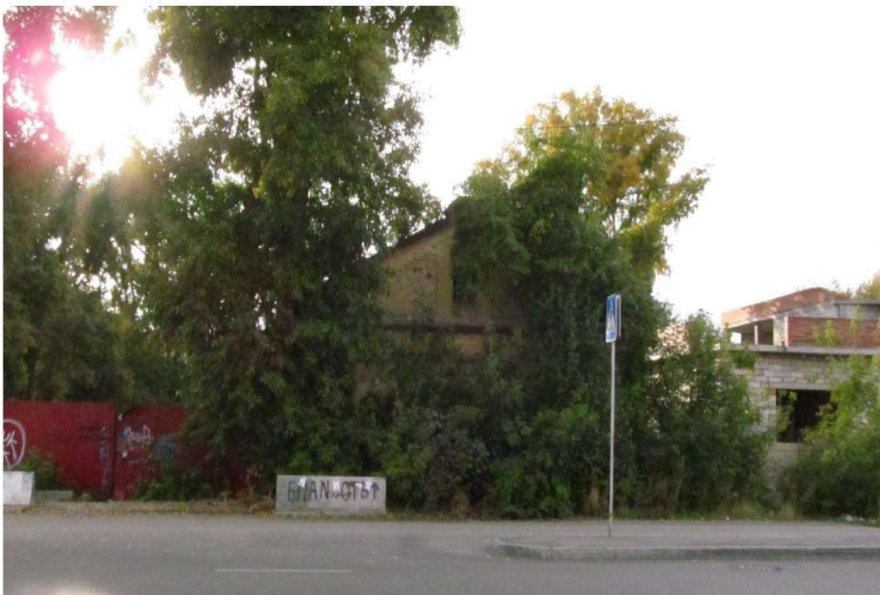
Рис. 6 Вид на главный фасад здания со стороны ул. Свободы
