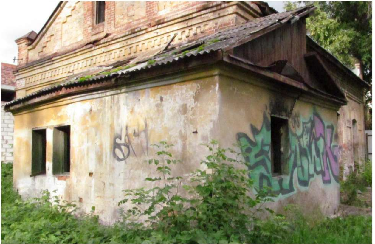
Рис. 14 Вид на юго-западную угловую часть пристроя здания со стороны дворовой территории
