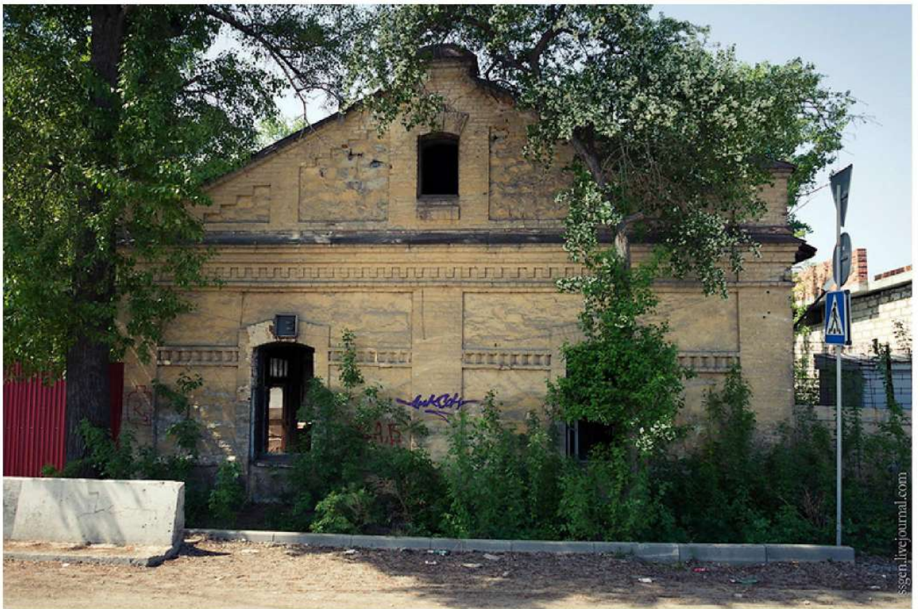
Рис. 38 Главный (восточный) фасад здания бывшей насосной (водокачки) водопровода «Златоусто-Челябинской» железной дороги (участка Самаро-Златоустовской железной дороги) по ул.Свободы,6 (Фото – май, 2014 г). Ссылка: http://img-fotki.yandex.ru/get/9304/674039.703/0_c0242_522f6a12_XL.jpg .
