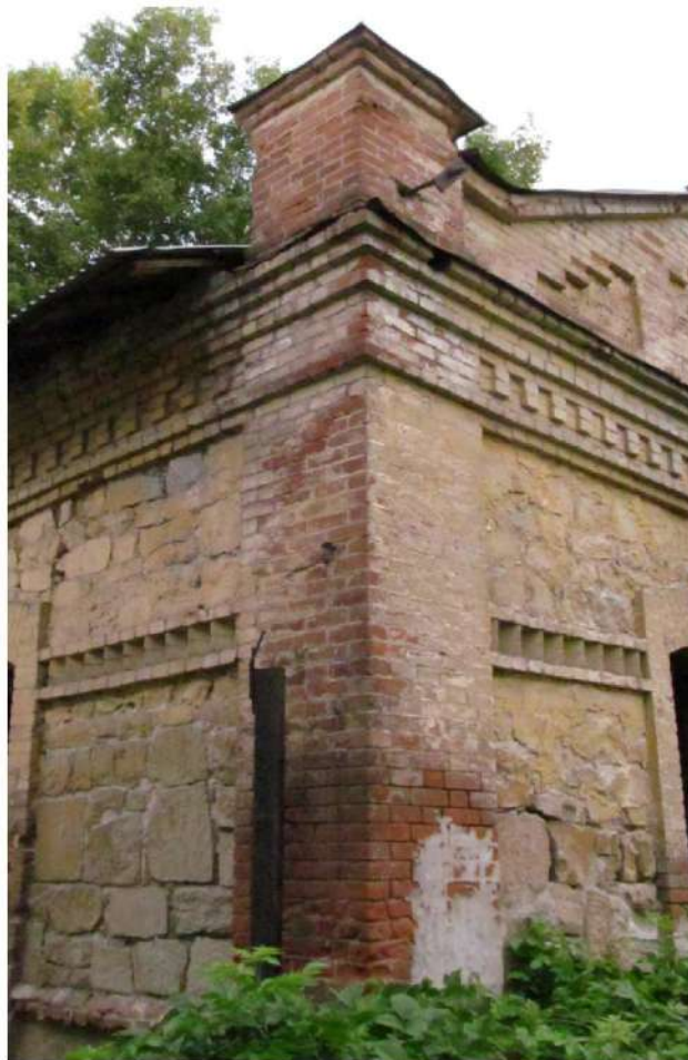
Рис. 16 Вид на угловую пилястру здания с северо-запада
