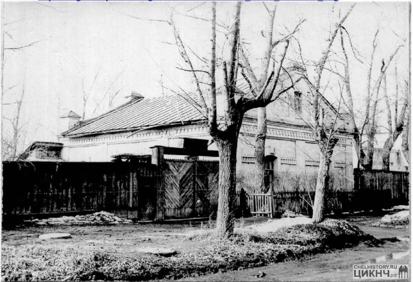
Рис. 35 Здание бывшей водокачки (насосной водопровода) железной дороги (Фото - начала 1990-х гг.)// Фотография с учетной карточкой ЦИКНЧ. Ссылка: https://pp.userapi.com/c630717/v630717914/14c1d/w5awtf7_CkE8.jpg .
