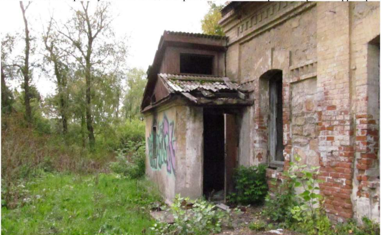
Рис. 13 Вид на юго-восточную угловую часть пристроя здания со стороны дворовой территории
