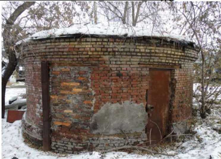
Рис. 47 Здание насосной советского периода (типовой проект) около здания бывшей водоканки «Златоусто-Челябинской» железной дороги по ул.Свободы, 6 (Фото – октябрь, 2014 г.). Ссылка: https://img-fotki.yandex.ru/get/3310/5661614.8e/0_a91e6_2380208a_orig .
