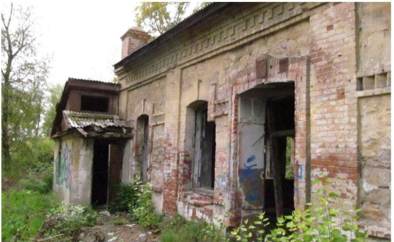
Рис. 8 Вид на южный фасад здания с пристроем со стороны дворовой территории
