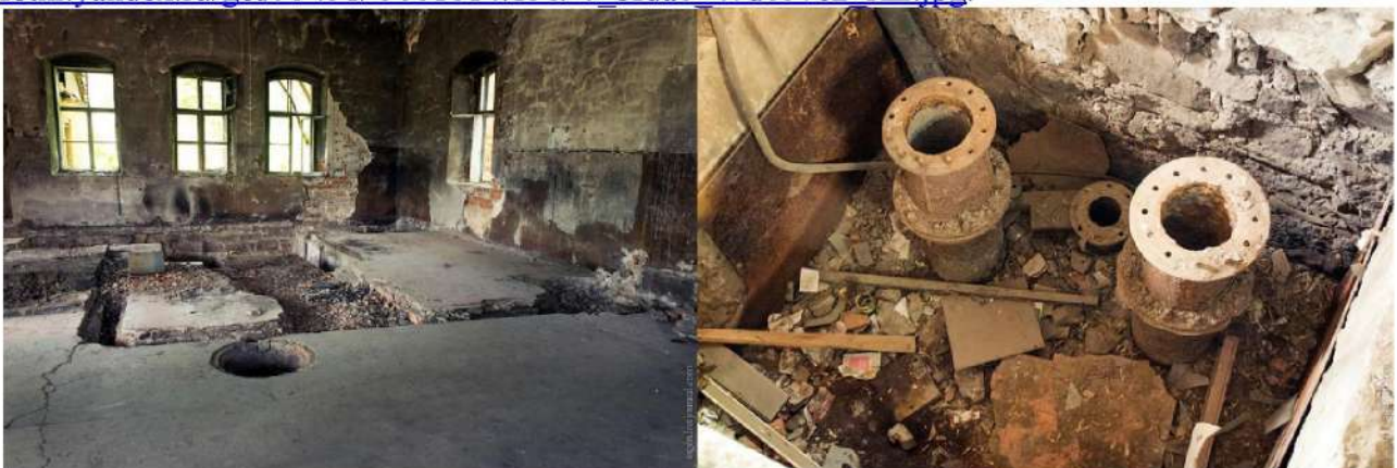
Рис. 56 Интерьеры и остатки оборудования здания бывшей насосной (водокачки) водопровода железной дороги по ул.Свободы, 6 (Фото - 2014 г.). Ссылки: http://img-fotki.yandex.ru/get/9804/674039.703/0_c0248_b31fc742_XL.jpg , http://img-fotki.yandex.ru/get/9804/674039.703/0_c024e_a3eb68b1_XL.jpg .
