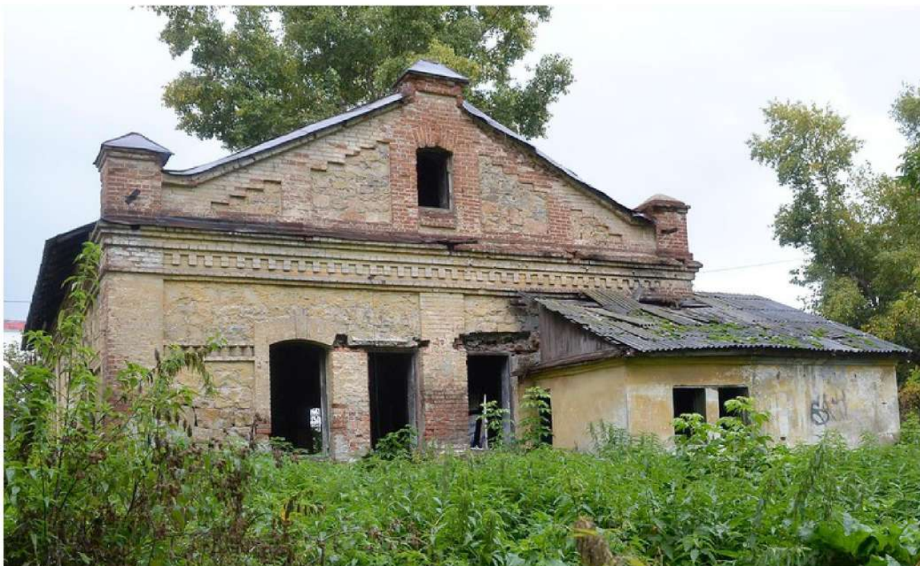
Рис. 50 Западный фасад здания бывшей насосной (водокачки) водопровода «Златоусто-Челябинской» железной дороги (участка Самаро-Златоустовской железной дороги) по ул.Свободы, 6 (Фото - 2016 г.). Ссылка: https://img-fotki.yandex.ru/get/50388/130498157.48/0_189ddc_bc57e84c_XXL.jpg .
