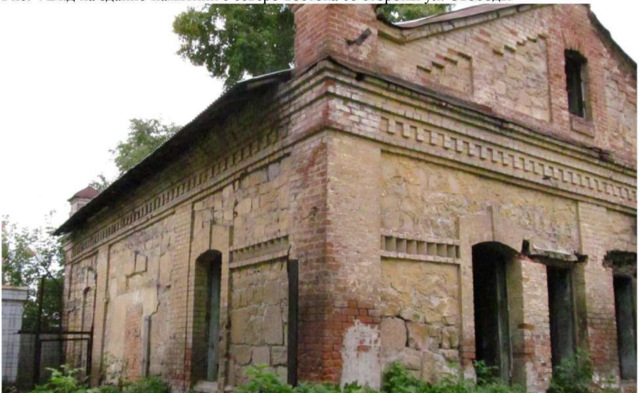
Рис. 5 Вид на здание-памятник с северо-запада со стороны дворовой территории
