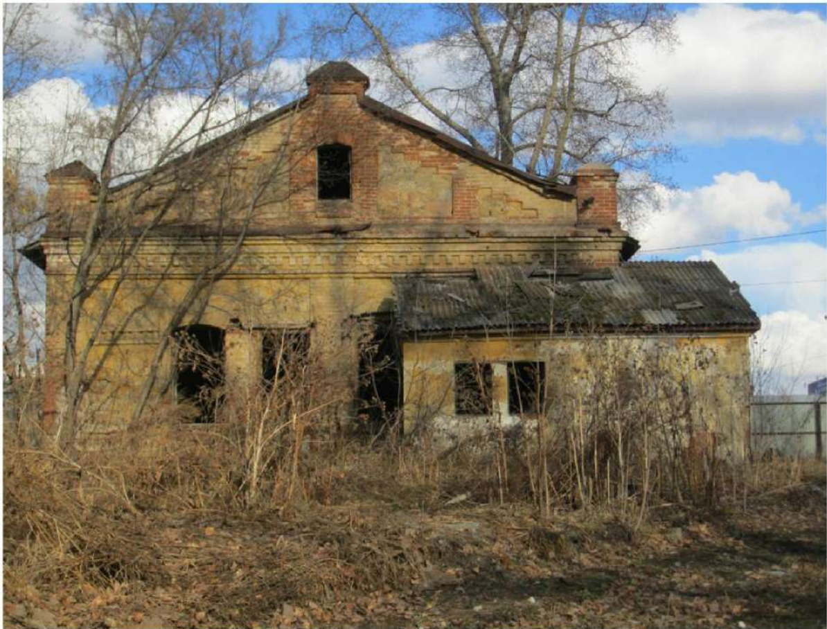
Рис. 48 Западный фасад здания бывшей насосной (водокачки) водопровода «Златоусто-Челябинской» железной дороги (участка Самаро-Златоустовской железной дороги) по ул.Свободы,6 (Фото – апрель, 2015 г.). Ссылка: http://cs622016.vk.me/v622016824/351a5/Jv4_zKG_HIRg.jpg .
