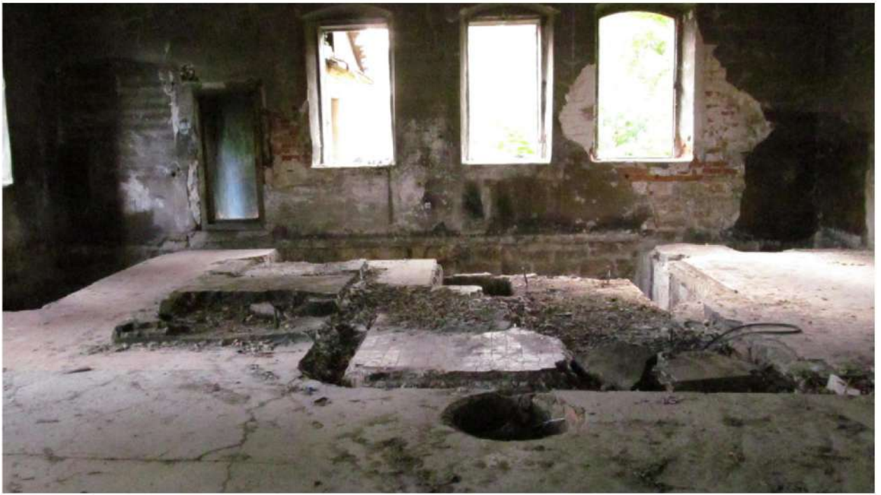
Рис. 33 Общий вид на состояние полов и стен в западной части основного помещения здания
