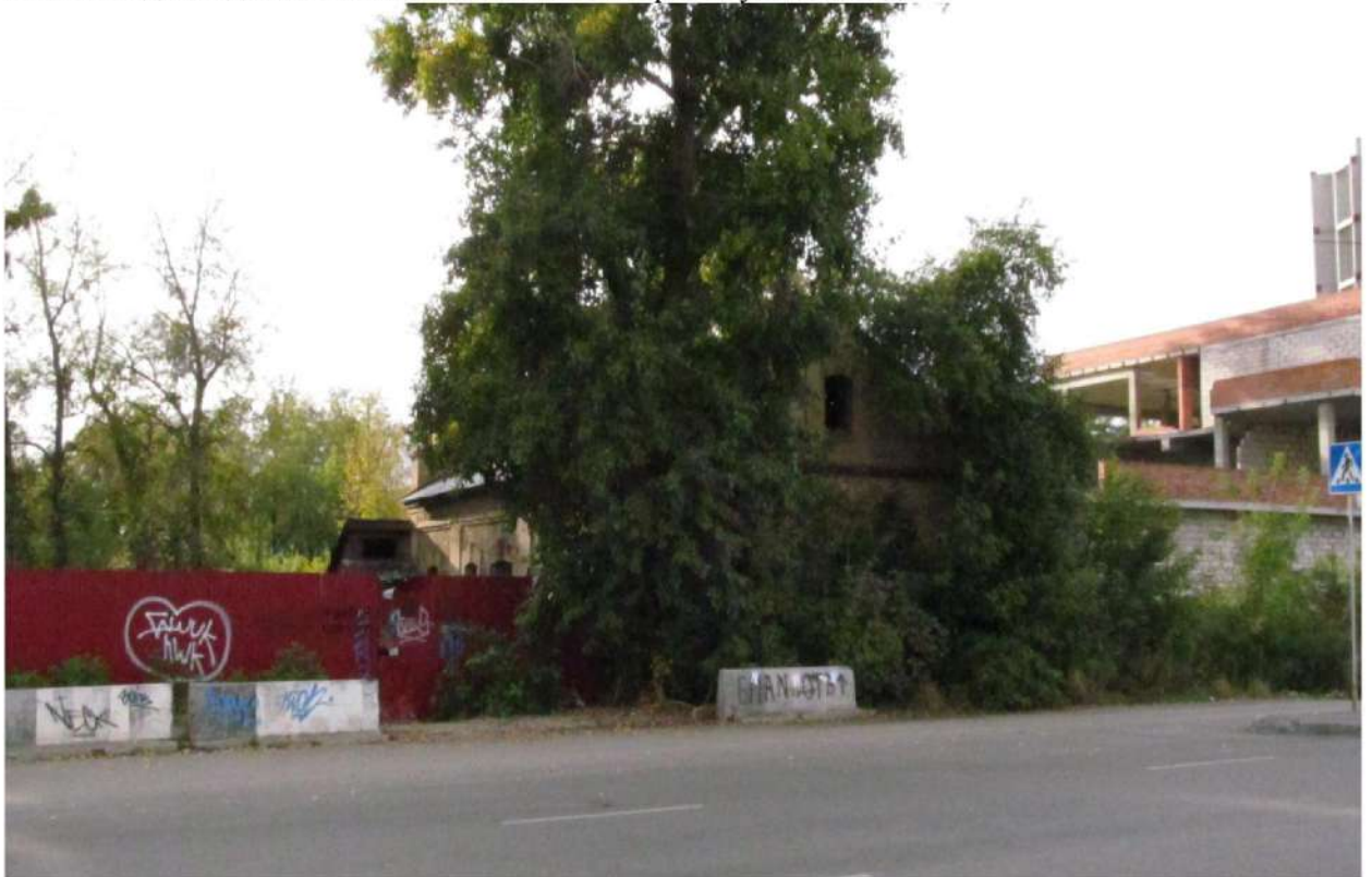
Рис. 3 Вид на здание-памятник с юго-востока со стороны ул. Свободы
