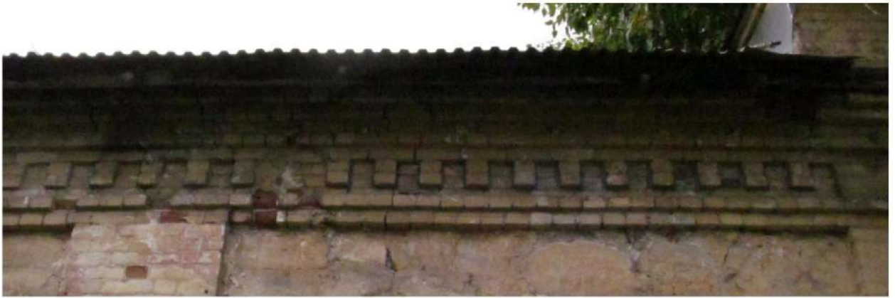
Рис. 22 Вид на карнизную зону южного фасада здания
