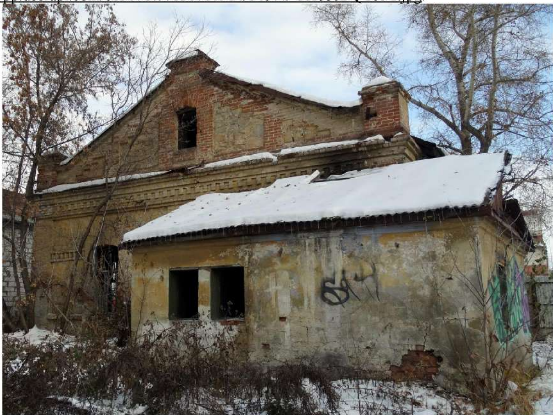
Рис. 41 Западный фасад здания бывшей насосной (водокачки) водопровода «Златоусто-Челябинской» железной дороги (участка Самаро-Златоустовской железной дороги) по ул.Свободы, 6 (Фото – октябрь, 2014 г.). Ссылка: https://pp.userapi.com/c630717/v630717914/14c4e/FT7yZENKeBE.jpg .
