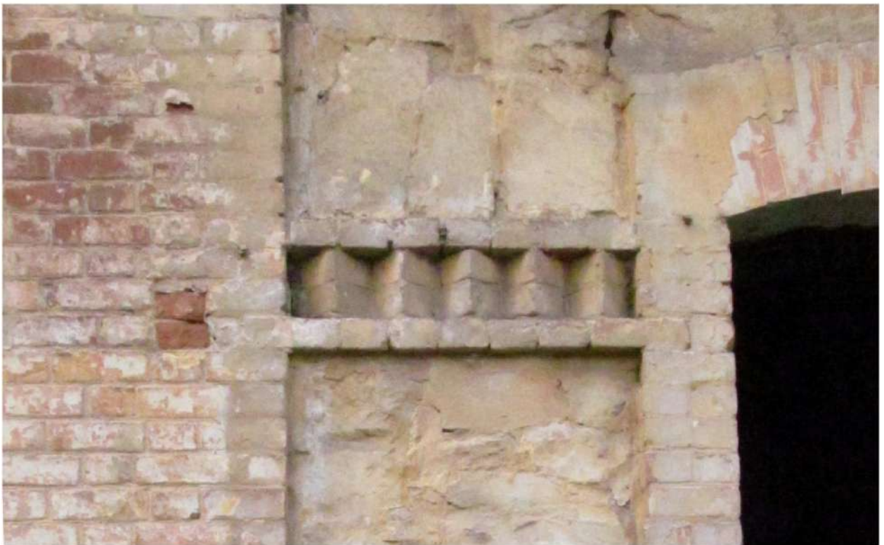
Рис. 21 Вид на поребрики простенков южного фасада здания
