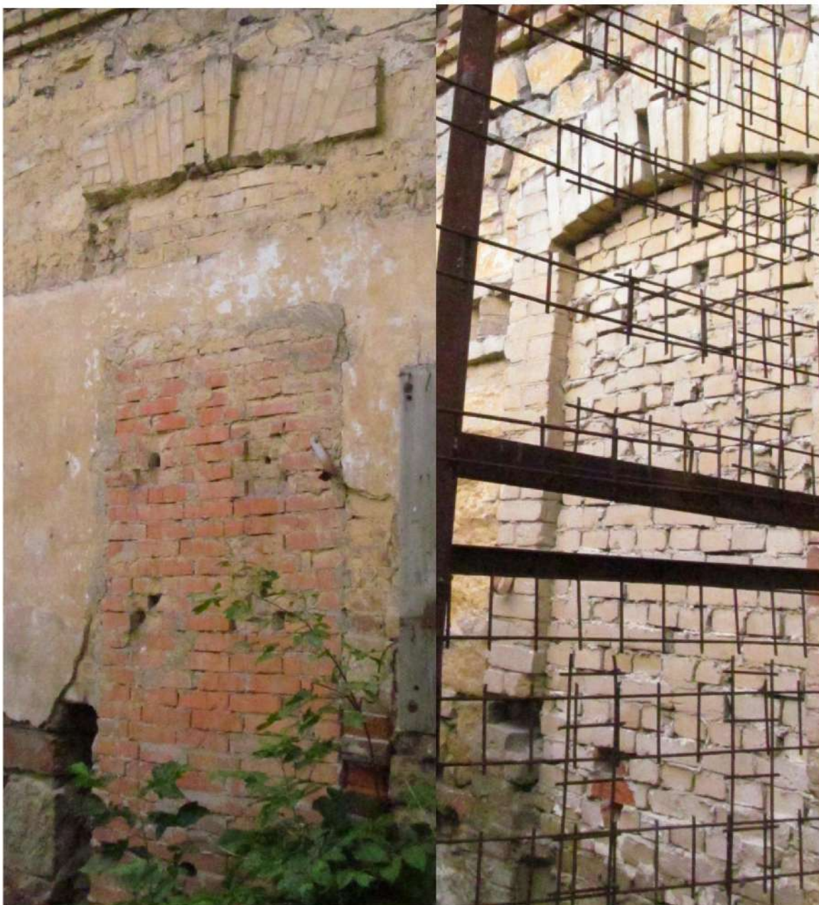
Рис. 19 Вид на заложенные проемы северного фасада здания
