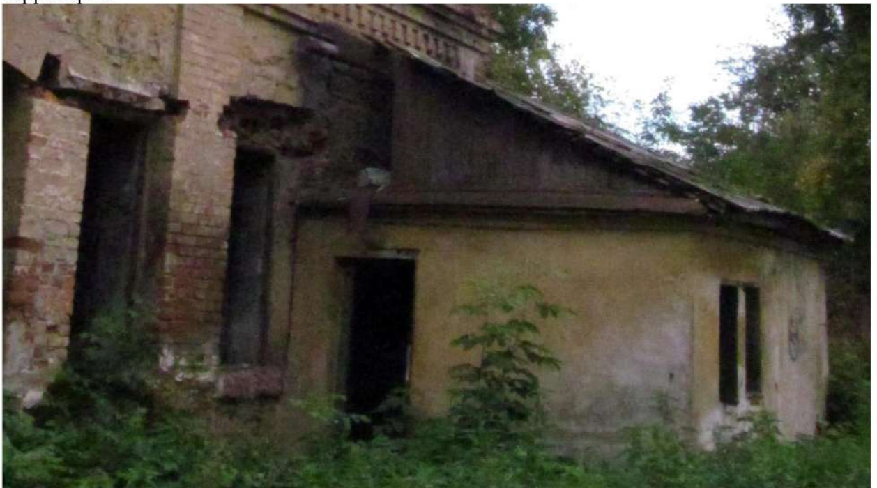
Рис. 15 Вид на северо-западную угловую часть пристроя здания со стороны дворовой территории
