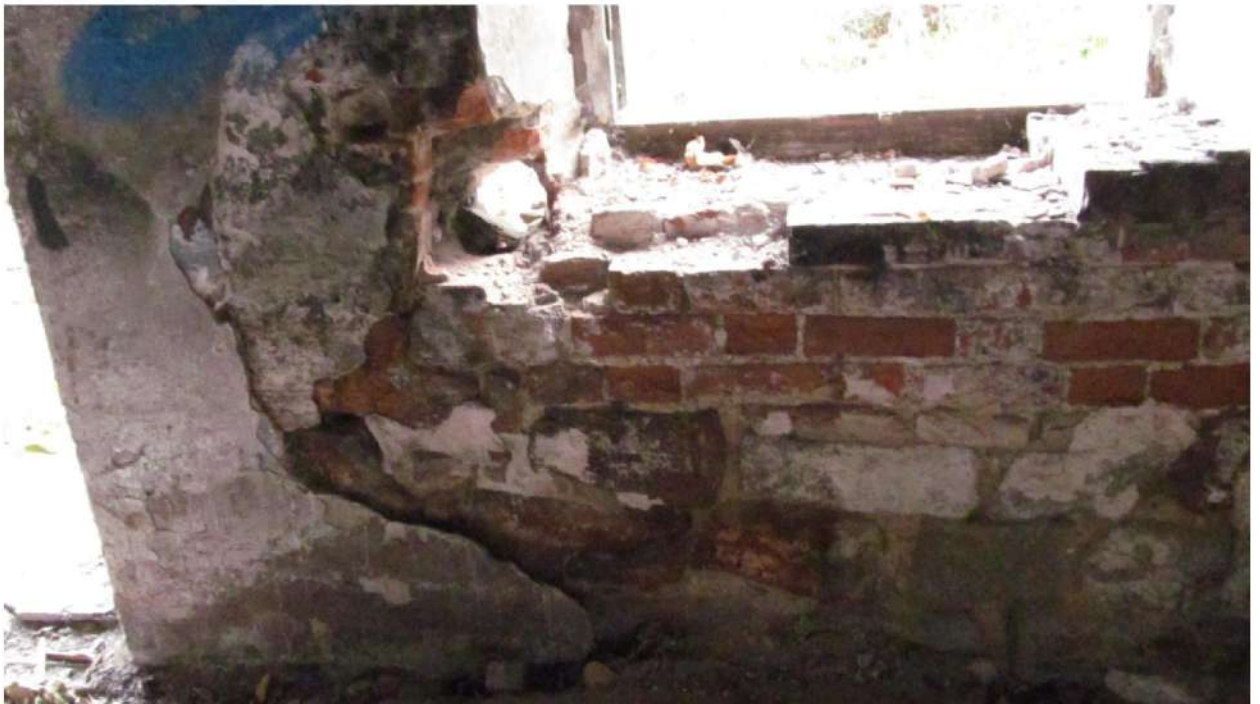
Рис. 38 Виды на состояние стен подоконной зоны основного помещения здания
