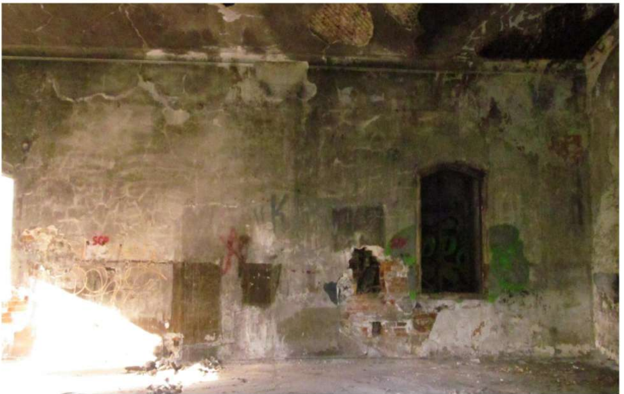
Рис. 24 Общий вид северную стену интерьера здания
