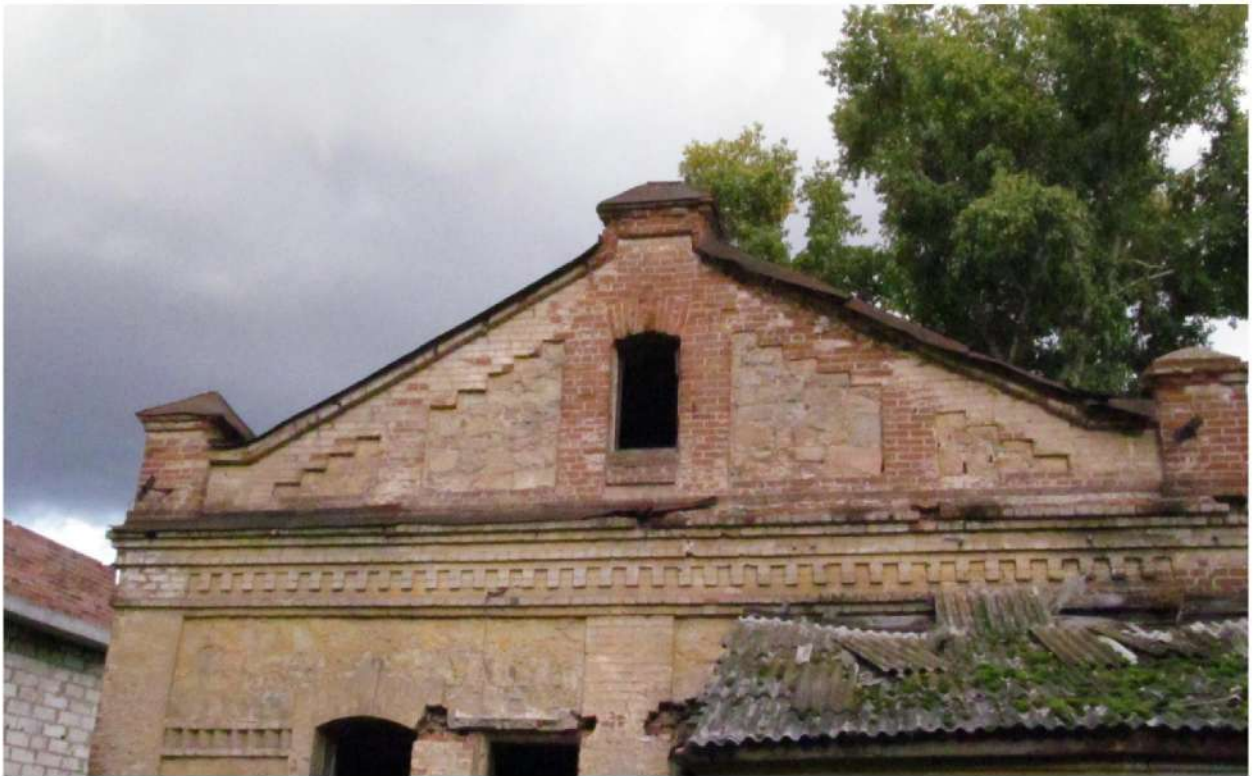
Рис. 12 Вид на чердачную часть западного фасада здания со стороны дворовой территории
