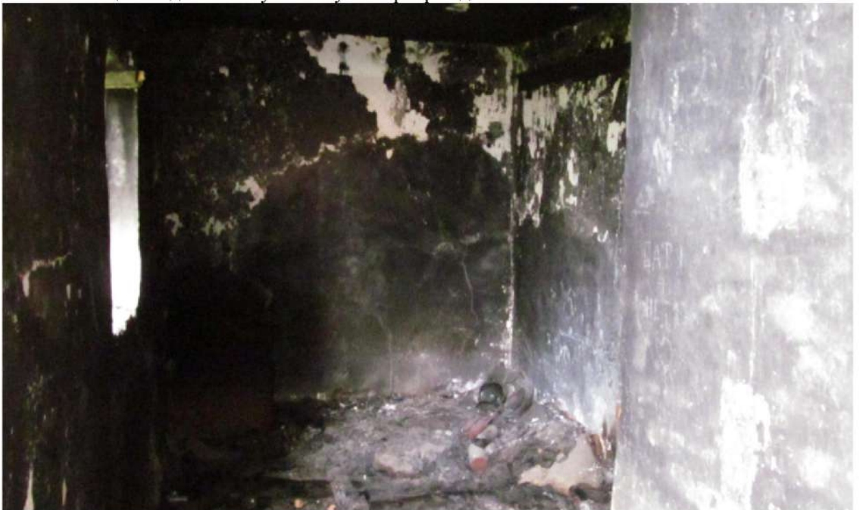
Рис. 28 Общий вид на помещение пристроя здания
