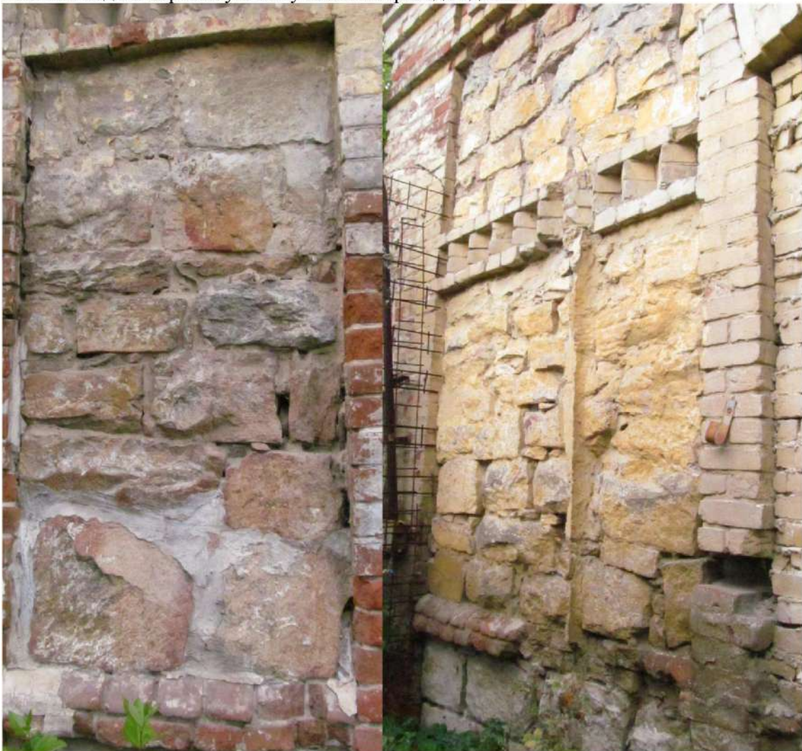
Рис. 23 Вид на бутовую кладку простенков южного и северного фасадов здания
