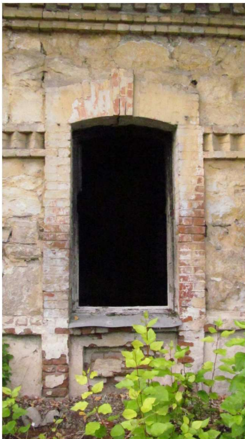
Рис. 18 Вид на оконное обрамление и подоконную филенку южного фасада здания
