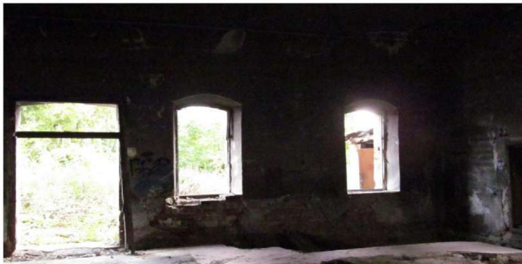
Рис. 26 Общий вид южную стену интерьера здания
