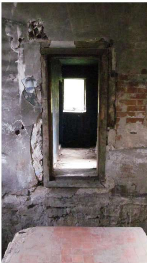
Рис. 29 Вид на переход из основного помещения здания в пристрой
