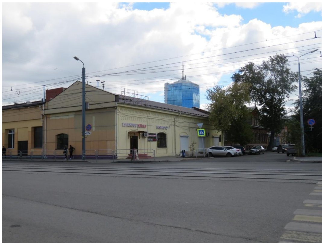
Рис. 1. Северный и западный фасады со стороны пересечения улиц Труда и Елькина.
