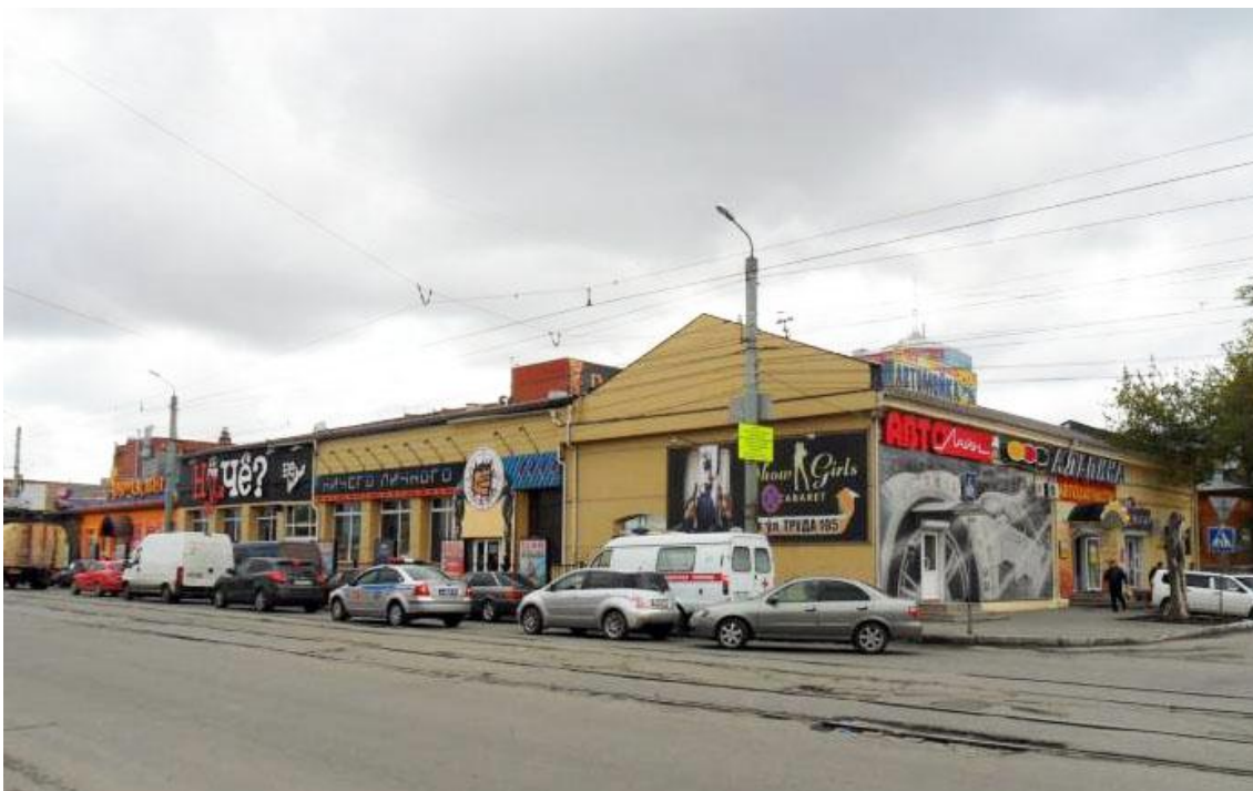
Рис. 23. Вид на здание со стороны перекрестка улиц Труда и Елькина. Фото 2010-х гг.
