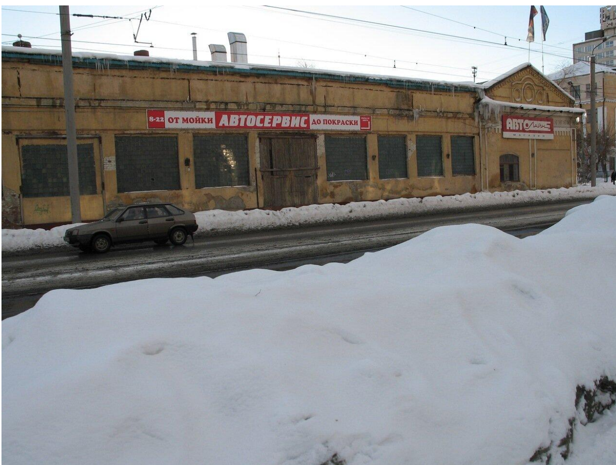
Рис. 20. Вид на выявленный объект культурного наследия «Каменная кладовая» и примыкающее слева одноэтажное здание (1930-е гг.) со стороны ул. Труда. Фото 2000-х гг.
