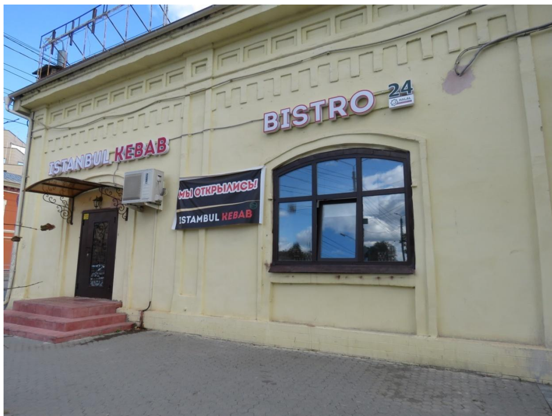
Рис. 5. Фрагмент западного фасада.
