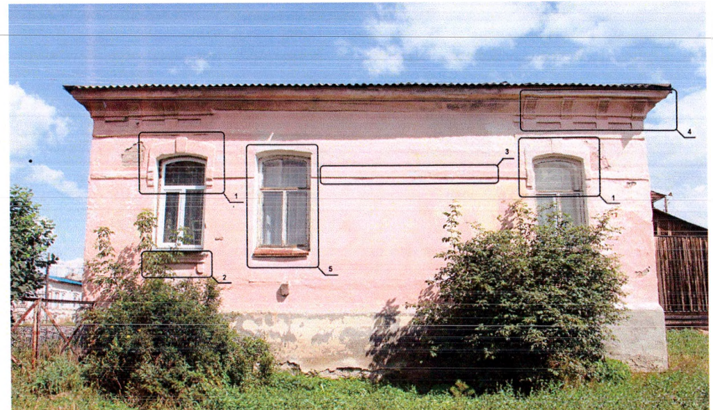
1. Наличники с имитацией замкового камня. 4. Карниз на кронштейнах. Псевдогалтель. Пояс ширинок. 2. Подоконники, поддерживаемые кронштейнами. 5. Арочный лучковый оконный проём с исторической расстекловкой. 3. Прямоугольная тяга.
