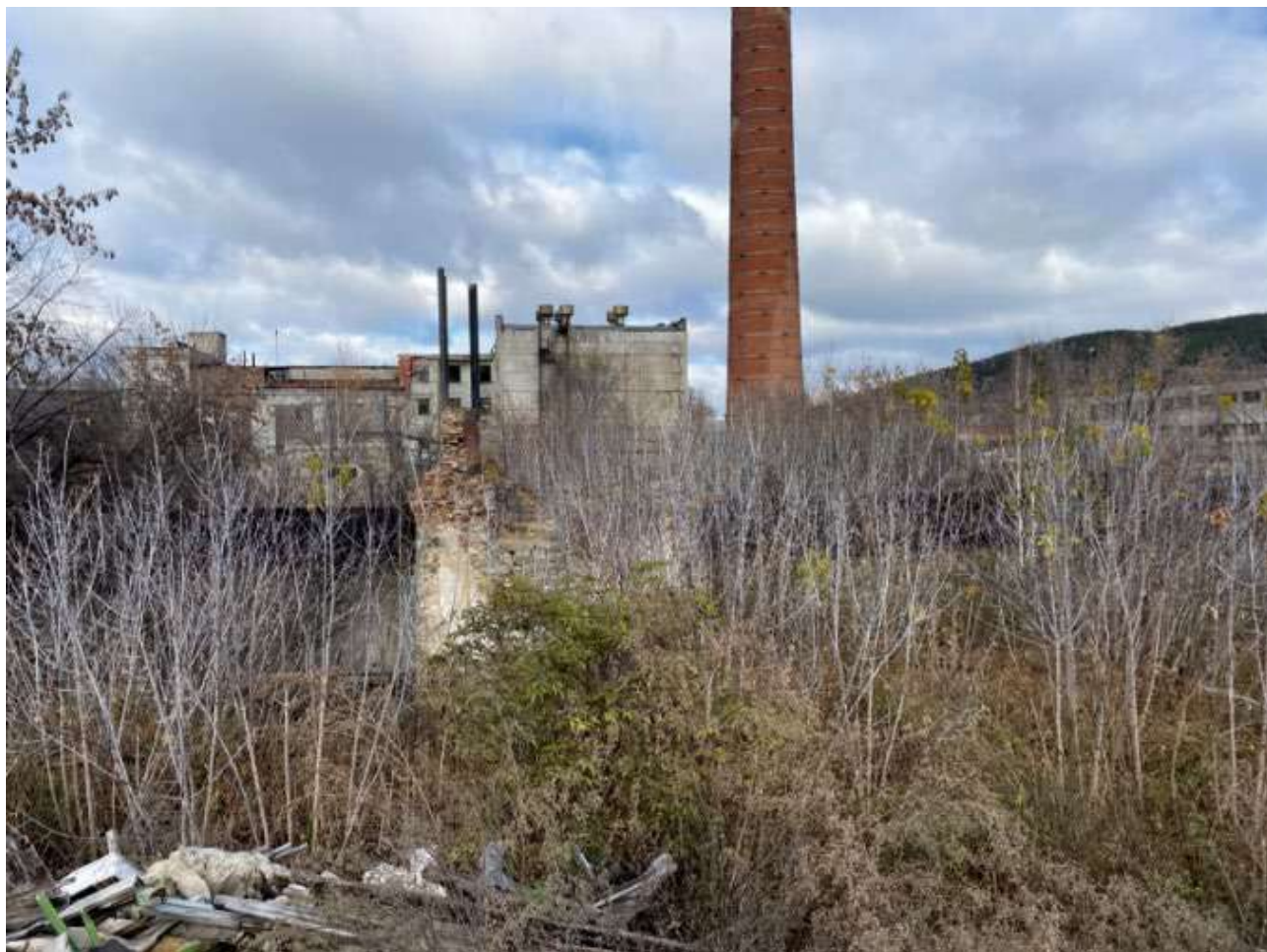
Фото 2. Выявленный объект культурного наследия «Паровая мельница мельника Рассомахина» по адресу: Челябинская обл., г. Миасс, площадь Ремесленная. Общий вид выявленного объекта культурного наследия.
