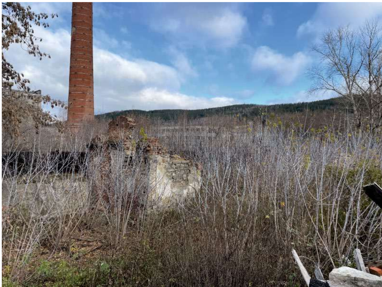
Фото 8. Выявленный объект культурного наследия «Паровая мельница мельника Рассомахина» по адресу: Челябинская обл., г. Миасс, площадь Ремесленная. Общий вид выявленного объекта культурного наследия.
