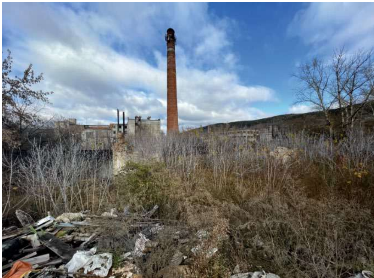
Фото 3. Выявленный объект культурного наследия «Паровая мельница мельника Рассомахина» по адресу: Челябинская обл., г. Миасс, площадь Ремесленная. Общий вид выявленного объекта культурного наследия.
