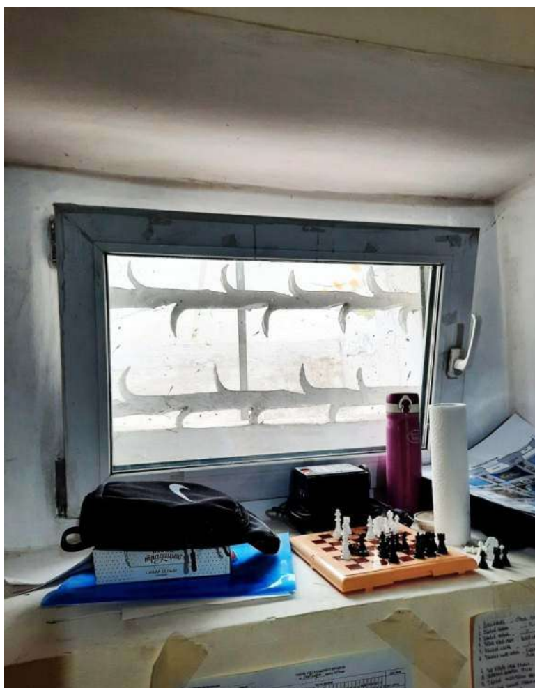
Рис.17. Подвальное окно с исторической решеткой «в расщеп».
