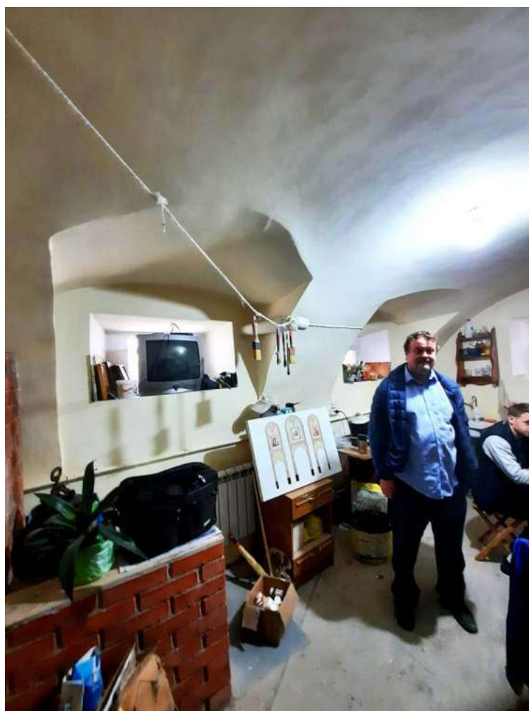
Рис.15. Вид на подвальное помещение исторической части с цилиндрическим сводом, с прямоугольными окнами, расположенными в нишах со сводиками с параболической проекцией.
