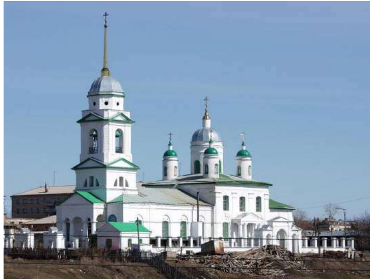
Рис.18. Свято-Троицкий собор (Кафедральный собор Троицы Живоначальной) (Фото –2000-х гг.). Вид на главный (западный) фасад и южный фасады здания, ограду и дом причта. Ссылка: http://static.esosedi.org/fiber/236461/fit/1400x1000/uyskiy_sobor.png
