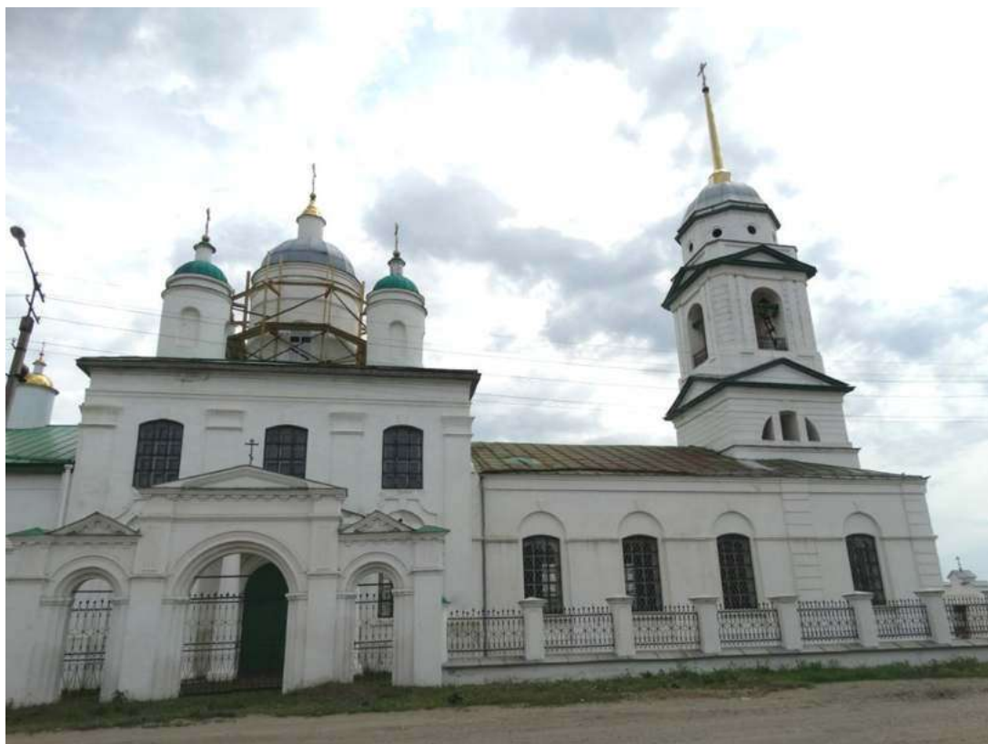
Рис.30. Свято-Троицкий собор (Кафедральный собор Троицы Живоначальной). Вид на северный фасад здания, ограду и северные ворота (Фото – 2014 г., автор – Ю.Латышев). Ссылка: https://img-fotki.yandex.ru/get/3209/5661614.8d/0_a8c2e_2c8027_orig .
