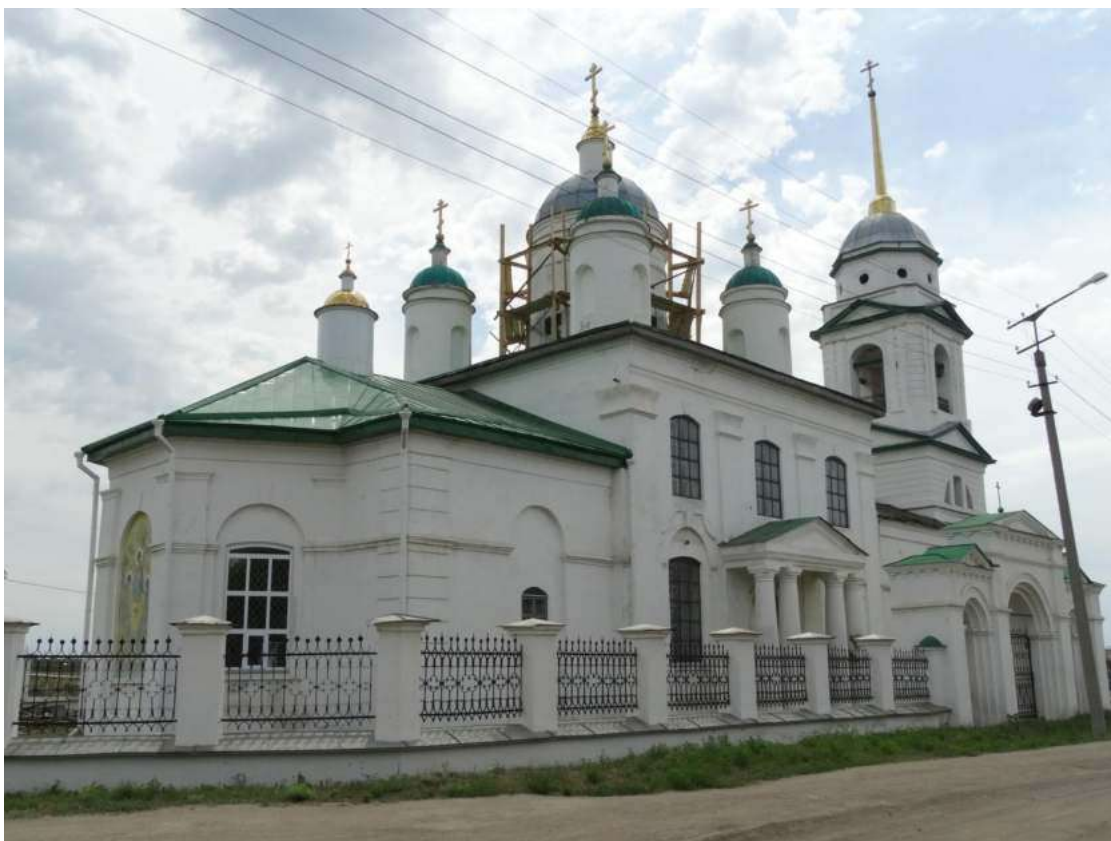
Рис.32. Свято-Троицкий собор (Кафедральный собор Троицы Живоначальной). Вид на северный и восточный фасады здания и ограду. (Фото – 2014 г., автор – Ю.Латышев). Ссылка: https://img-fotki.yandex.ru/get/6818/5661614.8d/0_a8c30_47b98061_orig .
