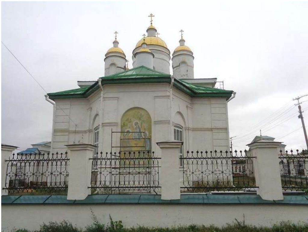
Рис.48. Свято-Троицкий собор (Кафедральный собор Троицы Живоначальной). Вид на восточный фасад здания и ограду (Фото – ноябрь, 2015 г., автор – А.Романов). Ссылка: https://upload.wikimedia.org/wikipedia/commons/thumb/8/82/Ансамбль_4.jpg/1024px-Ансамбль_4.jpg .
