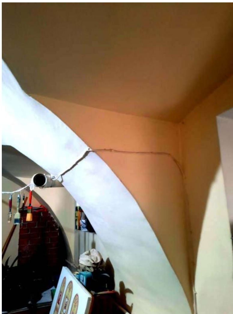
Рис.18. Арочные своды исторического подвального помещения.
