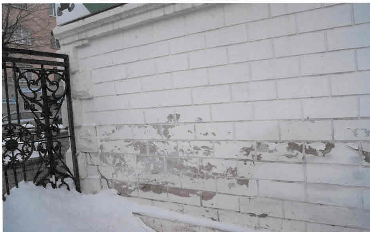
Фото 8. Фрагмент южного фасада здания.
