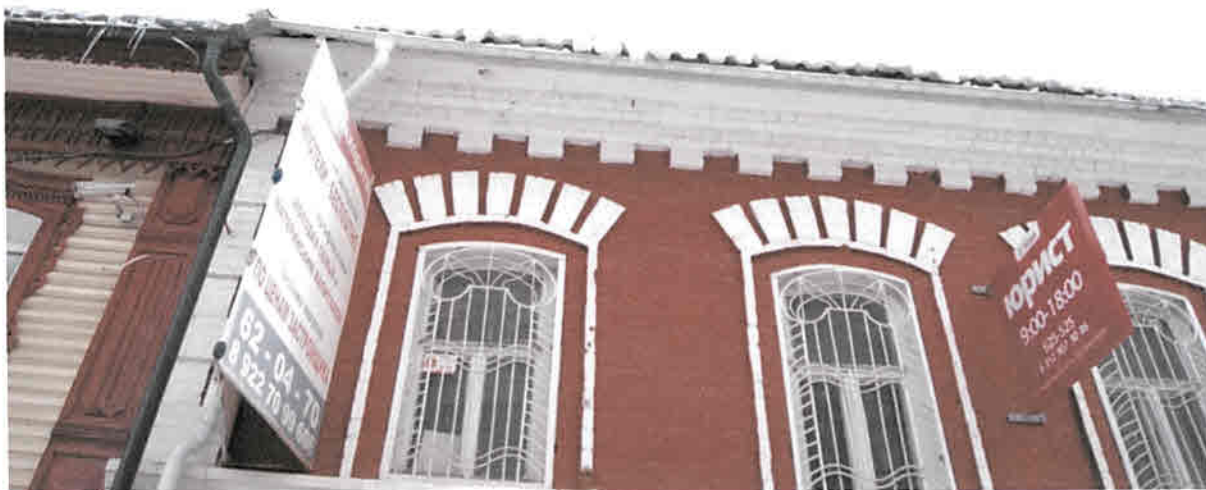
Фото 5. Фрагмент западного фасада здания. Вид на окна 2-го этажа
