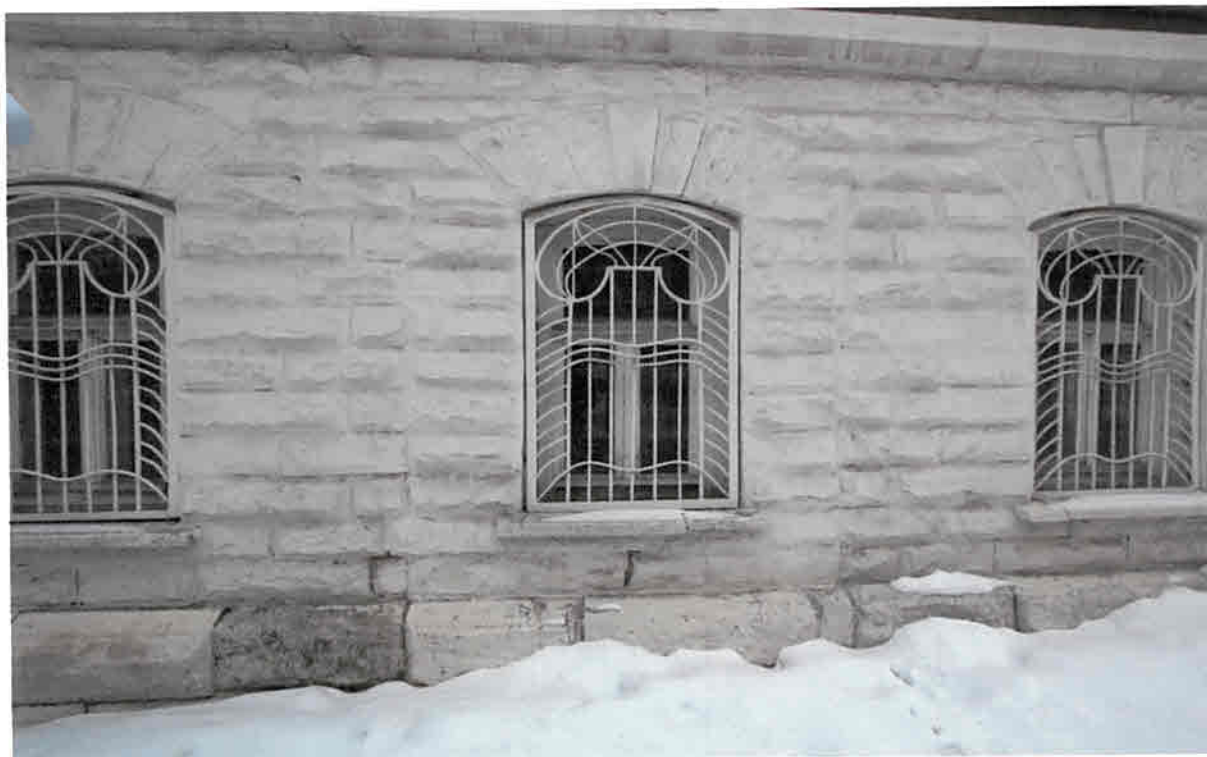
Фото 6. Фрагмент западного фасада здания. Вид на окна 1-го этажа
