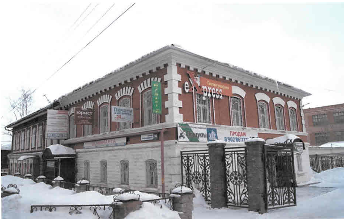
Фото 1. Общий вид здания с юго-западной стороны
