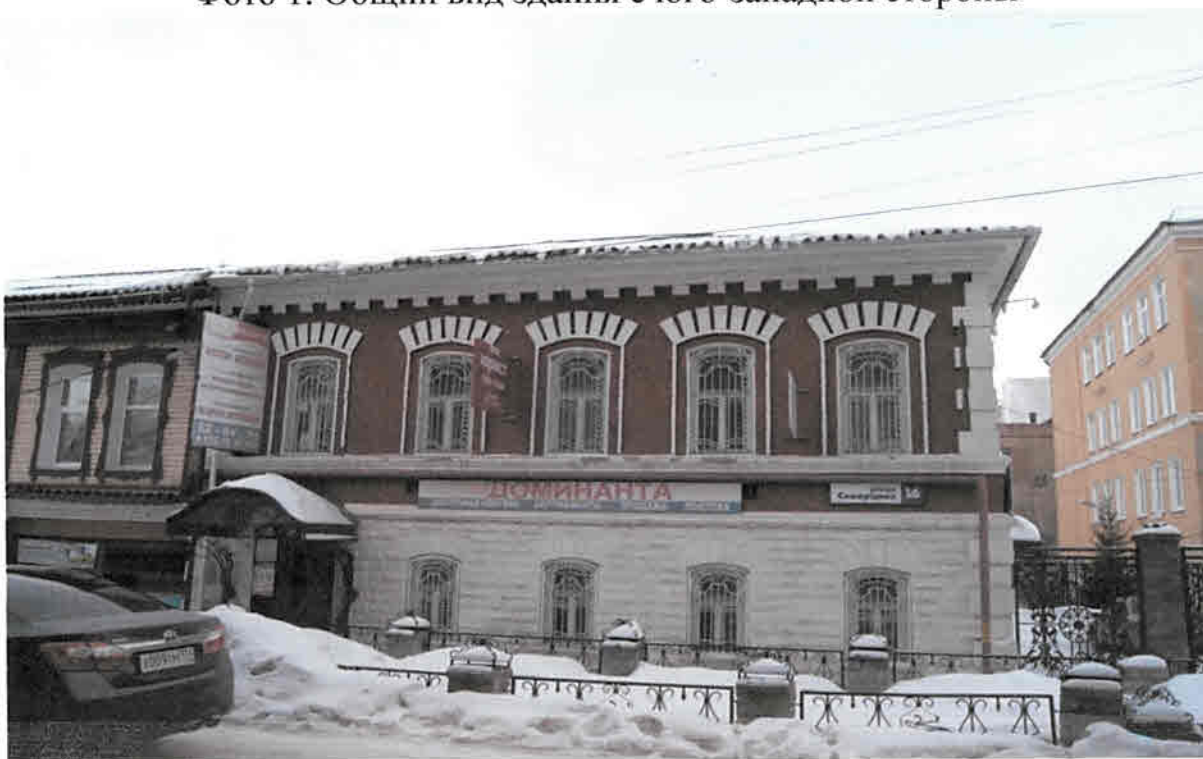
Фото 2. Вид на главный западный фасад здания
