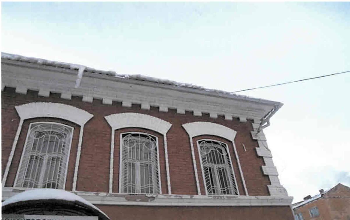
Фото 7. Фрагмент южного фасада здания. Вид на окна 2-го этажа
