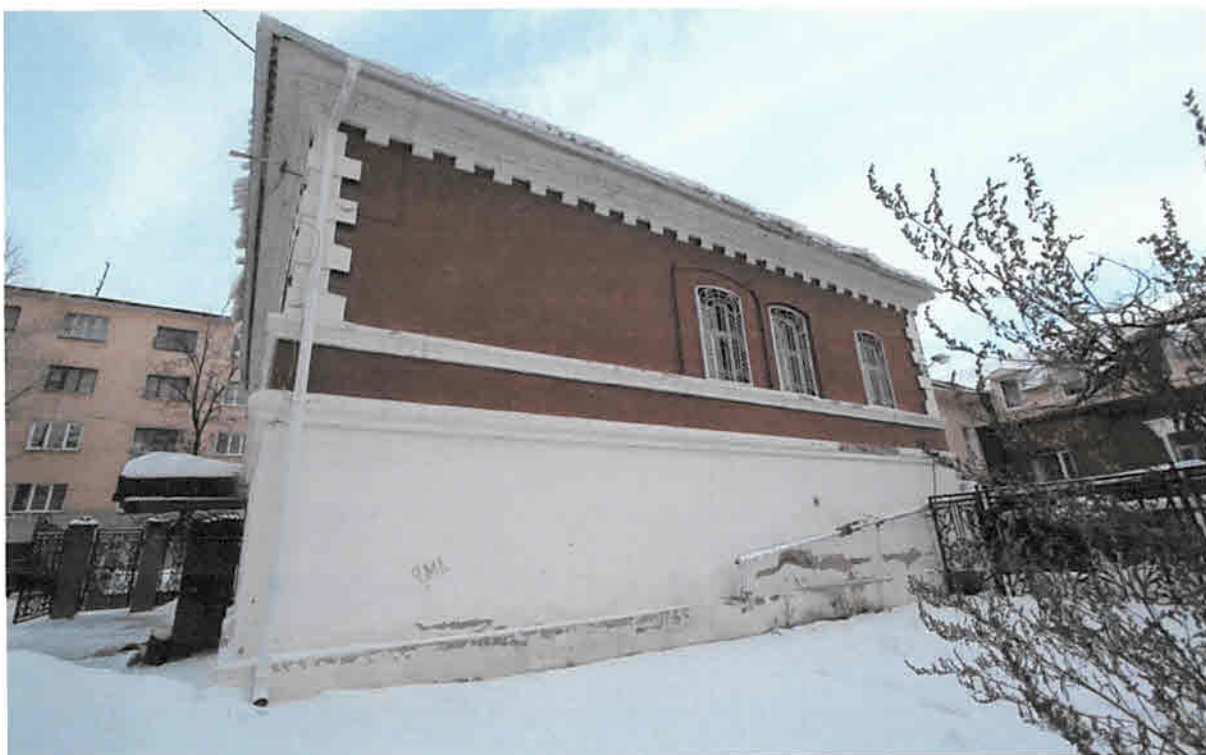
Фото 4. Вид на восточный фасад здания
