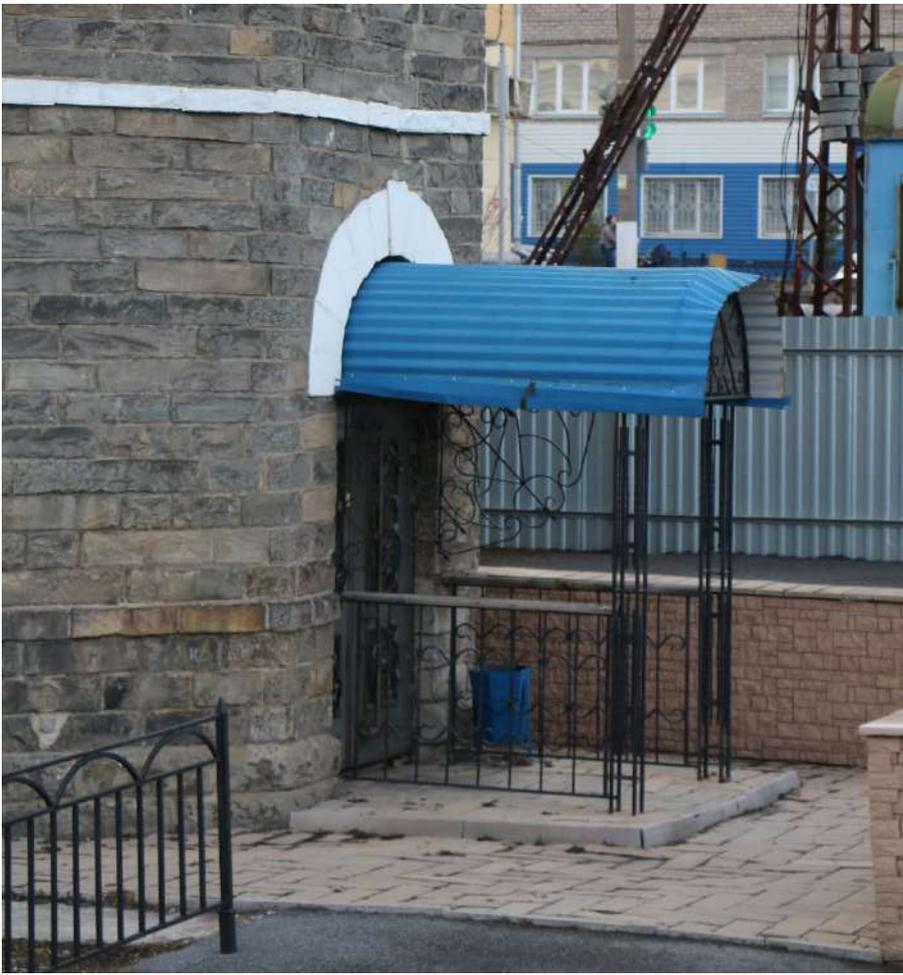
Фото 18. Дверной проем арочного завершения, украшен архивольтом с замковым камнем. Современное исполнение металлического ажурного козырька с перилами.
