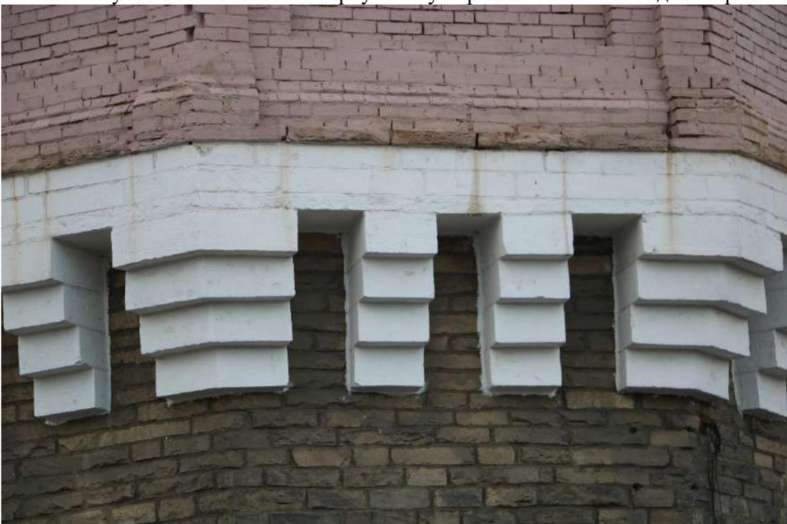
Фото 15. Массивный карнизный пояс с многоступенчатыми консолями.
