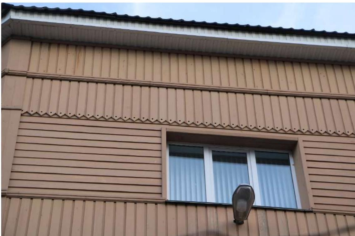
Фото 13. Поздний оконный проем с современным заполнением. Дощатая обшивка. Надоконная полоса с пропиленным узором.
