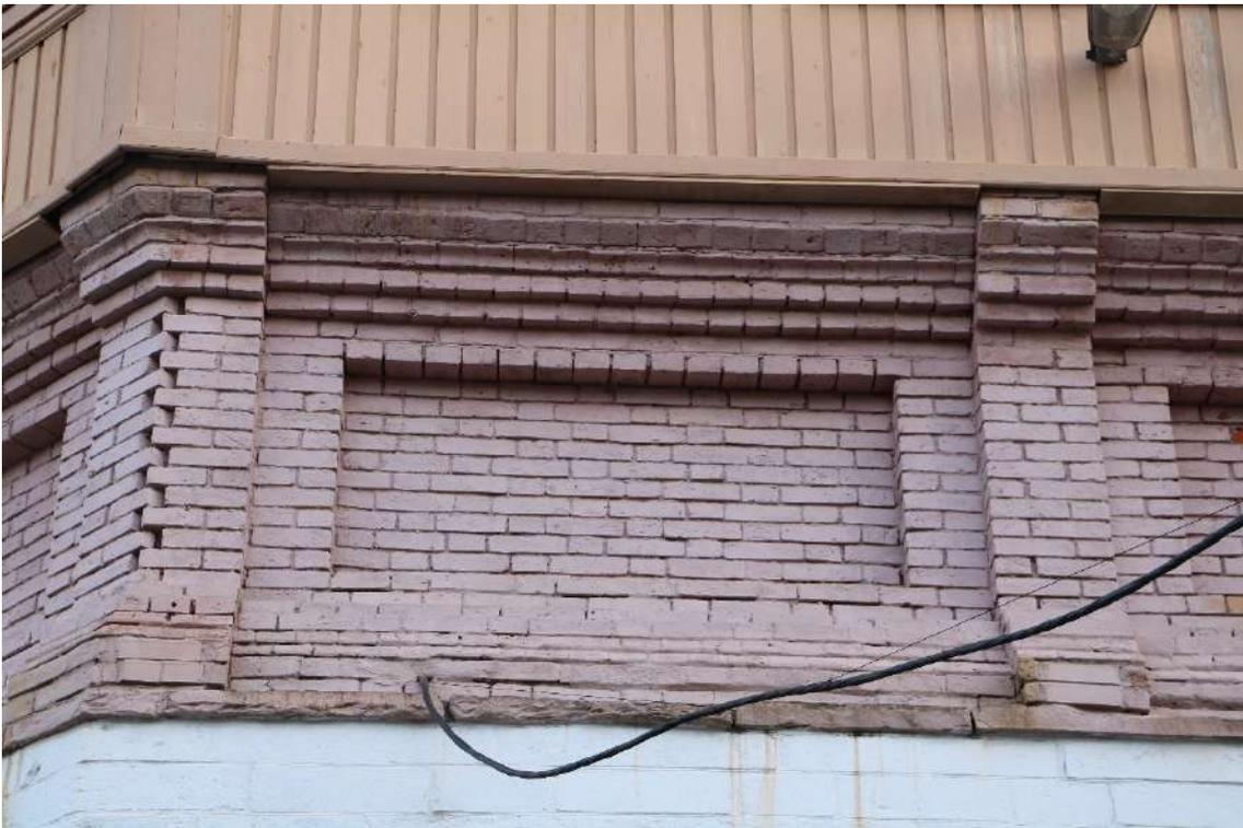
Фото 14. Лопатки с прямоугольной филенкой между ними. Переходные многоступенчатые пояски по верху и низу кирпичного объема водонапорной башни
