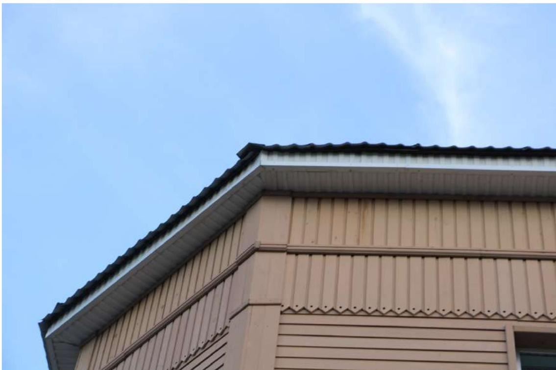
Фото 12. Фрагмент венчания третьего яруса. Современное исполнение карнизной части.
