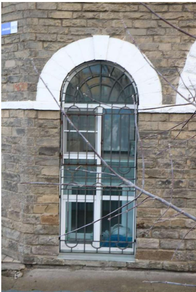
Фото 16. Оконный проем арочного завершения, украшен архивольтом с замковым камнем и объединяющим пояском под архивольтом.
