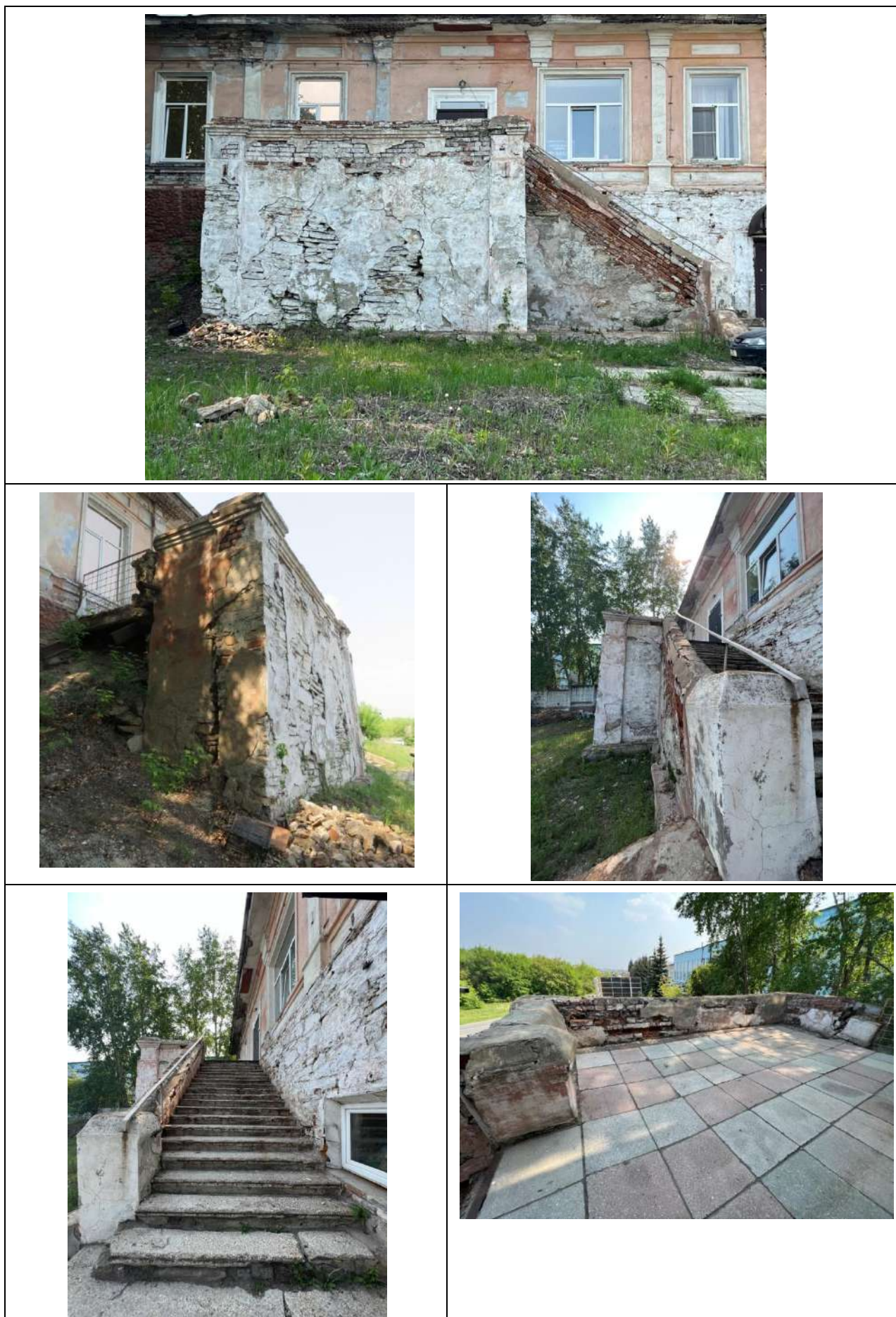
Рис. 5. Фрагмент главного фасада. Парадная лестница
