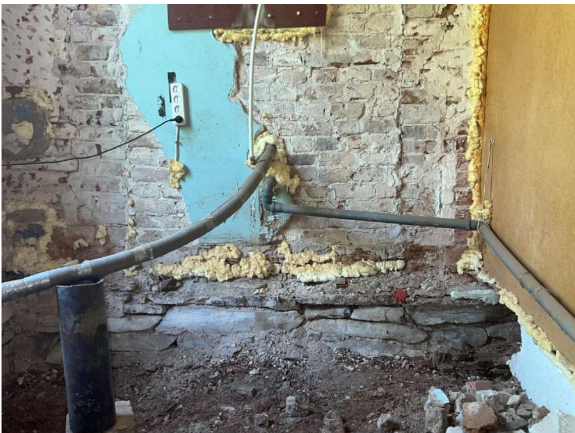
Рис. 19. Бутовая кладка фундамента
