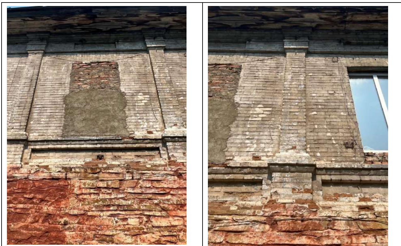
Рис. 14. Боковой, юго-западный фасад. Фрагменты фасада второго этажа
