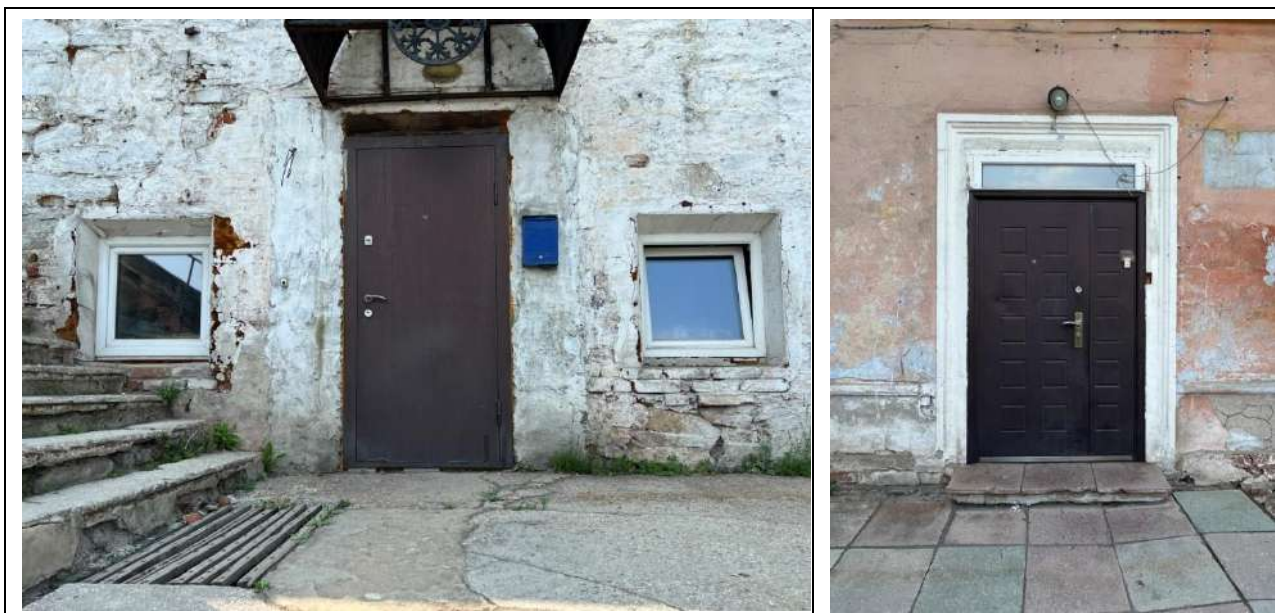
Рис. 7 а, б. Фрагмент главного фасада. Входной проем на первый этаж и фланкирующие его оконные проемы (слева) и входной второй проем на второй этаж с лестничной площадки (справа)
