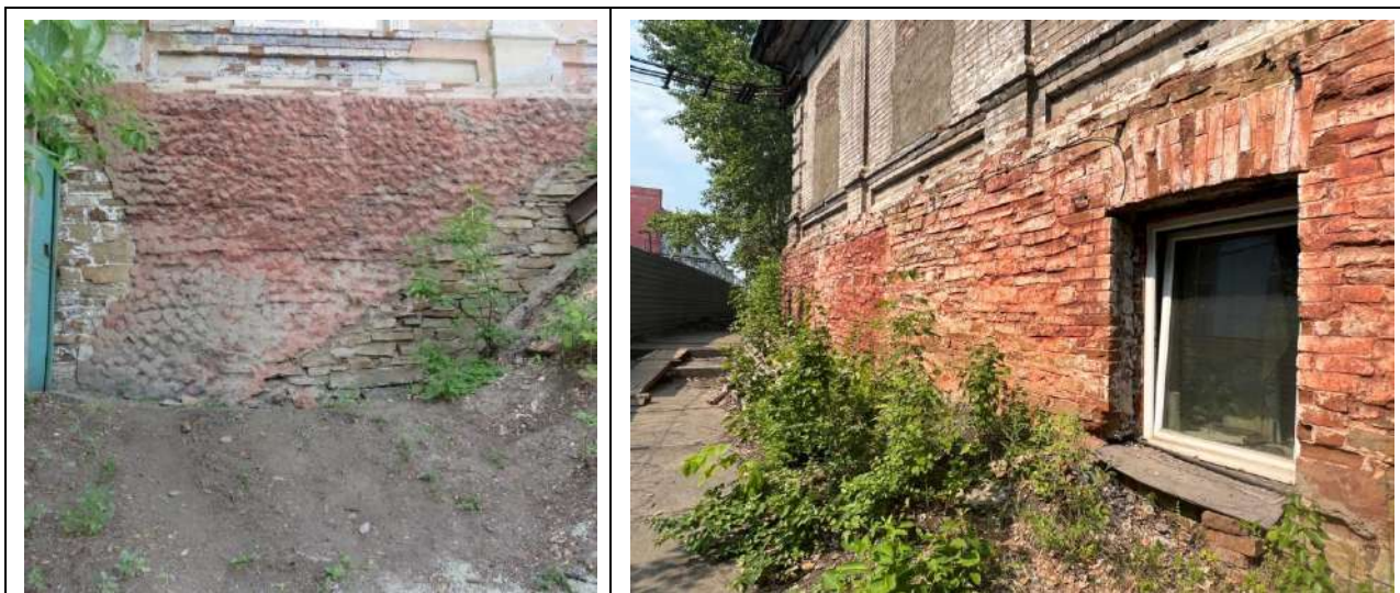
Рис. 21. Бутовая кладка стен первого этажа
