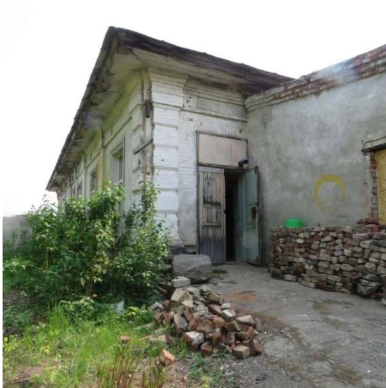
Рис. 17. Фрагмент дворового фасада. Дверной проем на левом фланге (пробит на месте исторического оконного проема)
