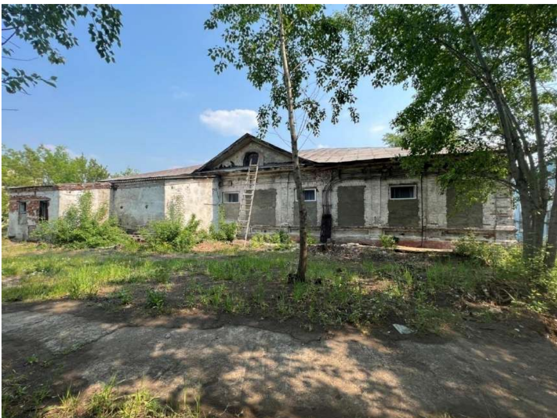
Рис. 15. Дворовый, северо-западный фасад. Вид с северо-запада
