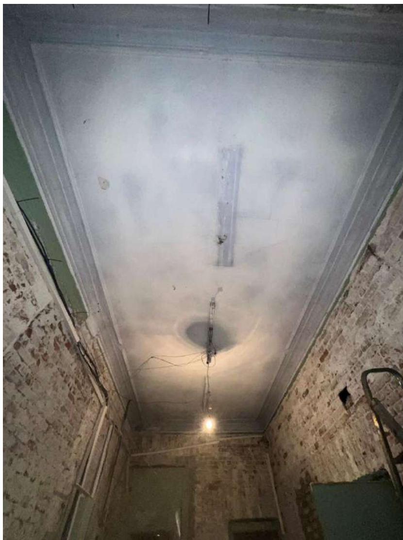
Рис. 29 а, б. Фрагменты интерьера. Кирпичная кладка исторических стен конца XVIII в.
