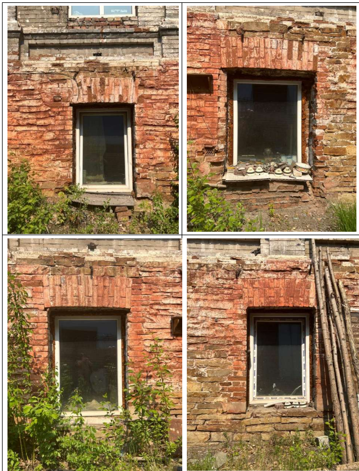
Рис. 12. Боковой, юго-западный фасад. Оконные проемы первого этажа
