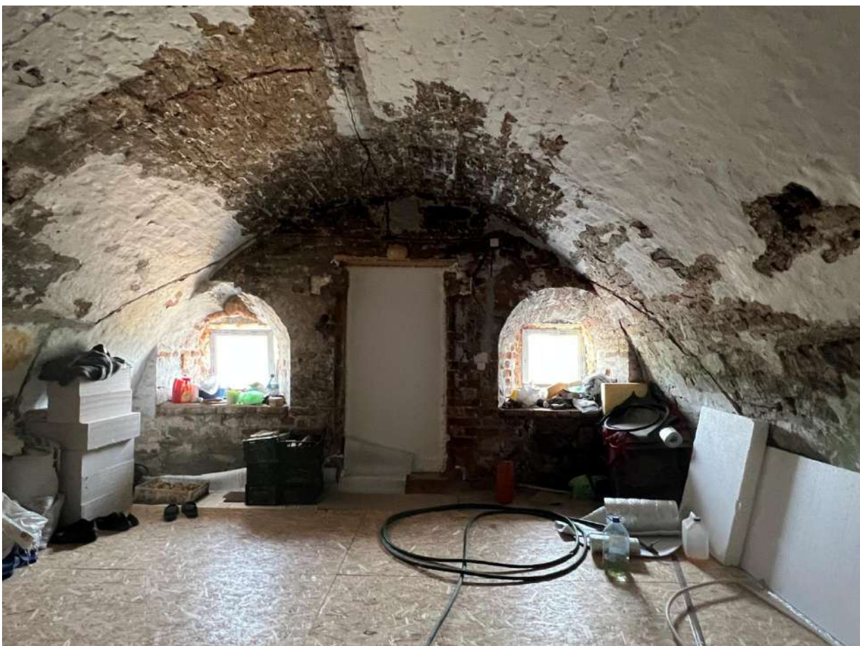
Рис. 23. Фрагменты интерьера. Помещение первого этажа со сводчатым перекрытием (входной проем первого этажа со стороны главного фасада и фланкирующие его оконные проемы)
