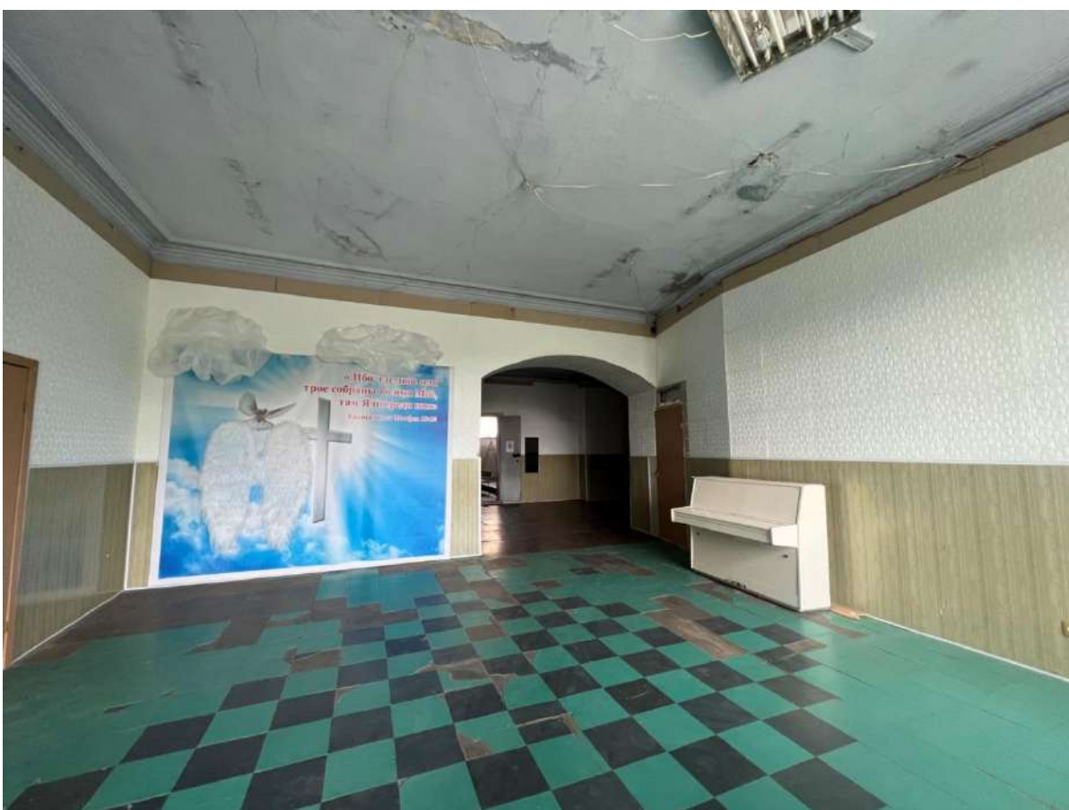
Рис. 26. Фрагменты интерьера. Помещения второго этажа. Холл главного входа
