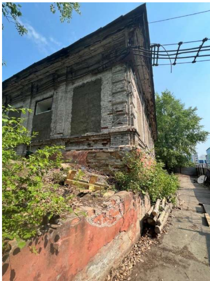
Рис. 18. Фрагмент дворового фасада. Правый фланг
