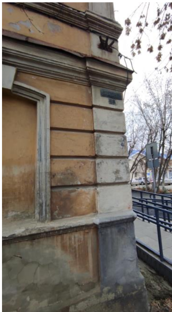
Фото 5. Вид на выявленный объект культурного наследия «Банк», расположенный по адресу: Челябинская область, Миасский городской округ, г. Миасс, ул. Спорта, 3.
