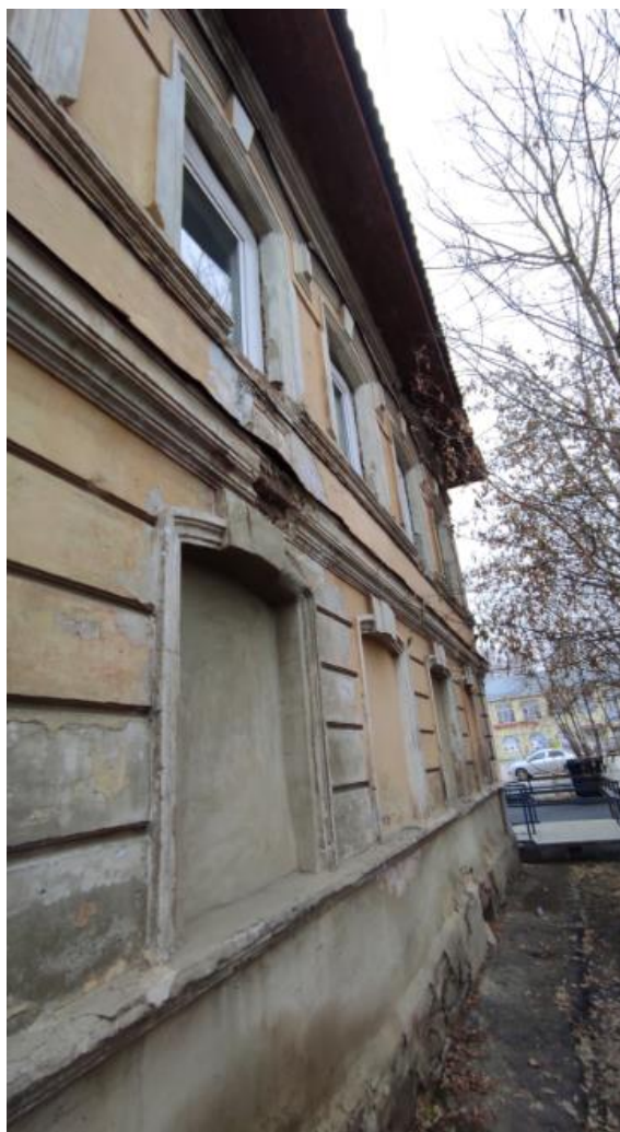
Фото 4. Вид на выявленный объект культурного наследия «Банк», расположенный по адресу: Челябинская область, Миасский городской округ, г. Миасс, ул. Спорта, 3.
