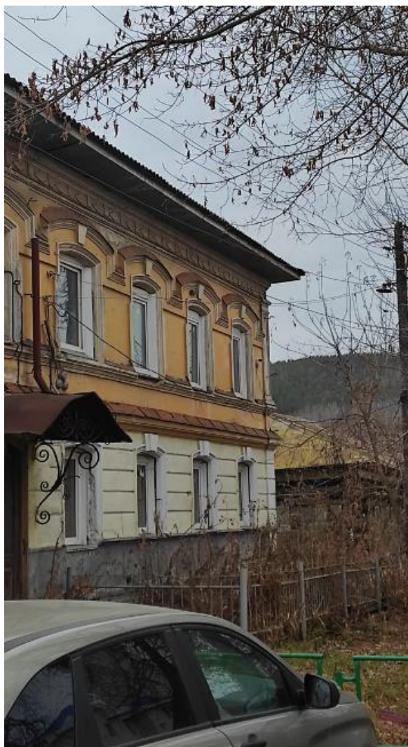
Фото 8. Вид на выявленный объект культурного наследия «Банк», расположенный по адресу: Челябинская область, Миасский городской округ, г. Миасс, ул. Спорта, 3.
