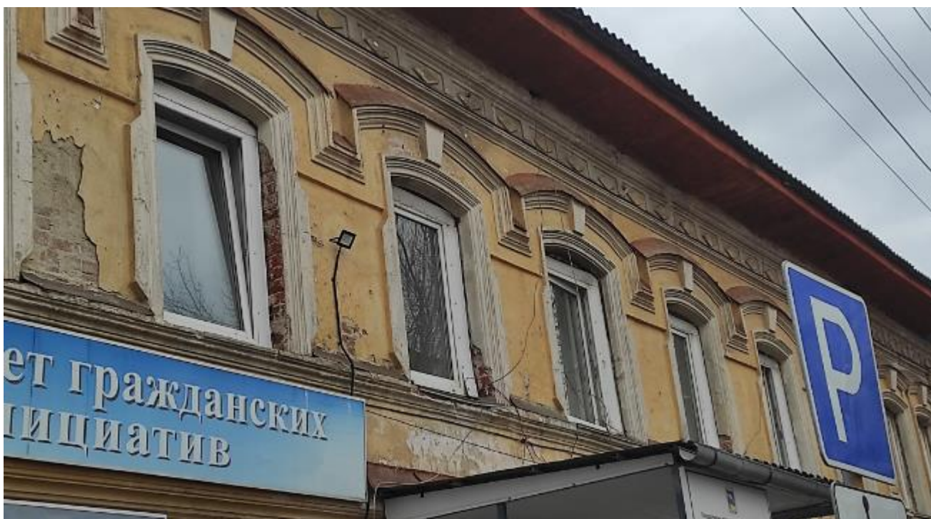
Фото 7. Вид на выявленный объект культурного наследия «Банк», расположенный по адресу: Челябинская область, Миасский городской округ, г. Миасс, ул. Спорта, 3.
