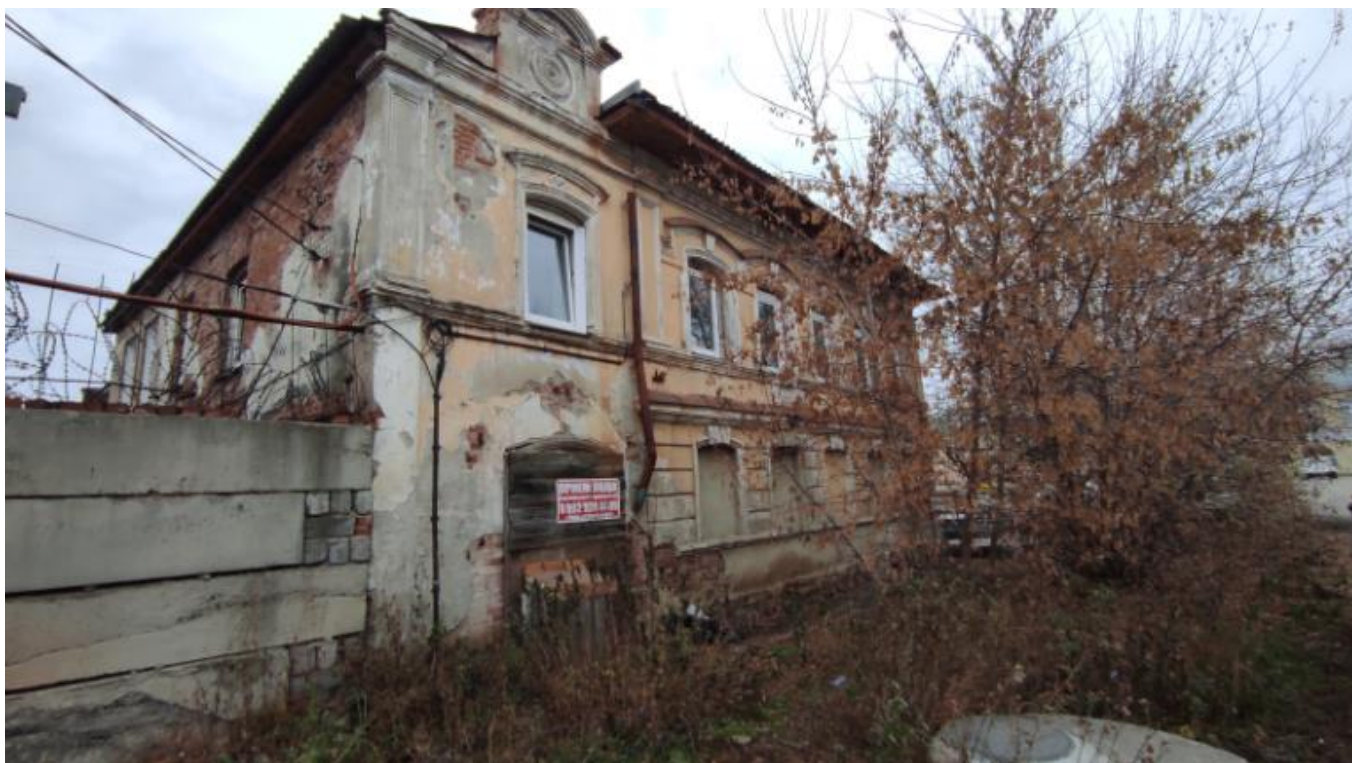
Фото 1. Вид на выявленный объект культурного наследия «Банк», расположенный по адресу: Челябинская область, Миасский городской округ, г. Миасс, ул. Спорта, 3.
