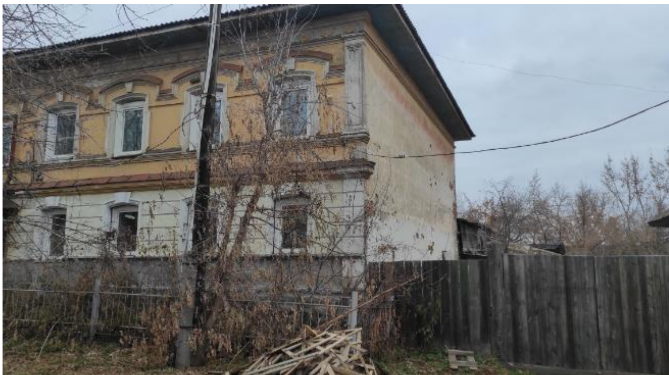
Фото 16. Вид на выявленный объект культурного наследия «Банк», расположенный по адресу: Челябинская область, Миасский городской округ, г. Миасс, ул. Спорта, 3.
