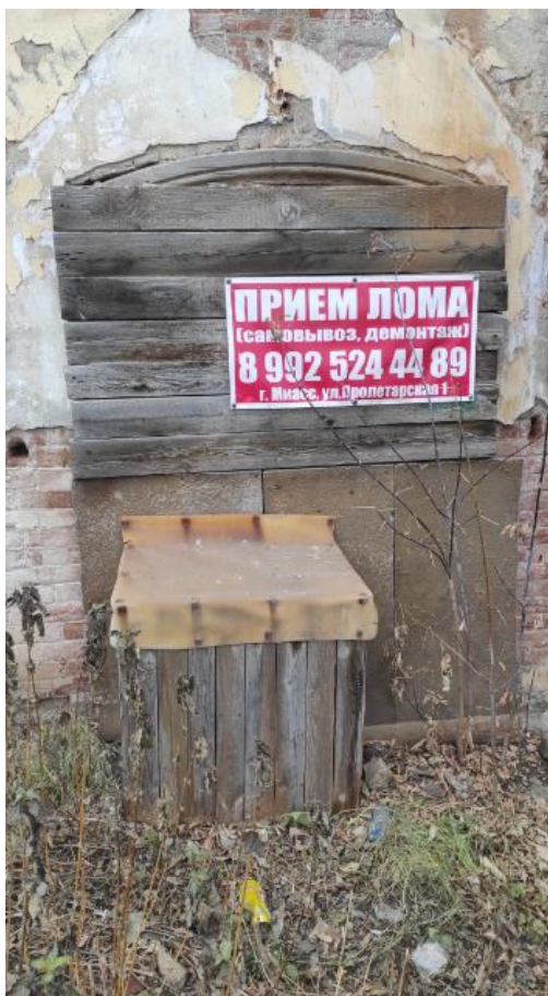
Фото 2. Вид на выявленный объект культурного наследия «Банк», расположенный по адресу: Челябинская область, Миасский городской округ, г. Миасс, ул. Спорта, 3.
