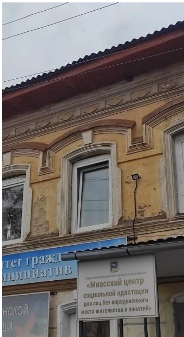
Фото 9. Вид на выявленный объект культурного наследия «Банк», расположенный по адресу: Челябинская область, Миасский городской округ, г. Миасс, ул. Спорта, 3.
