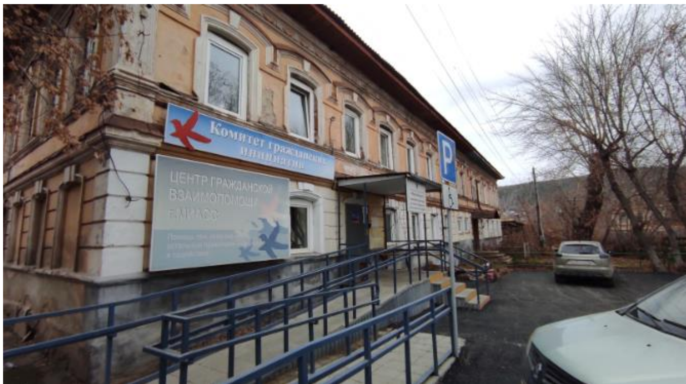
Фото 6. Вид на выявленный объект культурного наследия «Банк», расположенный по адресу: Челябинская область, Миасский городской округ, г. Миасс, ул. Спорта, 3.
