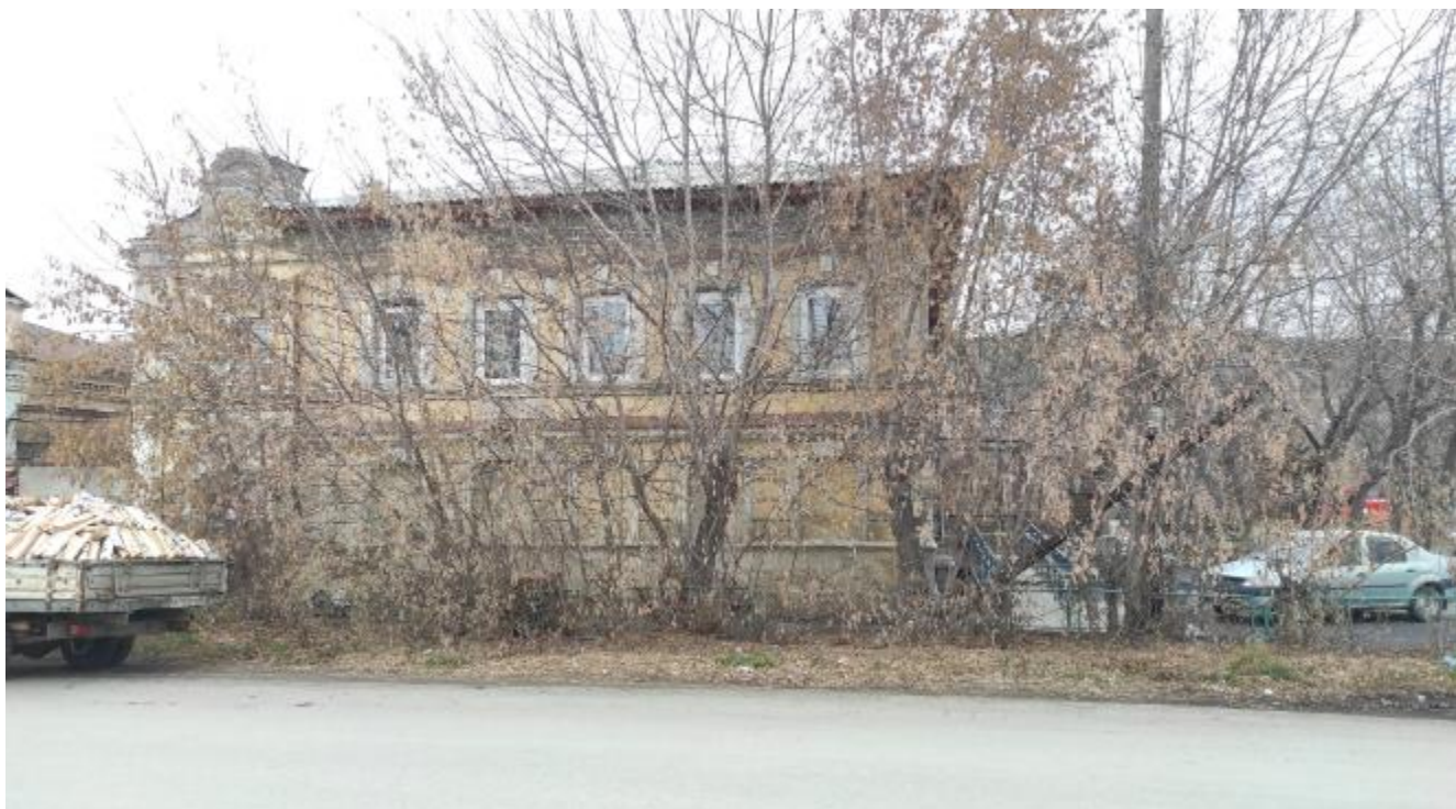
Фото 14. Вид на выявленный объект культурного наследия «Банк», расположенный по адресу: Челябинская область, Миасский городской округ, г. Миасс, ул. Спорта, 3.
