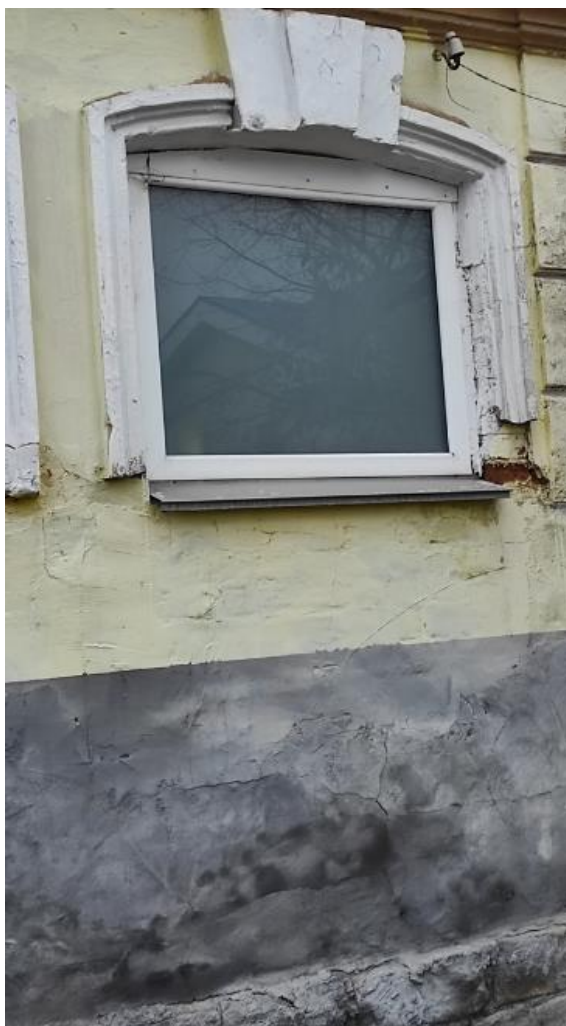
Фото 12. Вид на выявленный объект культурного наследия «Банк», расположенный по адресу: Челябинская область, Миасский городской округ, г. Миасс, ул. Спорта, 3.
