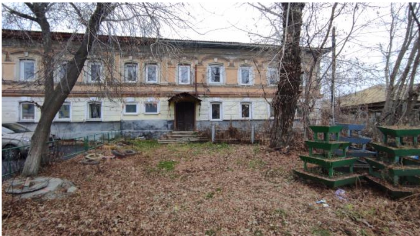
Фото 18. Вид на выявленный объект культурного наследия «Банк», расположенный по адресу: Челябинская область, Миасский городской округ, г. Миасс, ул. Спорта, 3.
