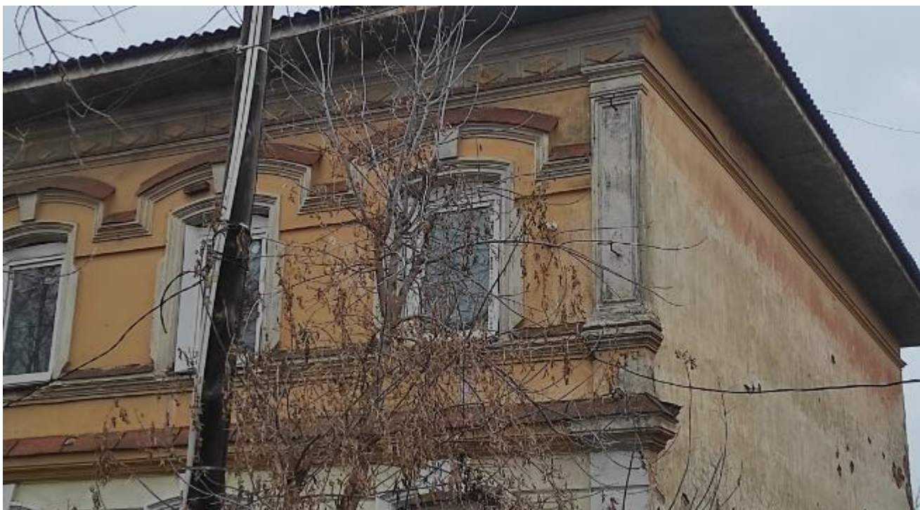
Фото 17. Вид на выявленный объект культурного наследия «Банк», расположенный по адресу: Челябинская область, Миасский городской округ, г. Миасс, ул. Спорта, 3.
