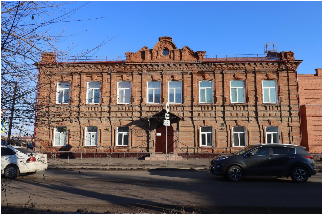
Фото 2. Вид на выявленный объект культурного наследия «Здание приходской школы», расположенный по адресу: Челябинская область, Троицкий городской округ, г. Троицк, ул. Красноармейская, 36.
