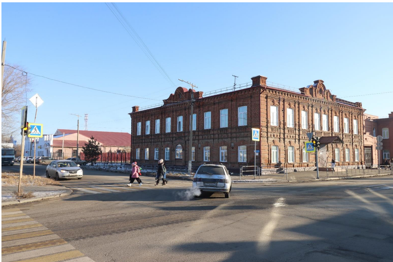
Фото 3. Вид на выявленный объект культурного наследия «Здание приходской школы», расположенный по адресу: Челябинская область, Троицкий городской округ, г. Троицк, ул. Красноармейская, 36.
