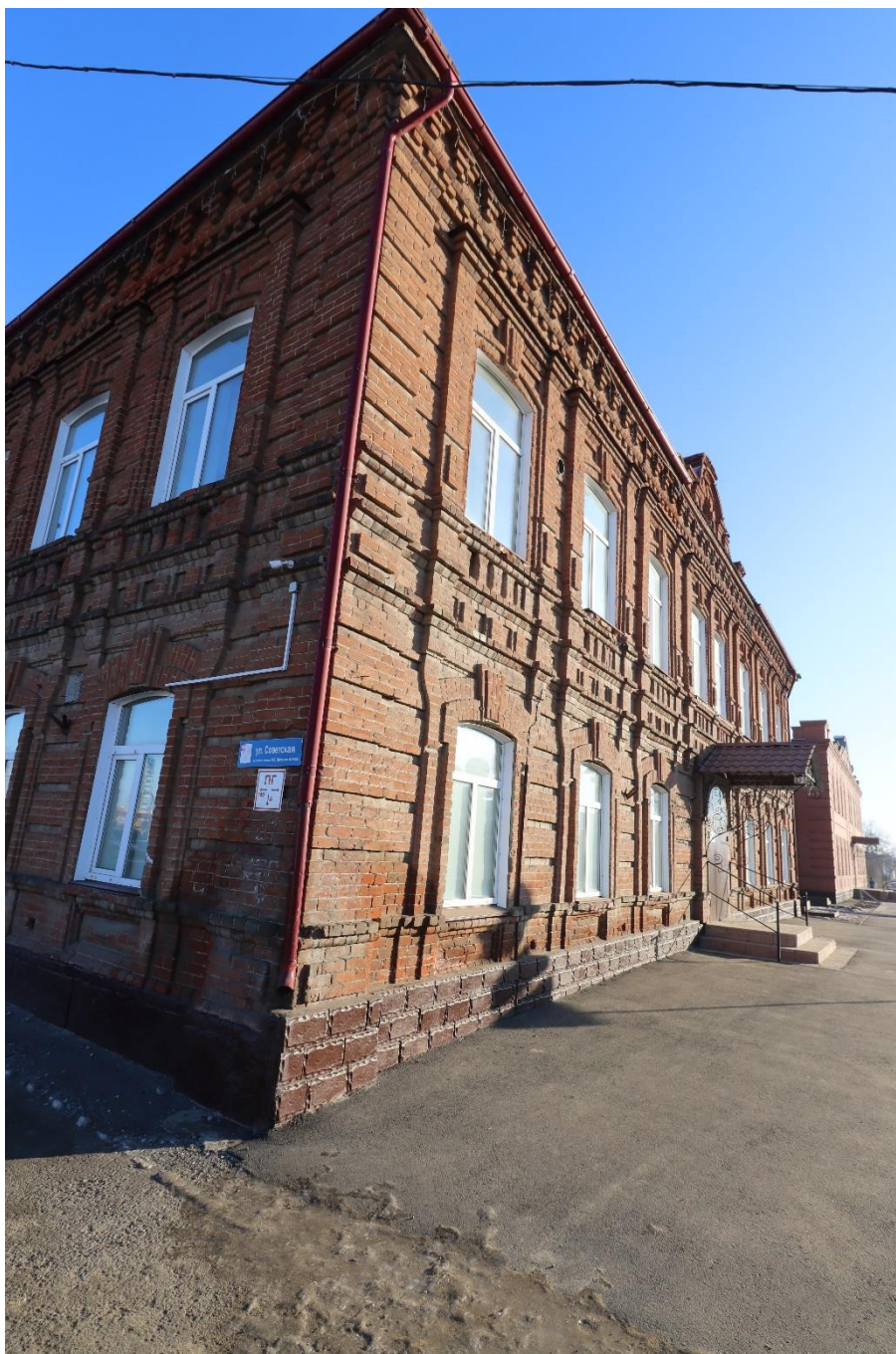
Фото 9. Вид на выявленный объект культурного наследия «Здание приходской школы», расположенный по адресу: Челябинская область, Троицкий городской округ, г. Троицк, ул. Красноармейская, 36.
