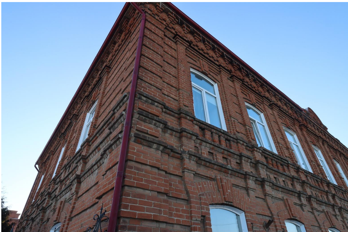
Фото 7. Вид на выявленный объект культурного наследия «Здание приходской школы», расположенный по адресу: Челябинская область, Троицкий городской округ, г. Троицк, ул. Красноармейская, 36.
