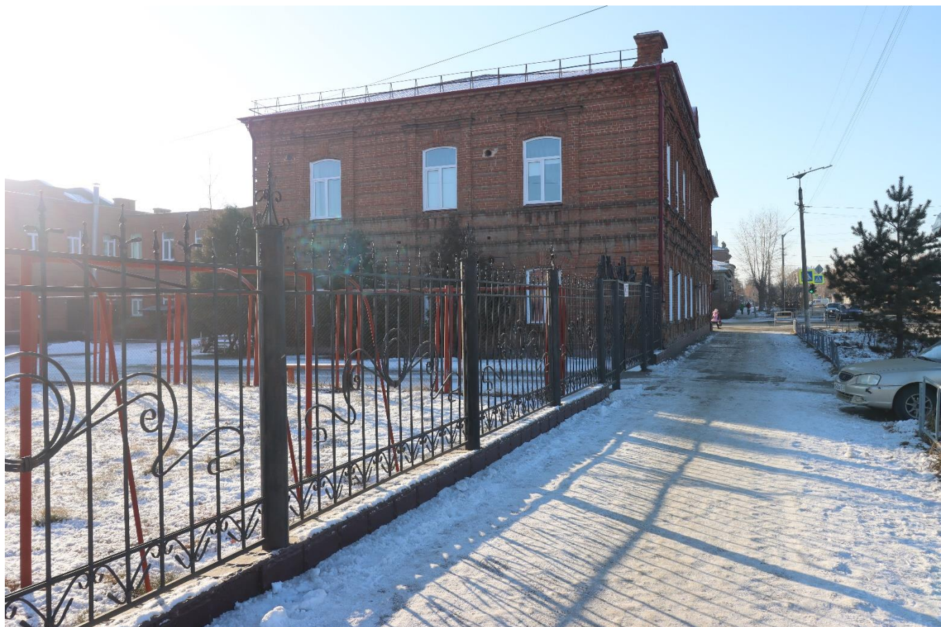
Фото 6. Вид на выявленный объект культурного наследия «Здание приходской школы», расположенный по адресу: Челябинская область, Троицкий городской округ, г. Троицк, ул. Красноармейская, 36.
