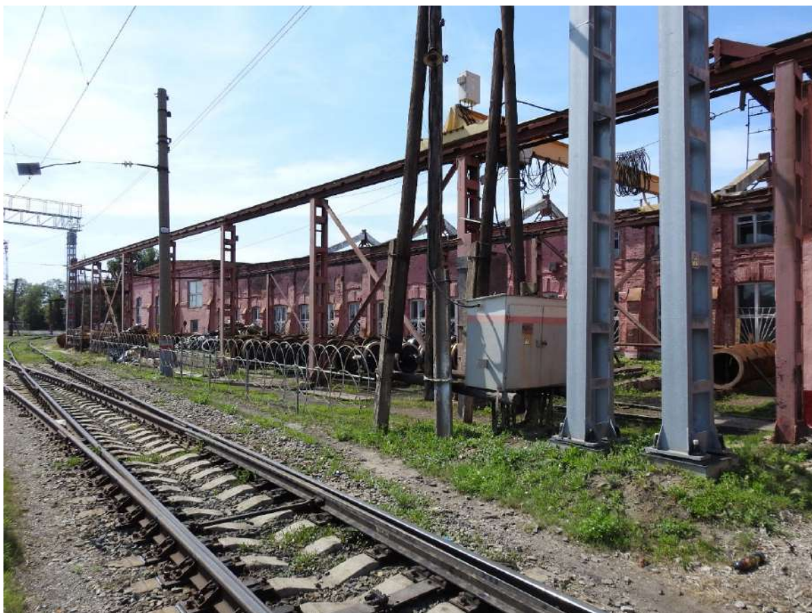
Фото 8. Фрагмент северного фасада Объекта. Вид с северной стороны.
