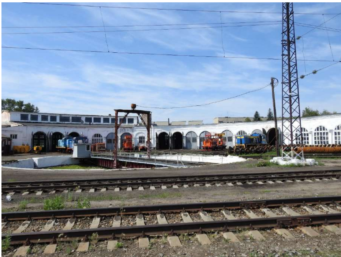
Фото 2. Вид на фрагмент восточного фасада Объекта.
