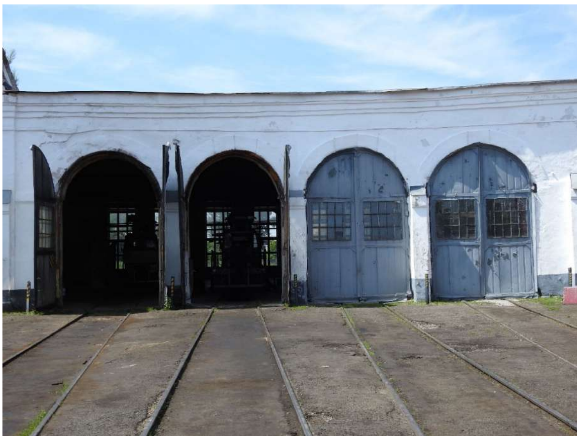
Фото 25. Вид на ворота для выезда тепловозов. Фрагмент восточного фасада Объекта.
