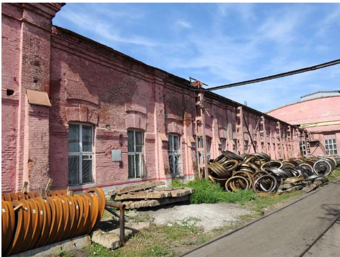
Фото 5. Фрагмент северного фасада Объекта.
