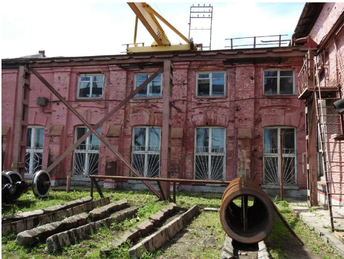
Фото 20. Фрагмент северного фасада Объекта.
