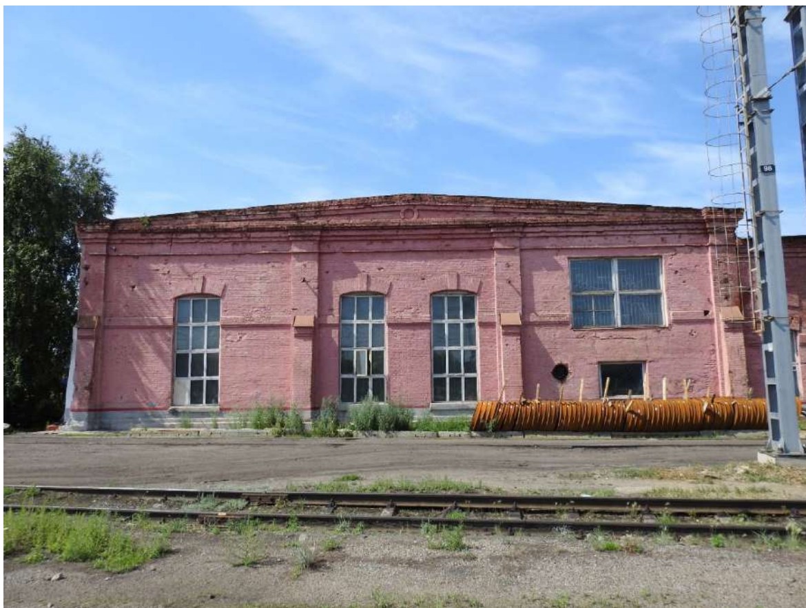
Фото 4. Фрагмент северного фасада Объекта.
