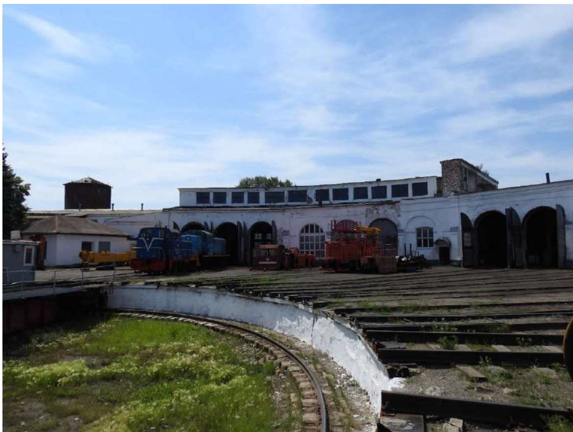
Фото 24. Фрагмент восточного фасада Объекта.
