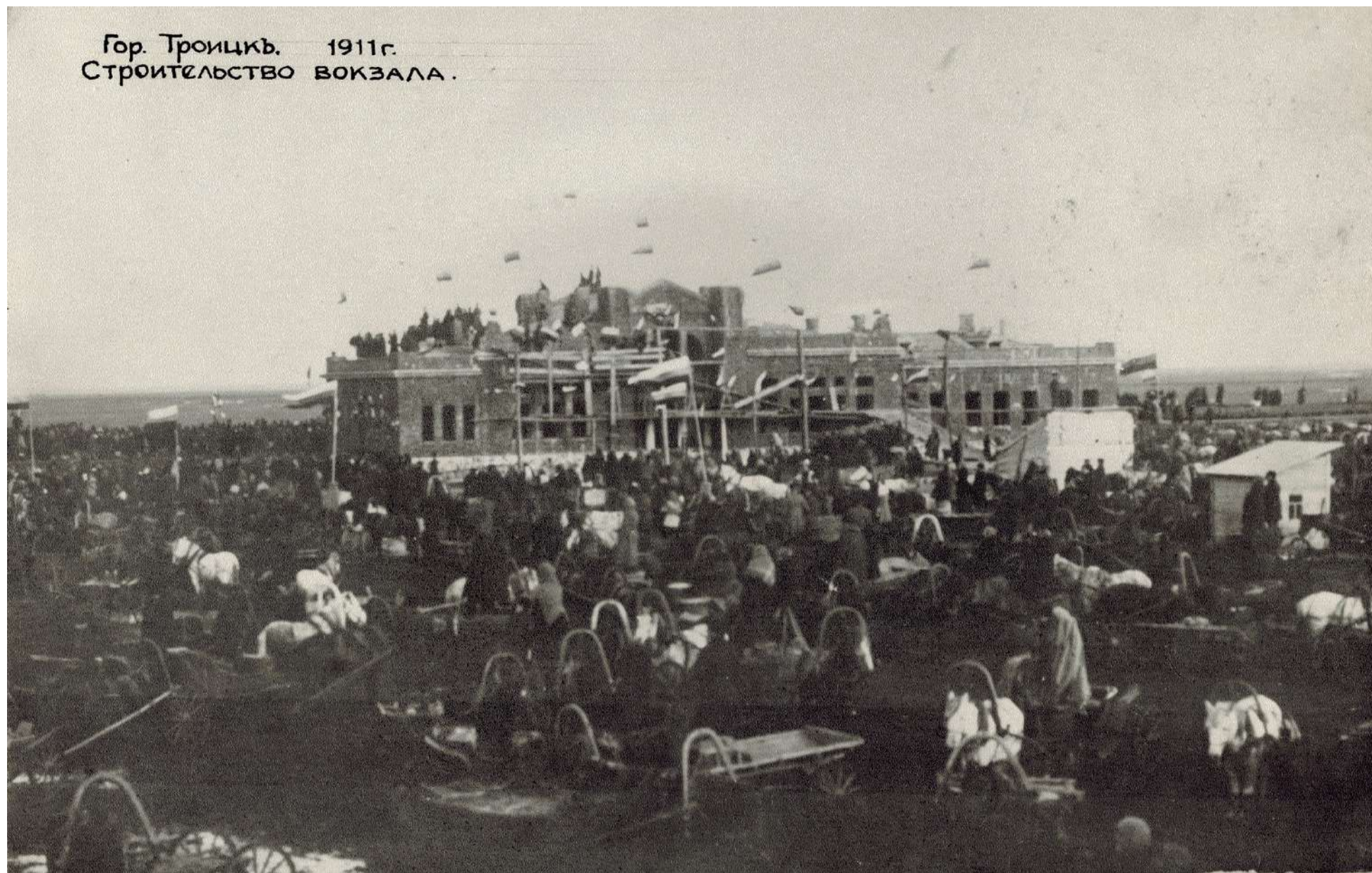
22. Строительство Троицкого вокзала. 1911 год.
