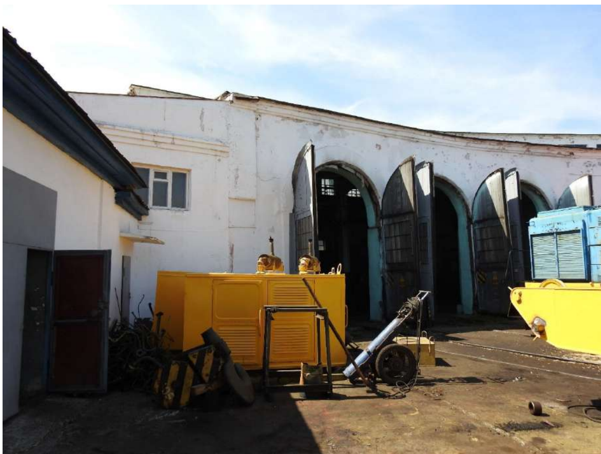
Фото 19. Фрагмент входной группы восточного фасада Объекта.
