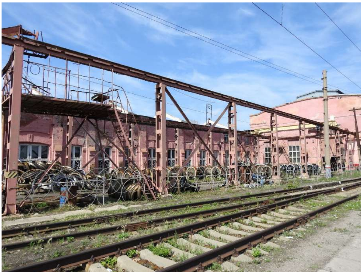
Фото 6. Фрагмент северного фасада Объекта.
