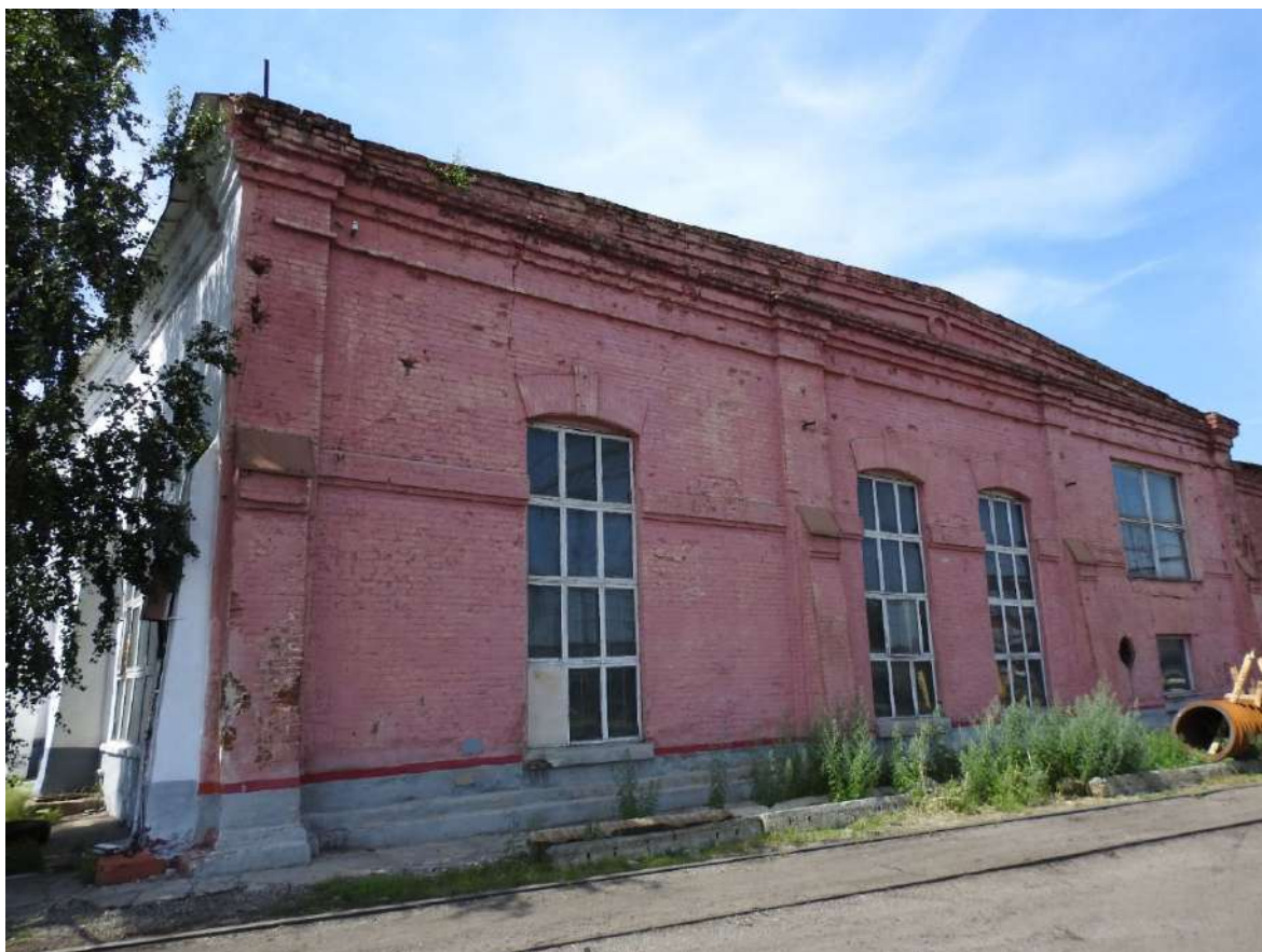
Фото 22. Фрагмент северного фасада Объекта.
