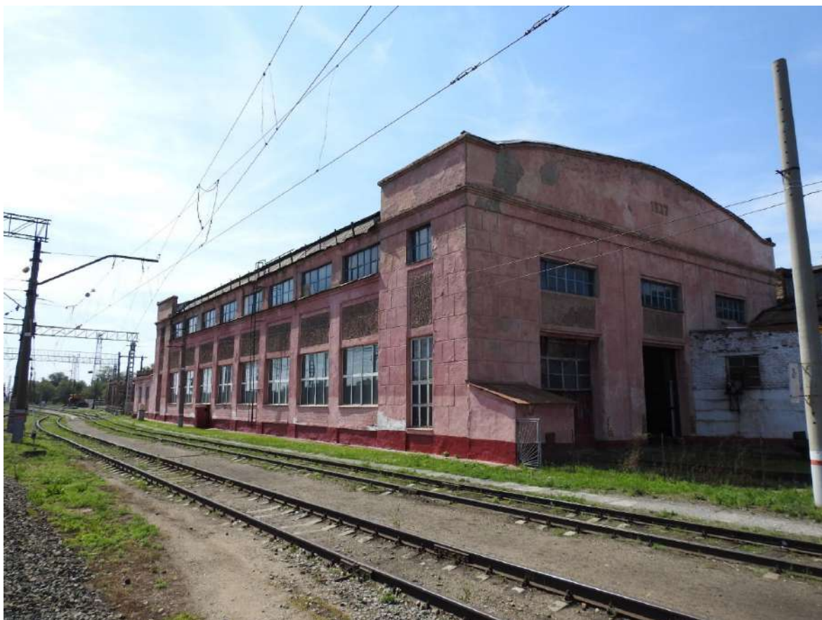
Фото 10. Вид на пристрой к Объекту (1937 г.).
