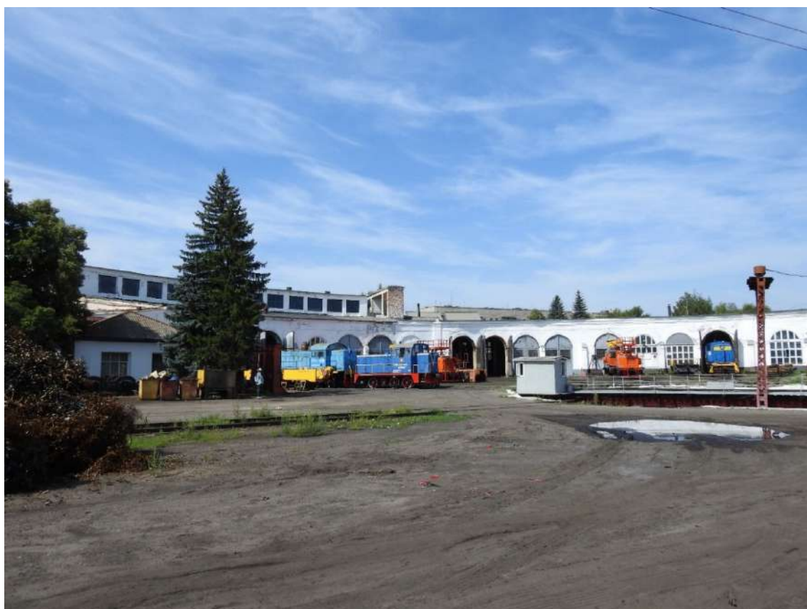
Фото 1. Вид на фрагмент восточного фасада Объекта.
