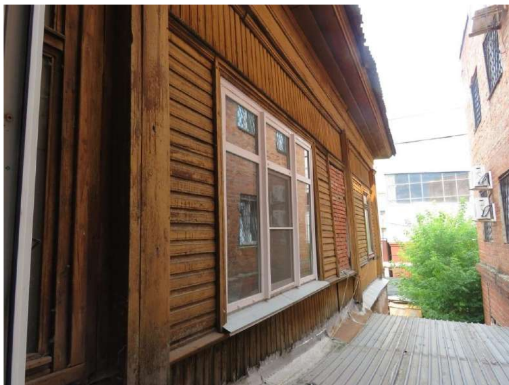
Рис. 18. Фрагмент второго этажа бокового, восточного фасада основного объема и кровля позднего пристроя (литера А3) между ОКН и соседним зданием по адресу ул. Маркса, 68
