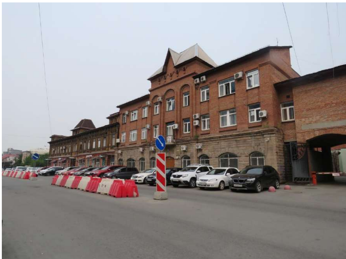
Рис. 1. Вид объекта в застройке ул. Маркса. Вид с юго-востока
