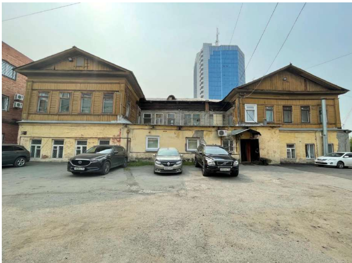
Рис. 14. Дворовый, северный фасад. Вид с севера
