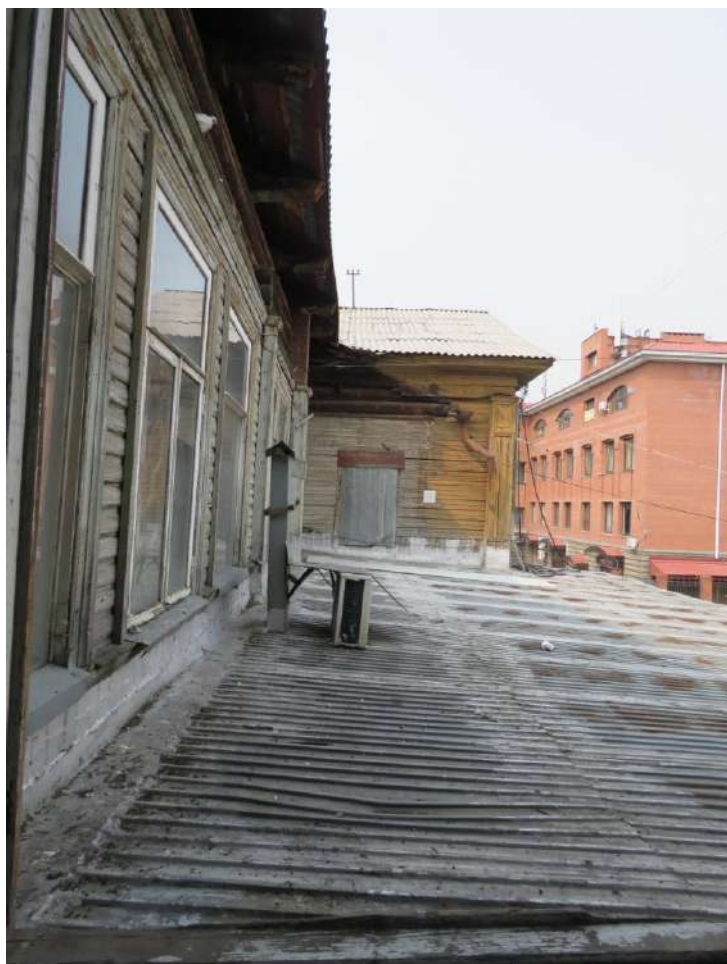
Рис. 17. Фрагмент второго этажа дворового, северного фасада. Кровля позднего пристроя (литера А1)
