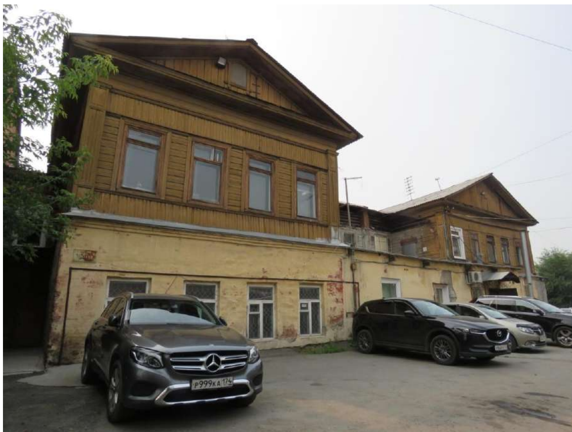
Рис. 13 а, б. Дворовый, северный фасад. Вид с северо-запада (вверху) и северо-востока (внизу)
