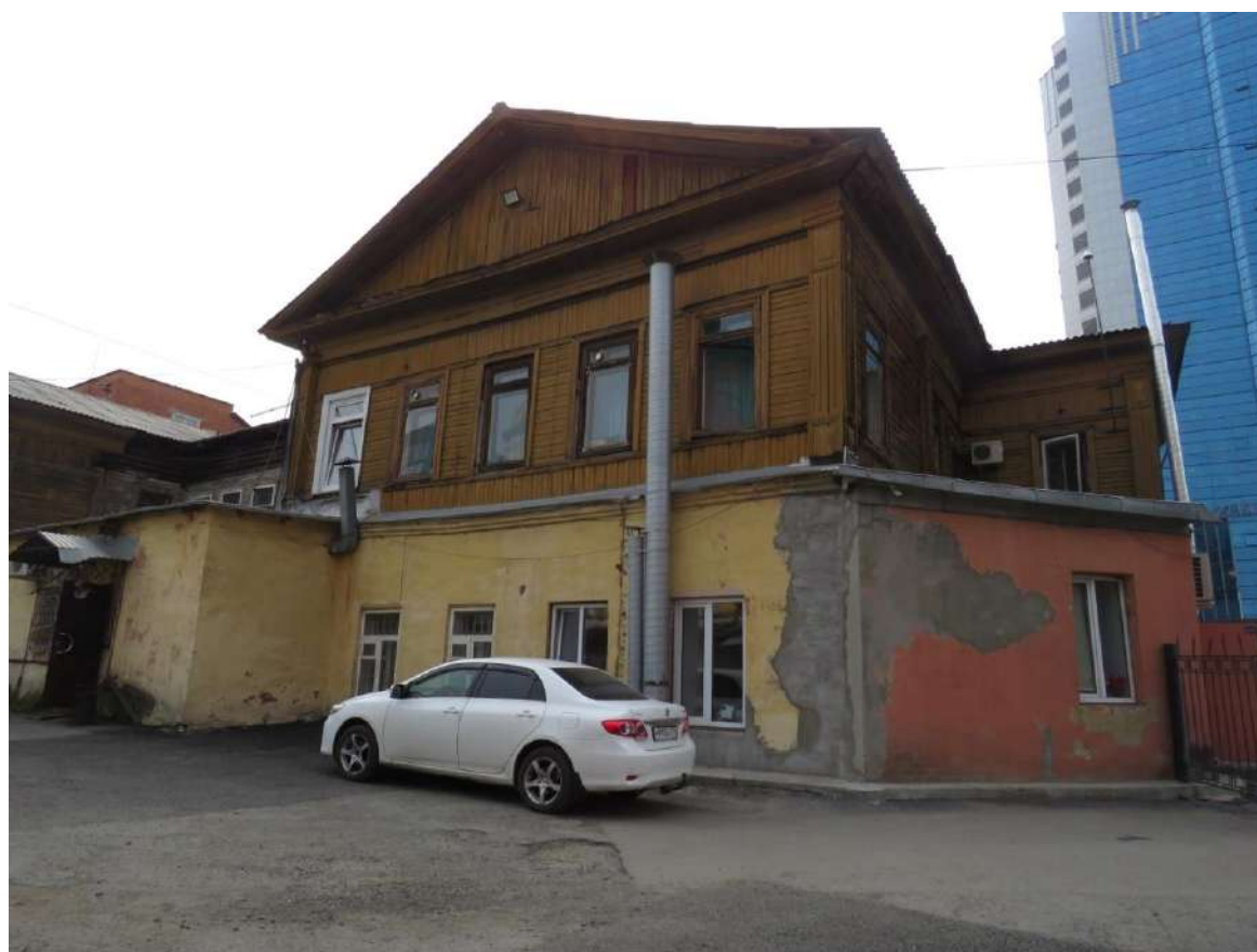
Рис. 12 а, б. Боковой, западный фасад с поздним пристроем (литера А2). Вид с запада (вверху) и северо-запада (внизу)
