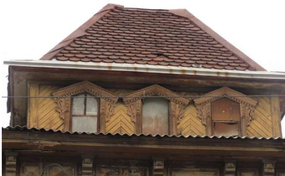
Рис. 6 а, б. Фрагмент главного фасада. Решение средней оси. Заложенный проем въезда и размещенный на его месте входной проем в помещение на месте арки (внизу). Надстройка-светелка по средней оси фасада (вверху)
