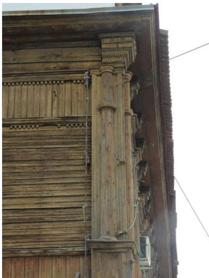
Рис. 10. Оформление углового стыка главного, южного фасада и бокового, западного фасада
