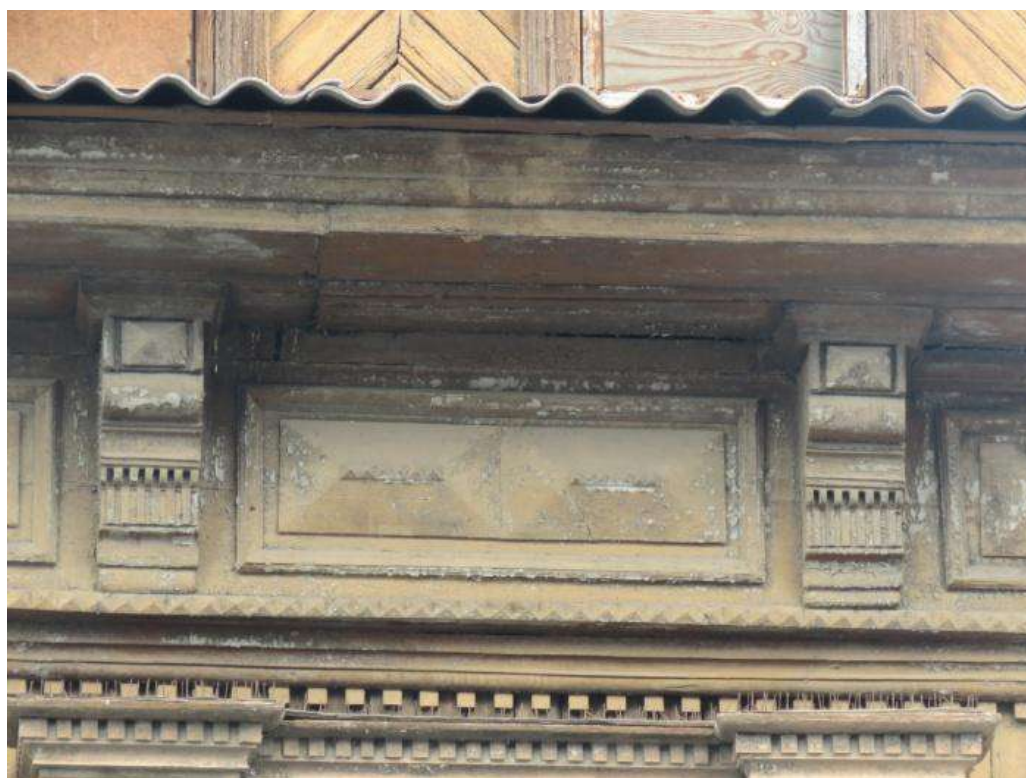
Рис. 11. Фрагмент оформления подкарнизной доски и карниза
