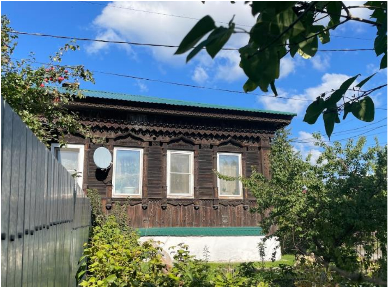
Фото 8. Выявленный объект культурного наследия «Дом жилой», расположенный по адресу: Челябинская область, Кыштымский городской округ, г. Кыштым, ул. Володарского,1. Фрагмент южного фасада выявленного объекта культурного наследия в северном направлении.
