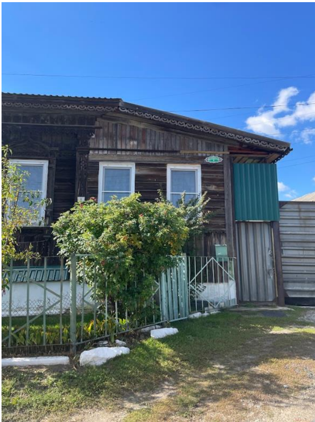
Фото 4. Выявленный объект культурного наследия «Дом жилой», расположенный по адресу: Челябинская область, Кыштымский городской округ, г. Кыштым, ул. Володарского,1. Фрагмент восточного фасада выявленного объекта культурного наследия.
