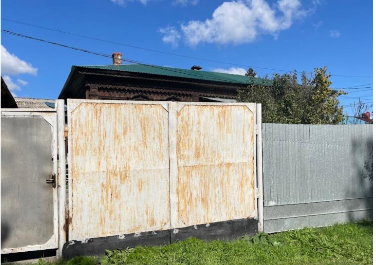
Фото 11. Выявленный объект культурного наследия «Дом жилой», расположенный по адресу: Челябинская область, Кыштымский городской округ, г. Кыштым, ул. Володарского,1. Фрагмент южного фасада выявленного объекта культурного наследия.
