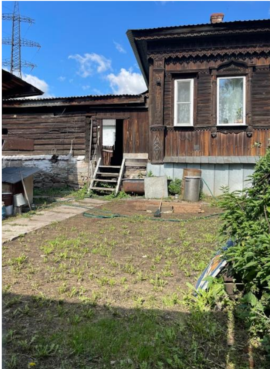
Фото 9. Выявленный объект культурного наследия «Дом жилой», расположенный по адресу: Челябинская область, Кыштымский городской округ, г. Кыштым, ул. Володарского,1. Фрагмент южного фасада выявленного объекта культурного наследия в северном направлении.
