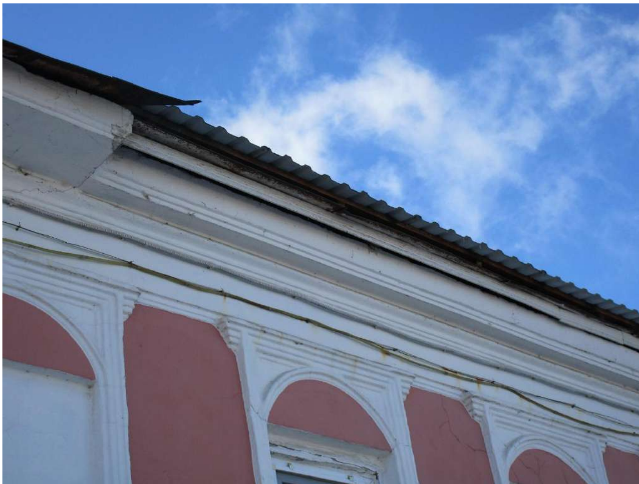
7. Северо-восточный фасад. Карниз пристроенного объема. Октябрь 2023 г.
