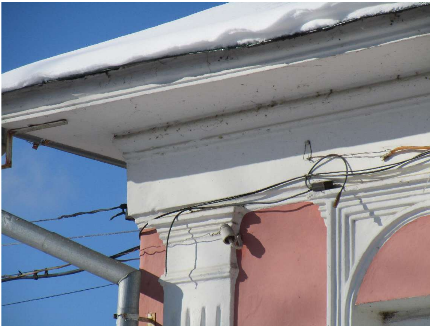
5. Левая часть юго-восточного фасада. Фриз, лепной карниз, свесы крыши широкого выноса. Октябрь 2023 г.
