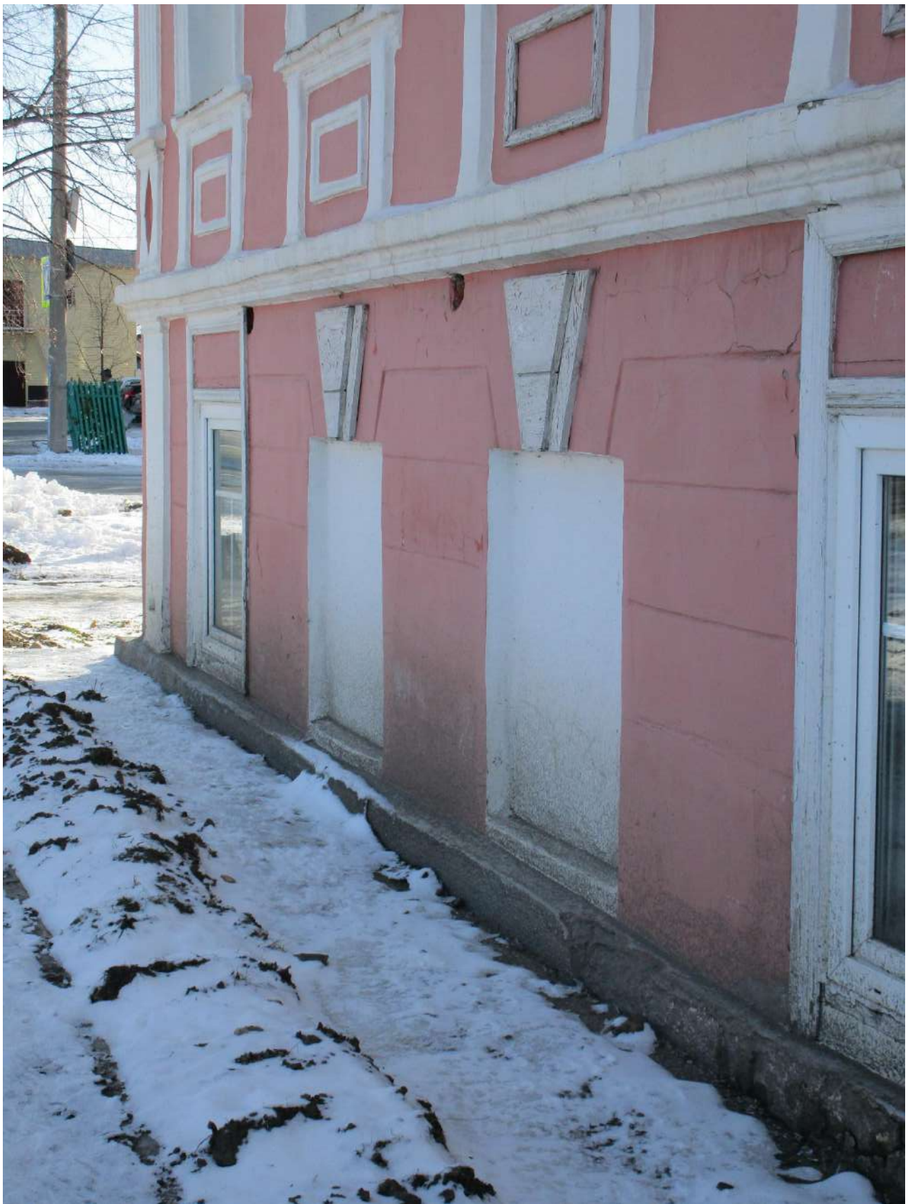
11. Фрагмент северо-восточного фасада. Поздние докомпановки (дерево) замковых камней и оконных наличников.
