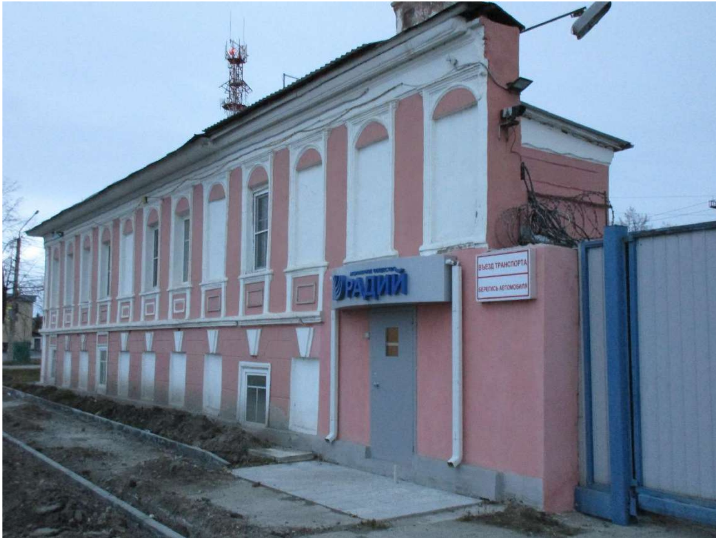
б. Северо-восточный фасад. Октябрь 2023 г.
