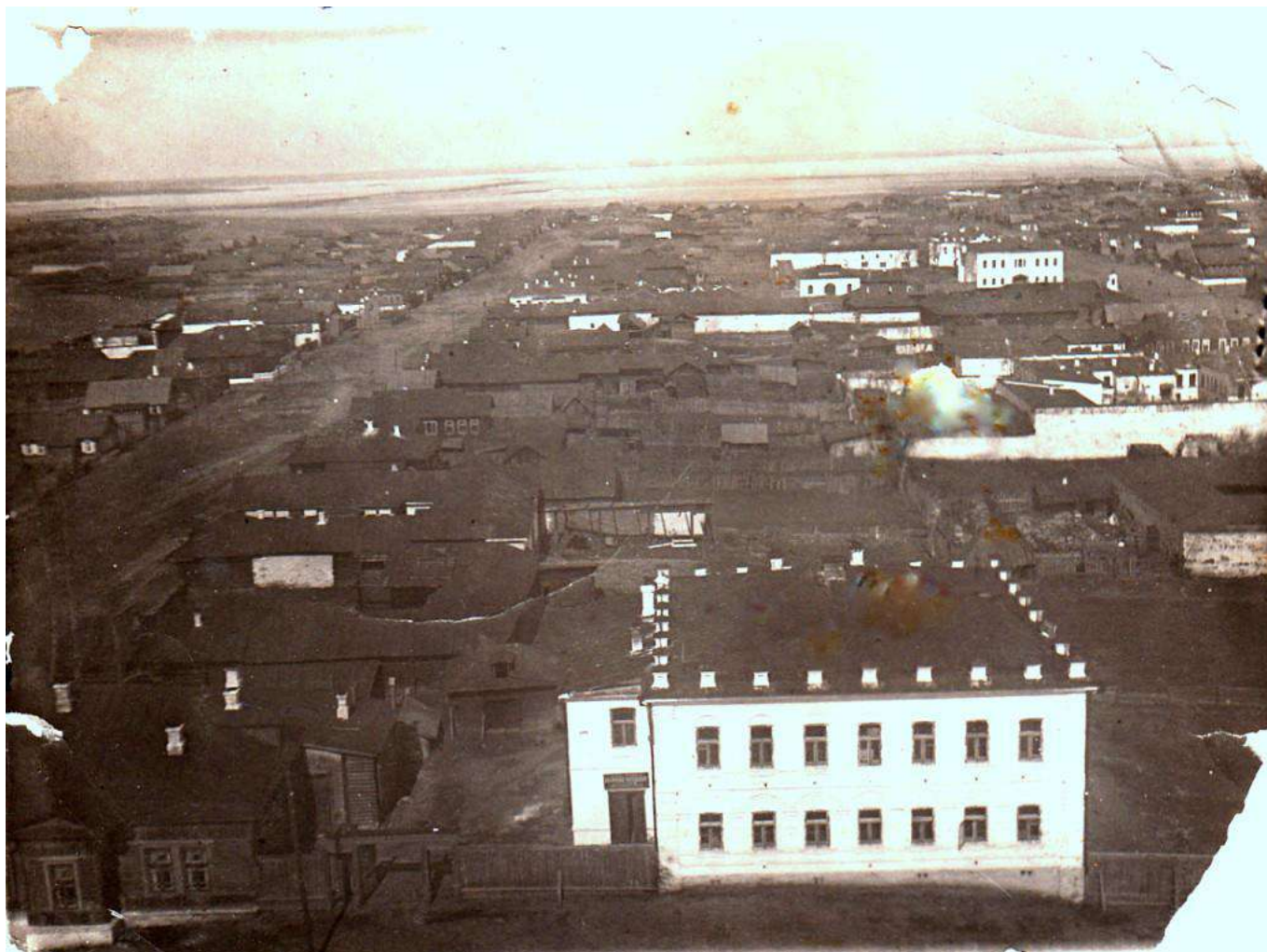
3. Историческое фото. Вид со стороны заводоуправления.
