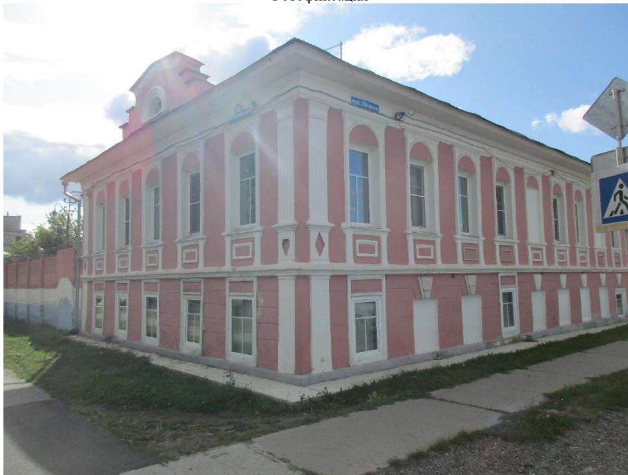
1. Вид с востока. Август 2023 г.
