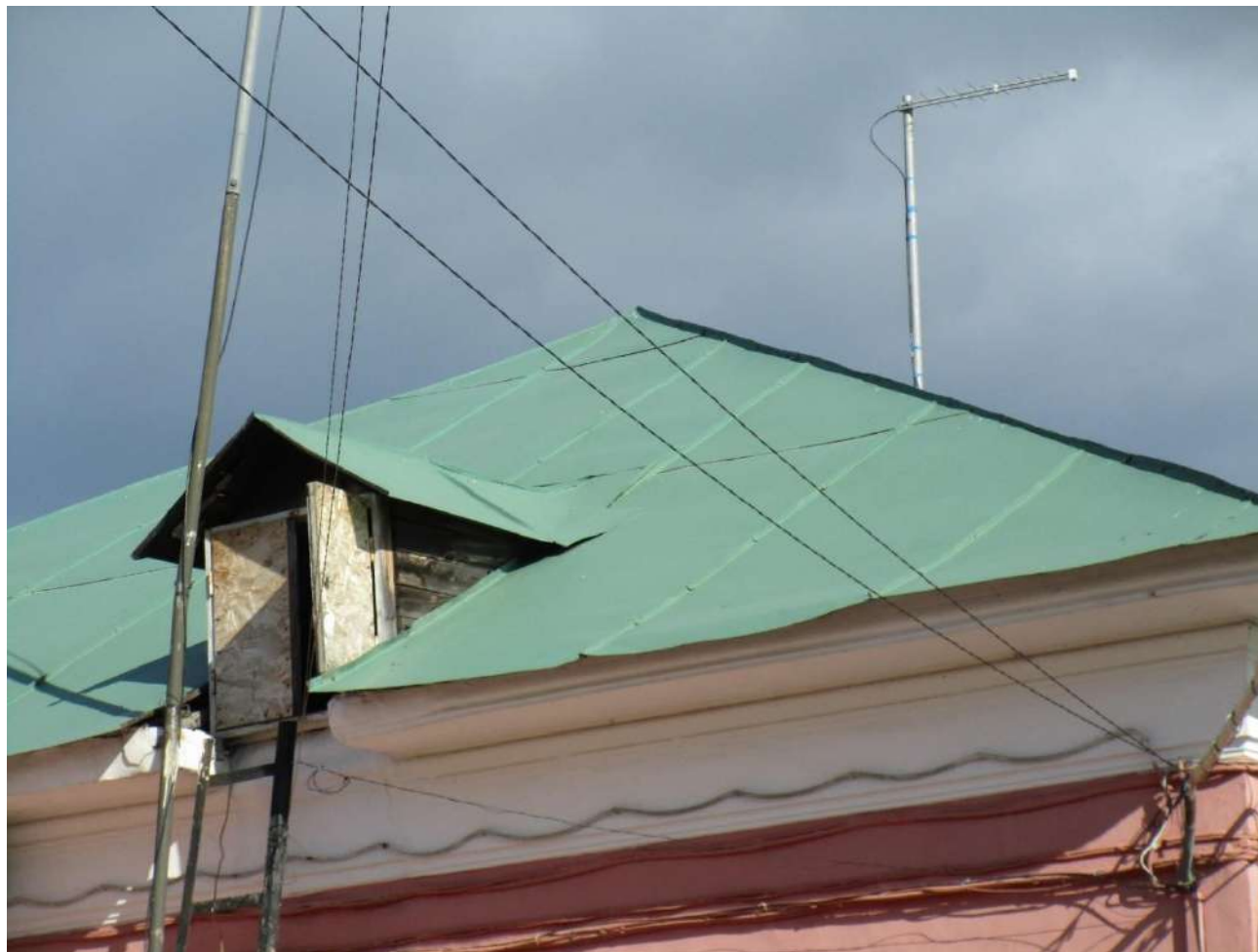
14. Выпускное окно. Кровля фальцевая. Август 2023 г.
