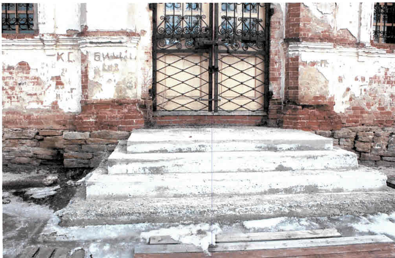
Фото 9. Крыльцо южного входа
