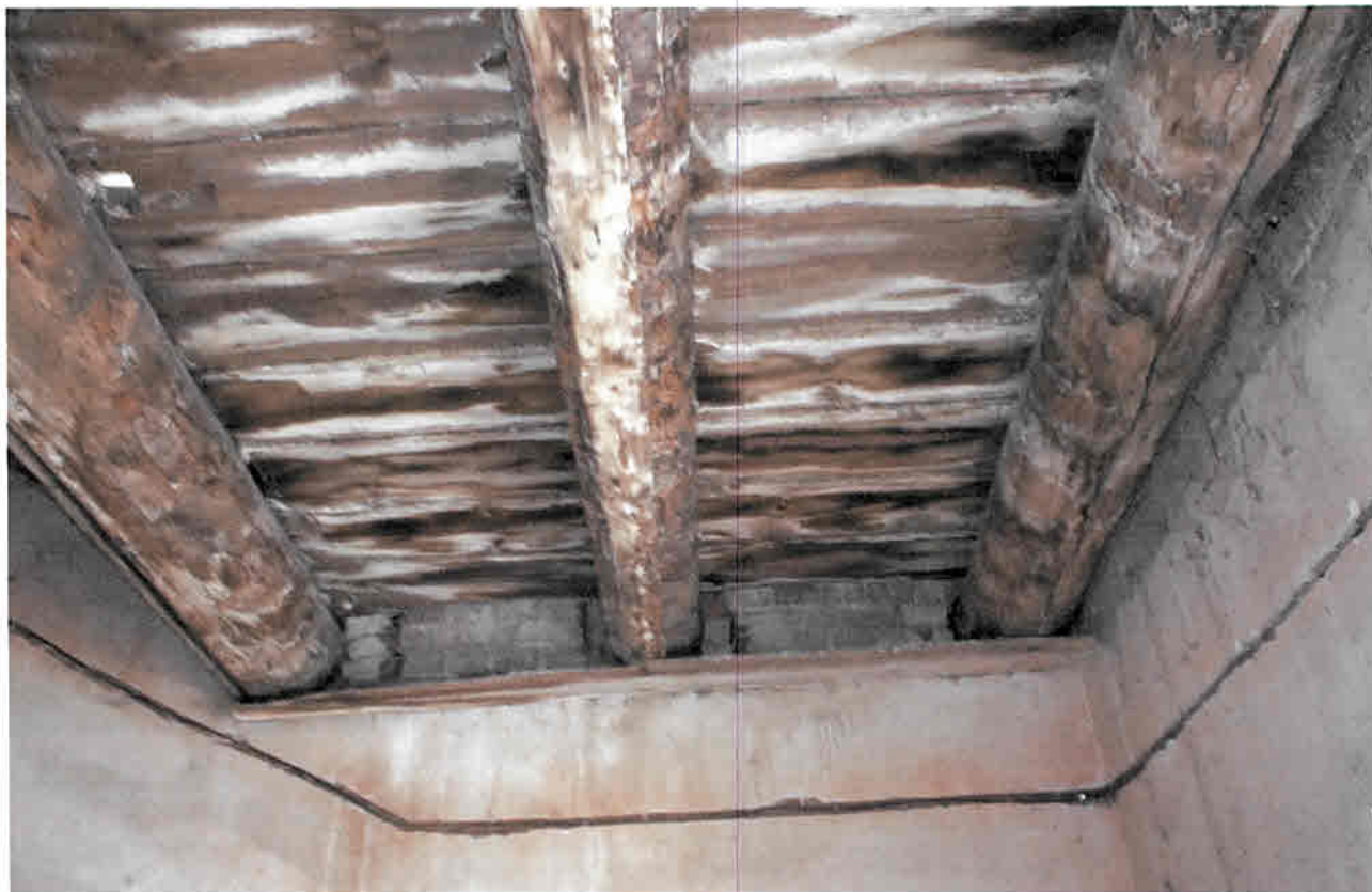
Фото 21. Балки и настил лестничной площадки
