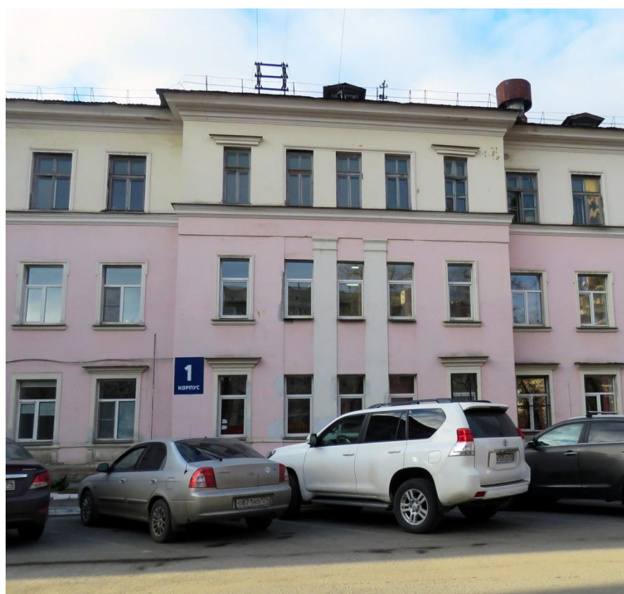
Рис. 19. Боковой, западный, ризалит юго-восточного фасада прямоугольного корпуса, идентичный по решению восточному ризалиту. Фото 2017 г.
