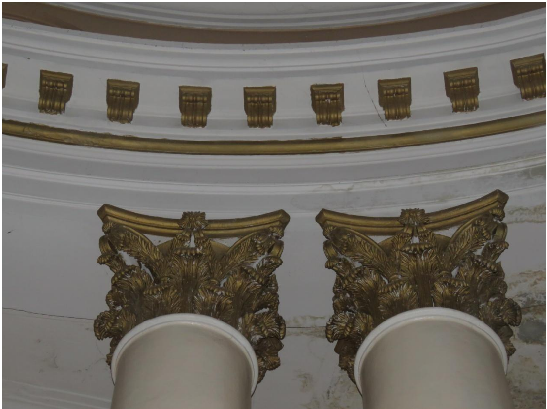
Рис. 35. Цилиндрический объем лекционной аудитории. Лекционная аудитория. Капители колонн сцены и профилированный карниз с модульонами. Фото 2017 г.
