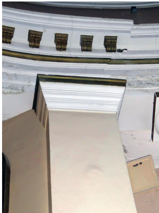
Рис. 36. Цилиндрический объем лекционной аудитории. Лекционная аудитория. Капители колонн, замыкающих амфитеатр и фрагмент фриза. Фото 2017 г.
