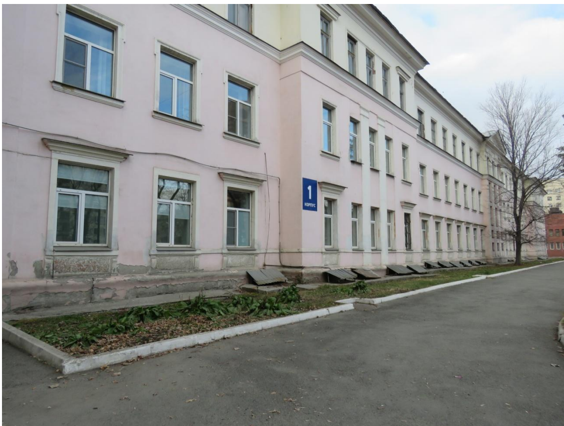
Рис. 18. Юго-восточный фасад прямоугольного корпуса. Вид с запада. Фото 2017 г.
