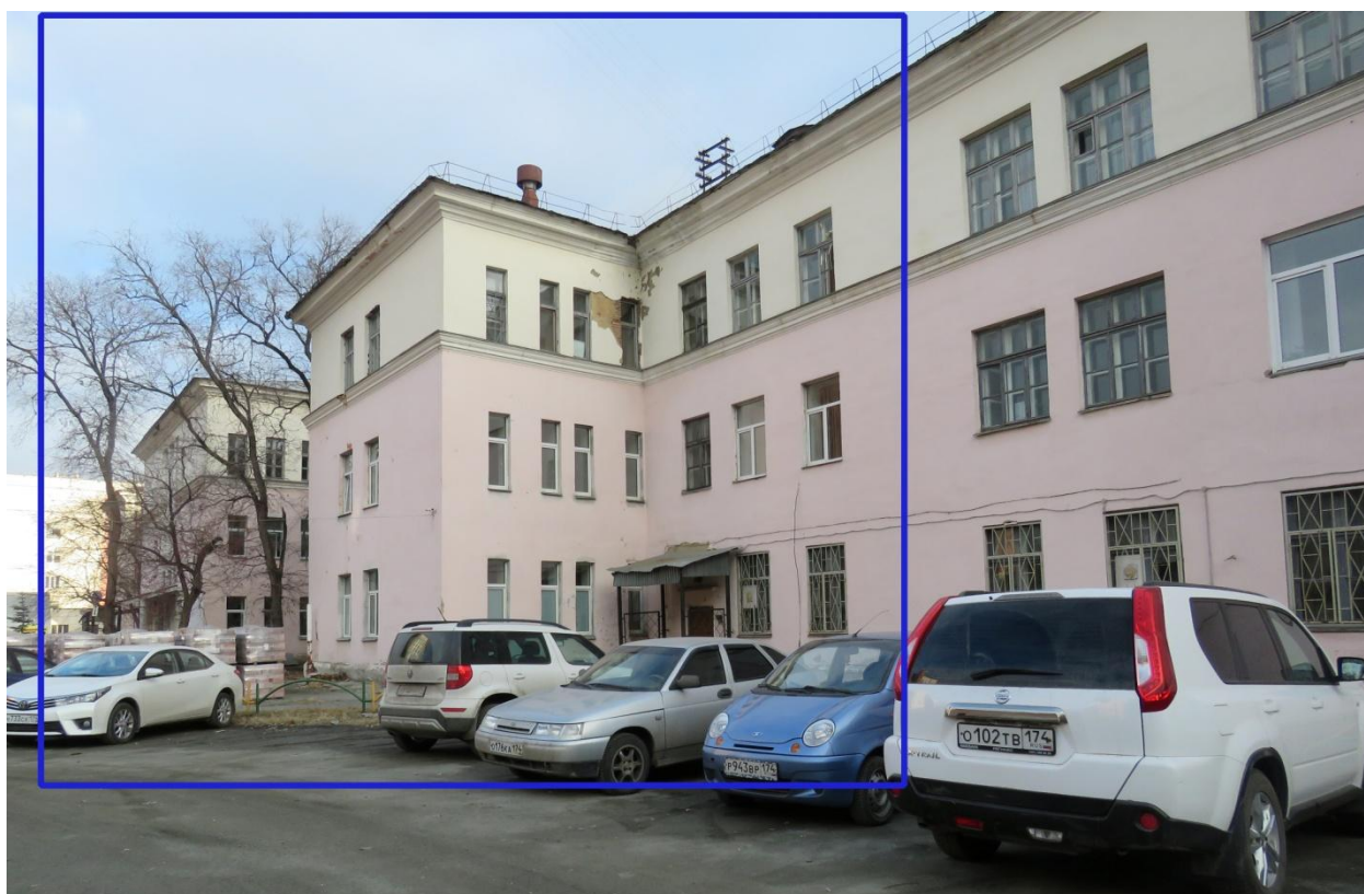
Рис. 16а,б. Фрагмент центральной (а) и западной частей (б) северо-западного фасада. На фото б синим квадратом выделен главный, прямоугольный корпус с тремя окнами правого, западного фланга. Правее – фасад примыкающего юго-западного корпуса. Фото 2017 г.
