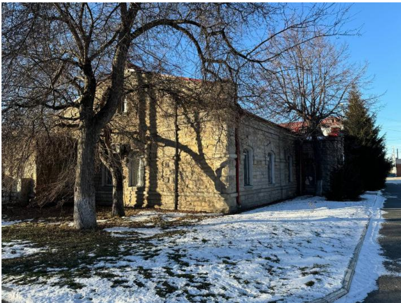
Фото 15. Вид на выявленный объект культурного наследия «Здание старого вокзала», расположенный по адресу: Челябинская область, Миасский городской округ, г. Миасс, ж/д ст. Миасс-1.
