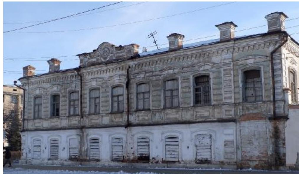
7.2.9. существующие месторасположение (на флангах фасада и входной группы), форма, габариты и оформление лопаток (на втором этаже: декорированные прямоугольными ширинками на стволе лопаток и квадратной ширинкой – в цоколе лопаток, на первом этаже: декорированные прямоугольными филёнками на стволе лопаток, без цоколей);
