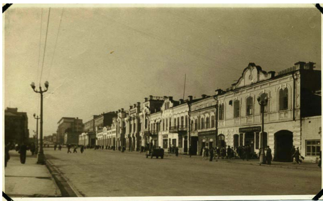
ул. Кирова. Участок от Главпочтамта до ул. Коммуны
