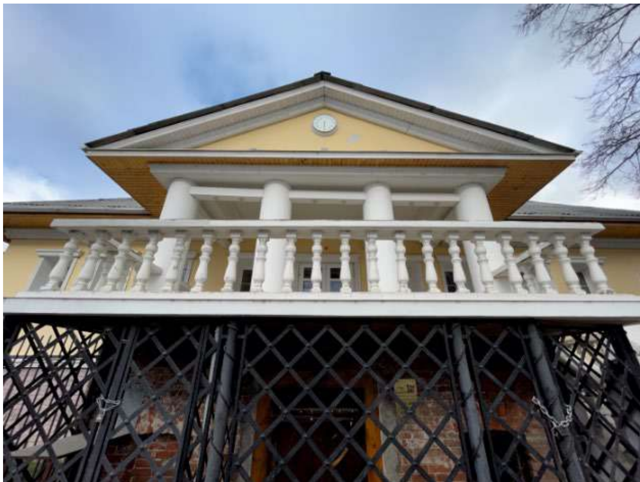
Фото 4. Выявленный объект культурного наследия «Дом купца Лесина» по адресу: Челябинская обл., г. Миасс, ул. Октябрьская, 7. Фрагмент южного фасада выявленного объекта культурного наследия.
