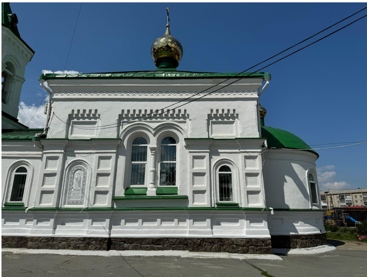
Фото 13. Вид на выявленный объект культурного наследия «Церковь Святых апостолов Петра и Павла», расположенный по адресу: Челябинская область, Коркинский муниципальный район, г. Коркино, ул. Д. Бедного, 40.
