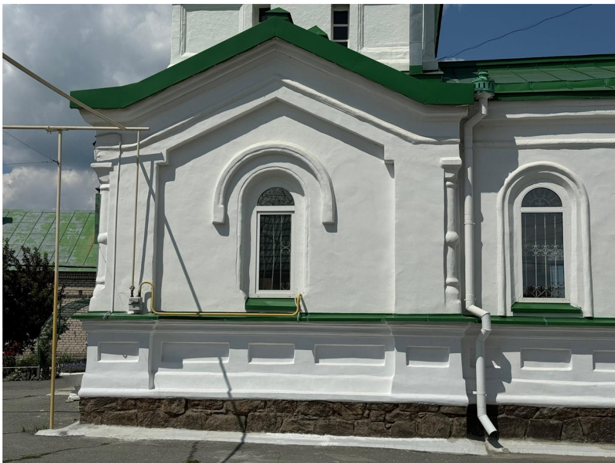
Фото 7. Вид на выявленный объект культурного наследия «Церковь Святых апостолов Петра и Павла», расположенный по адресу: Челябинская область, Коркинский муниципальный район, г. Коркино, ул. Д. Бедного, 40.
