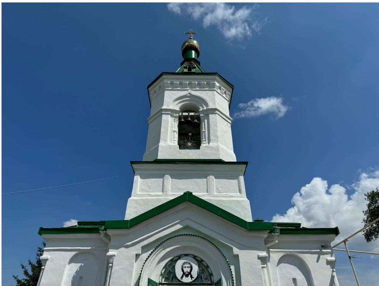
Фото 3. Вид на выявленный объект культурного наследия «Церковь Святых апостолов Петра и Павла», расположенный по адресу: Челябинская область, Коркинский муниципальный район, г. Коркино, ул. Д. Бедного, 40.
