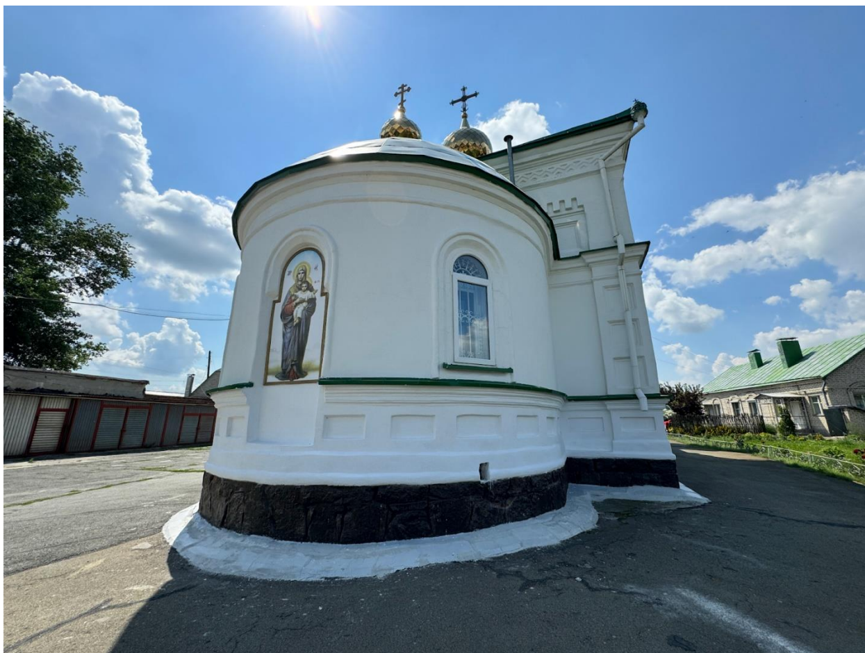
Фото 19. Вид на выявленный объект культурного наследия «Церковь Святых апостолов Петра и Павла», расположенный по адресу: Челябинская область, Коркинский муниципальный район, г. Коркино, ул. Д. Бедного, 40.
