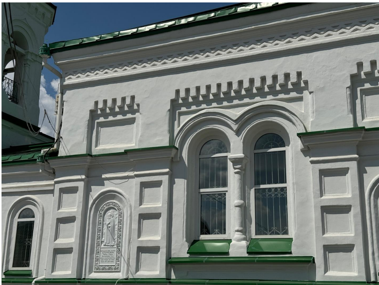
Фото 16. Вид на выявленный объект культурного наследия «Церковь Святых апостолов Петра и Павла», расположенный по адресу: Челябинская область, Коркинский муниципальный район, г. Коркино, ул. Д. Бедного, 40.
