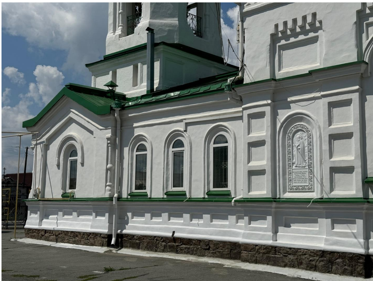
Фото 14. Вид на выявленный объект культурного наследия «Церковь Святых апостолов Петра и Павла», расположенный по адресу: Челябинская область, Коркинский муниципальный район, г. Коркино, ул. Д. Бедного, 40.
