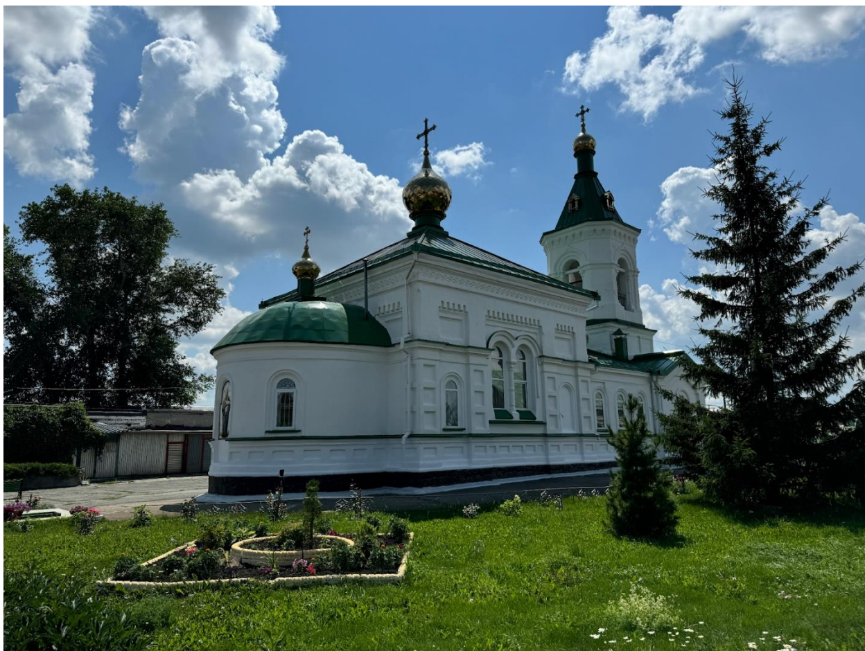
Фото 21. Вид на выявленный объект культурного наследия «Церковь Святых апостолов Петра и Павла», расположенный по адресу: Челябинская область, Коркинский муниципальный район, г. Коркино, ул. Д. Бедного, 40.
