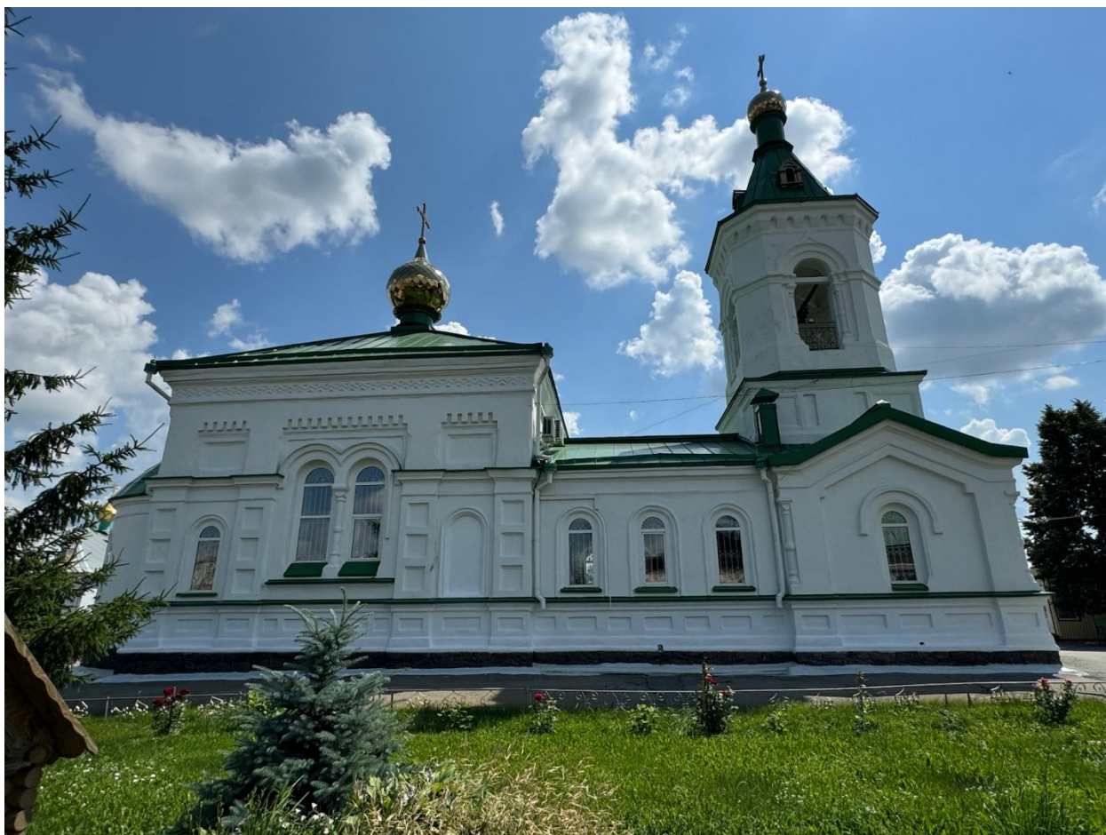
Фото 22. Вид на выявленный объект культурного наследия «Церковь Святых апостолов Петра и Павла», расположенный по адресу: Челябинская область, Коркинский муниципальный район, г. Коркино, ул. Д. Бедного, 40.
