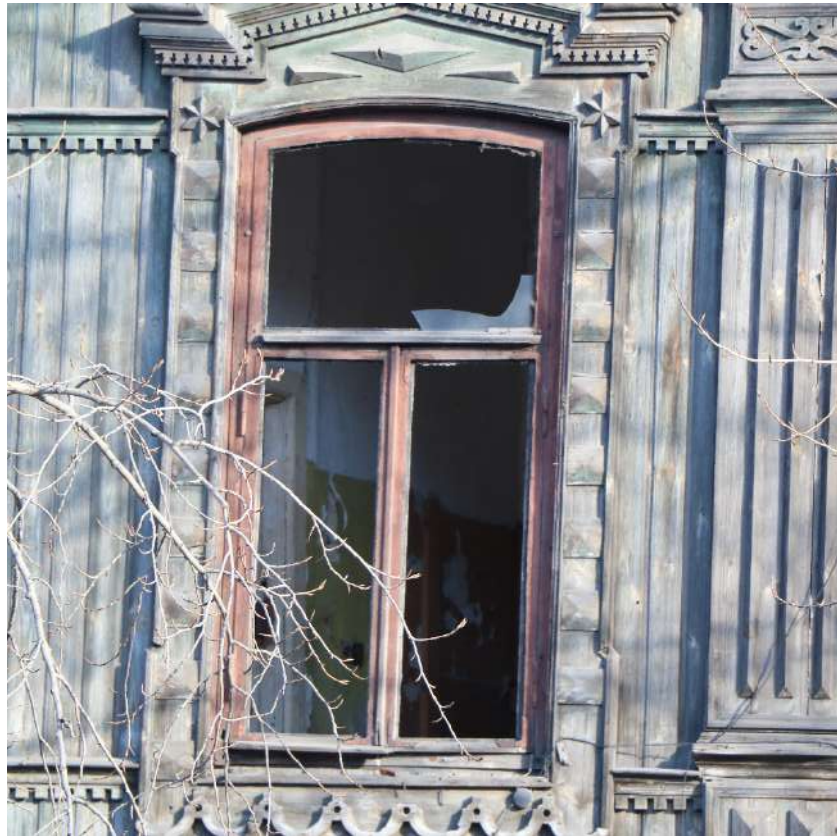
Фото 15. Выявленный объект культурного наследия. Фрагмент фасада с окном.
