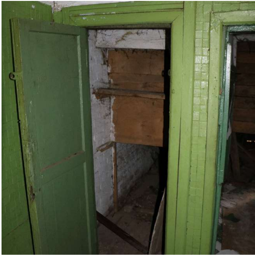
Фото 75. Выявленный объект культурного наследия. Внутреннее помещение. Дверной проем.
