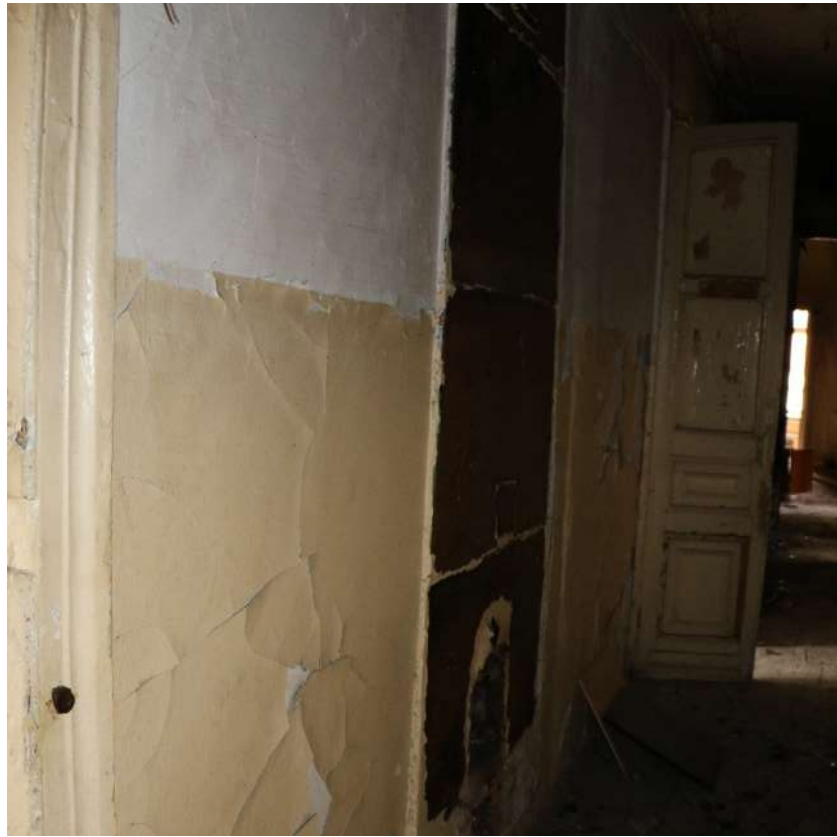
Фото 96. Выявленный объект культурного наследия. Внутреннее помещение. Фрагмент стены.
