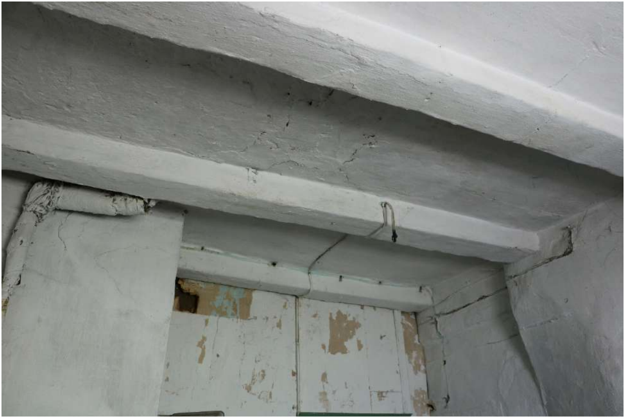
Фото 73. Выявленный объект культурного наследия. Внутреннее помещение. Фрагмент потолка и стен.
