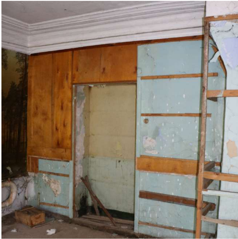
Фото 59. Выявленный объект культурного наследия. Внутреннее помещение. Фрагмент стены.
