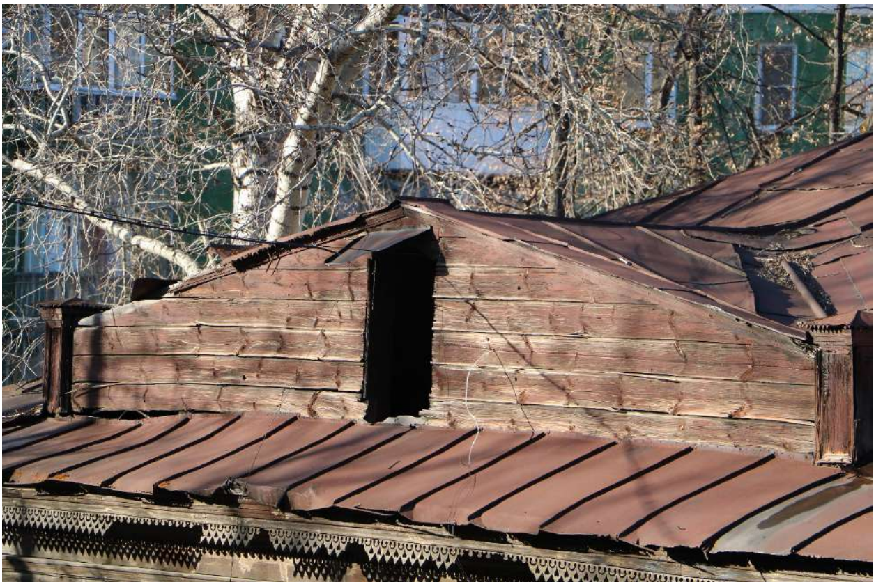
Фото 41. Выявленный объект культурного наследия. Фрагмент крыши.
