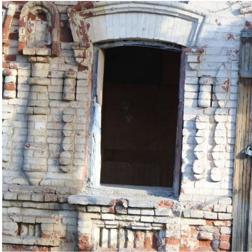
Фото 19. Выявленный объект культурного наследия. Фрагмент фасада с окном.
