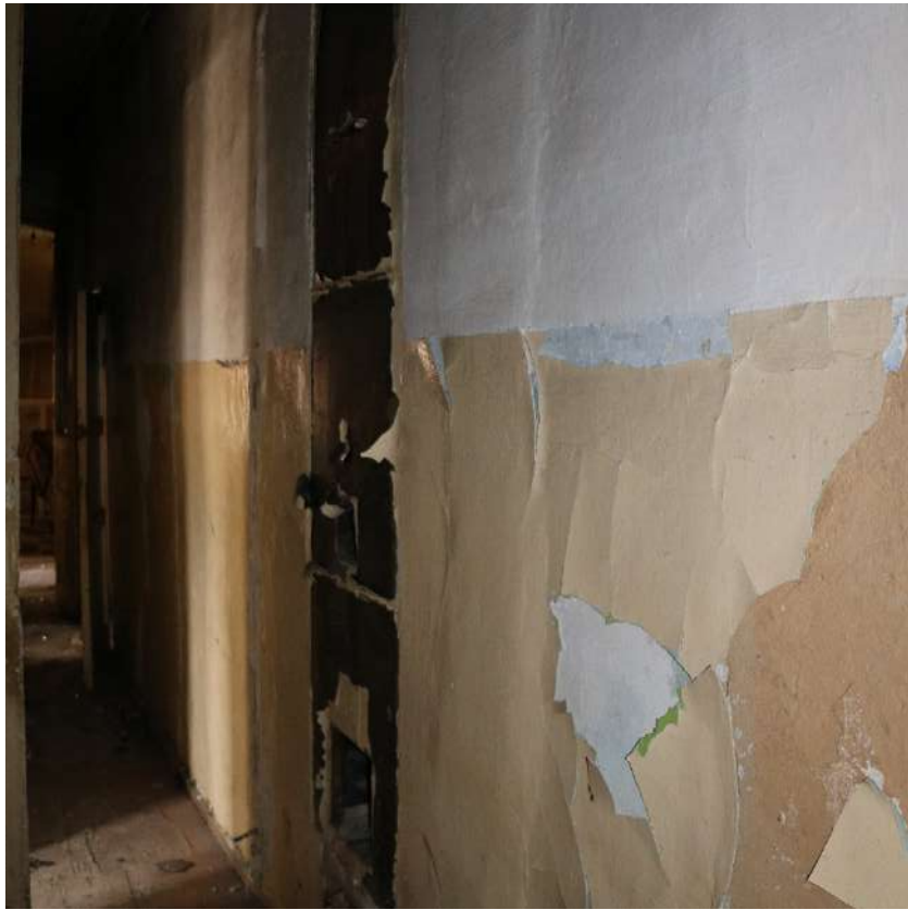
Фото 97. Выявленный объект культурного наследия. Внутреннее помещение. Фрагмент стены.
