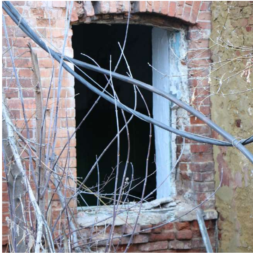
Фото 38. Выявленный объект культурного наследия. Фрагмент фасада с окном.
