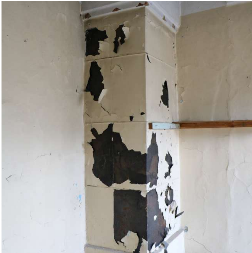
Фото 86. Выявленный объект культурного наследия. Внутреннее помещение. Фрагмент стены.
