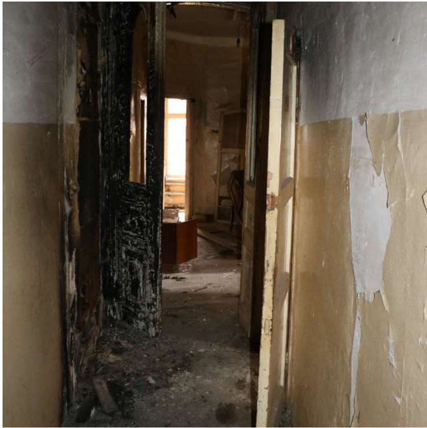
Фото 85. Выявленный объект культурного наследия. Внутреннее помещение. Коридор.
