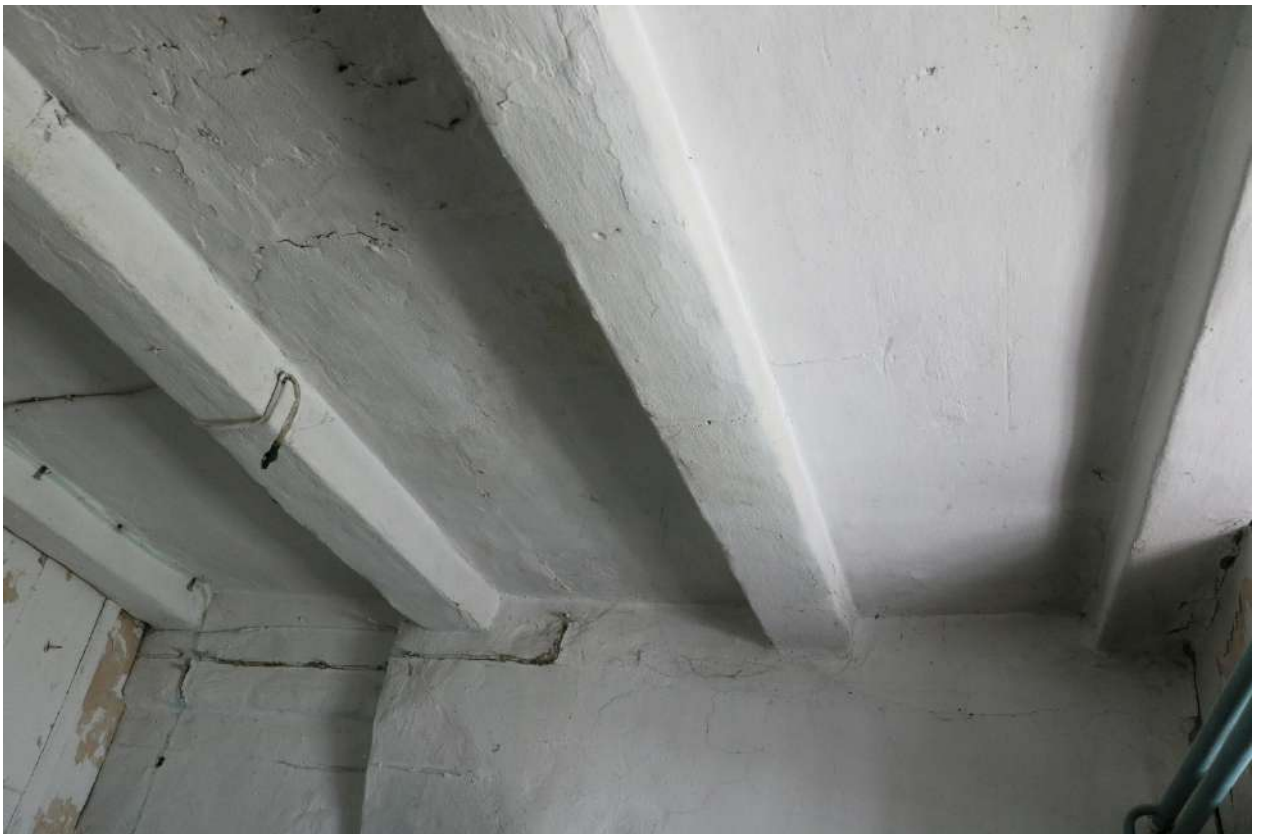
Фото 74. Выявленный объект культурного наследия. Внутреннее помещение. Фрагмент потолка и стен.
