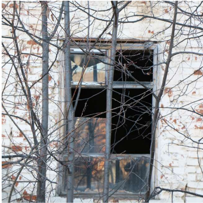
Фото 32. Выявленный объект культурного наследия. Фрагмент фасада с окном.
