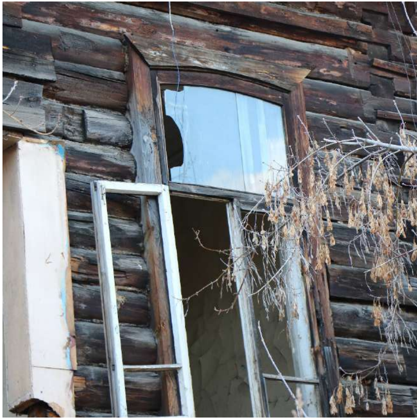
Фото 39. Выявленный объект культурного наследия. Фрагмент фасада с окном.
