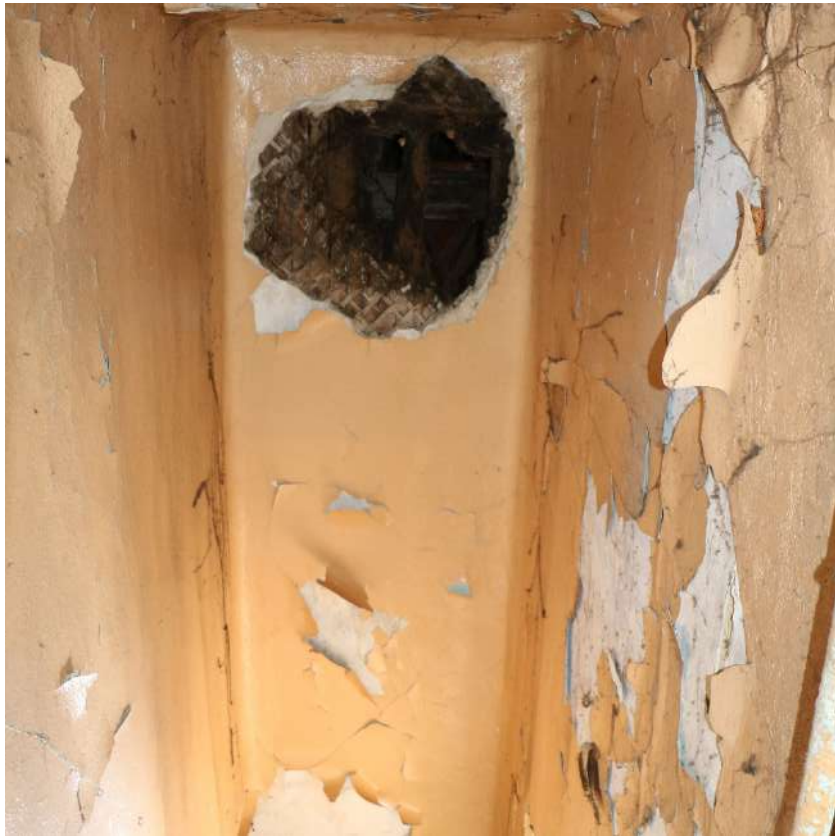
Фото 79. Выявленный объект культурного наследия. Фрагмент потолка.
