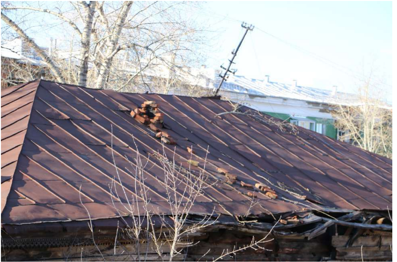
Фото 40. Выявленный объект культурного наследия. Фрагмент крыши.
