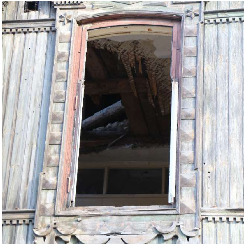
Фото 20. Выявленный объект культурного наследия. Фрагмент фасада с окном.
