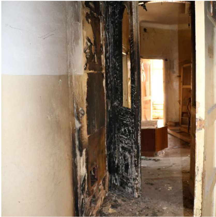
Фото 100. Выявленный объект культурного наследия. Внутреннее помещение. Коридор.
