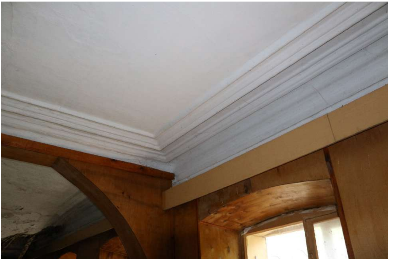
Фото 55. Выявленный объект культурного наследия. Фрагмент потолка.
