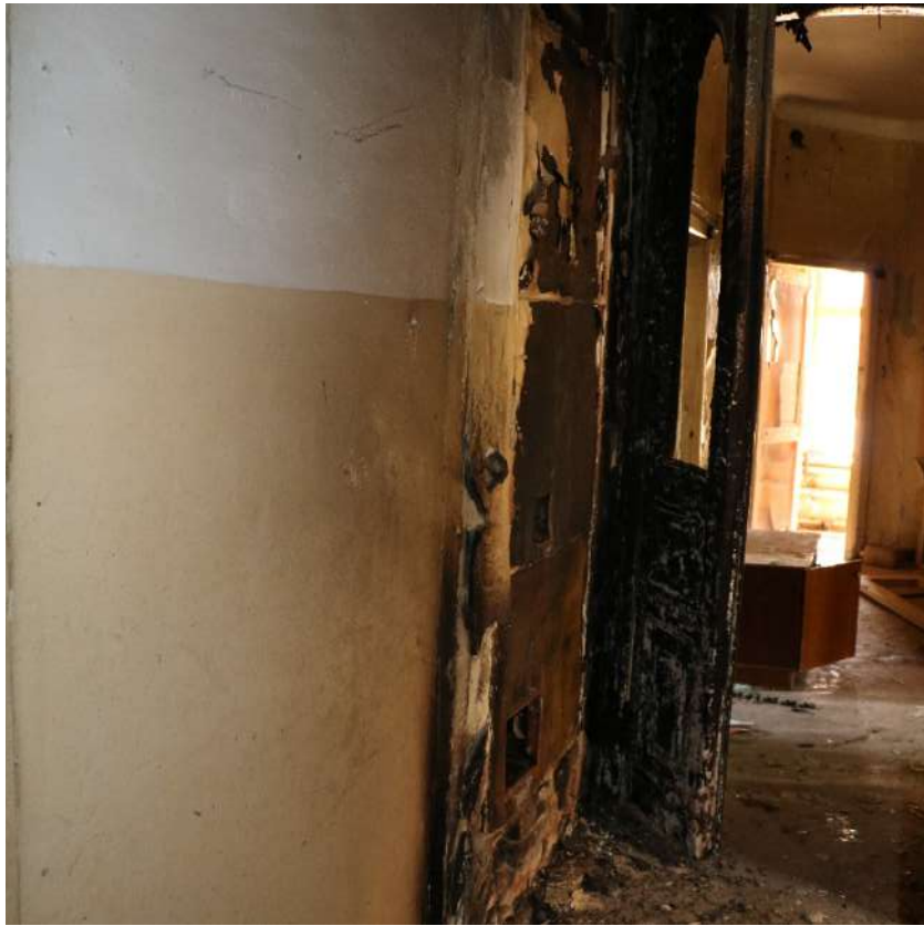
Фото 99. Выявленный объект культурного наследия. Внутреннее помещение. Коридор.
