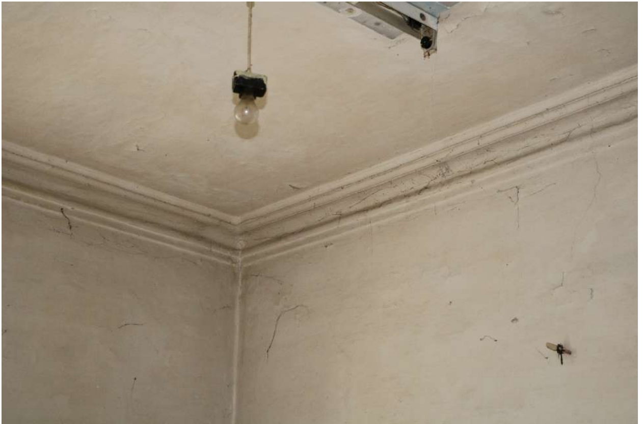
Фото 89. Выявленный объект культурного наследия. Внутреннее помещение. Фрагмент стен и потолка.
