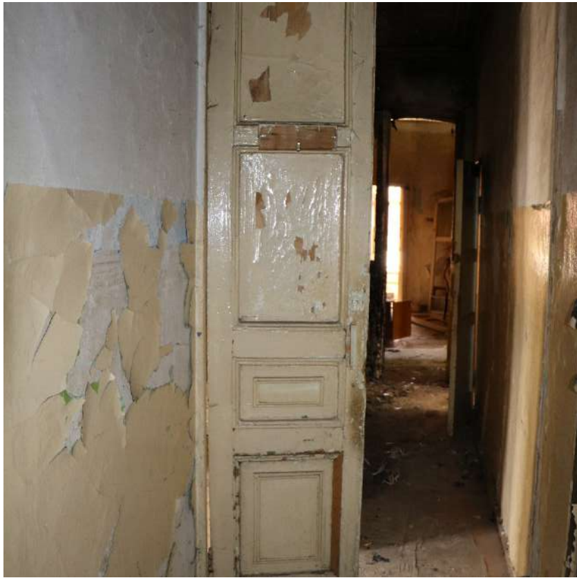
Фото 98. Выявленный объект культурного наследия. Внутреннее помещение. Коридор.
