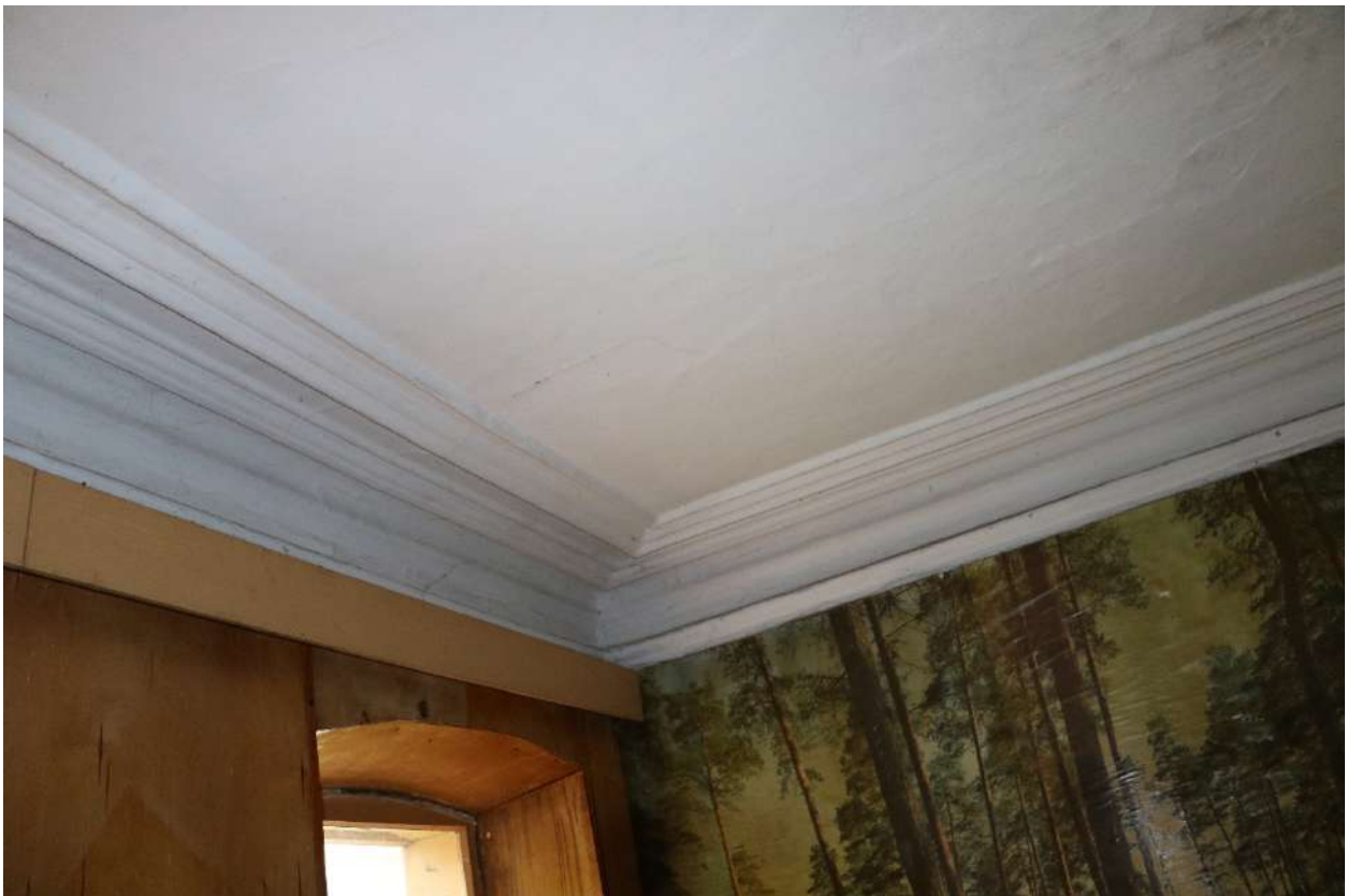
Фото 53. Выявленный объект культурного наследия. Внутреннее помещение. Фрагмент стены и потолка.
