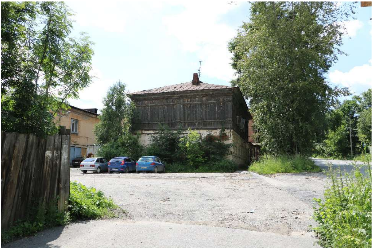
Фото 8. Выявленный объект культурного наследия. Вид с СВ.
