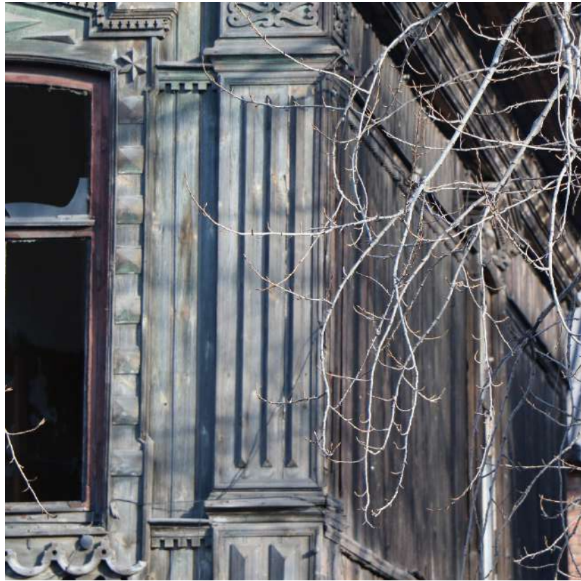
Фото 16. Выявленный объект культурного наследия. Фрагмент фасада с окном.
