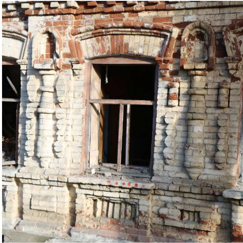
Фото 21. Выявленный объект культурного наследия. Фрагмент фасада с окном.
