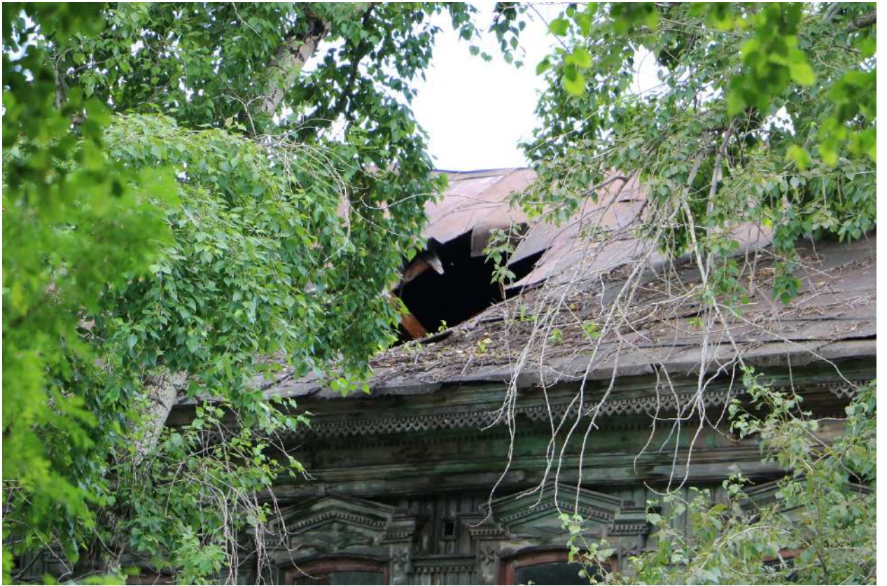
Фото 45. Выявленный объект культурного наследия. Фрагмент крыши.
