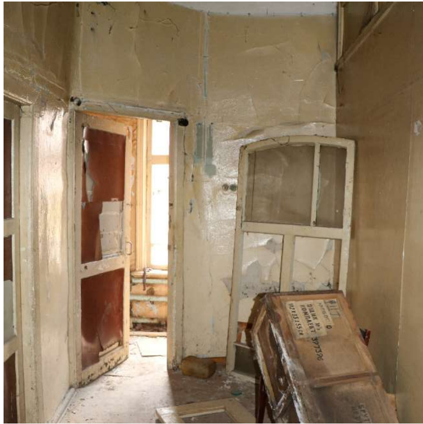
Фото 101. Выявленный объект культурного наследия. Внутреннее помещение. Коридор.
