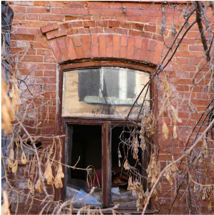
Фото 35. Выявленный объект культурного наследия. Фрагмент фасада с окном.
