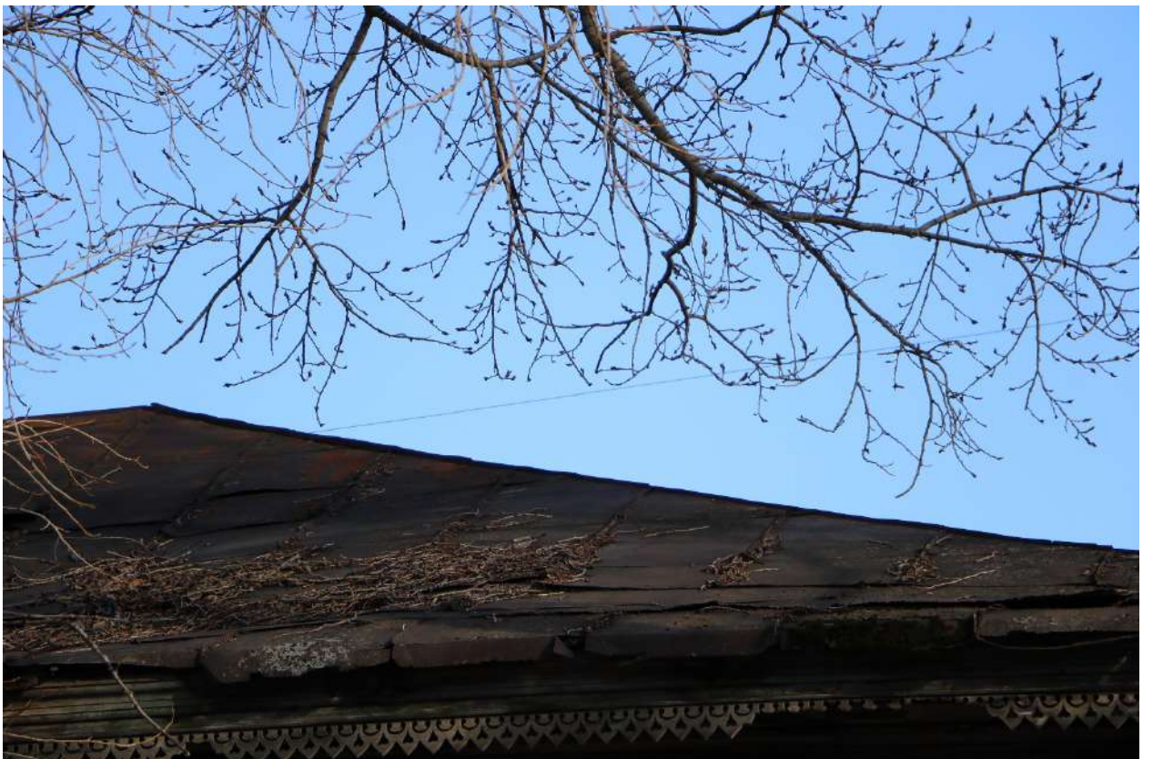
Фото 14. Выявленный объект культурного наследия. Фрагмент крыши.
