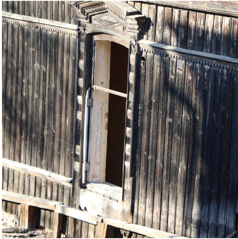
Фото 44. Выявленный объект культурного наследия. Фрагмент фасада с окном.
