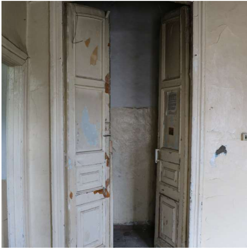
Фото 87. Выявленный объект культурного наследия. Внутреннее помещение. Дверной проем.
