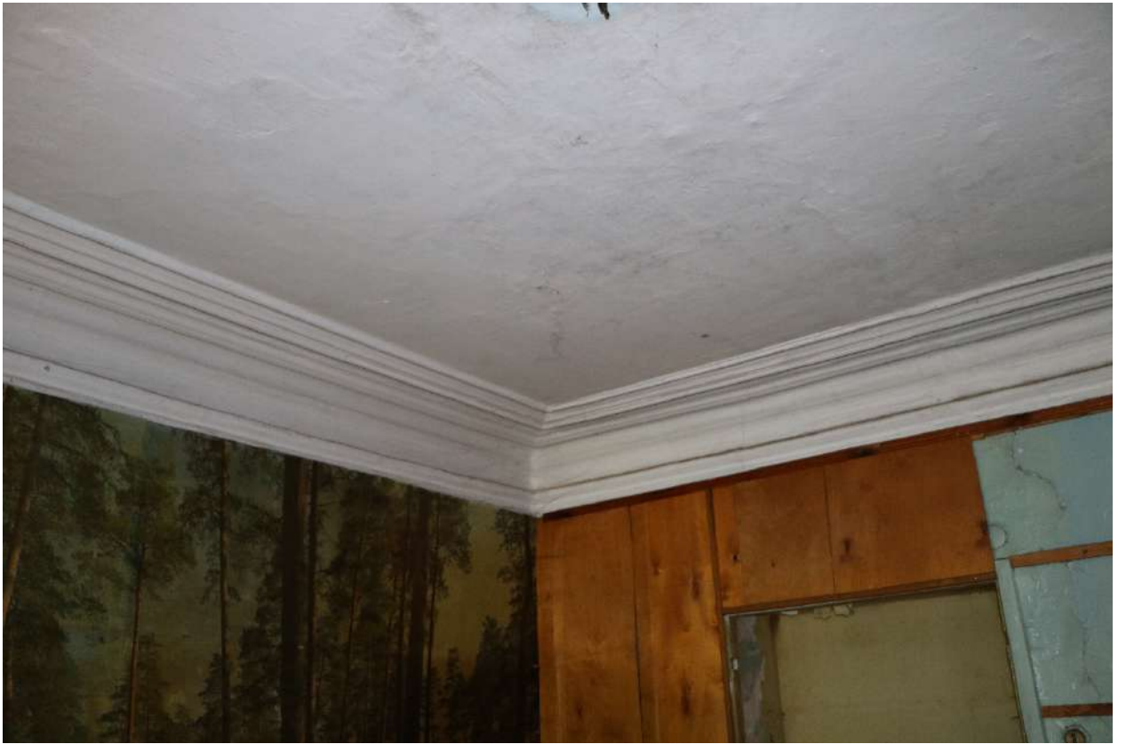
Фото 54. Выявленный объект культурного наследия. Внутреннее помещение. Фрагмент стены и потолка.
